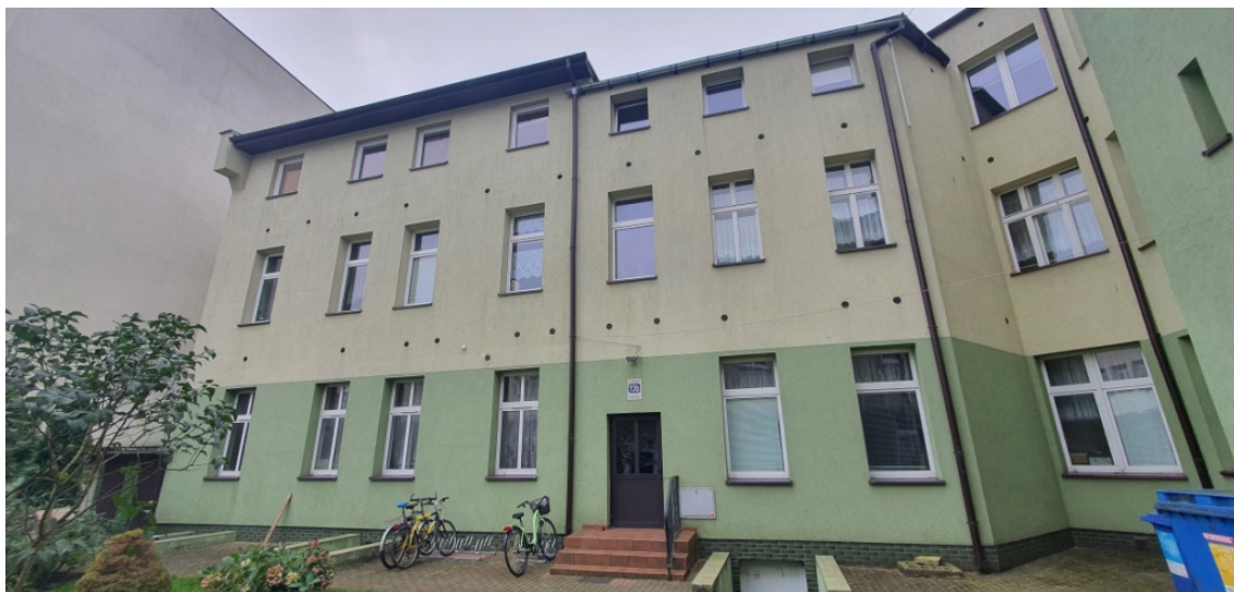
Fot. nr 1 Elewacja północna (wejście do oficyny budynku nr 13)
