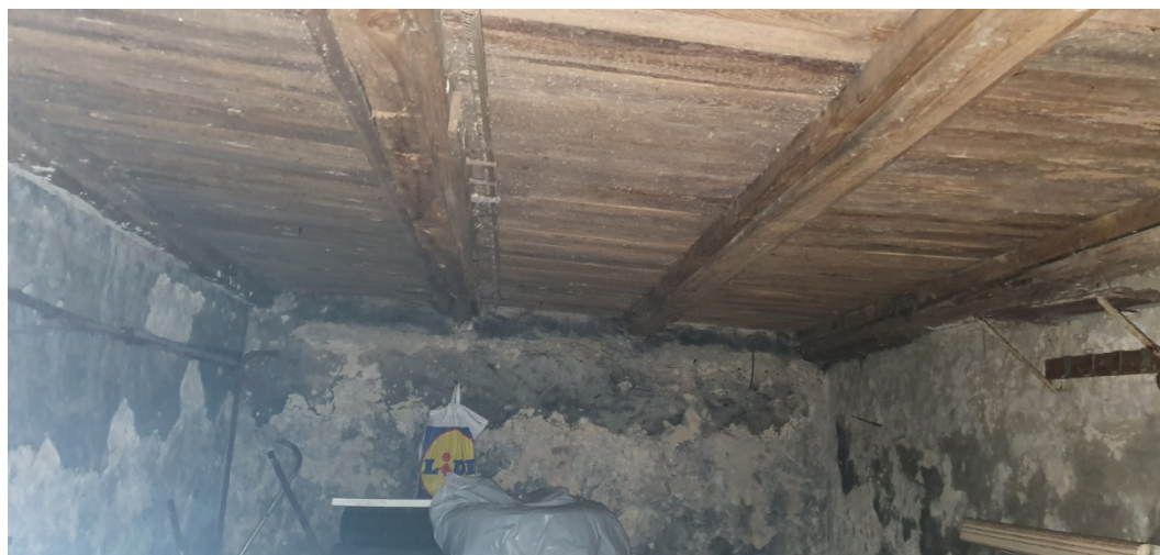
Fot. nr 5 pom. piwniczne – pod pokojem nr nr 2
