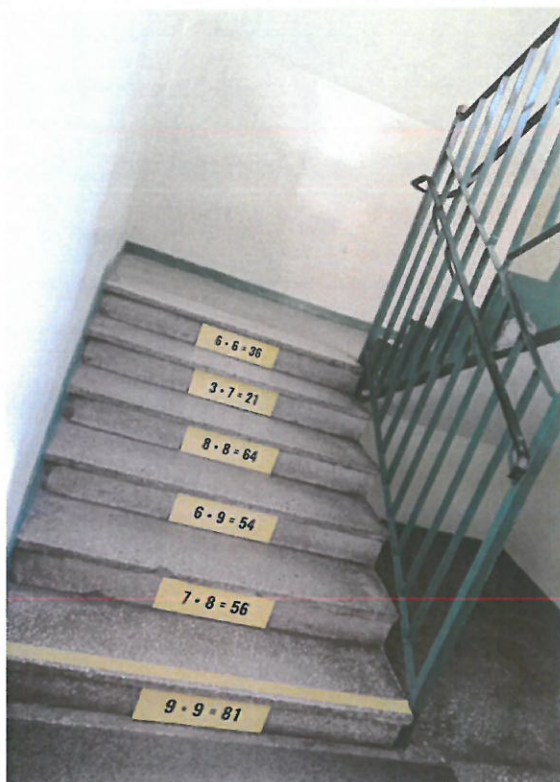
Fot. nr 1 – piwnica
