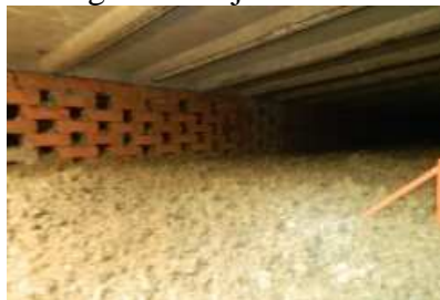
2 Wykonanie nadmuchu granulem z celulozy
