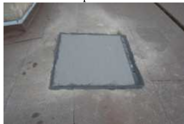
5 Wykonanie papy termo w miejscu otworu
