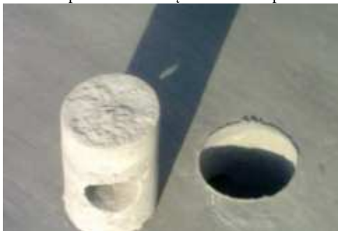
6 Wykonanie otworu pod kominek wentylacyjny
