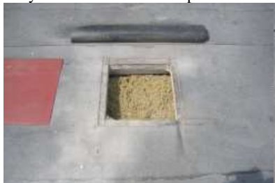
3 widok otworu po nadmuchu celulozy
