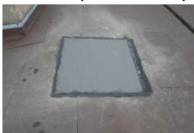
5 Wykonanie papy termo w miejscu otworu
