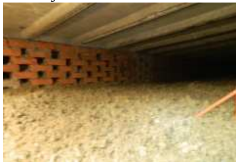
2 Wykonanie nadmuchu granulem z celulozy
