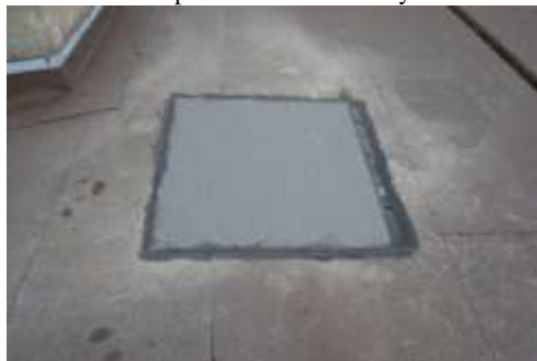
5 Wykonanie papy termo w miejscu otworu
