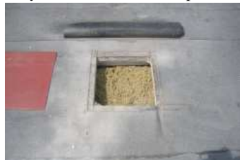
3 widok otworu po nadmuchu celulozy
