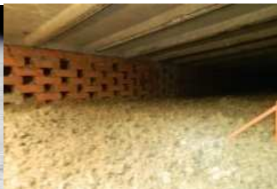
2 Wykonanie nadmuchu granulatem z celulozy
