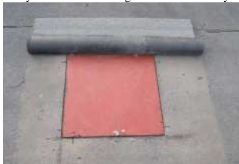
4 zabezpieczenie blachą otworu e stropodachu
