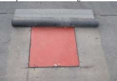
4 zabezpieczenie blachą otworu e stropodachu
