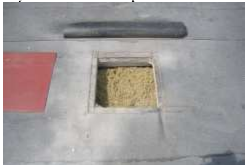
3 widok otworu po nadmuchu celulozy
