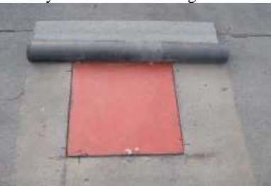
4 zabezpieczenie deskami otworu do wykonania nadmuchu stropodachu
