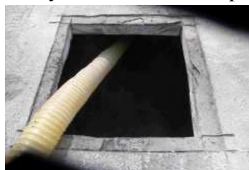
1 wykonanie otworu w stropodachu
