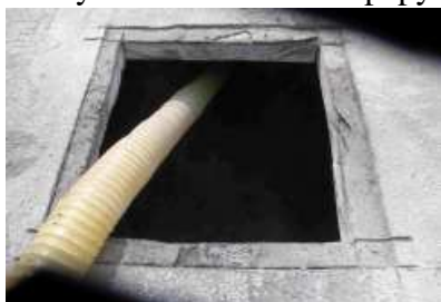
1 wykonanie otworu w stropodachu
