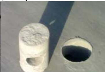
6 Wykonanie otworu pod kominek wentylacyjny
