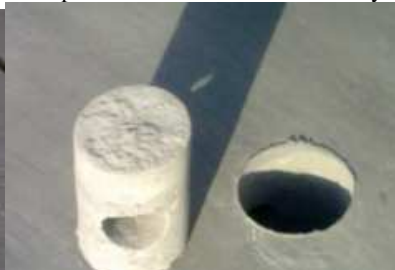
6 Wykonanie otworu pod kominek wentylacyjny
