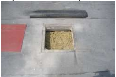
3 widok otworu po nadmuchu celulozy
