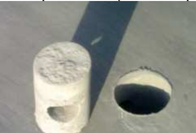
6 Wykonanie otworu pod kominek wentylacyjny
