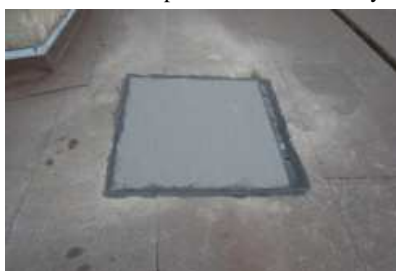
5 Wykonanie papy termo w miejscu otworu
