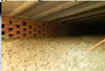
2 Wykonanie nadmuchu granulatem z celulozy
