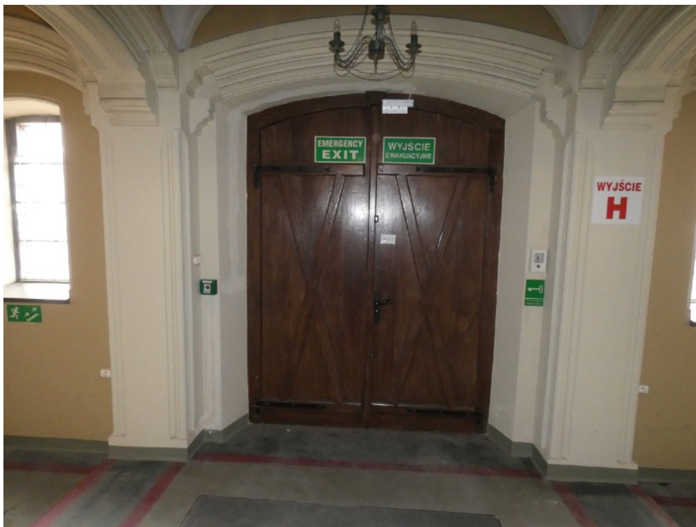
Fot. 9 Stolarka drzwiowa wejściowa od strony wewnętrznej z mazerunkami.
