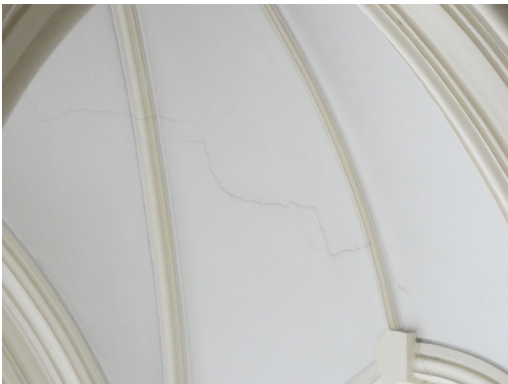
Fot. 3 Zbliżenie na spękania w obrębie sklepienia klatki schodowej.
