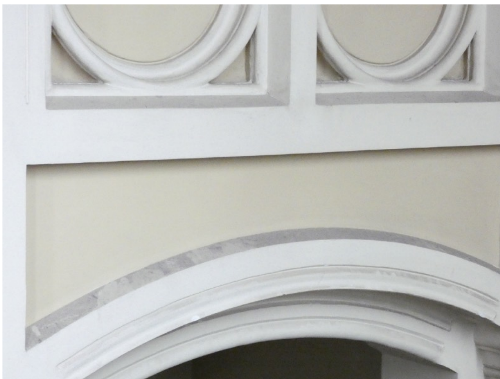
Fot. 4 Zbliżenie na zabrudzenia na poziomych elementach.
