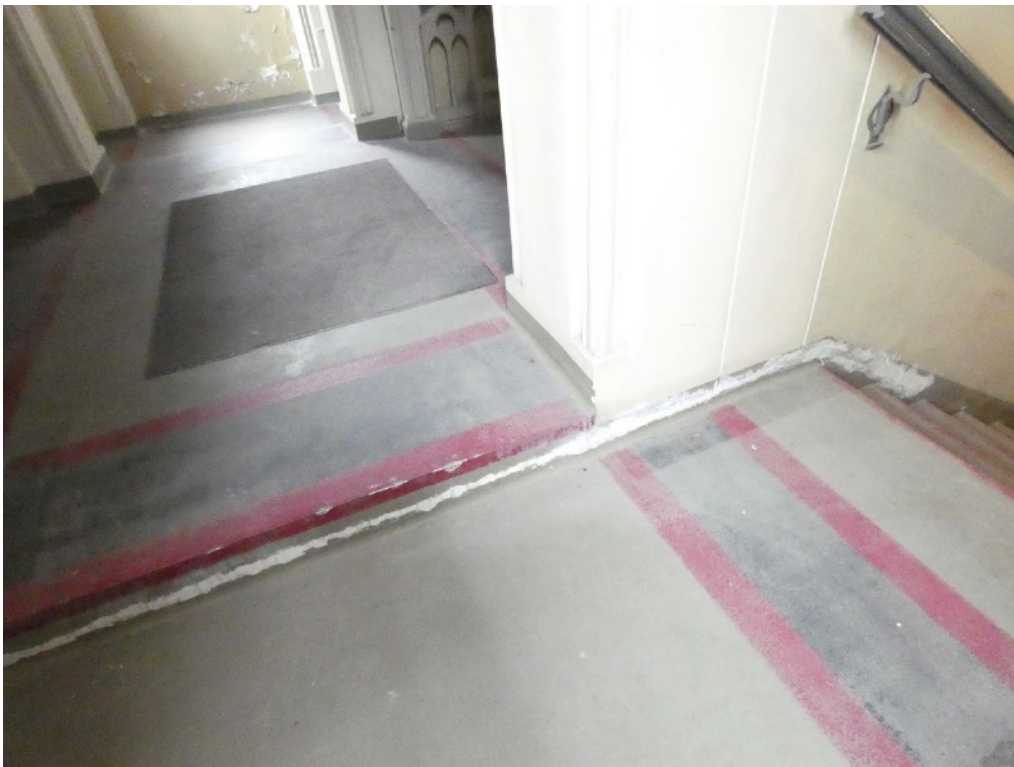
Fot. 11 Zbliżenie na nieestetyczne uzupełnienie w posadzce betonowej w przyziemiu.
