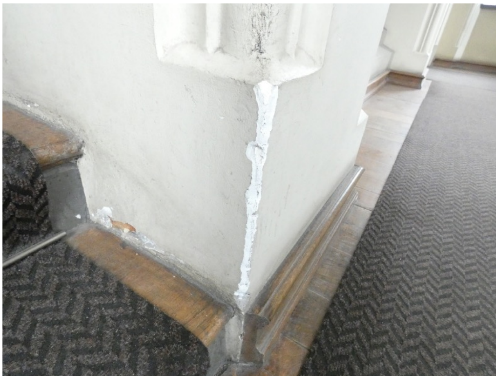
Fot. 5 Zbliżenie na uszkodzenia na narożach filarów oraz w dolnych partiach przy stopniach.
