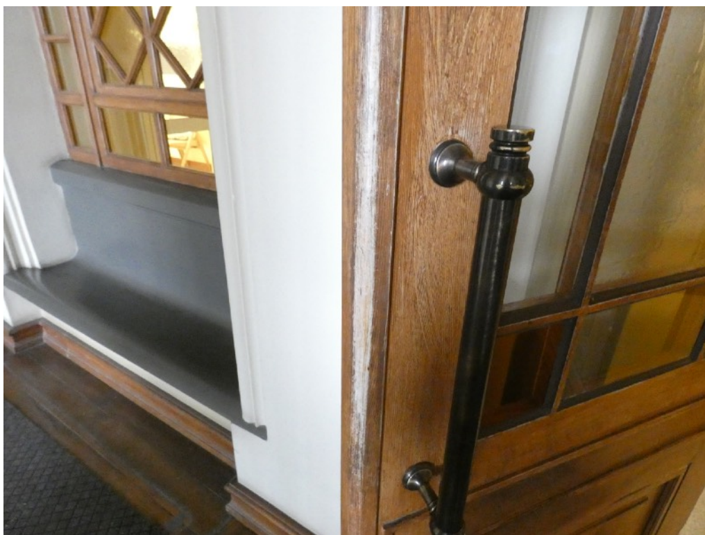
Fot. 8 Zbliżenie na przetarcia w obrębie mazerunków.
