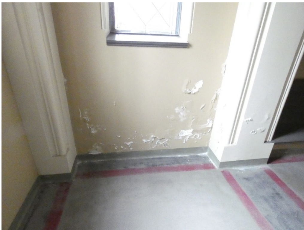
Fot. 10 Zbliżenie na zasolone tynki w obrębie ścian sieni w przyziemiu.
