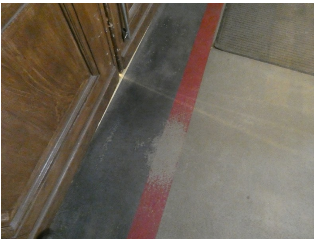
Fot. 12 Zbliżenie na przetarcia w obrębie dekoracji pasowej posadzki w przyziemiu.
