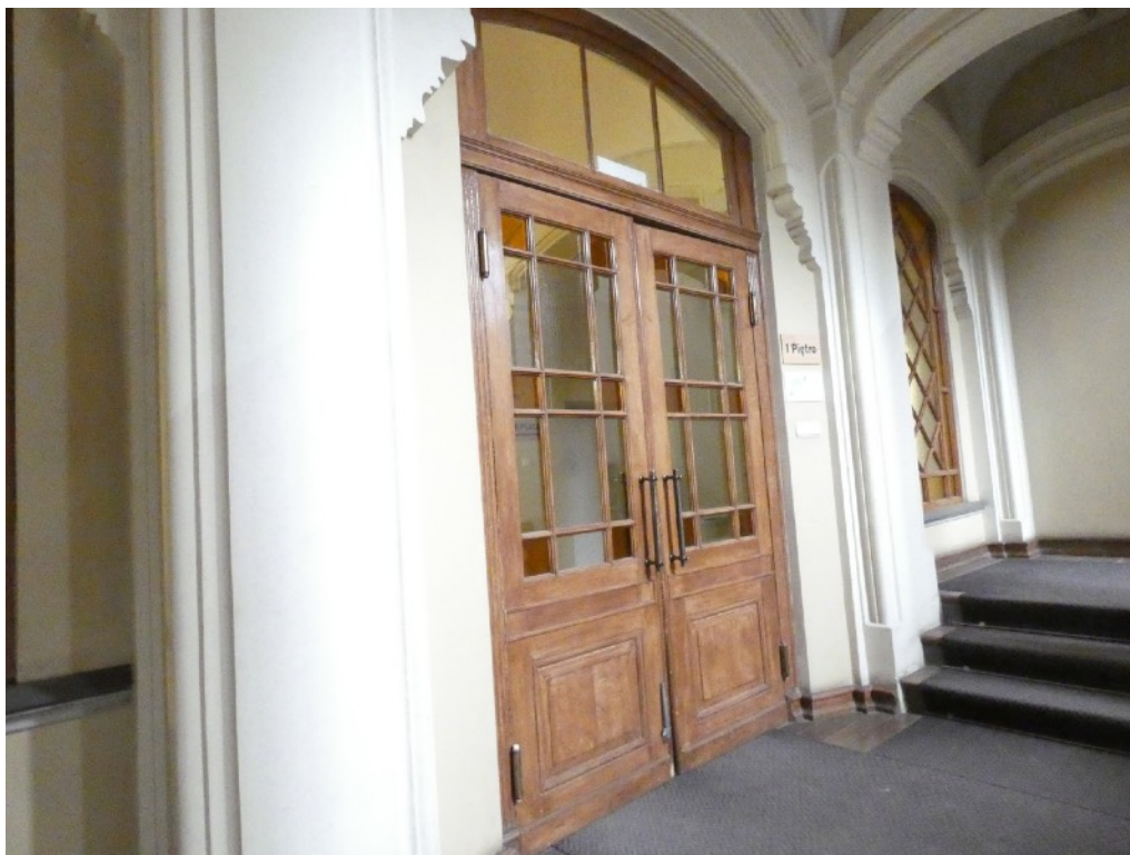
Fot. 7 Stolarka drzwiowa wewnętrzna klatki schodowej z mazerunkami i kolorowym szkleniem.
