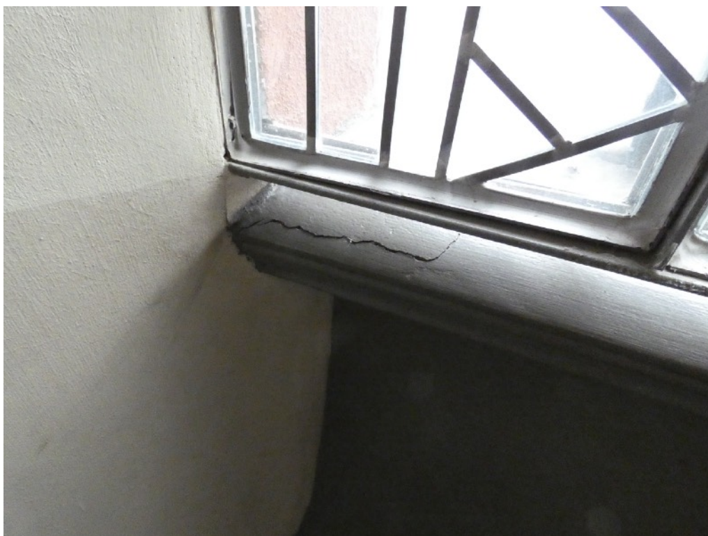
Fot. 6 Zbliżenie na spękania w obrębie parapetu okna witrażowego. Widoczne odcięcie kolorystyczne na ścianie spowodowane postarzeniem się lakieru zabezpieczającego.
