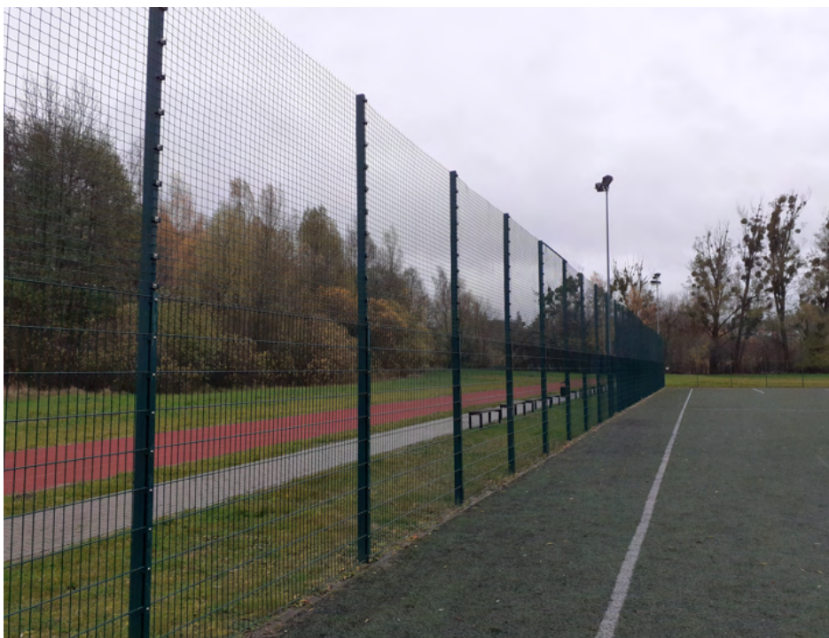
Ogrodzenie boczne boiska piłkarskiego Do wysokości 2,0m panele stalowe, powyżej do wysokości 4,0m siatka stalowa zgrzewana
