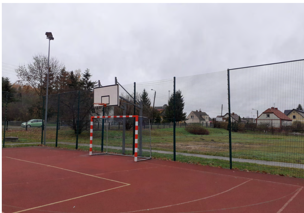
Ogrodzenie boiska wielofunkcyjnego i terenu zaplecza - częściowo wspólne z ogrodzeniem bocznym boiska piłkarskiego Do wysokości 2,0m panele stalowe, powyżej do wysokości 4,0m siatka stalowa zgrzewana
