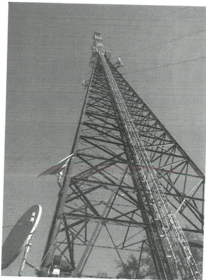
Widok ogólny wieży
