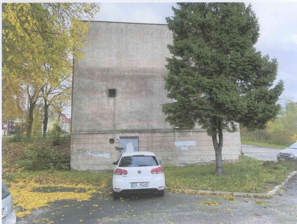
Fot. Nr 10 Budynek archiwum przewidziany do rozbiórki (elewacja zachodnia).
