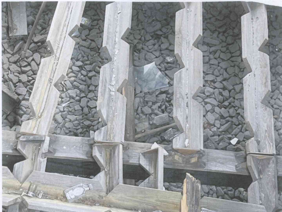
Fot. Nr 7 Budynek nieczynnej oczyszczalni ścieków przewidziany do rozbiórki (złóże organiczne).
