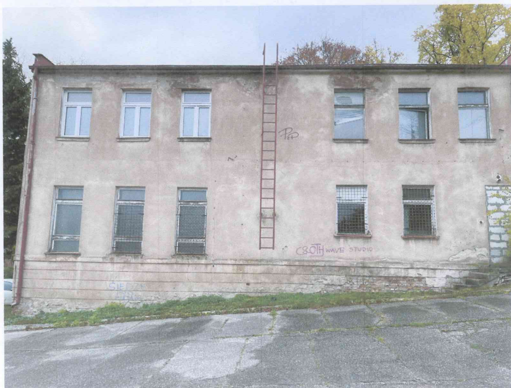
Fot. Nr 12 Budynek archiwum przewidziany do rozbiórki (elewacja tylna).
