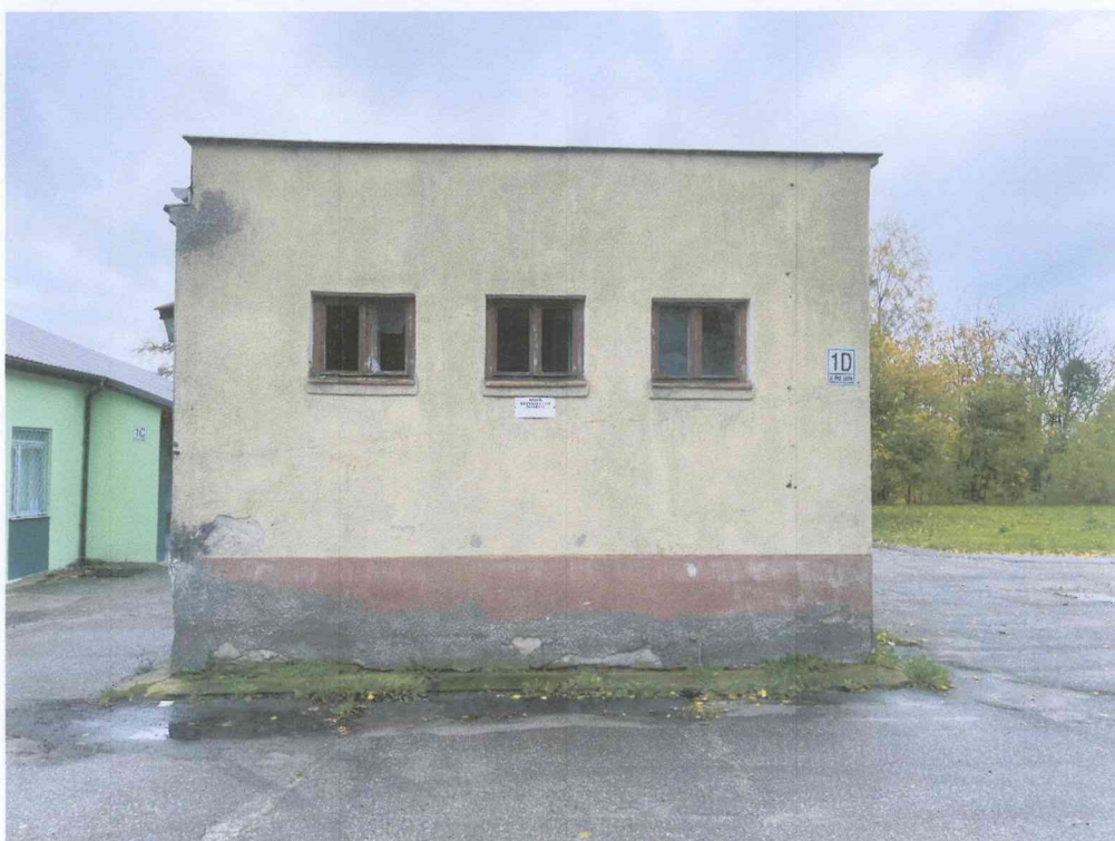
Fot. Nr 4 Budynek nieczynnej oczyszczalni ścieków przewidziany do rozbiórki (elewacja wschodnia).
