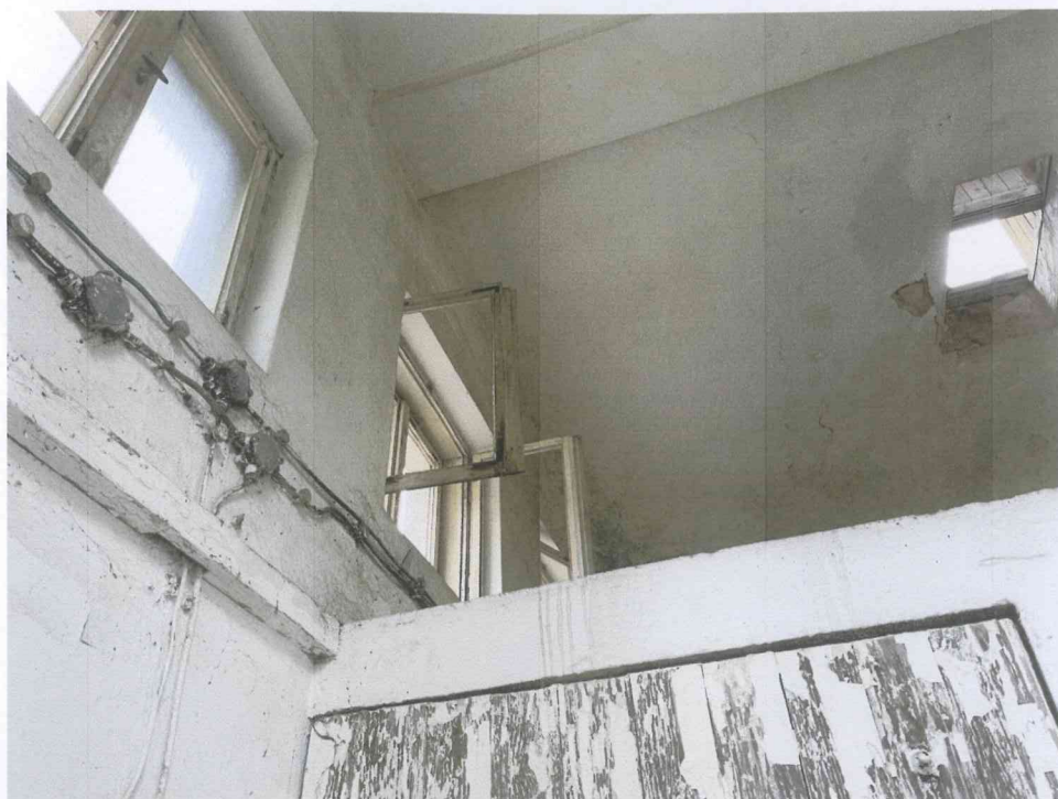
Fot. Nr 5 Budynek nieczynnej oczyszczalni ścieków przewidziany do rozbiórki (wnętrze obiektu).
