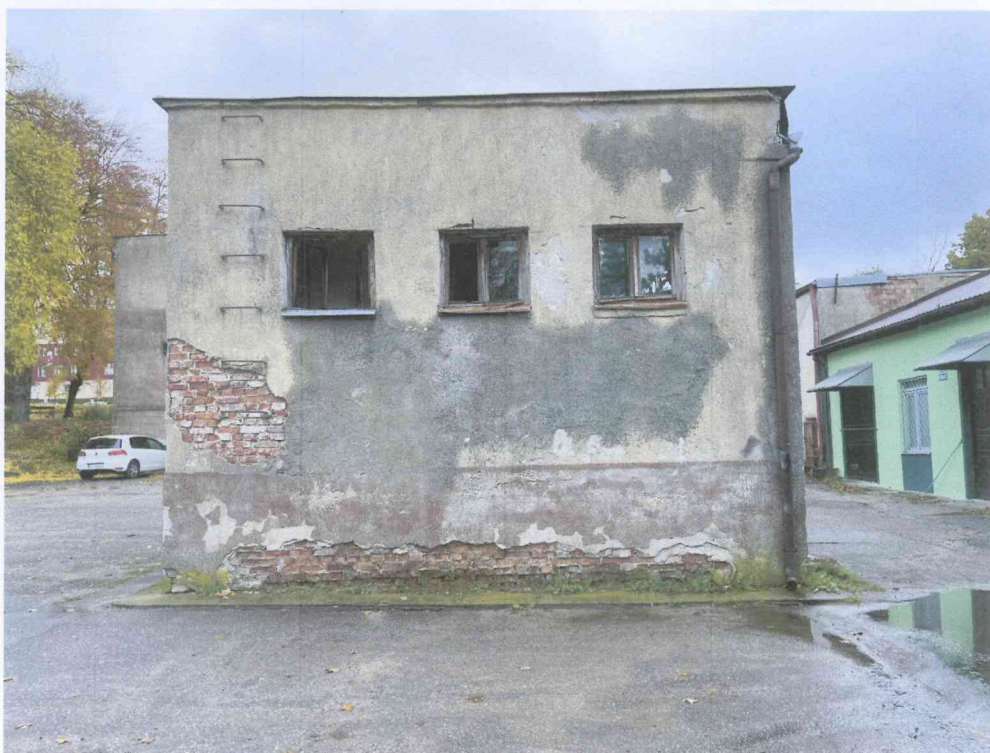
Fot. Nr 2 Budynek nieczynnej oczyszczalni ścieków przewidziany do rozbiórki (elewacja zachodnia).
