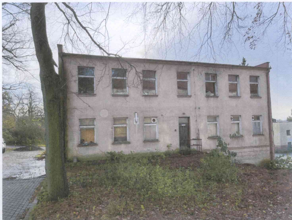
Fot. Nr 9 Budynek archiwum przewidziany do rozbiórki (elewacja frontowa).
