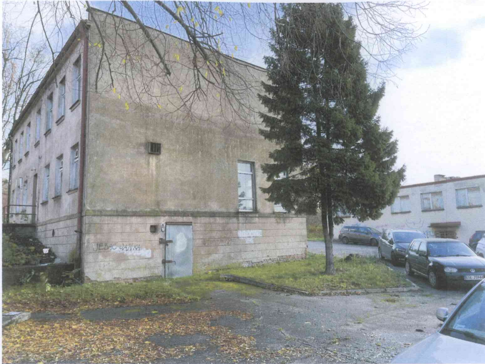
Fot. Nr 13 Budynek archiwum przewidziany do rozbiórki (elewacja zachodnia).
