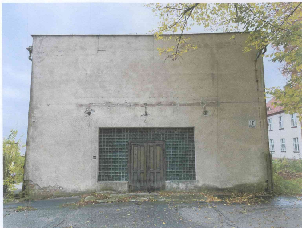
Fot. Nr 11 Budynek archiwum przewidziany do rozbiórki (elewacja wschodnia).
