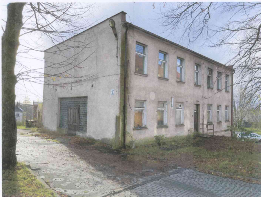
Fot. Nr 8 Budynek archiwum przewidziany do rozbiórki.
