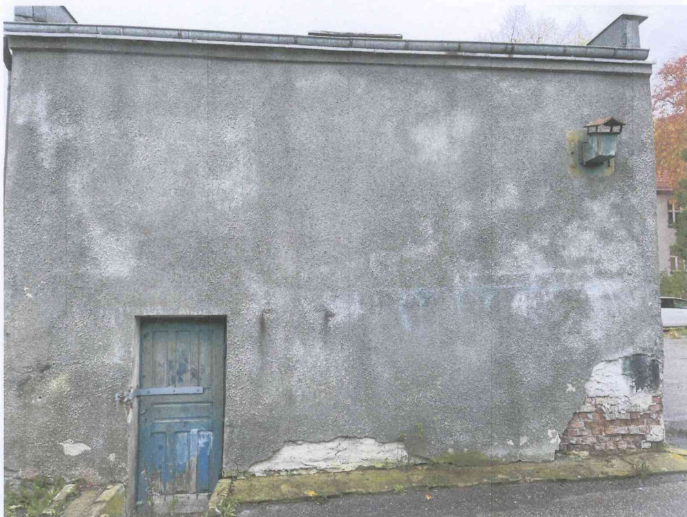
Fot. Nr 3 Budynek nieczynnej oczyszczalni ścieków przewidziany do rozbiórki (elewacja tylna).
