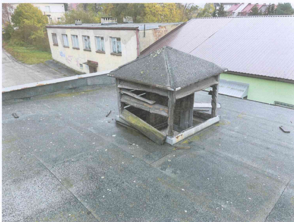
Fot. Nr 6 Budynek nieczynnej oczyszczalni ścieków przewidziany do rozbiórki (dach).
