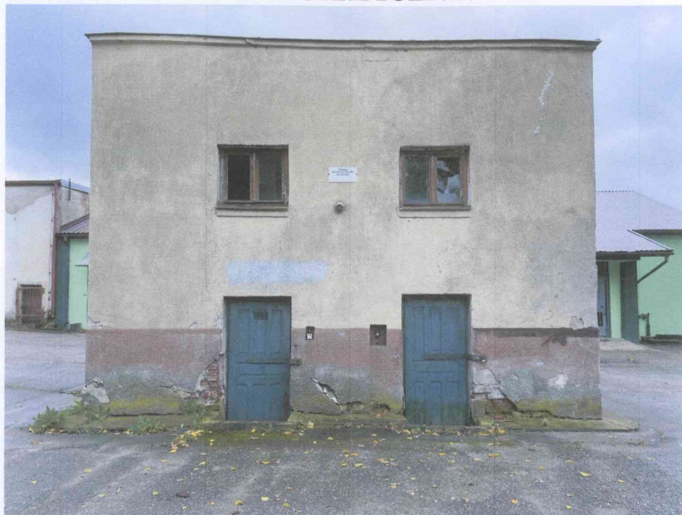
Fot. Nr 1 Budynek nieczynnej oczyszczalni ścieków przewidziany do rozbiórki (elewacja frontowa).
