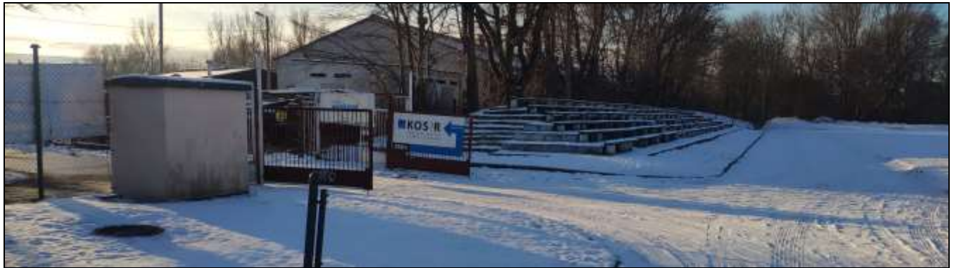
Fot. 4 Widok wjazdu na teren inwestycji oraz trybun przewidzianych do rozbiórki
