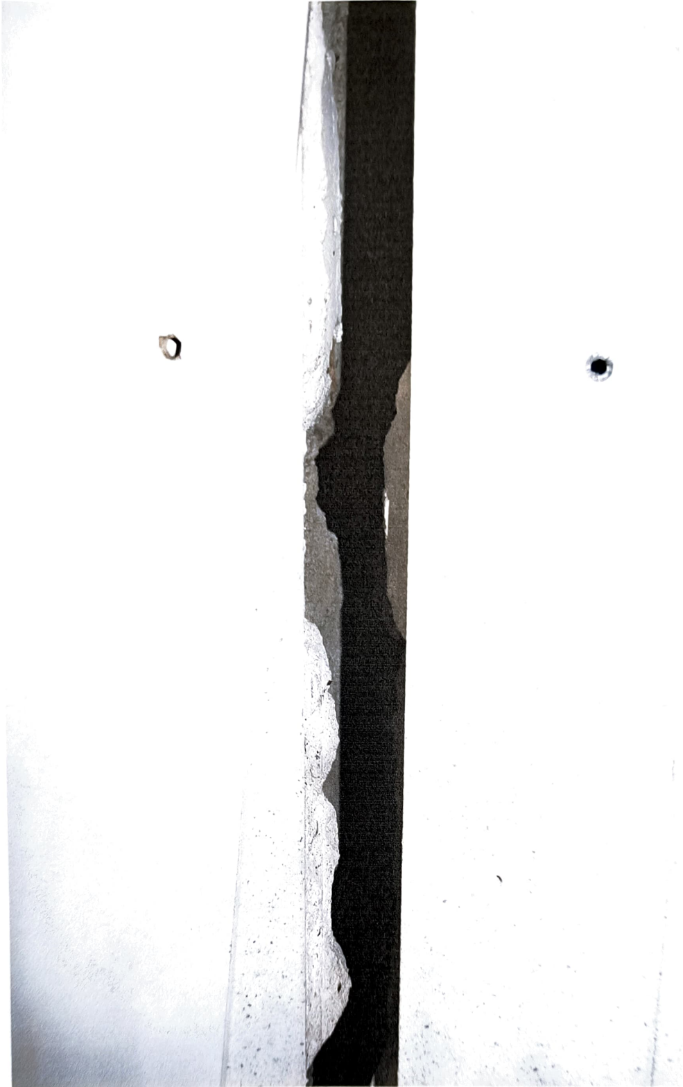
Fot. 4 Rozwarcie szczeliny dylatacyjnej pomiędzy słupami hall po stronie południowej
