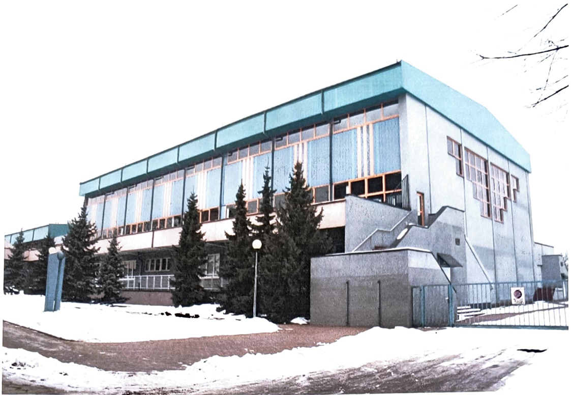
Fot. 1 Budynek hali sportowej. Widok od strony południowo-wschodniej.
