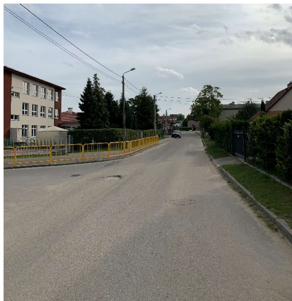
Fot. 2: widok ul. Szkolna w kierunku ul. Wejherowskiej
