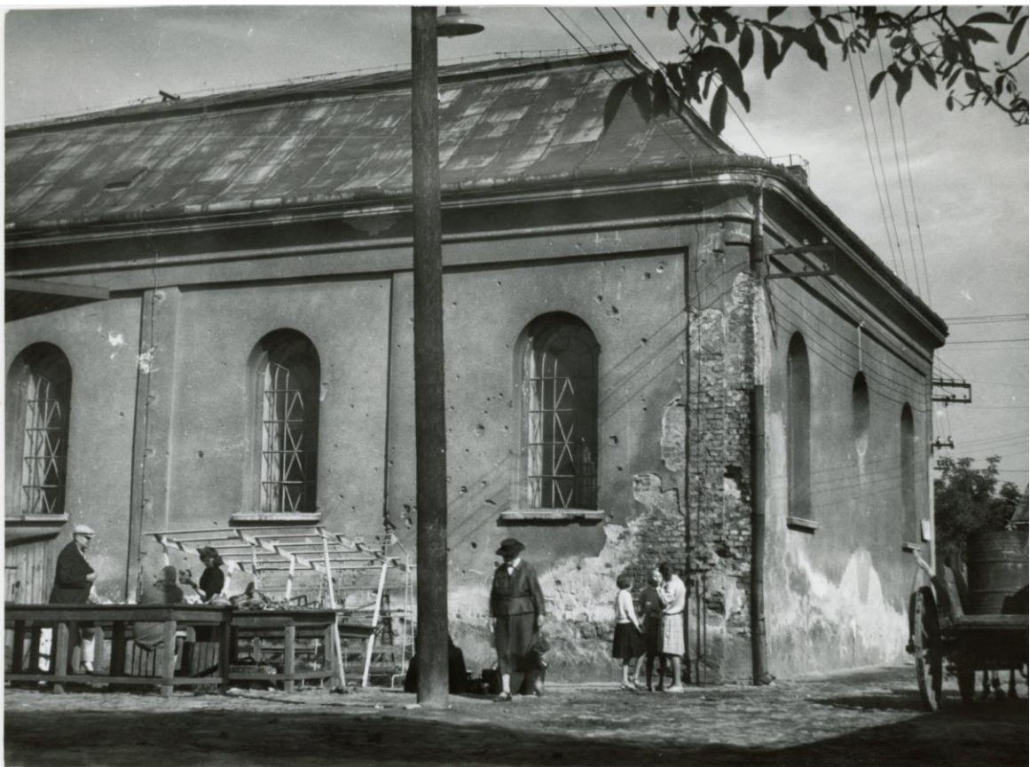
Il. 12. Synagoga Nowomiejska w Dębicy, widok od pd.-wsch. Autor fot.: Jerzy Żurawski. Datowanie: 1961 r. Źródło: Żydowski Instytut Historyczny, sygn.: ŻIH-III-34/d/DĘBI 002.
