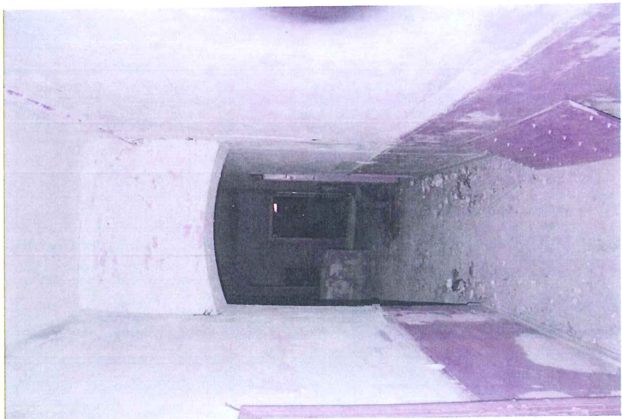
Fot.37. Piętro II. Zniszczenia polichromii spowodowane przez zawilgocenie wnętrza. Widoczne spękania i odspojenia warstwy malarskiej.
