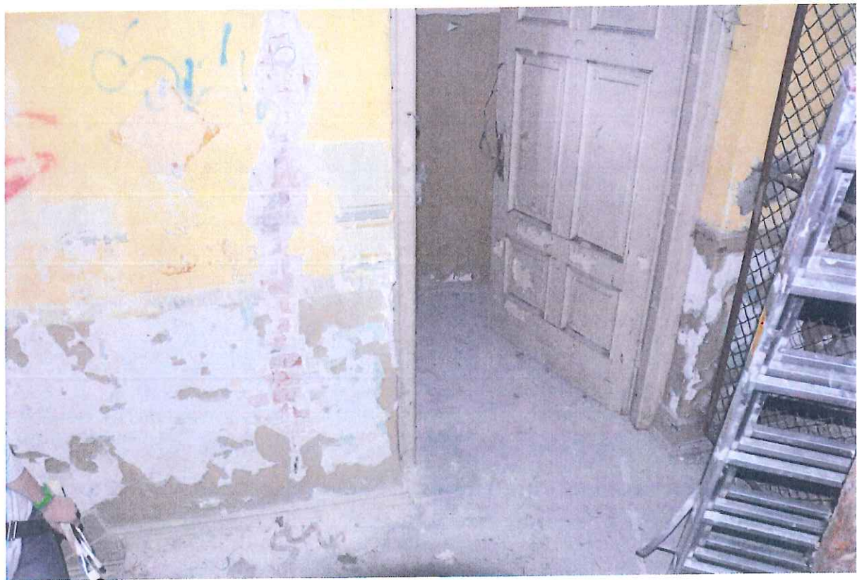
Fot. 15. Piętro I. Widoczne ubytki polichromii w strefie lamperii i bruzdy po wyrwanej instalacji elektrycznej na ścianach.
