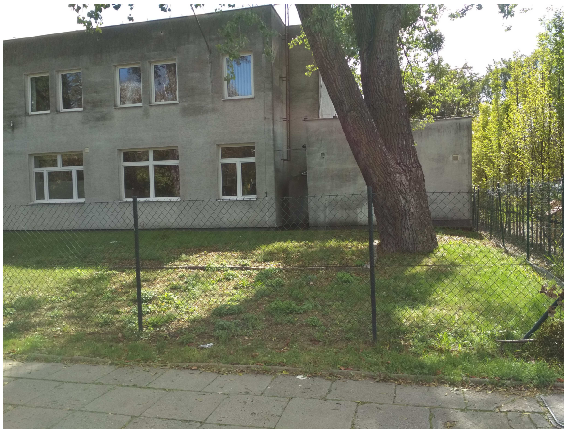
Fotografia nr 1: Widok na budynek uniwersytecki – w tle drabina przewidziana do demontażu
