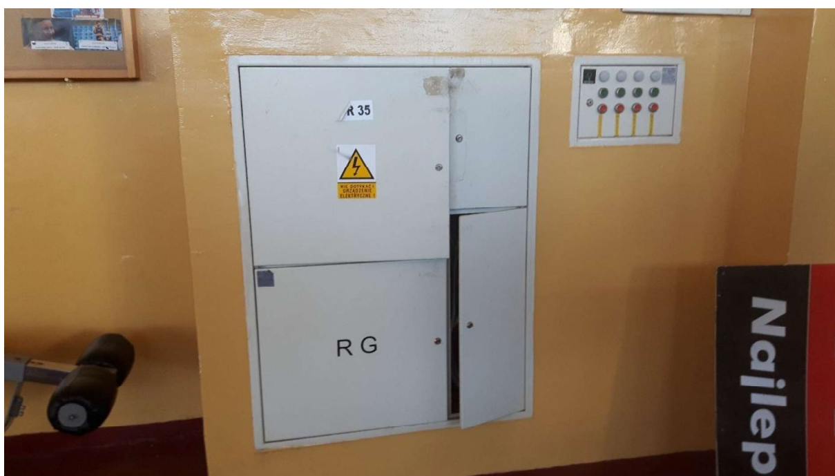
Rys. 7. Zdjęcia wewnątrz budynku
