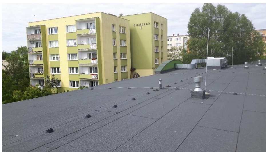
Rys. 15 . Zdjęcie dachu budynku nr 20 przy ul. ul. Podporucznik Emilii Gierczak 8
