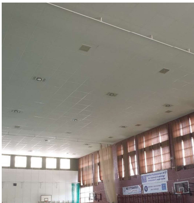
Rys. 18 . Zdjęcie budynku z wewnątrz
