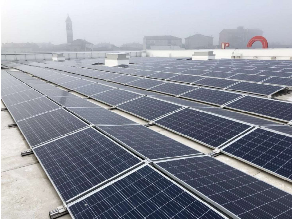
Rys. 3 Przykładowy rodzaj dedykowanej konstrukcji dla wybranego dachu
