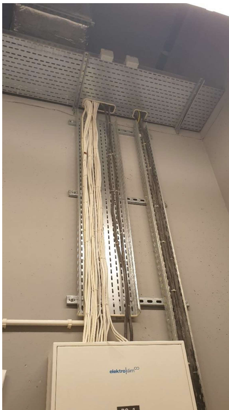
Rys. 4 Istniejący szacht komunikacyjny
