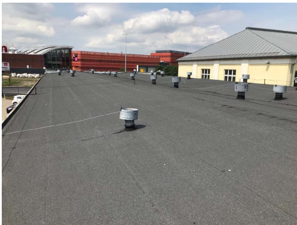
Rys. 23 . Zdjęcie dachu ZSM nr 1
