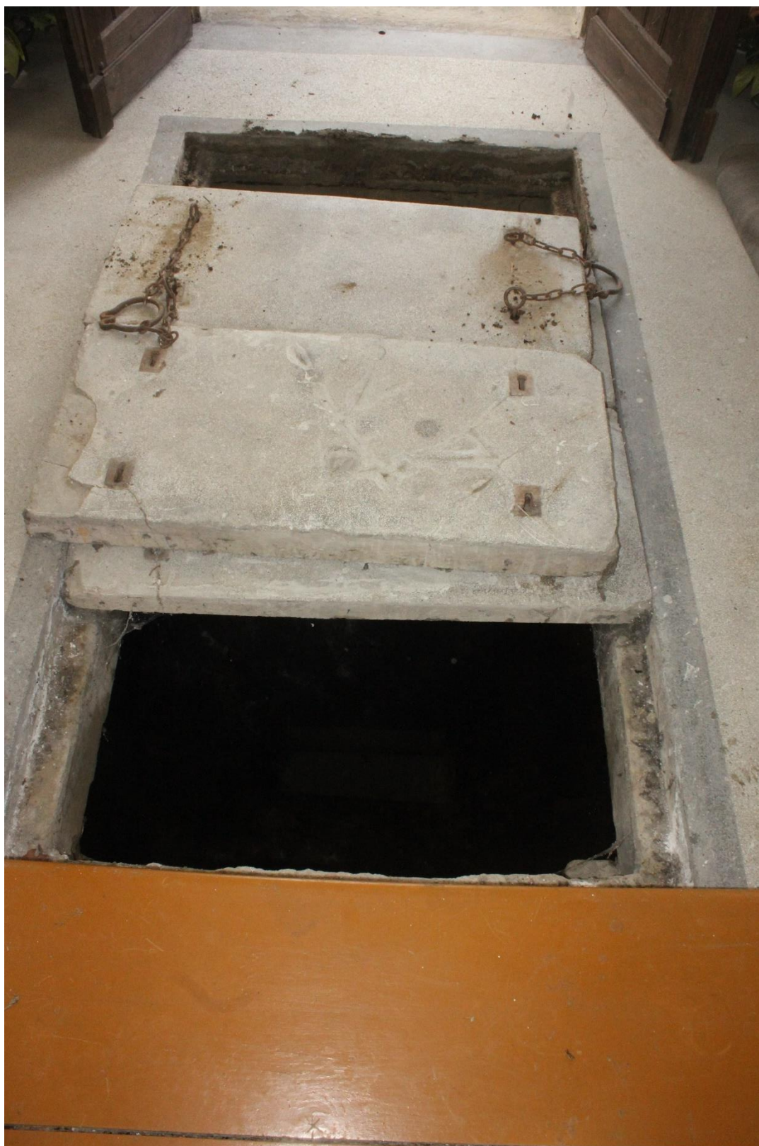
Fot. nr 29. Kaplica p.w. św. Szczepana z 1913 r. usytuowana na Starym cmentarzu w Ryglicach. Wnętrze kaplicy. Posadzka z lastriko i wejście do krypty zasłonięte czterema płytami. Stan przed konserwacją.
