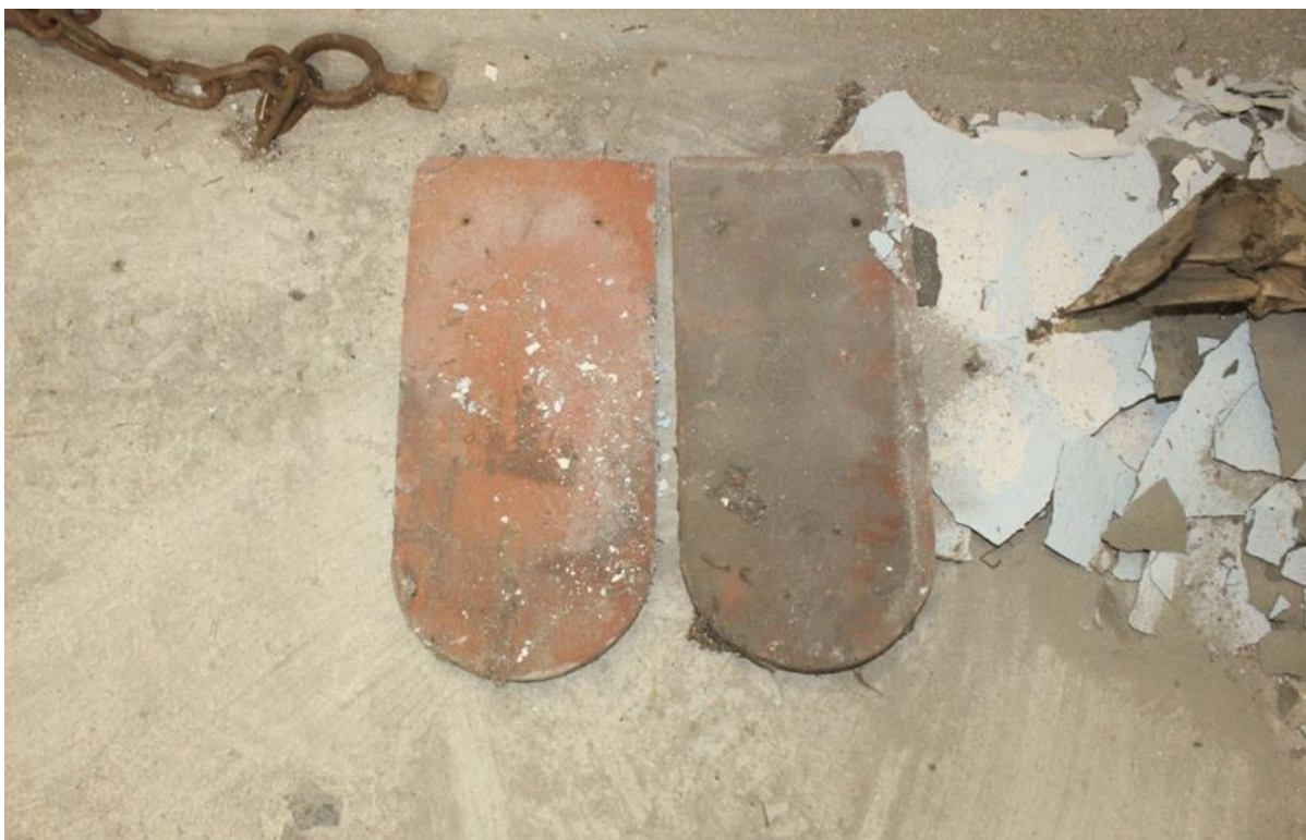
Zdjęcie 12. Pojedyncze dachówki karpiówki z pierwotnego pokrycia znalezione we wnętrzu kaplicy. W górnej części widoczne otwory montażowe dla gwoździ. Fot. Marta Bobek, maj 2024.
