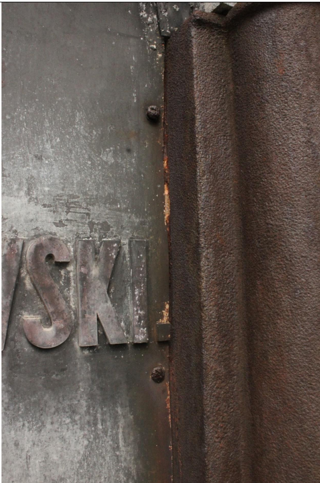
Fot. nr 58. Kaplica p.w. św. Szczepana z 1913 r. usytuowana na Starym cmentarzu w Ryglicach. Tablica epitafijna Stefana Leśniowskiego - fragment. Widoczny sposób montażu tablicy wykonanej z brązu do stelażu, przy użyciu wkrętów. Stan przed konserwacją.
