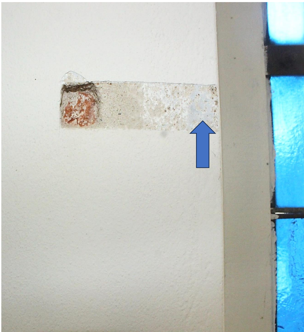
Fot. nr 27. Kaplica p.w. św. Szczepana z 1913 r. usytuowana na Starym cmentarzu w Ryglicach. Wnętrze kaplicy. Ściana zachodnia. Odkrywka stratygraficzna nawarstwień malarskich. Stwierdzono kolejno: mur z cegły, warstwa tynku, pobiała, monochromia w kolorze szarobłękitnym, warstwa malarska w kolorze białym - przemalowanie. Stan przed konserwacją.
