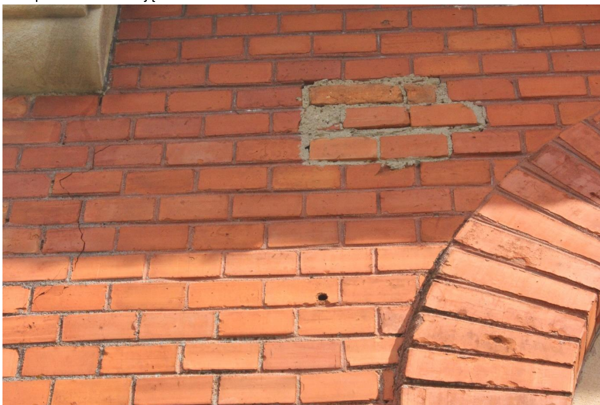
Fot. nr 14. Kaplica p.w. św. Szczepana z 1913 r. usytuowana na Starym cmentarzu w Ryglicach. Elewacja zachodnia. Widoczne wtórne uzupełnienia wątku ceglanego. Stan przed konserwacją.
