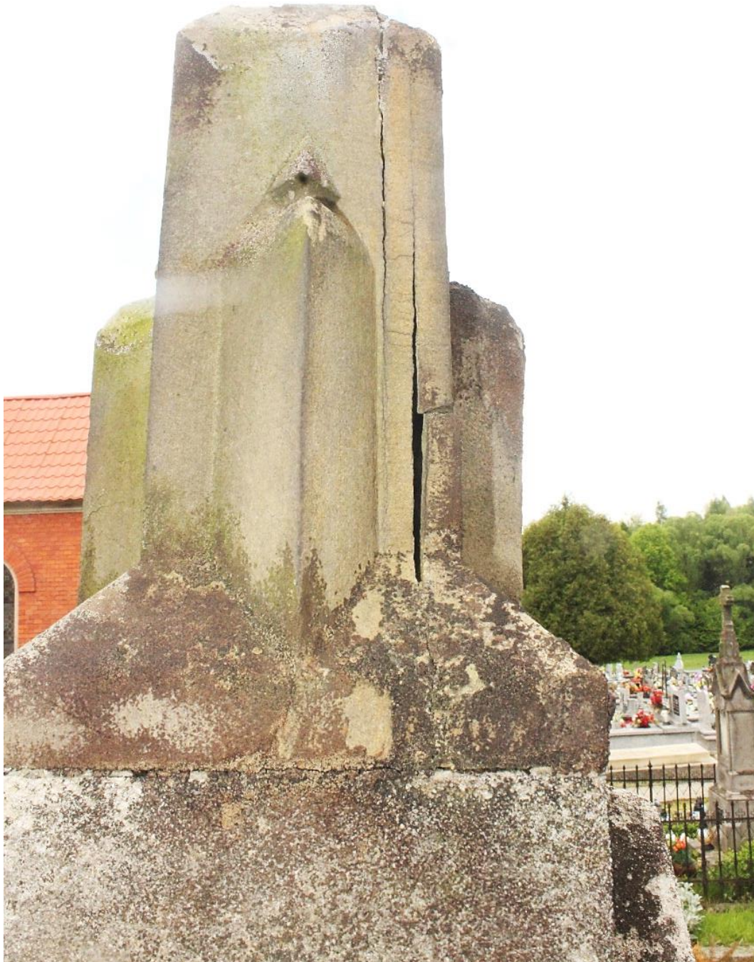
Fot. nr 10. Nagrobek Józefa Michniewskiego, zm. w 1889 r., na Starym cmentarzu w Ryglicach. Zbliżenie fragmentu zwieńczenia. Widoczne pęknięcia i rozwarstwienia elementu podstawy krzyża. Stan przed konserwacją.
