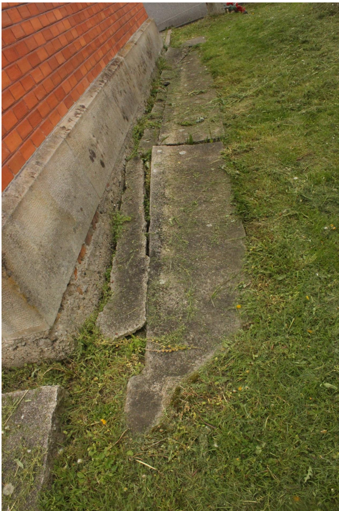
Fot. nr 15. Kaplica p.w. św. Szczepana z 1913 r. usytuowana na Starym cmentarzu w Ryglicach. Widoczna opaska betonowa wzdłuż wschodniej elewacji. Stan przed konserwacją.
