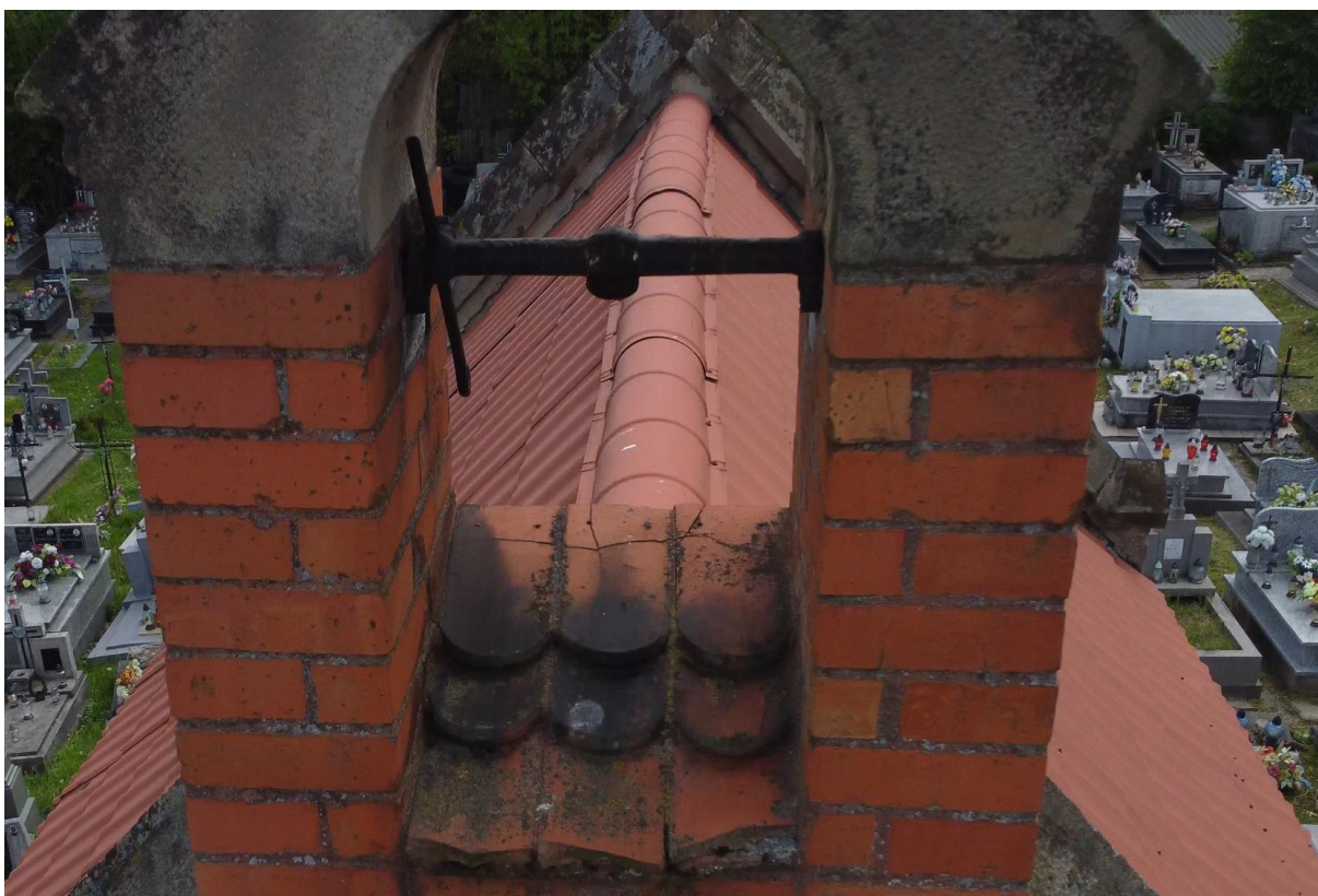
Zdjęcie 5. Zbliżenie na wieżyczkę na sygnaturkę w typie bell-cot. Widoczne zachowane dachówki karpiówki we wnętrzu ramy. Fot. własna, maj 2024.
