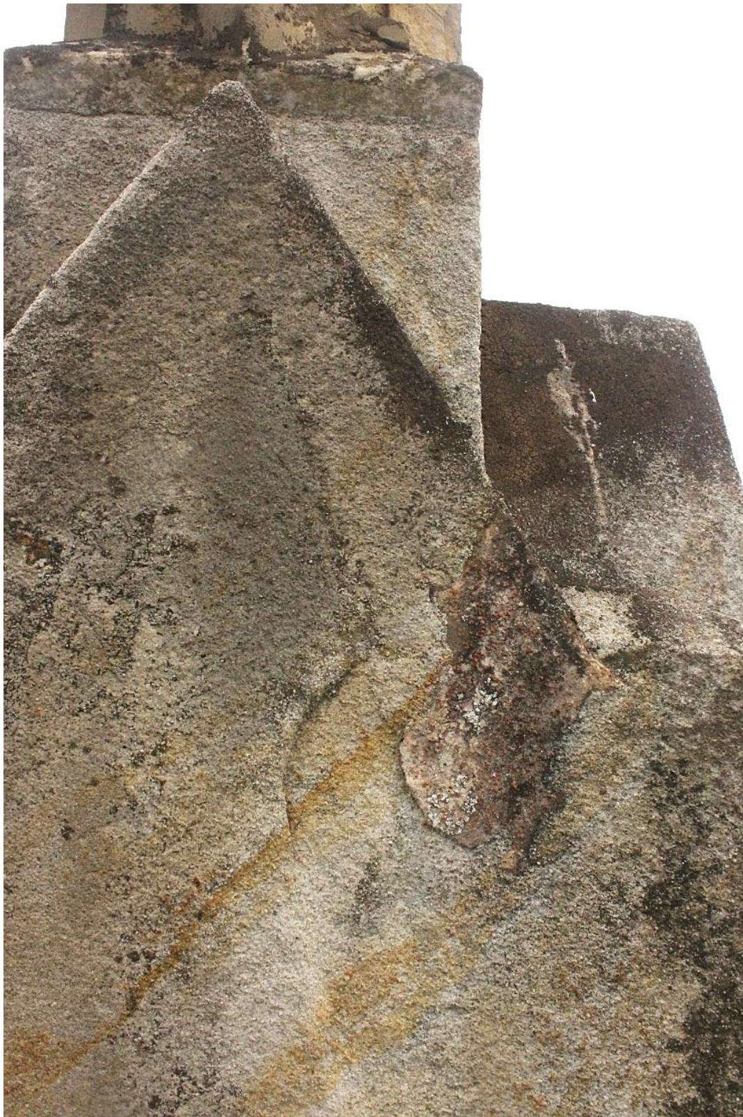
Fot. nr 11. Nagrobek Józefa Michniewskiego, zm. w 1889 r., na Starym cmentarzu w Ryglicach. Zbliżenie fragmentu zwieńczenia. Widoczne uzupełnienia ubytków. Stan przed konserwacją.
