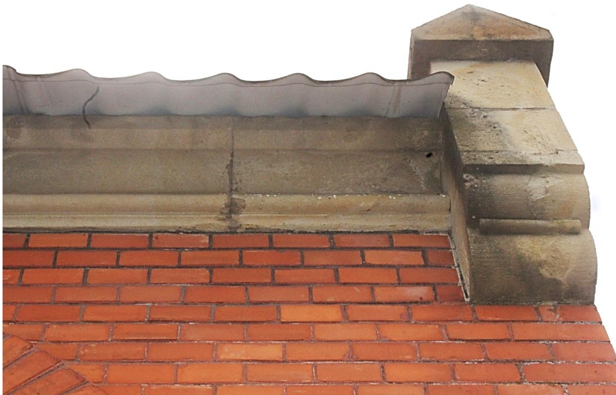
Fot. nr 19. Kaplica p.w. św. Szczepana z 1913 r. usytuowana na Starym cmentarzu w Ryglicach. Widoczne wymienione pokrycie dachu na blachę, ułożoną bezpośrednio na kamiennym gzymsie. Na kamiennym wsporniku widoczna powierzchnia kamienia wymyta przez wodę opadową spływającą z dachu. Stan przed konserwacją.
