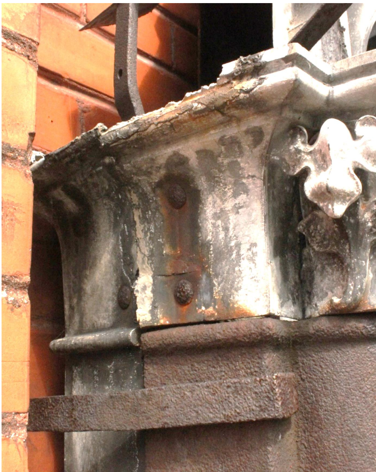
Fot. nr 50. Kaplica p.w. św. Szczepana z 1913 r. usytuowana na Starym cmentarzu w Ryglicach. Zbliżenia fragmentów zwieńczenia epitafium Stefana Leśniowskiego. Widoczna korozja nitów mocujących elementy do stelażu. Stan przed konserwacją.
