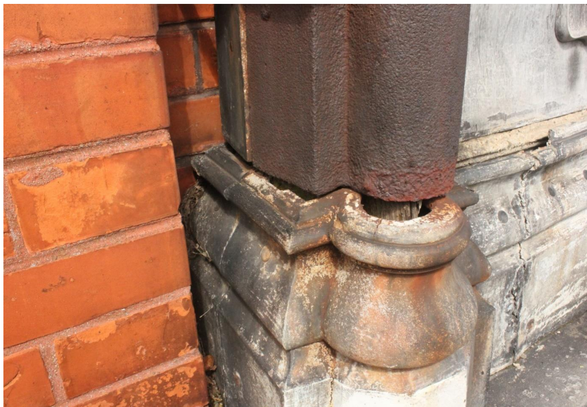
Fot. nr 51, 52. Kaplica p.w. św. Szczepana z 1913 r. usytuowana na Starym cmentarzu w Ryglicach. Zbliżenia fragmentów epitafium Stefana Leśniowskiego. Widoczne uszkodzenia i deformacje elementów, doraźne naprawy. Stan przed konserwacją.
