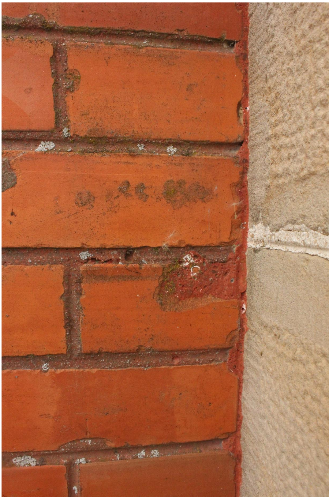
Fot. nr 12. Kaplica p.w. św. Szczepana z 1913 r. usytuowana na Starym cmentarzu w Ryglicach. Widoczny sposób opracowania historycznej spoiny, gdzie cementowa fuga pomalowana została na czerwono. Stan przed konserwacją.
