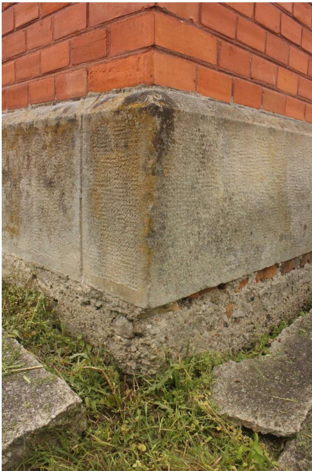
Fot. nr 16. Kaplica p.w. św. Szczepana z 1913 r. usytuowana na Starym cmentarzu w Ryglicach. Narożnik południowo - wschodni. Widoczny cokół z piaskowca i odsłonięty fundament betonowy. Stan przed konserwacją.
