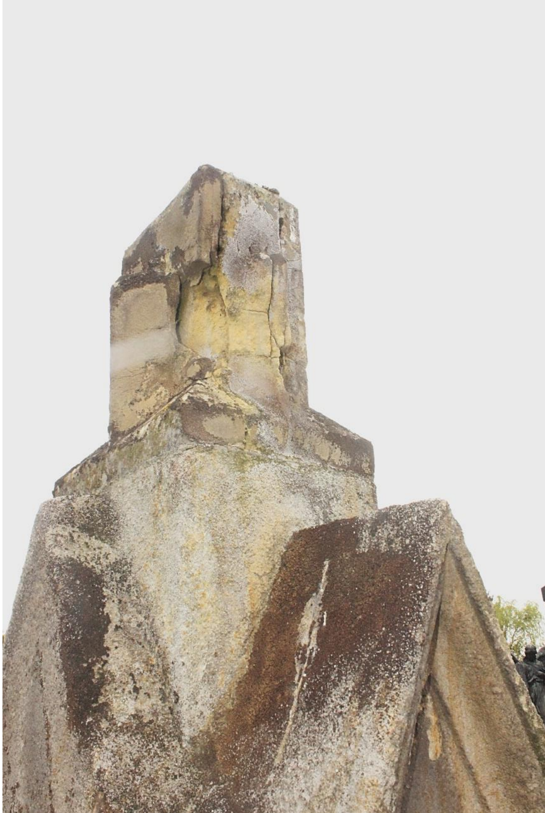
Fot. nr 9. Nagrobek Józefa Michniewskiego, zm. w 1889 r., na Starym cmentarzu w Ryglicach. Zbliżenie fragmentu zwieńczenia. Widoczne pęknięcia i rozwarstwienia elementu podstawy krzyża. Stan przed konserwacją.
