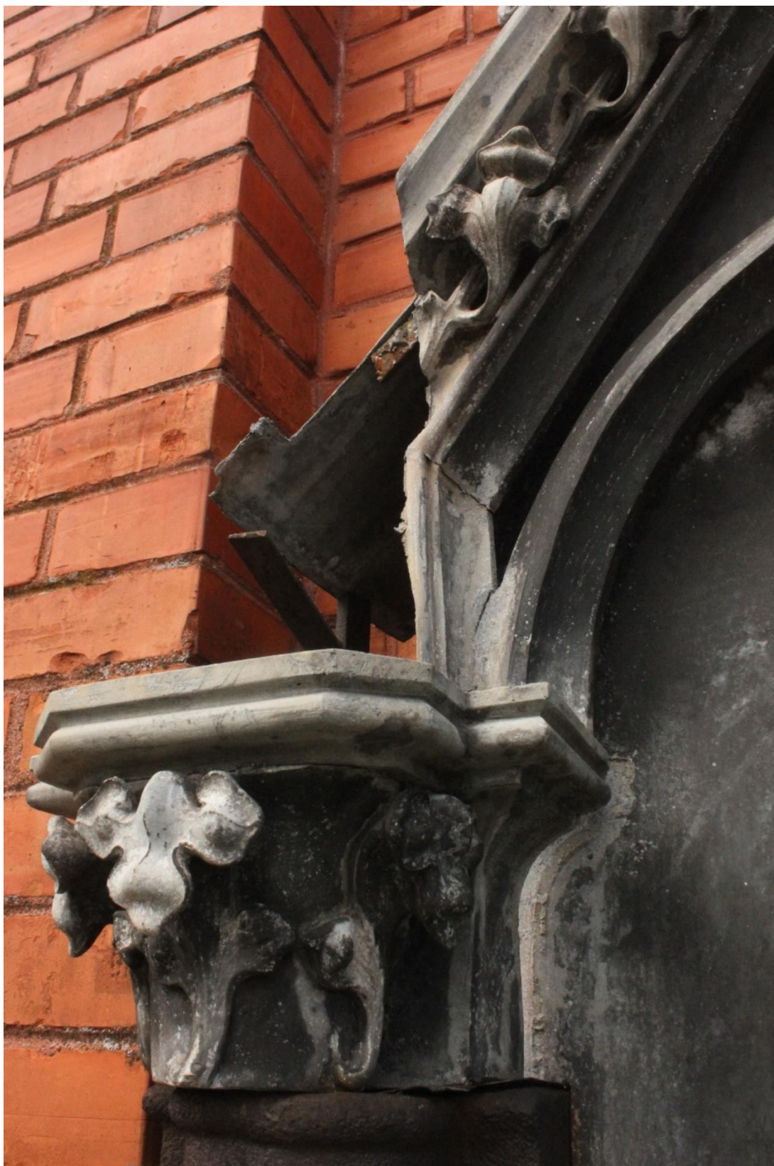
Fot. nr 47. Kaplica p.w. św. Szczepana z 1913 r. usytuowana na Starym cmentarzu w Ryglicach. Fragment zwieńczenia epitafium Stefana Leśniowskiego. Widoczne uszkodzenia i ubytki elementów metalowych. Stan przed konserwacją.
