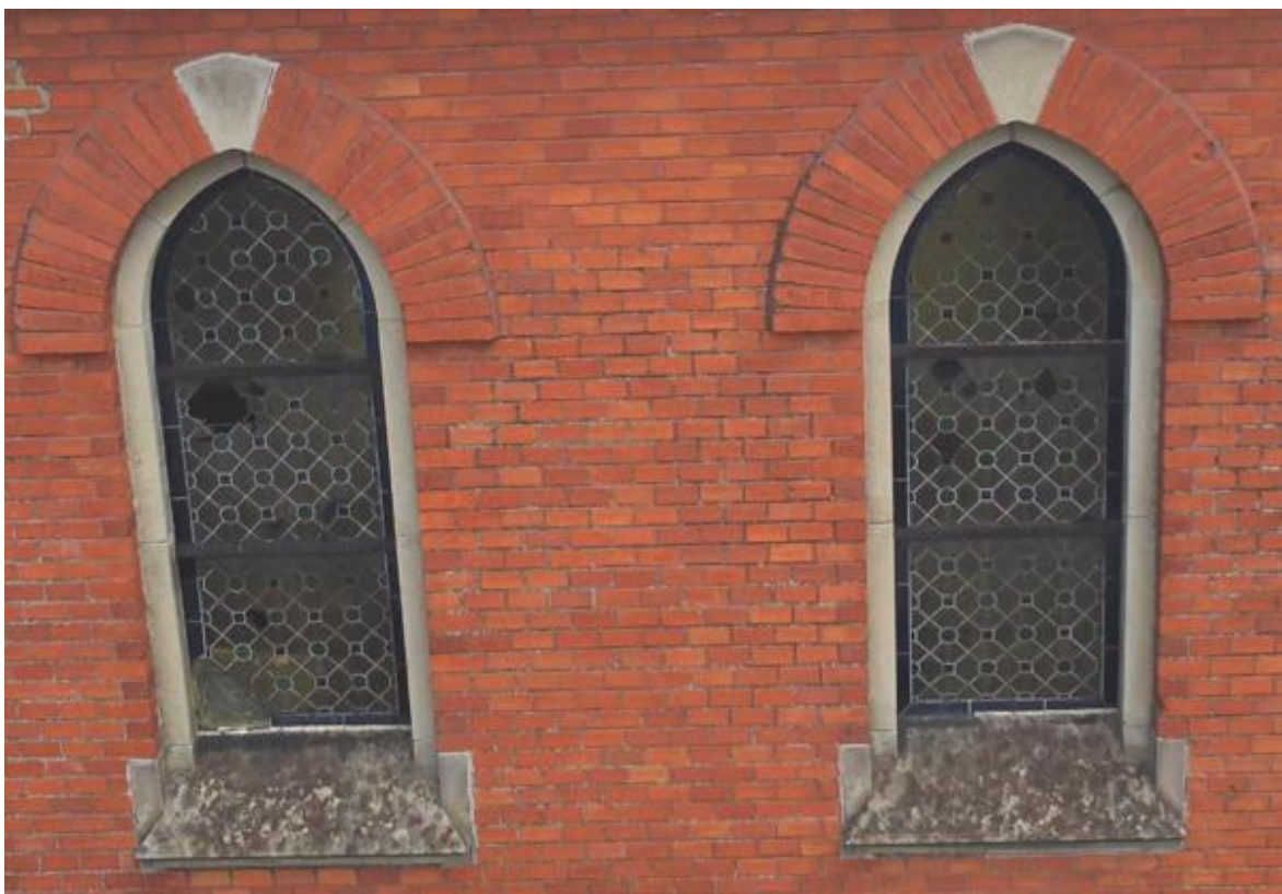
Zdjęcie 7. Dwa okna witrażowe znajdujące się ze strony zachodniej. Widoczne uszkodzenia i ubytki szklenia kwater witrażowych oraz doraźne zabezpieczenie narożnika folią. Fot. własna, maj 2024.
