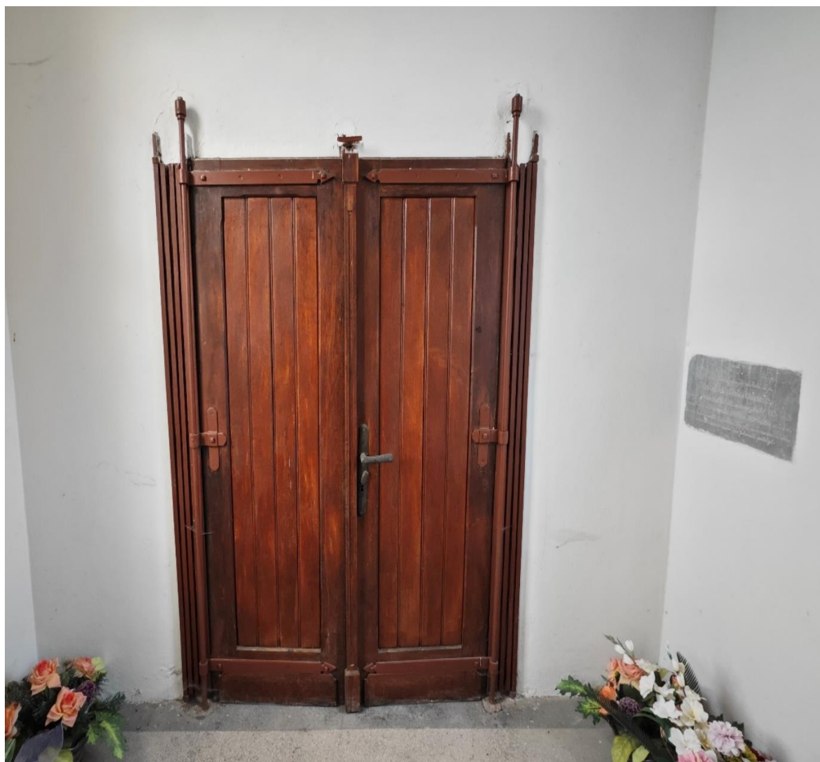
Fot. nr 37. Kaplica p.w. św. Szczepana z 1913 r. usytuowana na Starym cmentarzu w Ryglicach. Drzwi od strony wnętrza kaplicy. Po bokach widoczna zsunięta krata - żaluzja pozwalająca ograniczyć wstęp do kaplicy przy otwartych skrzydłach drzwi. Stan przed konserwacją.
