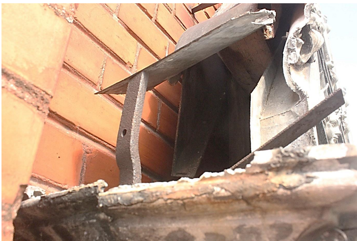
Fot. nr 45, 46. Kaplica p.w. św. Szczepana z 1913 r. usytuowana na Starym cmentarzu w Ryglicach. Zbliżenia fragmentów zwieńczenia epitafium Stefana Leśniowskiego. Widoczne uszkodzenia i ubytki elementów metalowych. Stan przed konserwacją.
