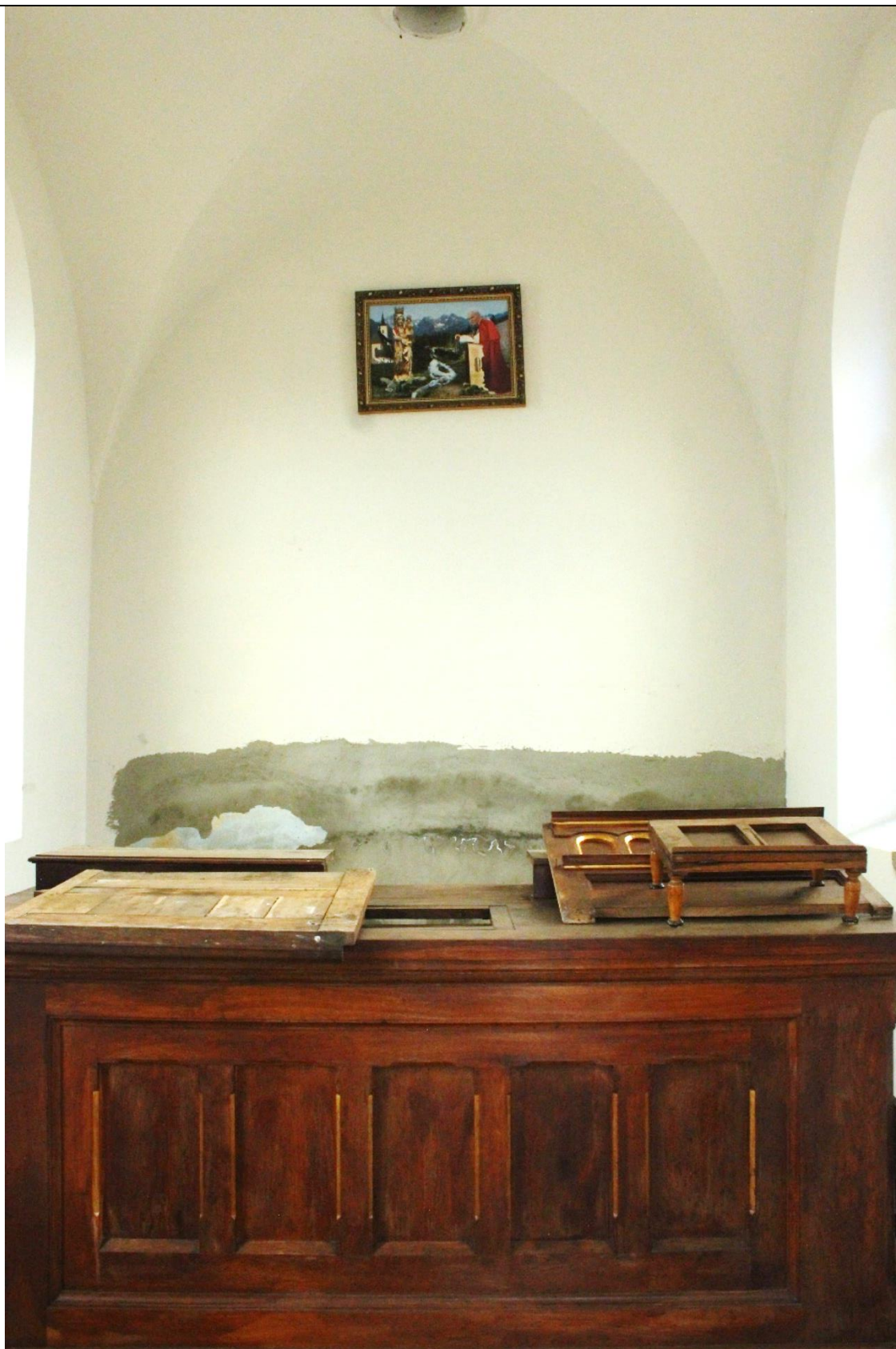
Fot. nr 21. Kaplica p.w. św. Szczepana z 1913 r. usytuowana na Starym cmentarzu w Ryglicach. Wnętrze kaplicy. Ściana południowa. Widoczny zdekompletowany ołtarz. Ściana w dolnej partii pokryta tynkiem cementowym. Stan przed konserwacją.
