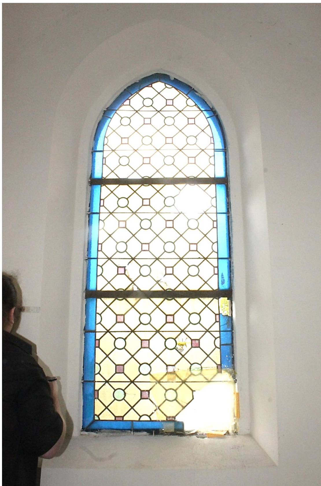
Fot. nr 40. Kaplica p.w. św. Szczepana z 1913 r. usytuowana na Starym cmentarzu w Ryglicach. Okno w ścianie zachodniej. Widoczne ubytki szklenia. Stan przed konserwacją.
