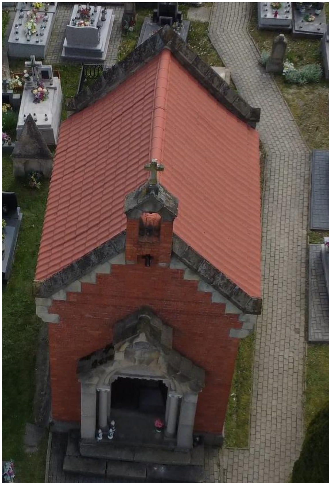
Zdjęcie 3. Wtórne pokrycie dachowe z blachodachówki w typie holenderki. Widoczne wygięcie potaci dachowych. Fot. własna, maj 2024.
