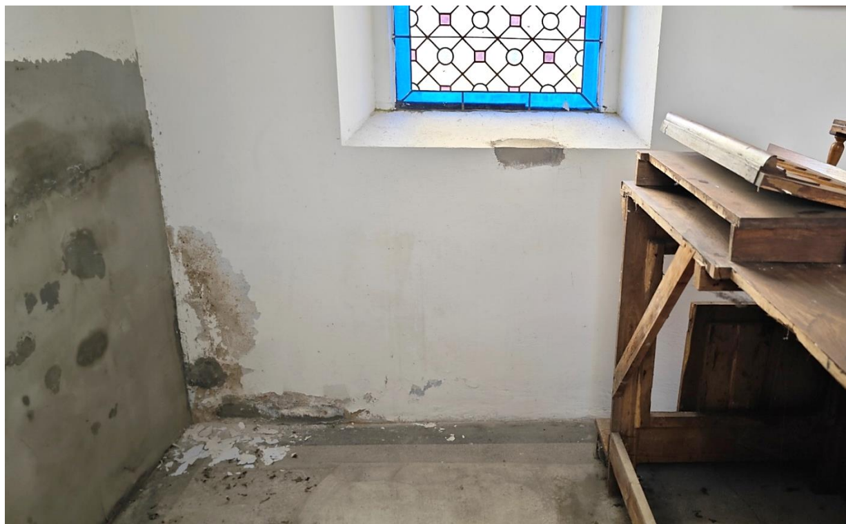
Fot. nr 25. Kaplica p.w. św. Szczepana z 1913 r. usytuowana na Starym cmentarzu w Ryglicach. Wnętrze kaplicy. Narożnik południowo zachodni. Widoczne uszkodzenie tynku powstałe na skutek zawilgocenia ściany. Stan przed konserwacją.
