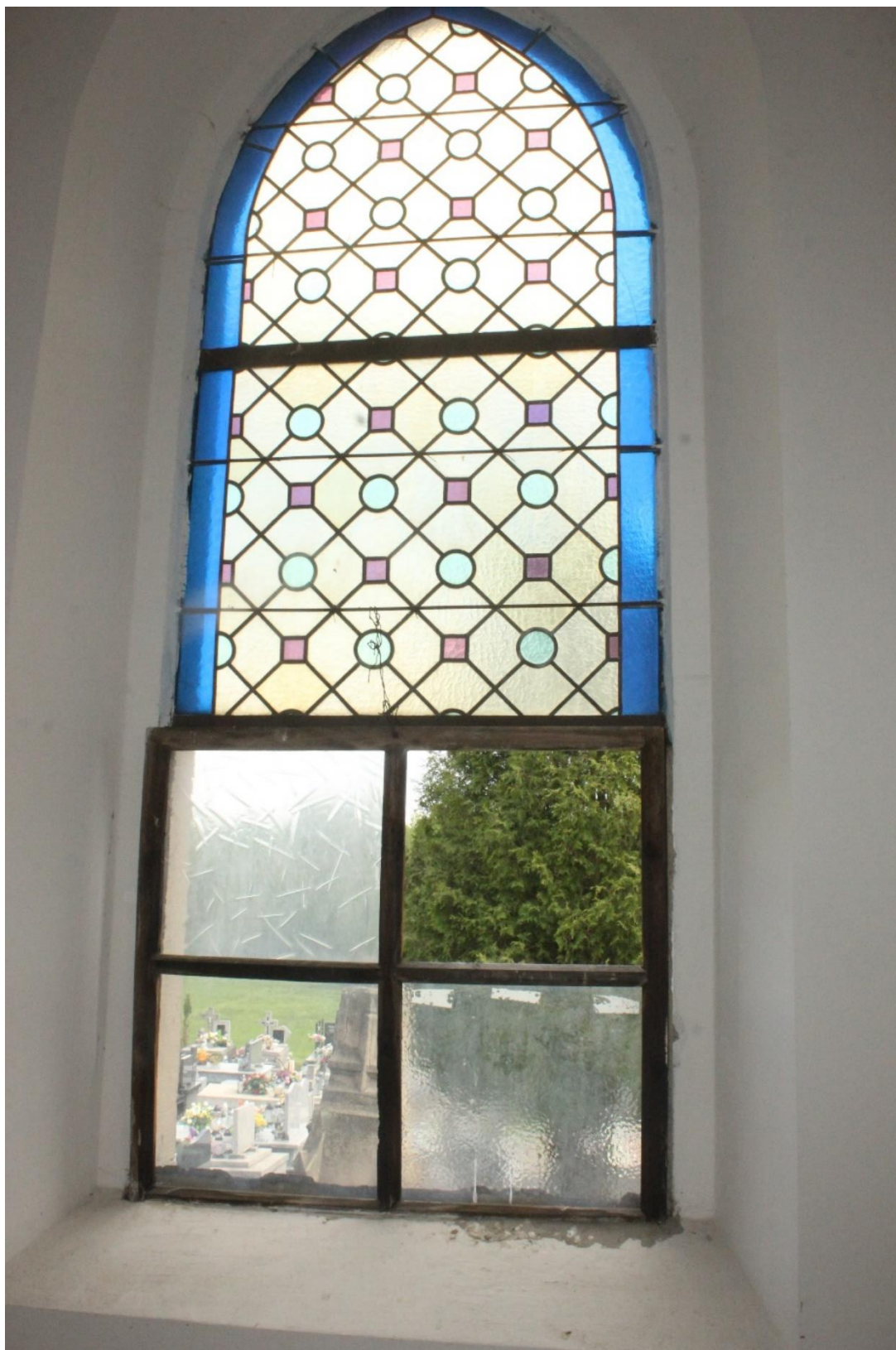
Fot. nr 39. Kaplica p.w. św. Szczepana z 1913 r. usytuowana na Starym cmentarzu w Ryglicach. Okno w ścianie wschodniej. Widoczne wtórne wypełnienie jednej z kwater okna. Stan przed konserwacją.
