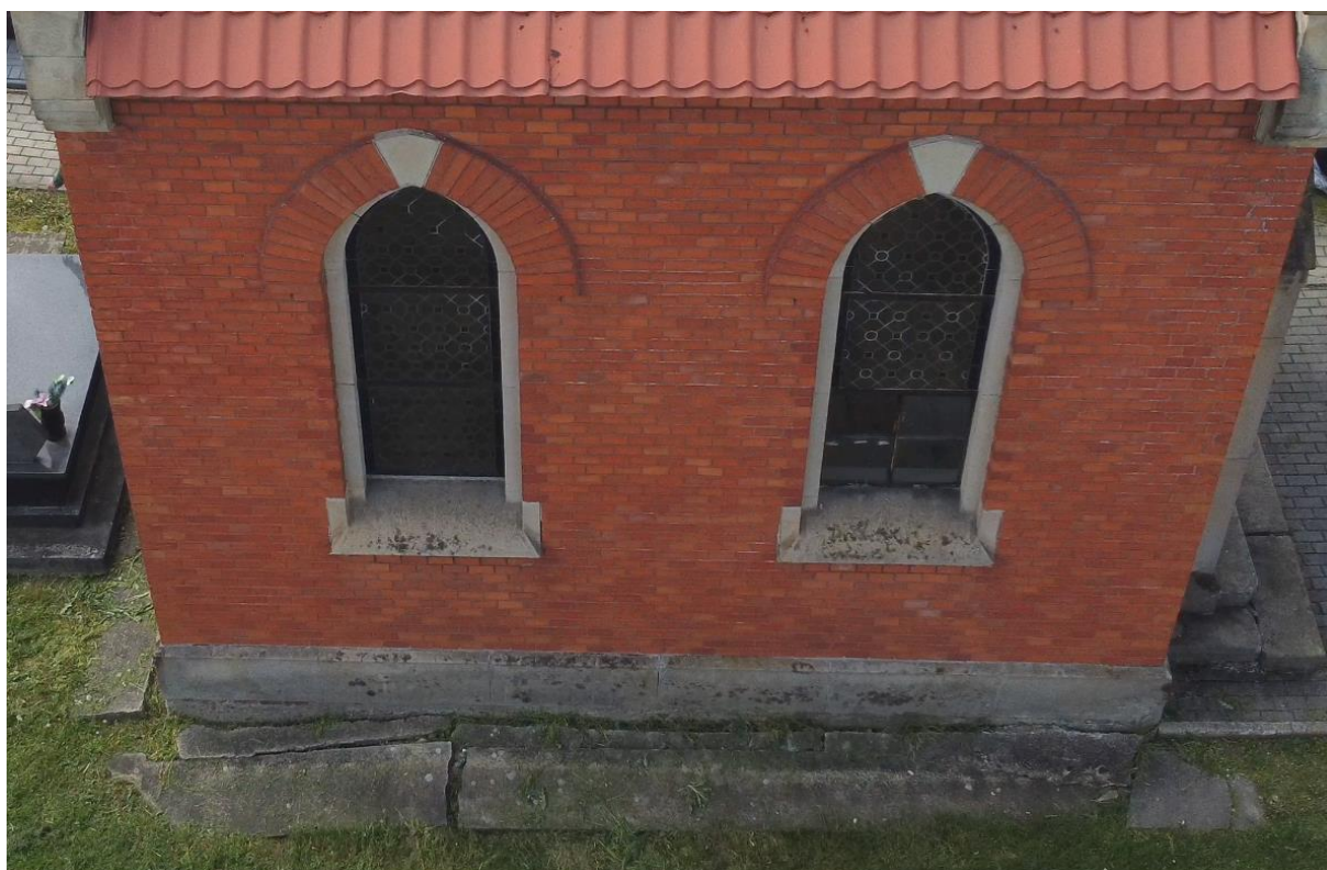
Zdjęcie 9. Zniszczone, spękanne pozostałości betonowej opaski od strony wschodniej elewacji. Fot. własna, maj 2024.
