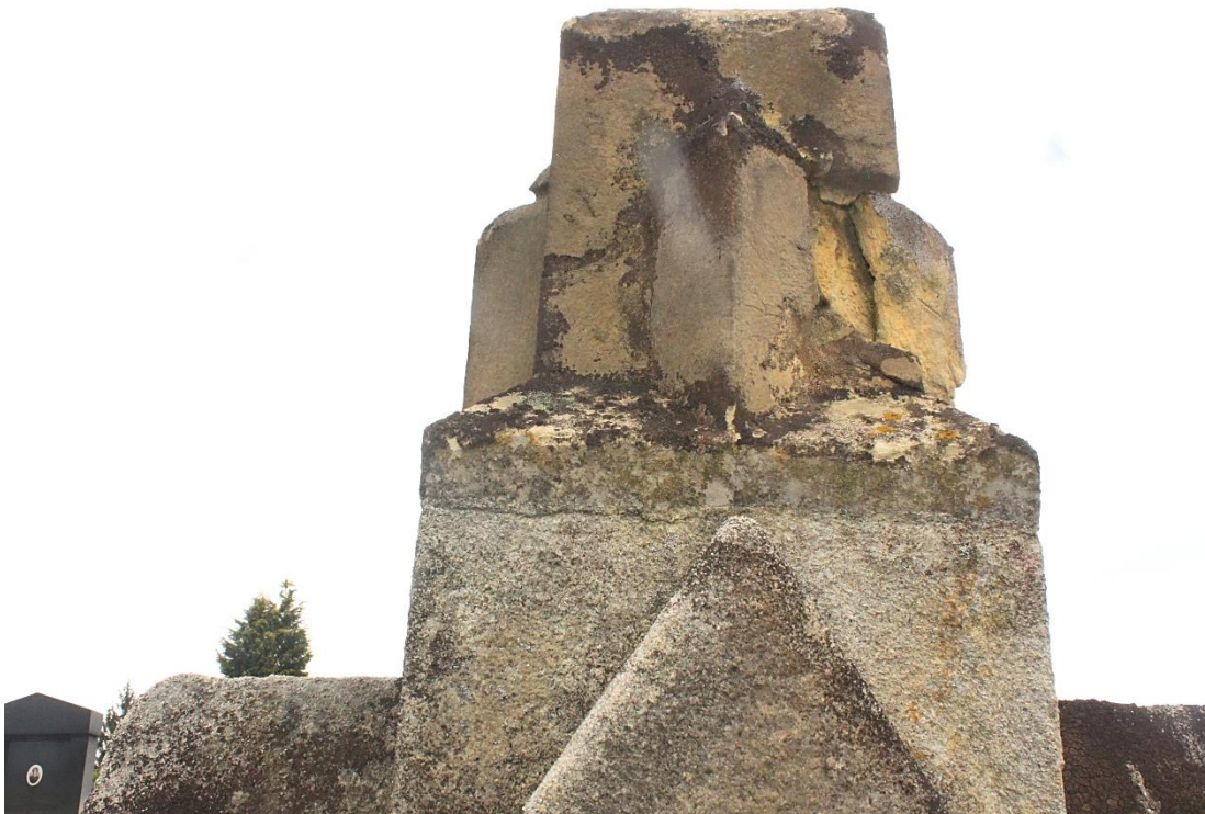
Fot. nr 7, 8. Nagrobek Józefa Michniewskiego, zm. w 1889 r., na Starym cmentarzu w Ryglicach. Zbliżenie fragmentu - podstawa krzyża. Widoczna degradacja struktury kamienia. Stan przed konserwacją.
