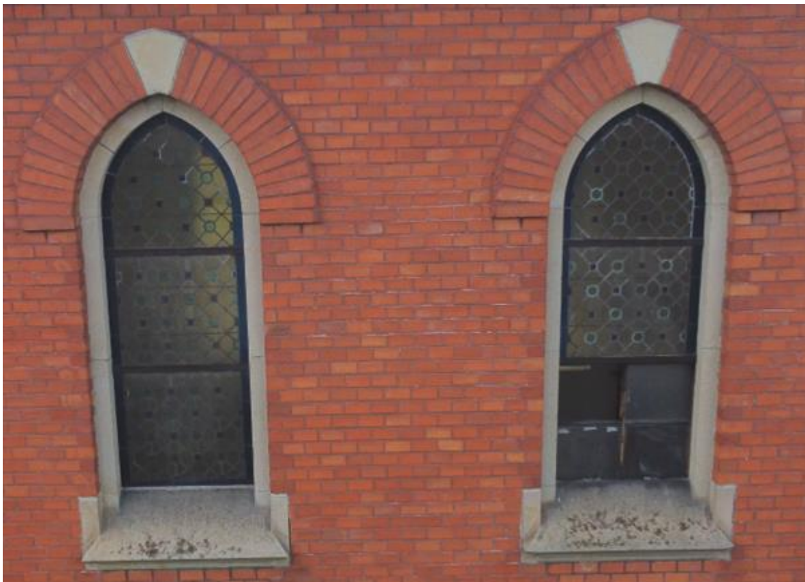
Zdjęcie 6. Dwa okna witrażowe znajdujące się ze strony wschodniej. Okno ptn.-wsch. z wtórną, współczesną dolną kwaterą. Fot. własna, maj 2024.
