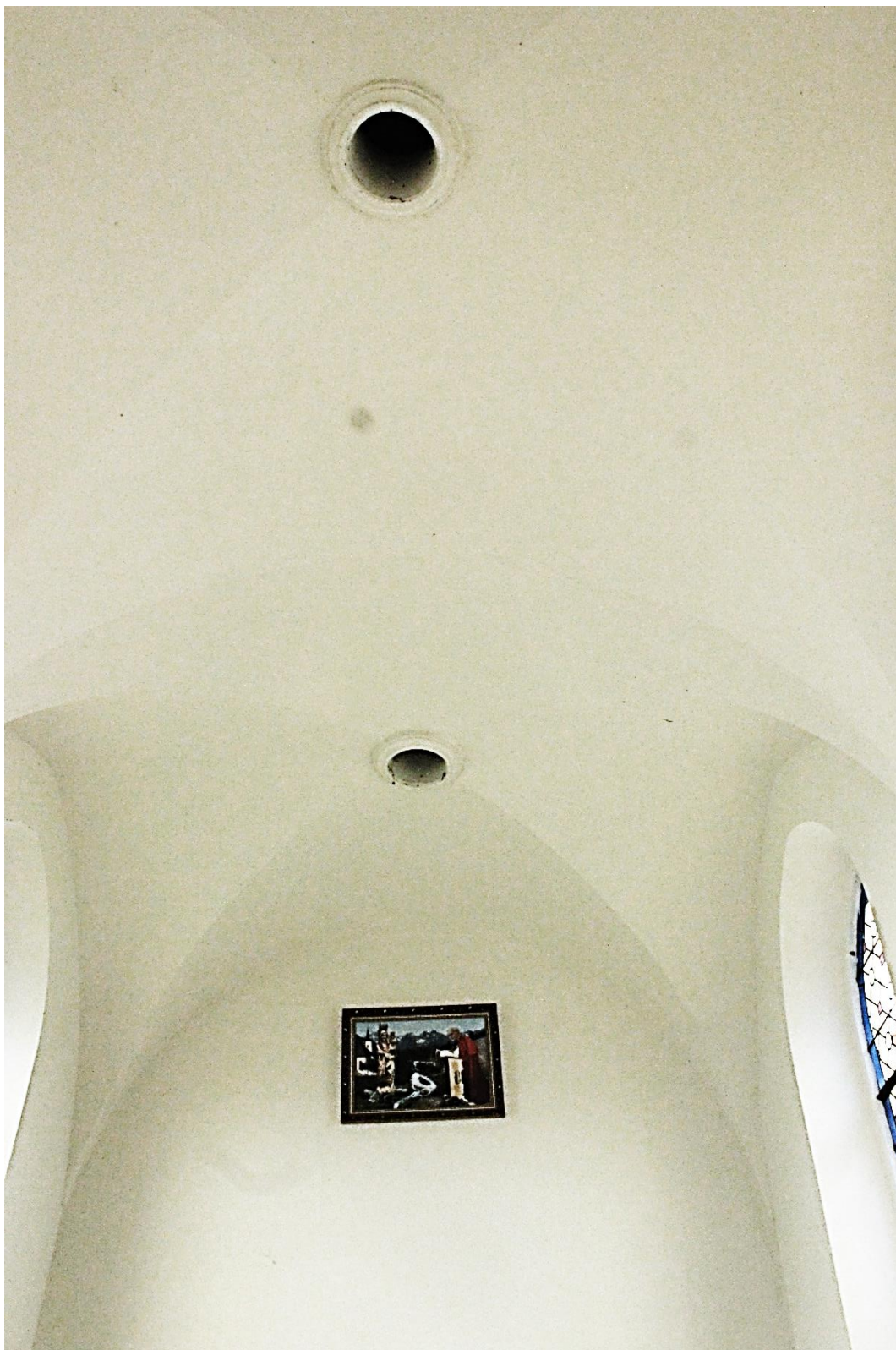
Fot. nr 28. Kaplica p.w. św. Szczepana z 1913 r. usytuowana na Starym cmentarzu w Ryglicach. Wnętrze kaplicy. Sklepienie krzyżowe z otworami wentylacyjnymi w zwornikach. Stan przed konserwacją.
