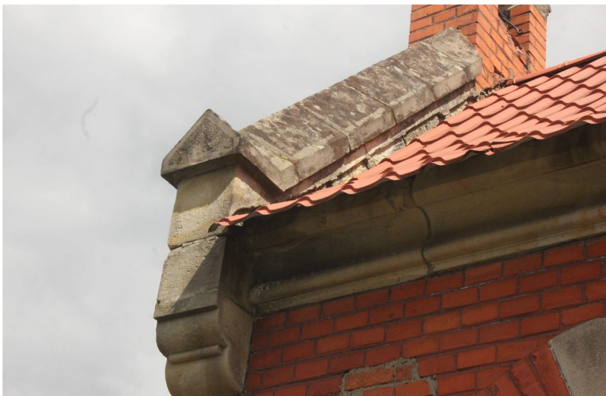
Fot. nr 17, 18. Kaplica p.w. św. Szczepana z 1913 r. usytuowana na Starym cmentarzu w Ryglicach. Ściana szczytowa po stronie północnej. Pokrycie dachu z dachówki wymienione zostało na blachę. Na styku z kamiennym zwieńczeniem ściany szczytowej widoczna linia ułożenia pierwotnej połaci dachowej. Obecnie połać opadła, brak jest obróbek blacharskich. Stan przed konserwacją.
