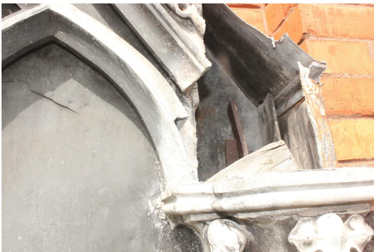
Fot. nr 48, 49. Kaplica p.w. św. Szczepana z 1913 r. usytuowana na Starym cmentarzu w Ryglicach. Zbliżenia fragmentów zwieńczenia epitafium Stefana Leśniowskiego. Widoczne uszkodzenia i ubytki elementów metalowych. Stan przed konserwacją.
