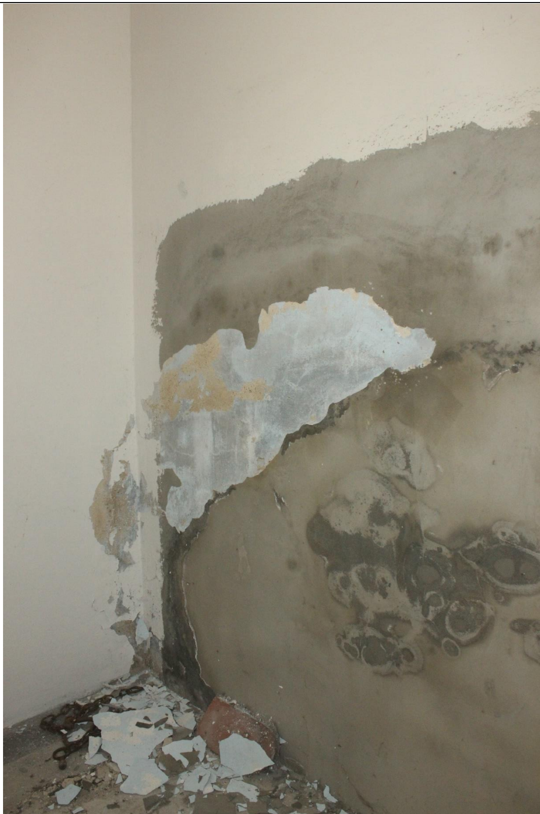
Fot. nr 26. Kaplica p.w. św. Szczepana z 1913 r. usytuowana na Starym cmentarzu w Ryglicach. Wnętrze kaplicy. Narożnik południowo wschodni. Widoczne uszkodzenie struktury tynku na skutek zawilgocenia ściany. Usunięty fragment zacierki cementowej, poniżej widoczny zakres uzupełnienia tynku. Spod zacierki cementowej odsłonięto pierwotny tynk i warstwę monochromii w kolorze szarobłękitnym. Stan przed konserwacją.
