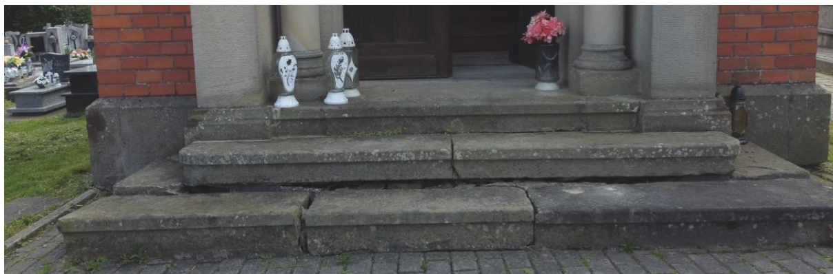
Zdjęcie 8. Kamienne, blokowe schody wejściowe. Widoczne przemieszczenia i miejscowe zapadnięcie stopni. Fot. własna, maj 2024.
