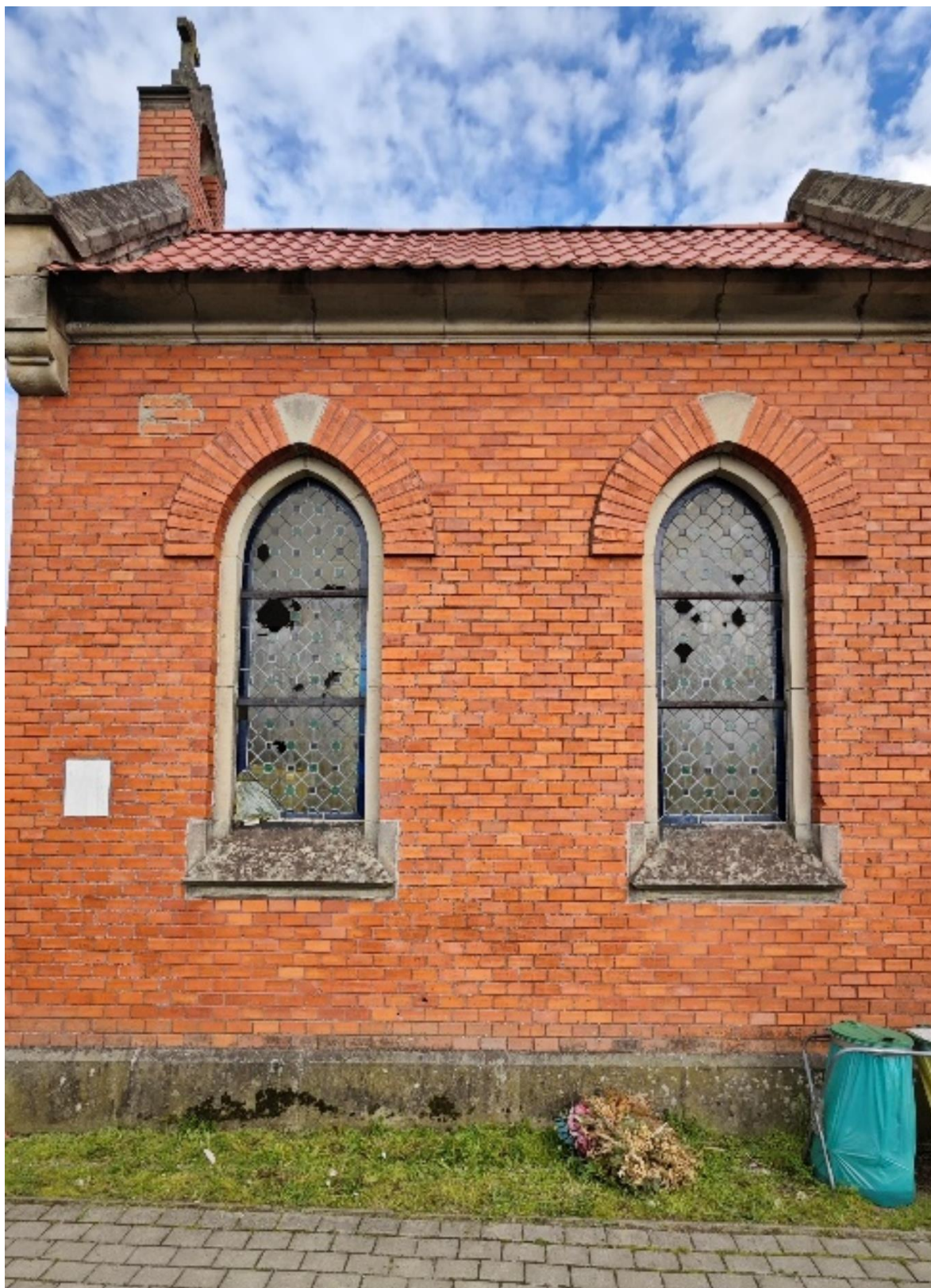
Fot. nr 41. Kaplica p.w. św. Szczepana z 1913 r. usytuowana na Starym cmentarzu w Ryglicach. Okna w ścianie zachodniej. Widoczne ubytki szklenia. Stan przed konserwacją.
