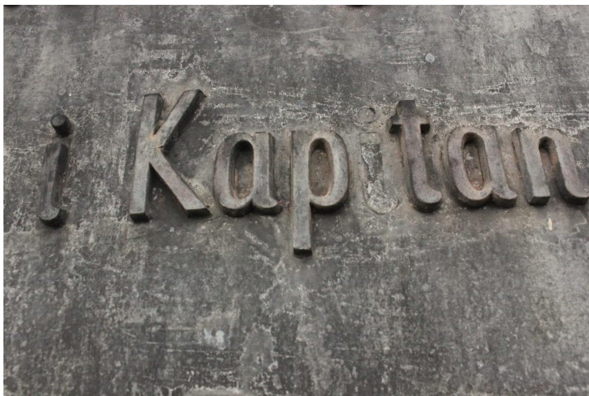
Fot. nr 59, 60. Kaplica p.w. św. Szczepana z 1913 r. usytuowana na Starym cmentarzu w Ryglicach. Tablica epitafijna Stefana Leśniowskiego- fragmenty. Litery z imieniem i nazwiskiem zmarłego były najprawdopodobniej złożone. Poniżej widoczny ubytek, po brakującej literze „i”. Stan przed konserwacją.
