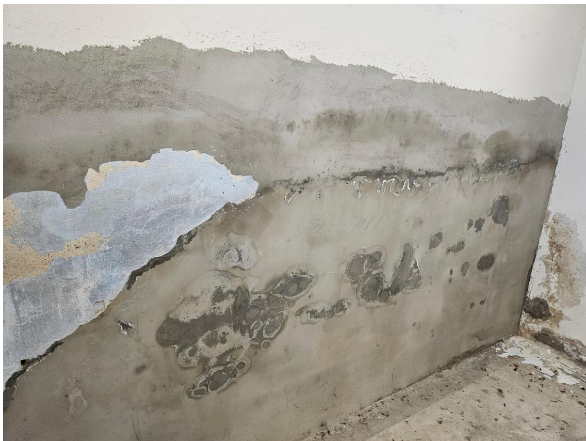
Zdjęcie 2. Wnętrze kaplicy, ściana południowo-zachodnia. Widoczne uszkodzenie tynku na skutek zawilgocenia ściany; ściana południowa z wtórną warstwą zacierki cementowej.
