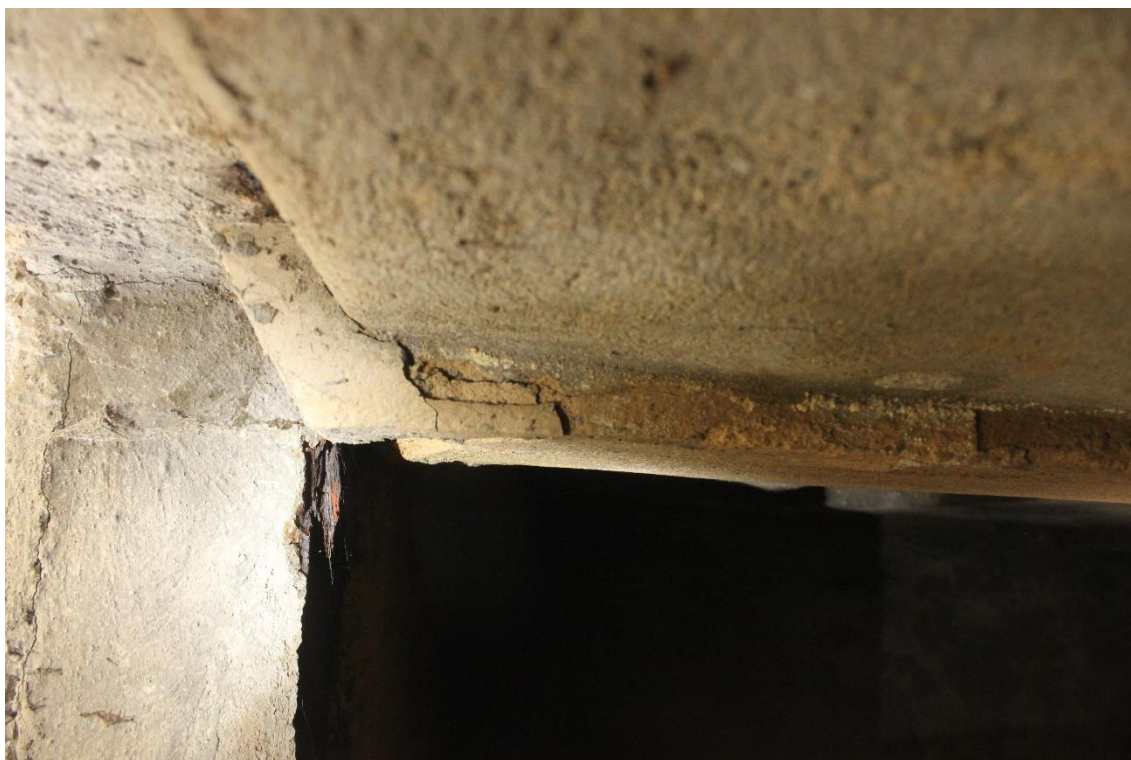
Fot. nr 35. Kaplica p.w. św. Szczepana z 1913 r. usytuowana na Starym cmentarzu w Ryglicach. Wnętrze krypty grobowej. Płaskownik stalowy przy krawędzi otworu. Widoczna korozja metalu. Stan przed konserwacją.
