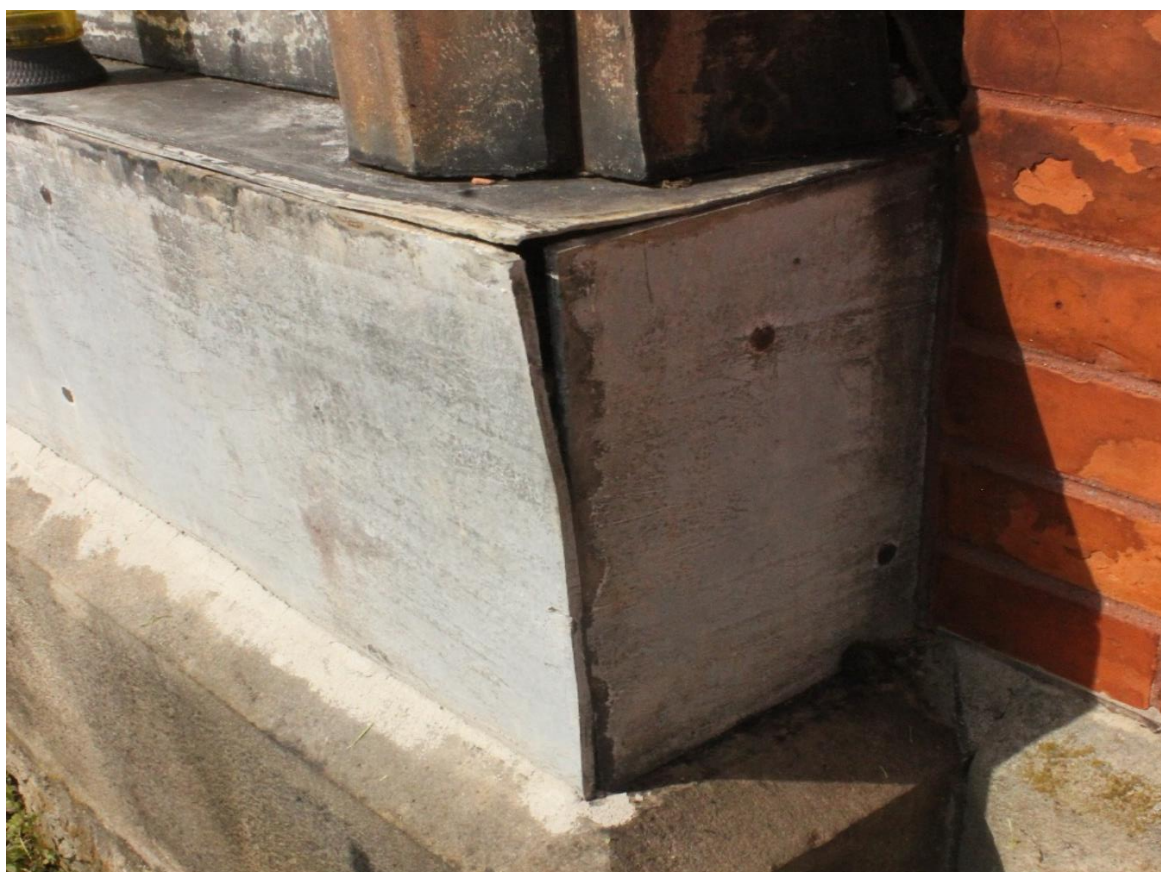
Fot. nr 55, 56. Kaplica p.w. św. Szczepana z 1913 r. usytuowana na Starym cmentarzu w Ryglicach. Zbliżenia fragmentów podstawy epitafium Stefana Leśniowskiego. Widoczne uszkodzenia i deformacje elementów, doraźne naprawy. Stan przed konserwacją.
