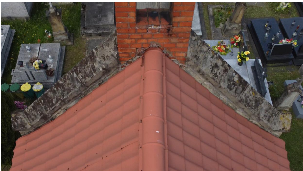
Zdjęcie 4. Zbliżenie na styk połaci dachowej z kamienną oprawą ściany szczytowej. Widoczny brak obróbek blacharskich i uszczelnienia. Fot. własna, maj 2024.
