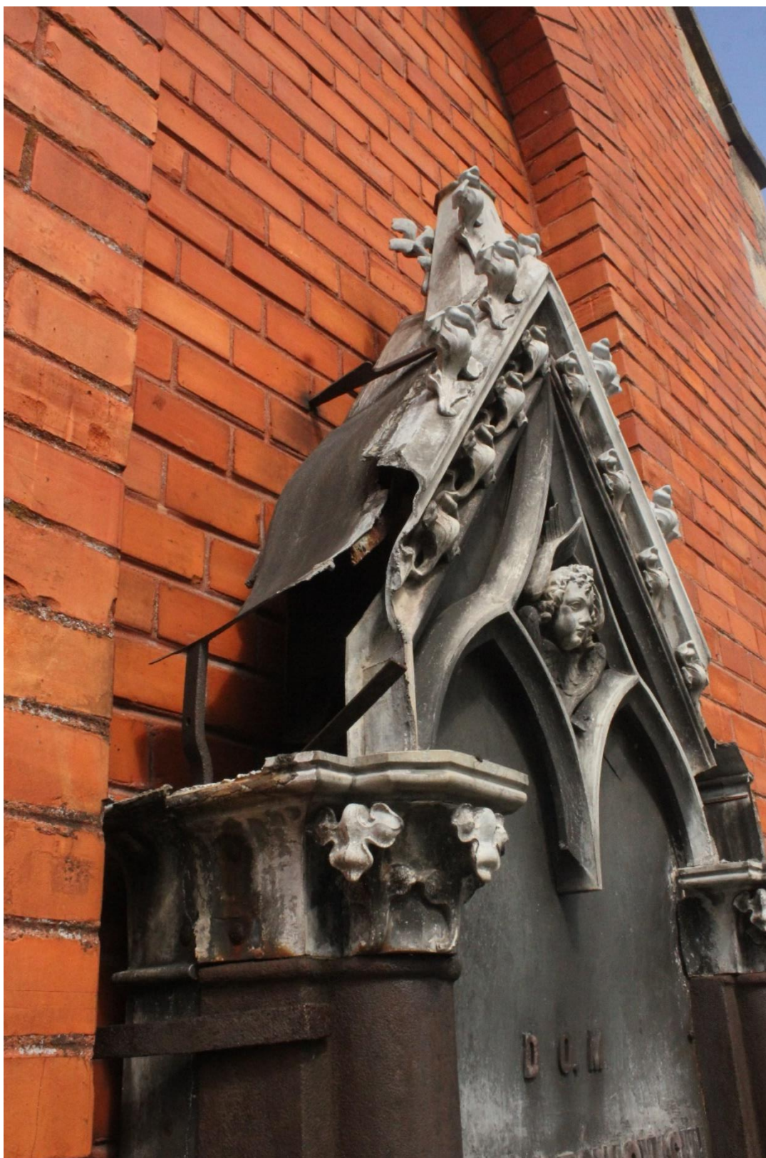
Fot. nr 44. Kaplica p.w. św. Szczepana z 1913 r. usytuowana na Starym cmentarzu w Ryglicach. Zwieńczenie epitafium Stefana Leśniowskiego. Widoczne uszkodzenia i ubytki elementów metalowych. Stan przed konserwacją.
