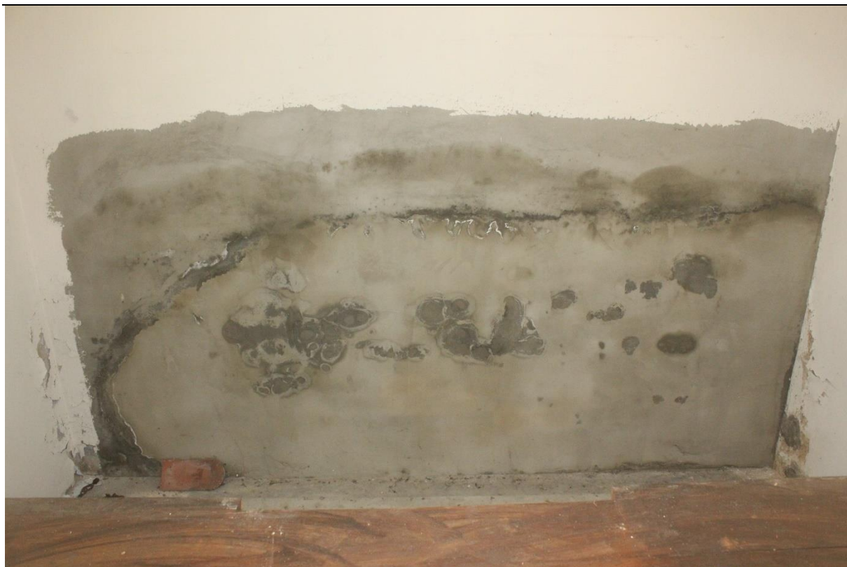
Fot. nr 24. Kaplica p.w. św. Szczepana z 1913 r. usytuowana na Starym cmentarzu w Ryglicach. Wnętrze kaplicy. Fragment ściany południowej. Widoczne uzupełnienie tynku wykonane zaprawa cementową. Stan przed konserwacją.
