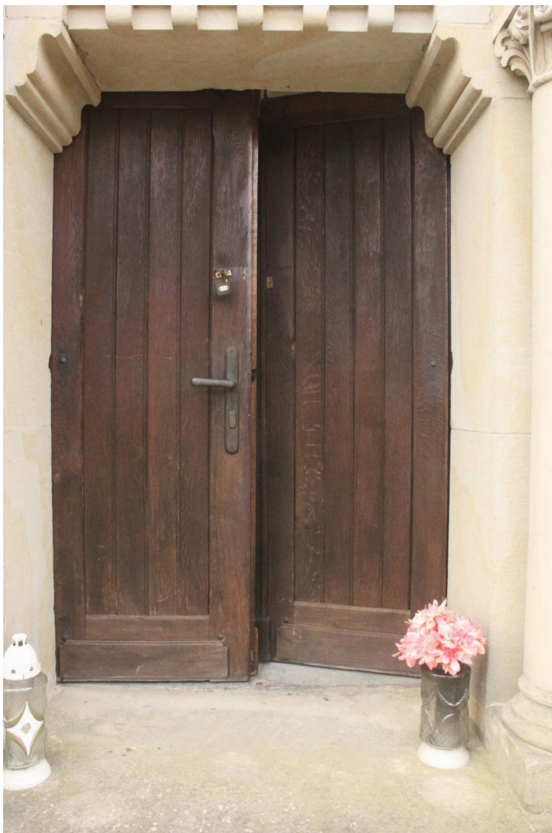
Fot. nr 36. Kaplica p.w. św. Szczepana z 1913 r. usytuowana na Starym cmentarzu w Ryglicach. Wejście do kaplicy. Widoczne drzwi dębowe, pełne dwuskrzydłowe, klepkowe. Stan przed konserwacją.
