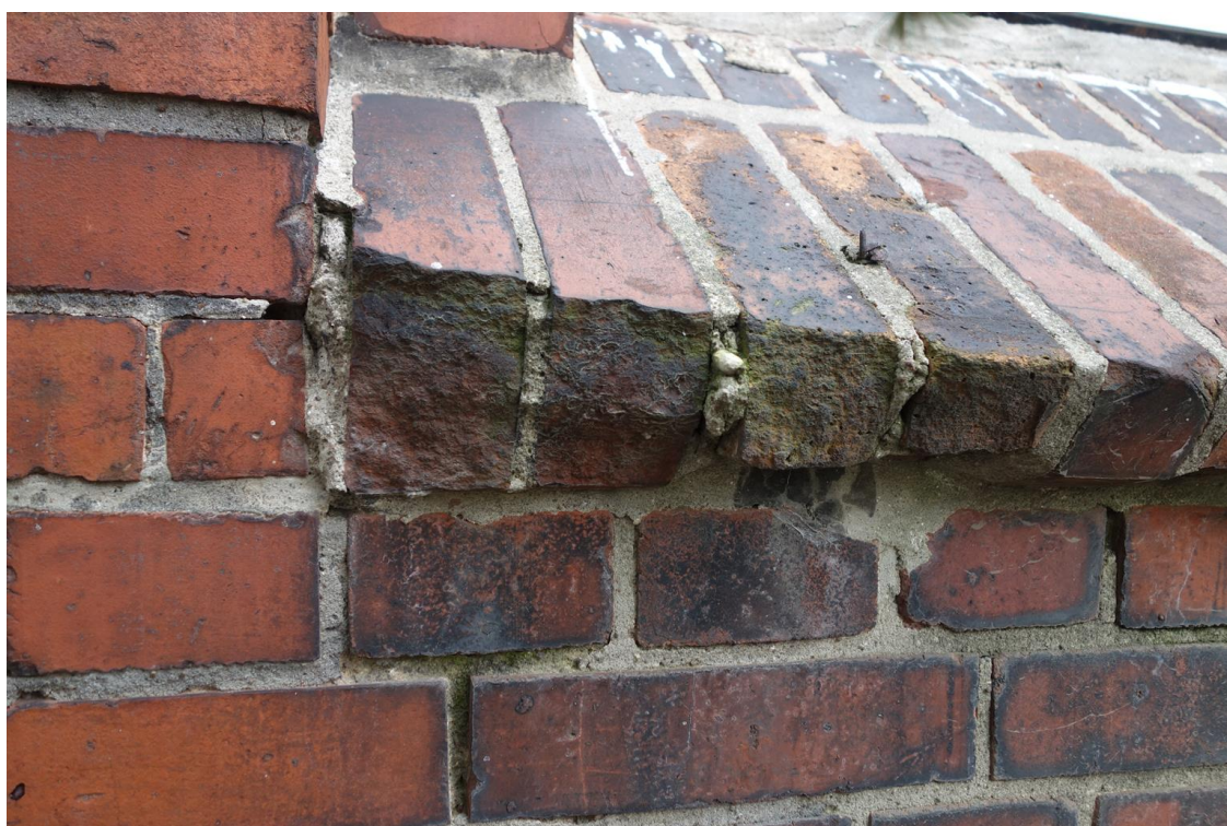
Fot. 46. Ubytek mechaniczny parapetu.
