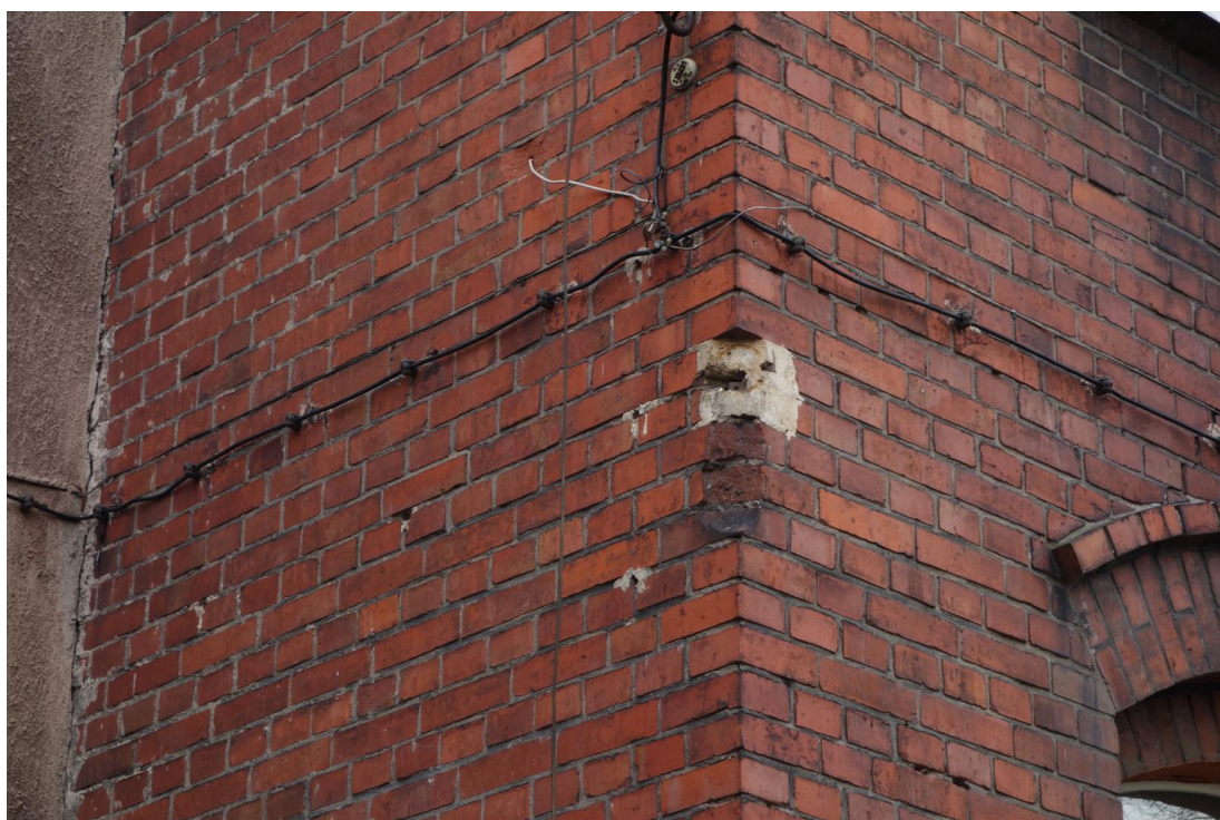
Fot. 33. Bezużyteczne okablowanie i ubytki mechaniczne cegieł.
