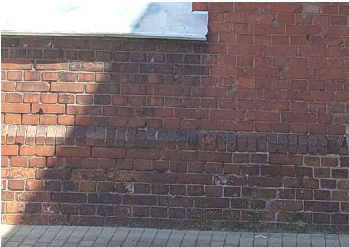
Fot. 7. Ubytki spoiny, rozwarstwienia, pęknięcia muru, porosty, ślady zasolenia - elewacja podwórzowa, prawa strona.
