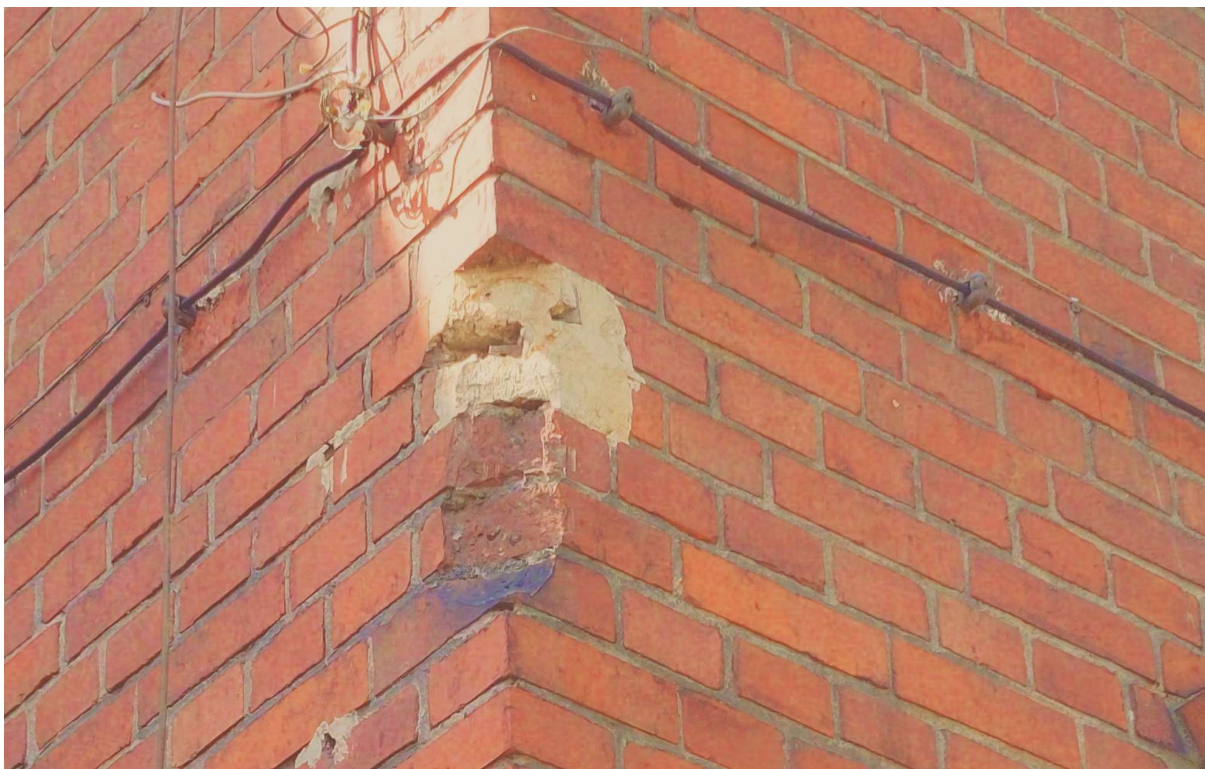
Fot. 4. Ubytki cegieł - uszkodzenia mechaniczne, zbędne okablowania – elewacja frontowa, lewy narożnik.
