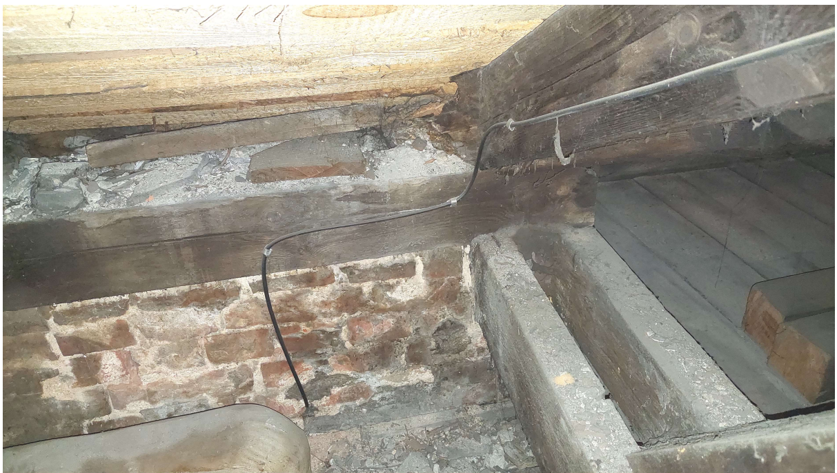
Fot. 10. Fragment więźby dachowej przy ryzalicie - strona południowa. Zbutwiałe końcówki murlaty i krokwi.
