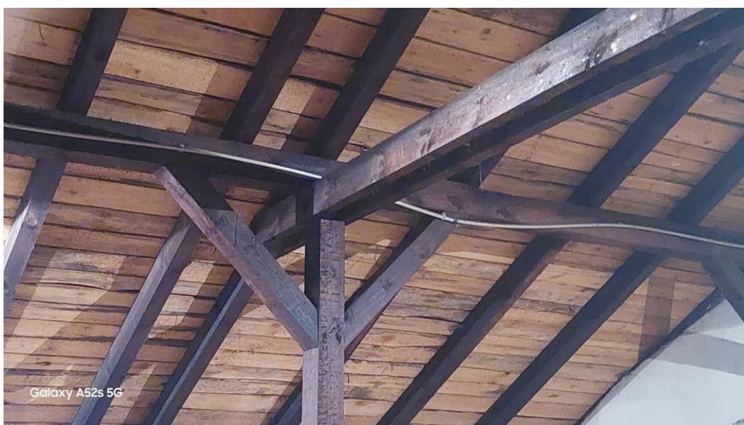
Fot. 60. Widok na więźbę z odeskowaniem.
