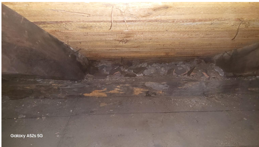
Fot. 67. Skutki niszczącego działania wody i porażenia mikrobiologicznego.
