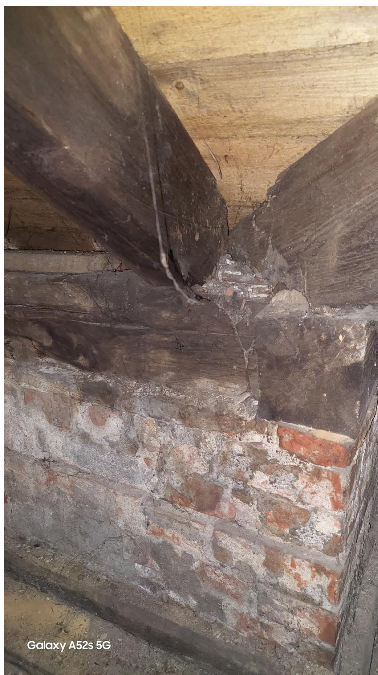
Fot. 65. Fragment konstrukcji drewnianej z zabrudzeniami i zniszczeniami.
