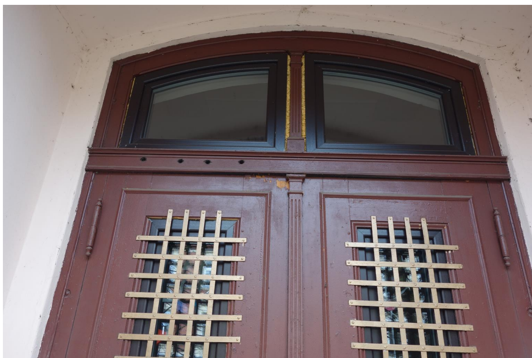
Fot. 29. Fragment stolarki drzwiowej z nadświetłem.
