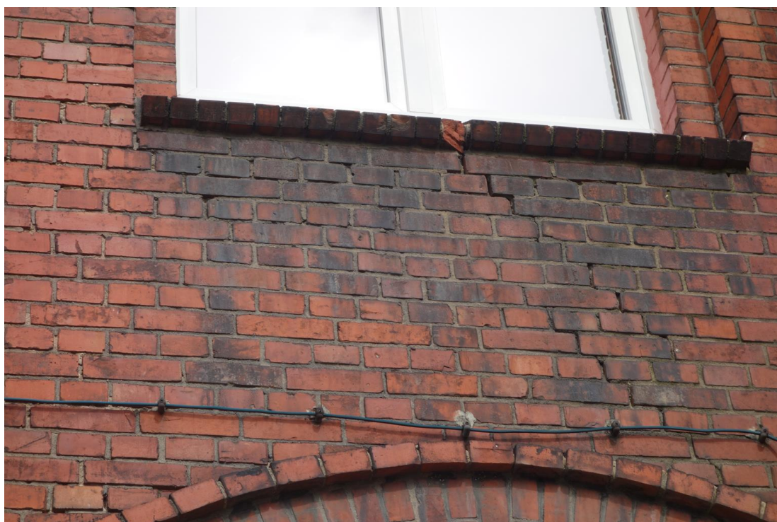
Fot. 34. Zniszczenia mechaniczne parapetu, pęknięcia muru i smolista patyna.
