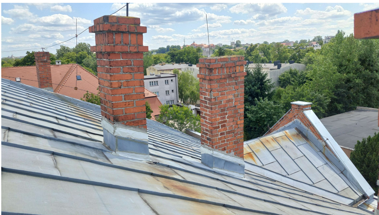
Fot. 8. Widok dachu. Pokrycie dachu na rąbek stojący podwójny. Widoczne ślady korozji i miejscowych napraw.
