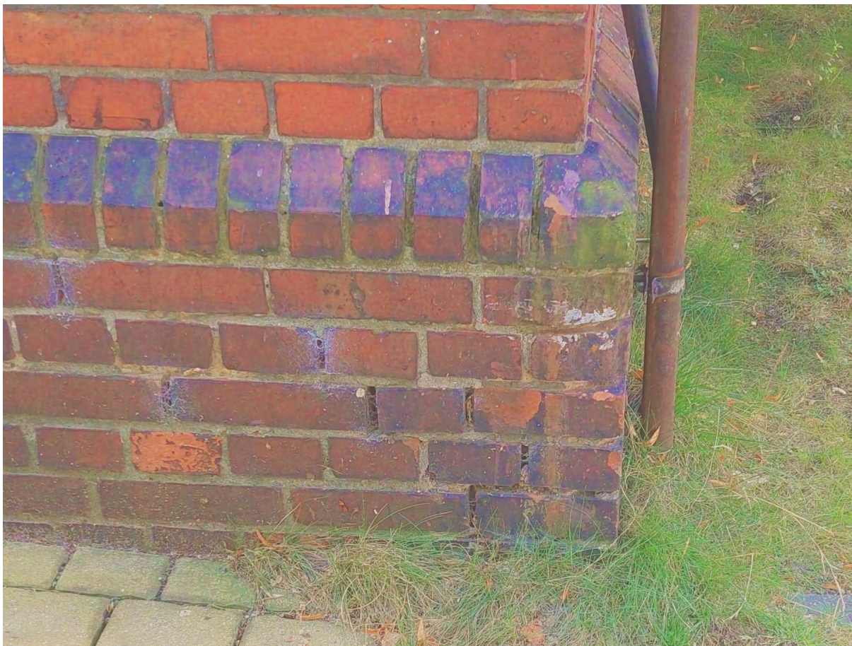
Fot. 5. Głęboko wypłukana spoina na cokole – elewacja frontowa, prawy narożnik.
