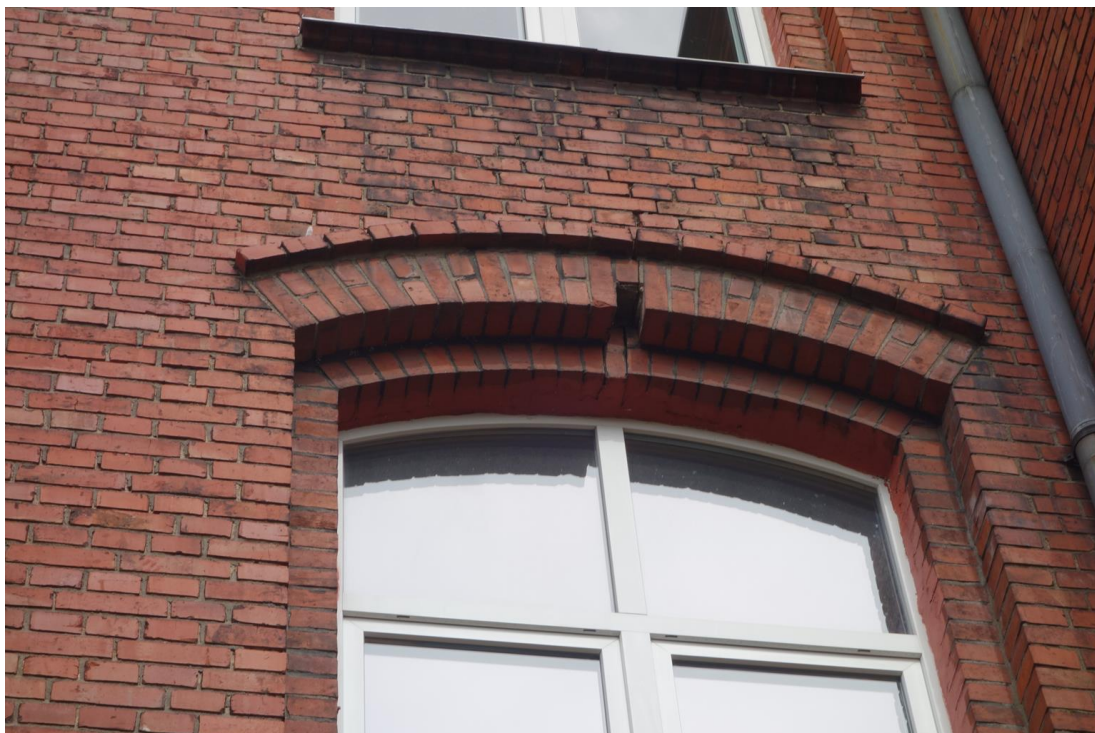
Fot. 35. Widoczne ubytki cegieł.
