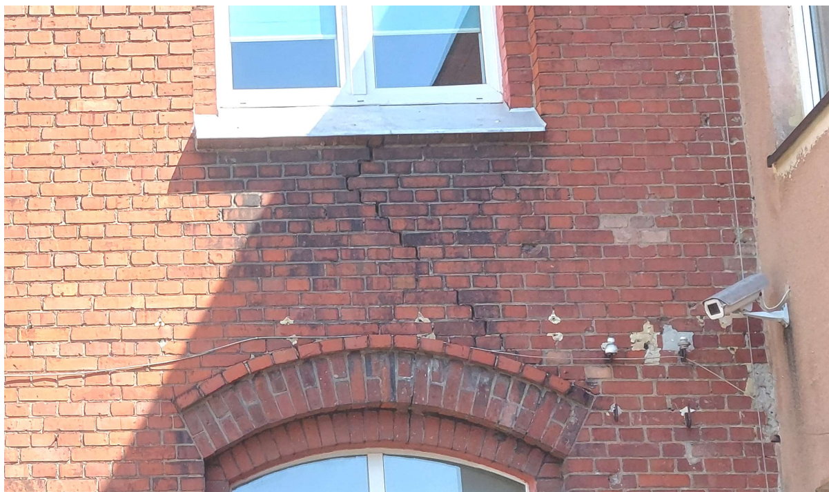
Fot. 1. Rozwarstwienie cegieł w pasie międzyokiennym, parter – 1 piętro na elewacji podwórzowej, oś 13.
