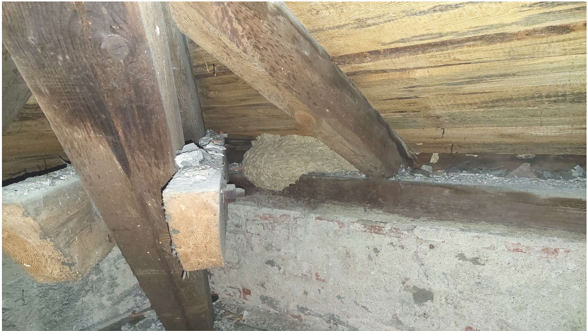
Fot. 9. Fragment więźby dachowej – narożnik południowo-wschodni. Zainfekowana murlata i krokwie, brak izolacji oddzielającej konstrukcję drewnianą od muru.
