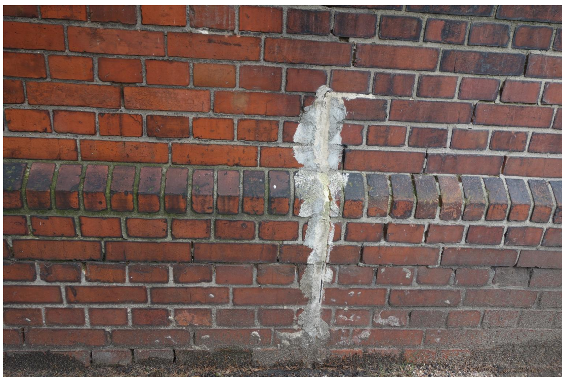
Fot. 40. Destrukcja muru, wtórne źle przeprowadzone reperacje.
