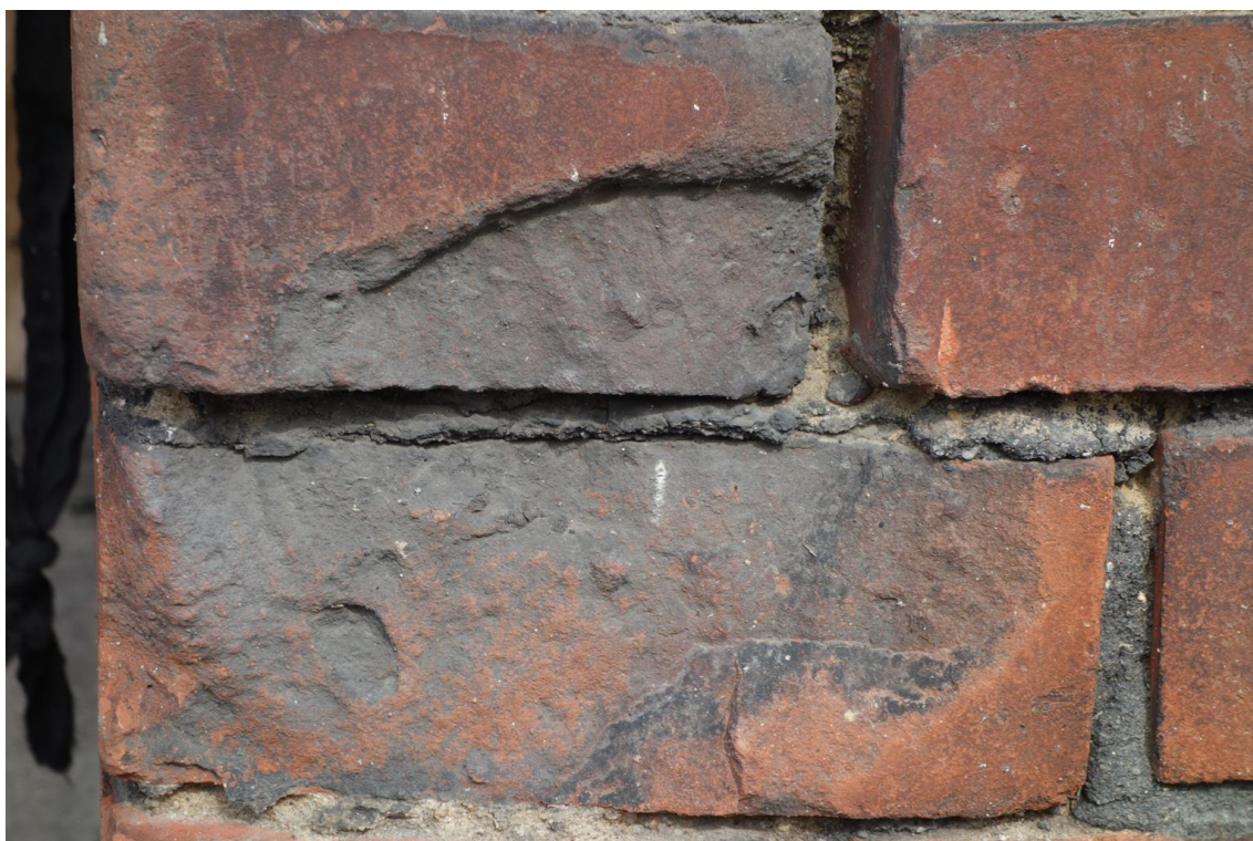
Fot. 50. Destrukcja materiału ceramicznego.
