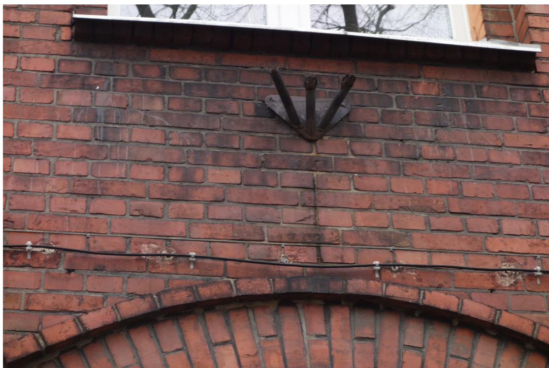
Fot. 31. Zniszczony i skorodowany uchwyt na flagę.
