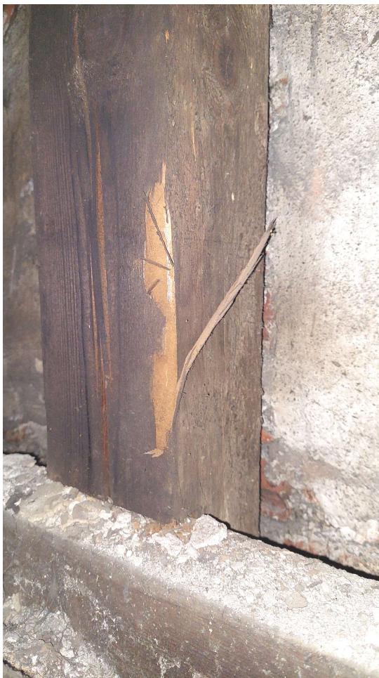
Fot. 12 i 13. Fragment więźby dachowej przy ryzalicie - strona południowa. Uszkodzenia słupa przez szkodniki drewna - owady.
