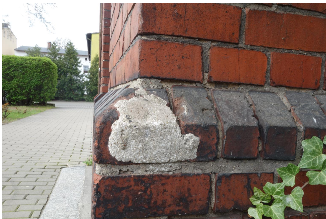
Fot. 48. Wtórne uzupełnienie ubytku cegieł.
