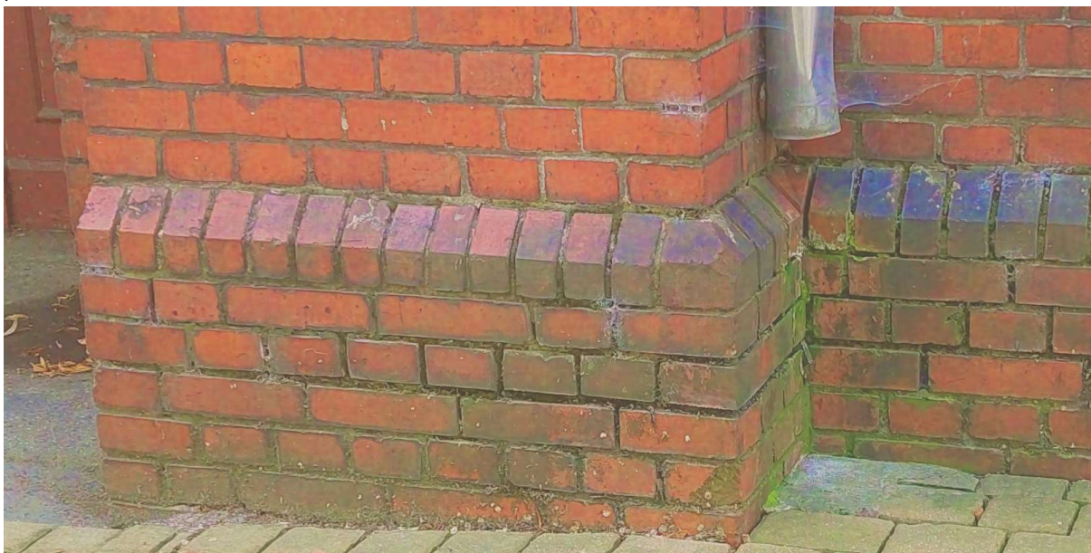
Fot. 6. Ubytki spoiny, infekcja glonami i porostami na cokole budynku - elewacja frontowa.
