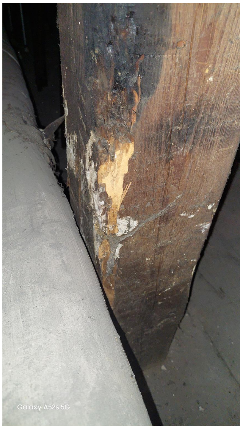
Fot. 68. Widoczne zniszczenia mechaniczne i biologiczne drewna.
