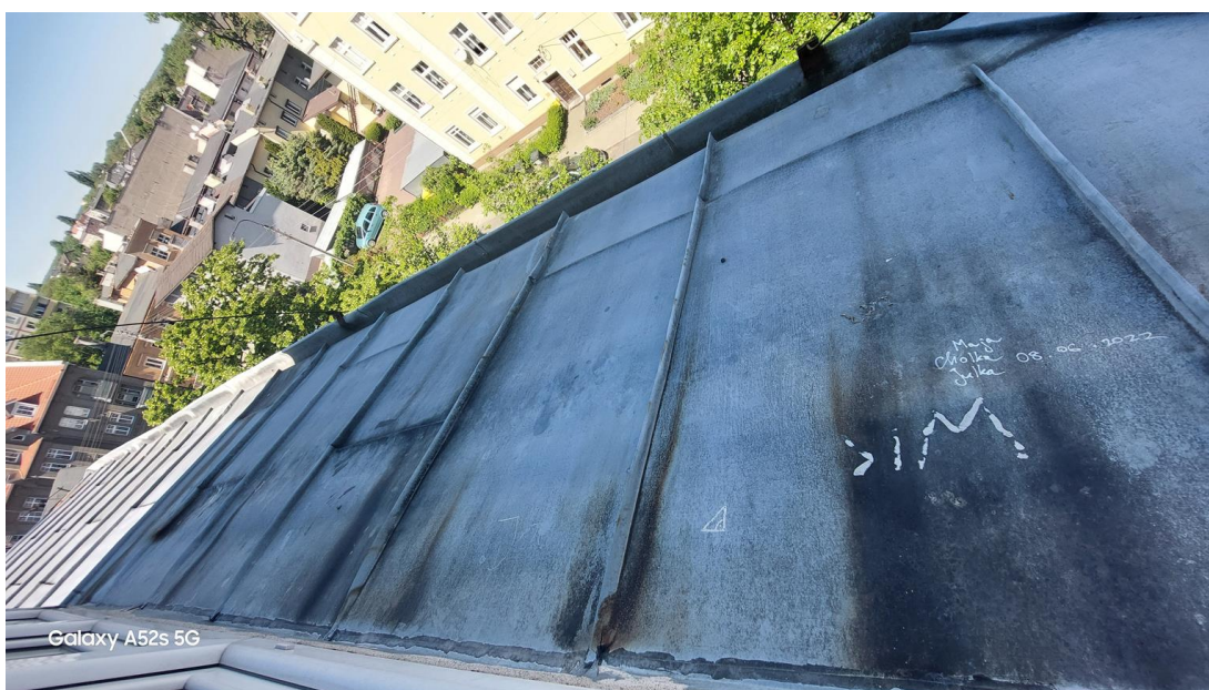
Fot. 55. Widok na łączenia i montaż blachy.
