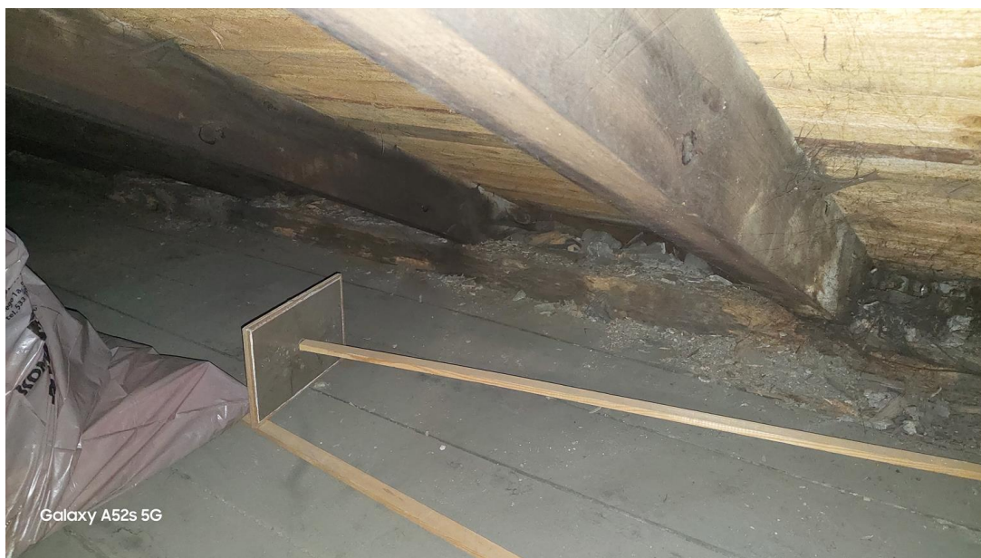
Fot. 66. Fragmenty zdestruowane przeznaczone do wymiany.
