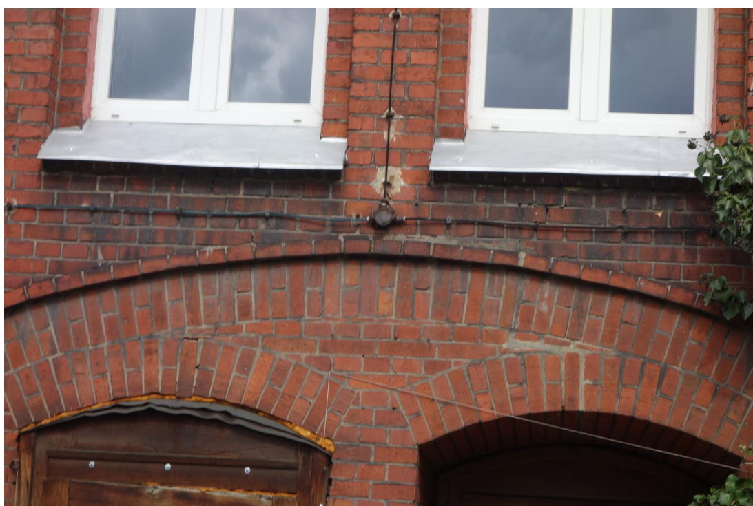
Fot. 32. Bezużyteczne kablowanie i zniszczenia cegieł.
