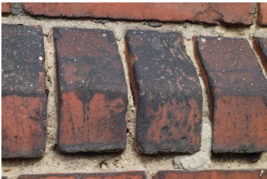
Fot. 49. Przebarwienia spowodowane rozwojem mikroflory, wypłukanie spoin.
