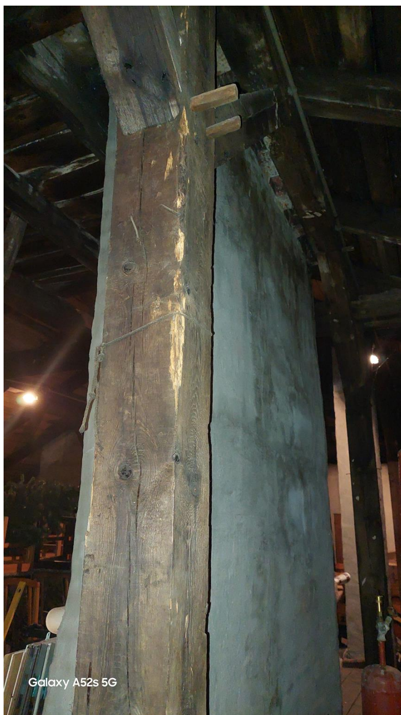
Fot. 64. Destrukcja belki – ubytki mechaniczne.
