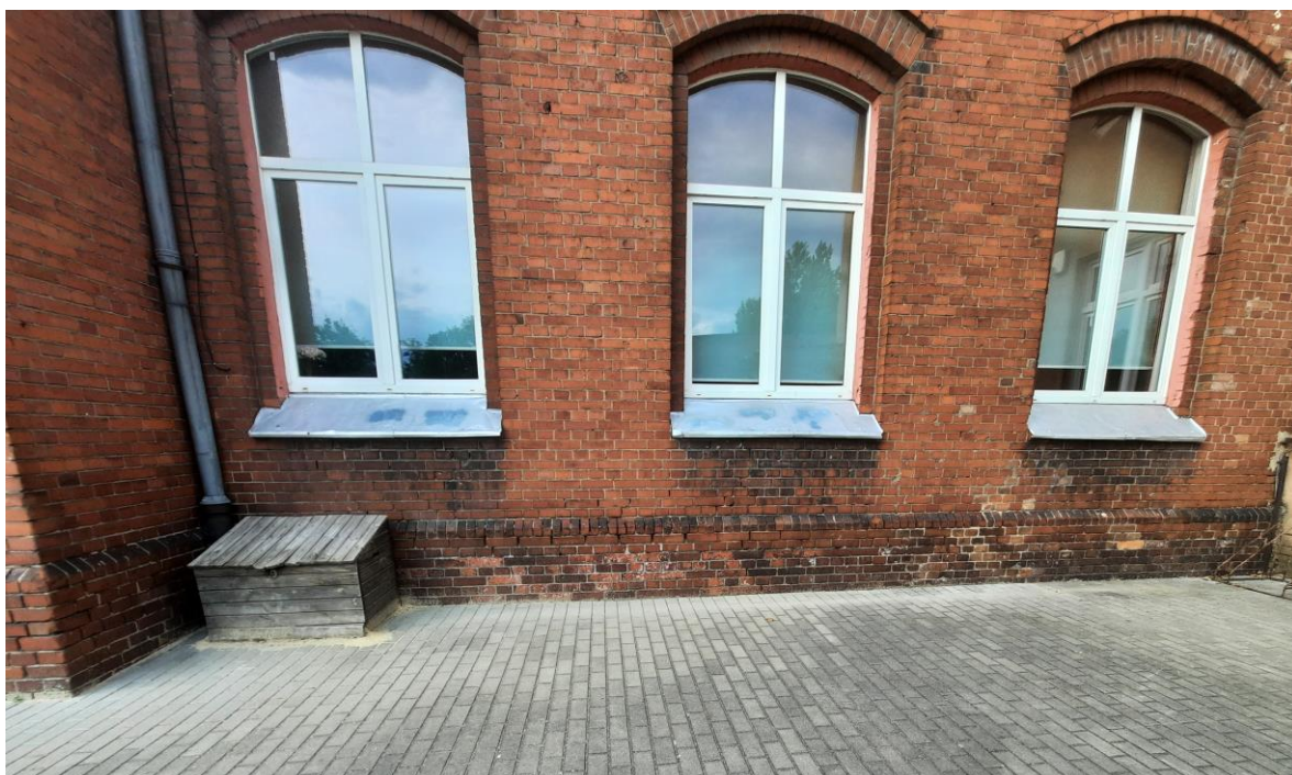
Fot. 44. Zabielenia w postaci „płytkiego nalotu” na fragmencie cokołu od strony dziedzińca.
