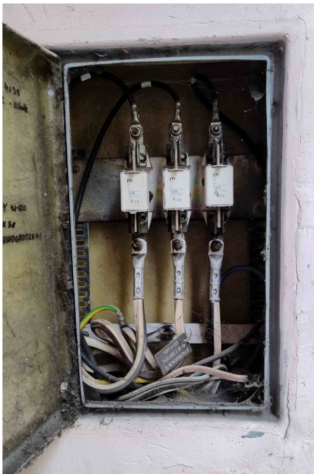
Zdjęcie 8: Wnętrze złącza kablowego
