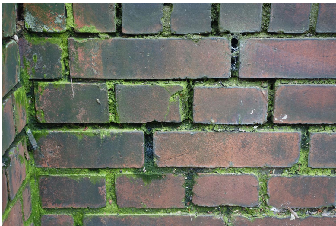
Fot. 42. Zakażenie mikrobiologiczne glonami i porostami, wypłukane spoiny.
