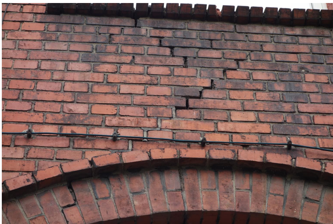
Fot. 36. Widoczne pęknięcia muru.
