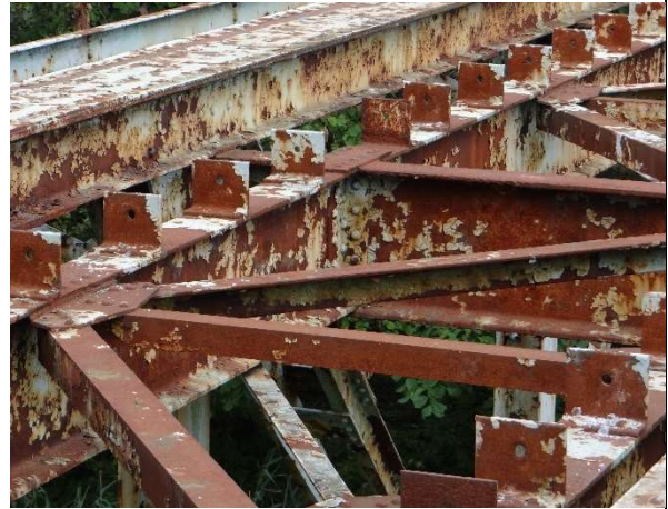
Rysunek 9 Korozja elementów stalowych.
