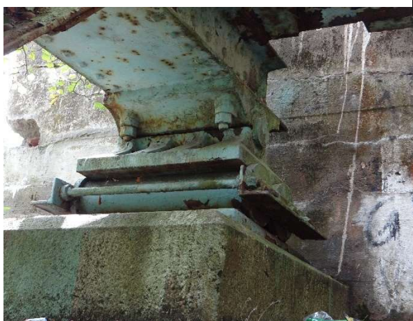
Rysunek 14 Widok łożyska i ciosu podłożyskowego.
