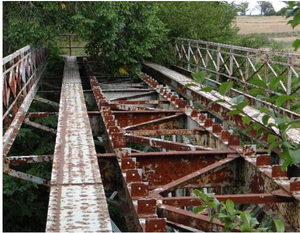
Rysunek 8 Widok na konstrukcję stalową przęsła – korozja.
