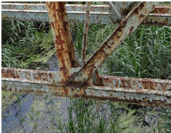
Rysunek 10 Węzeł dolny kratownicy – korozja stali.
