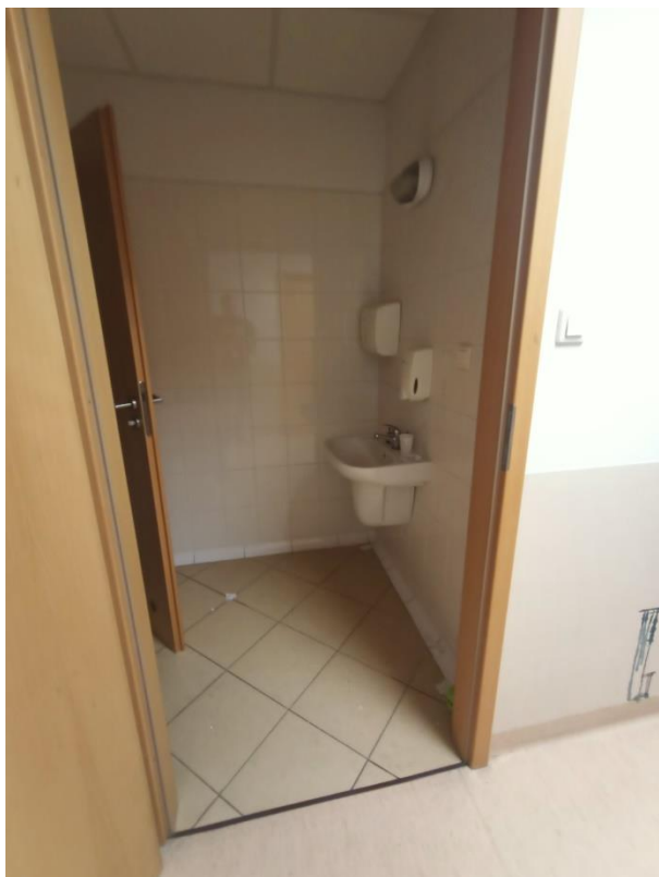
Zdjęcie 7. WC z przedsionkiem – w części przeznaczony do rozbioru (wejście od strony korytarza wewnętrznego widocznego na Zdjęciu nr 2)
