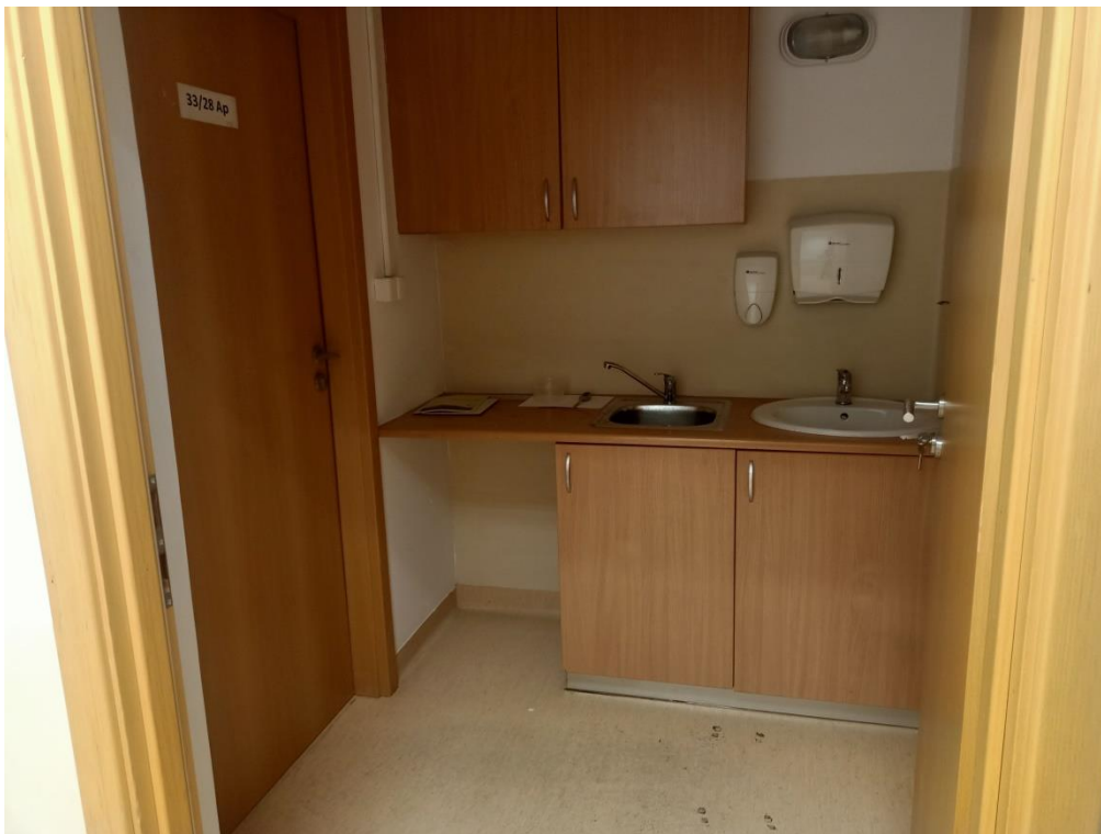
Zdjęcie 4. Istniejący aneks kuchenny – przeznaczony do rozbiórki w związku z przebudową nowoprojektowanych węzłów sanitarnych (zgodnie z oddzielnie opracowaną dokumentacją projektową).
