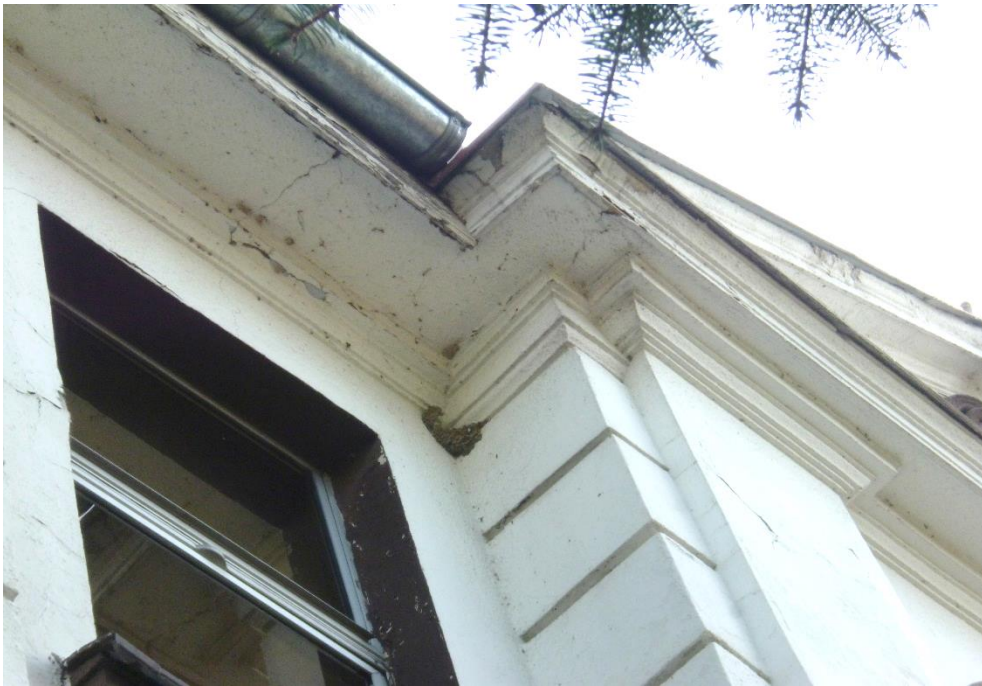
Foto.10. Uszkodzone gniazdo oknówki na elewacji frontowej, południowo-zachodniej. Fot. Przemysław Kubacki.
