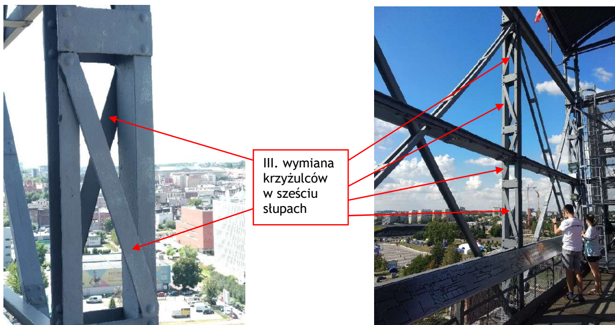
Fot. 1,2 Zdjęcie krzyżulców do wymiany na kątowniki 50x50x5 /wskazane tylko niektóre, do wymiany wszystkie/
