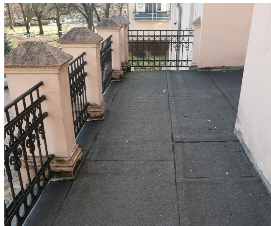
4. TARAS WSCHODNI: PIĘTRO
