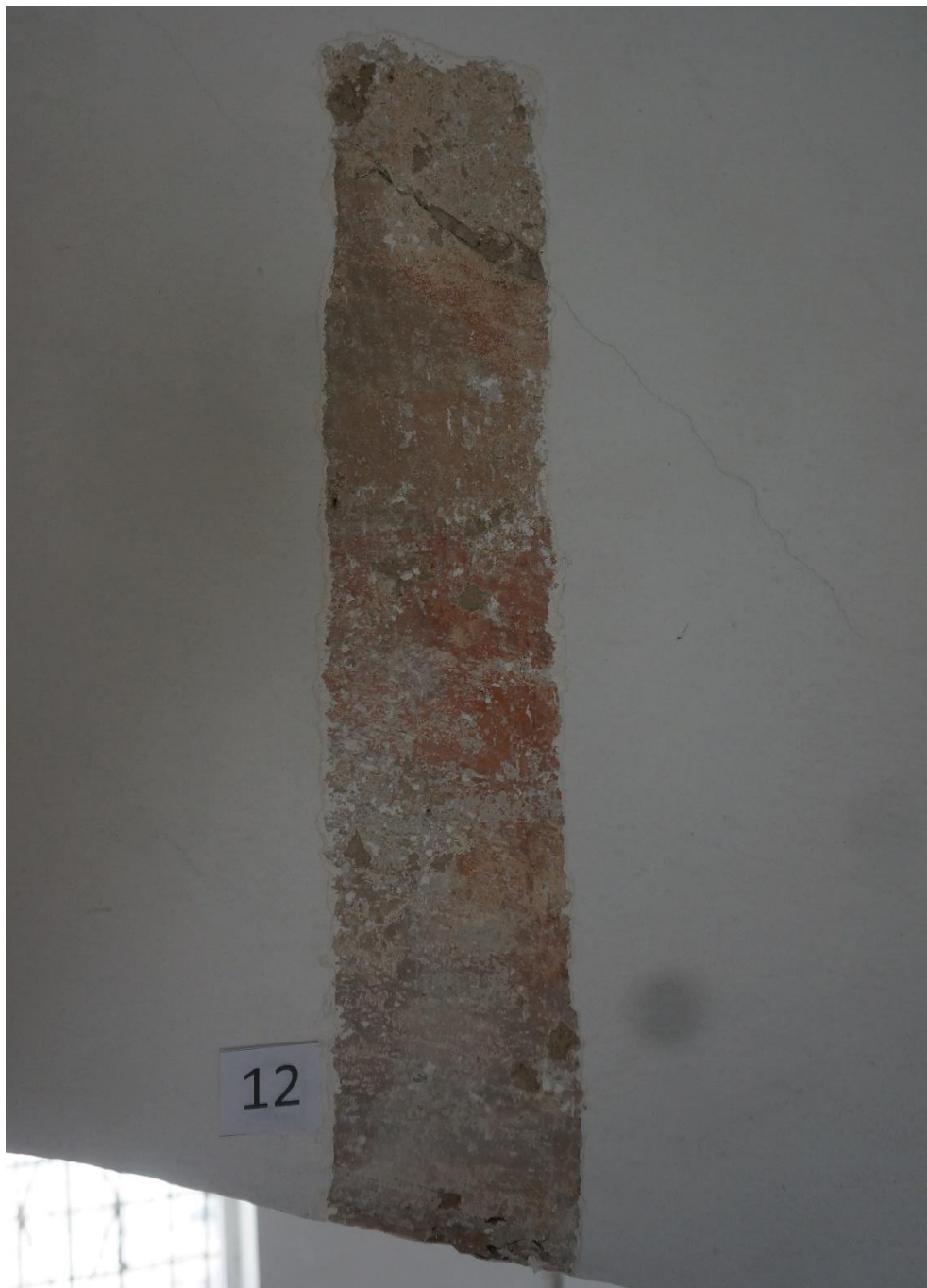
Fot. 4. Synagoga Nowomiejska w Dębicy. Odkrywka stratygraficzna w południowej części sklepienia znajdującego się nad bimą. Pod kilkoma warstwami pobiaty wapiennej i cienkim zatarciu z zaprawy cementowej znajdują się fragmenty zabytkowej polichromii z 2 poł XVIII w. Widoczna warstwa malarska wymaga doczyszczenia, posiada ubytki i przetarcia do zaprawy.
