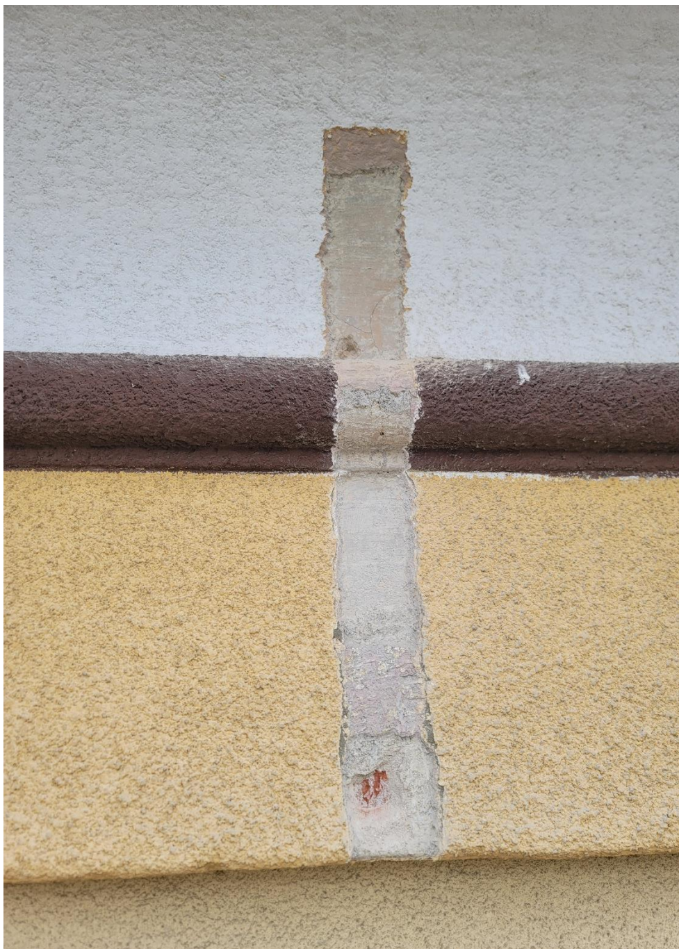
Fot.59 Synagoga Nowomiejska w Dębicy. Odkrywka stratygraficzna na ścianie południowej elewacji budynku. Widoczne fragmenty zaprawy i warstwy malarskiej j z 2 poł. XVIII w. (kolor ugrowy i biały).
