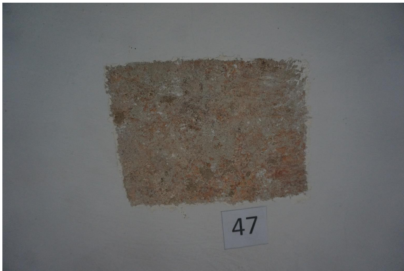
Fot. 15 Synagoga Nowomiejska w Dębicy. Odkrywka stratygraficzna na sklepieniu. Pod kilkoma warstwami pobiły wapiennej i cienkim zatarciu z zaprawy cementowej znajdują się fragmenty zabytkowej polichromii z 2 poł XVIII w. Widoczna warstwa malarska jest źle zachowana, posiada liczne ubytki i przetarcia do zaprawy.
