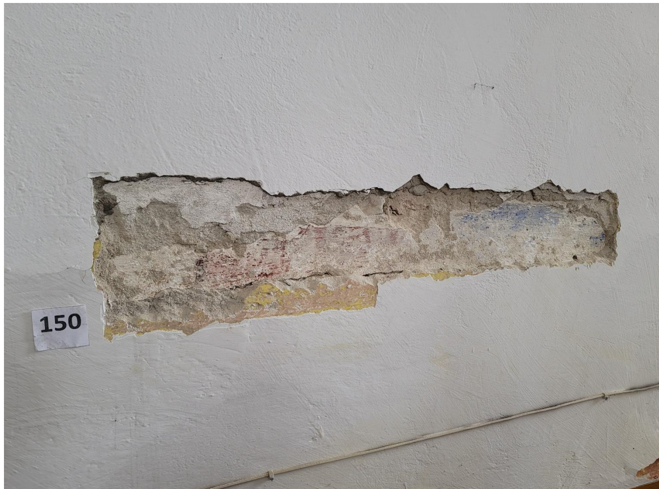
Fot.53 Synagoga Nowomiejska w Dębicy. Odkrywka stratygraficzna na ścianie zachodniej w oryginalnej sali modlitw. Widoczne fragmenty dekoracji malarskiej z 2 poł XVIII w.. Prawdopodobnie są to jedyne pozostałości barokowej polichromii, które zachowały się na wysokości ok. 3 m od poziomu posadzki. Warstwa malarska jest silnie spudrowana i odspojona od podłoża.
