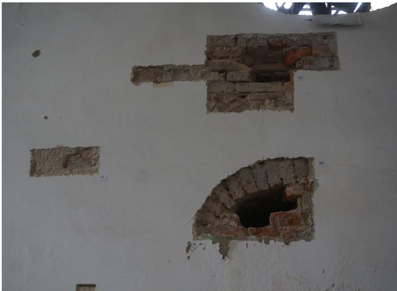
Fot. 32 Synagoga Nowomiejska w Dębicy. Odkrytki architektoniczne na ścianie wschodniej. Widać odsłonięty ceglany łuk od aron ha-kodesz, który został zamurowany prawdopodobnie w latach 30-tych XX w.
