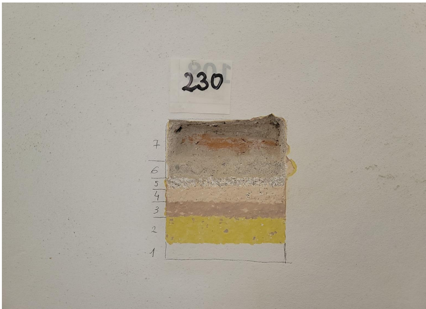
Fot.43 Synagoga Nowomiejska w Dębicy. Odkrywka stratygraficzna na ścianie południowej w oryginalnym babińcu. Widoczne współczesne przekształcenia malarskie ścian. Najniżej położona szara warstwa stanowi pobiałę wapienną zabrudzoną na skutek pożaru w czasie II wojny światowej.
