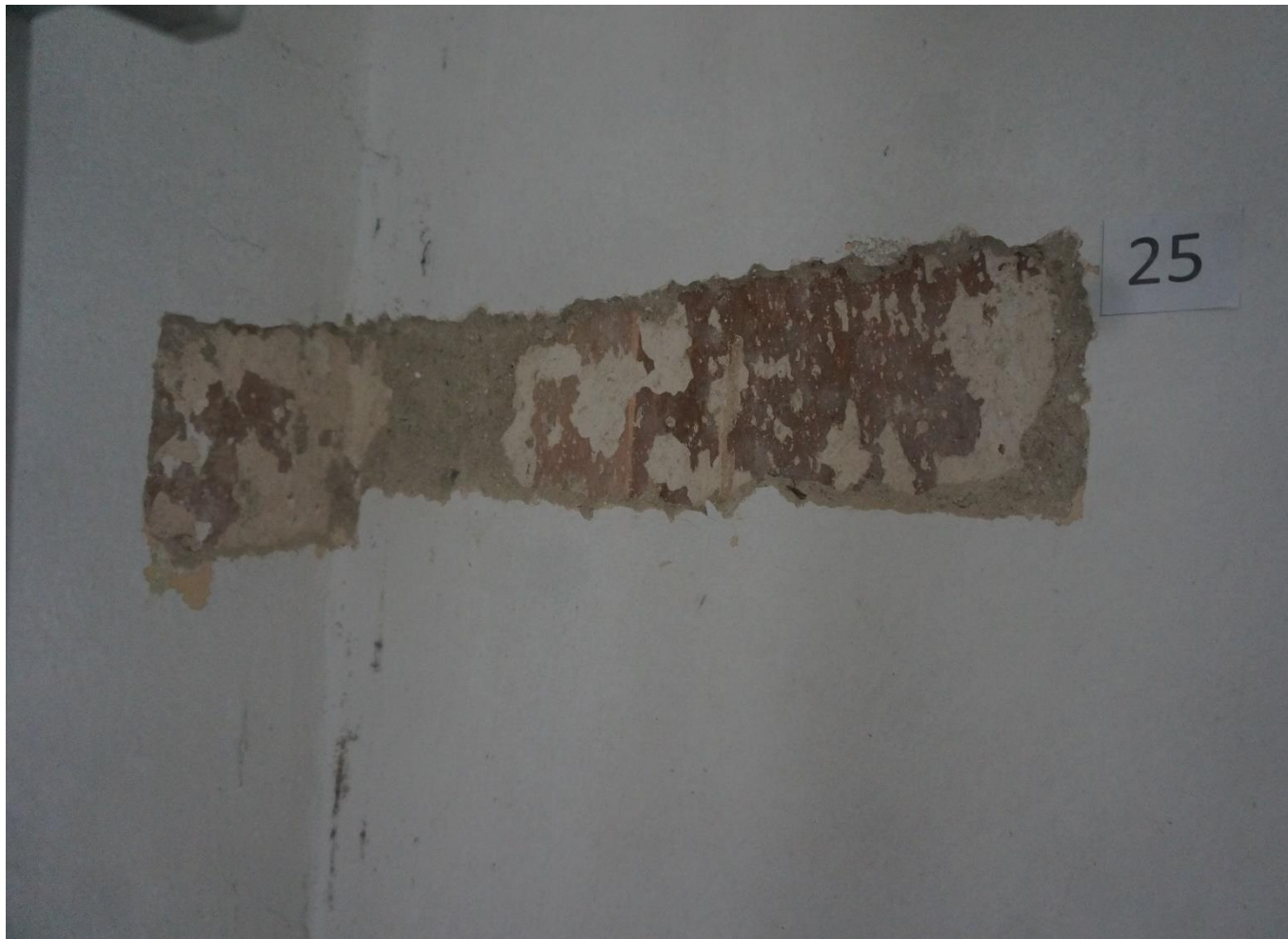
Fot.36 Synagoga Nowomiejska w Dębicy. Odkrywka stratygraficzna w narożniku ścian wschodniej i południowej. Pod wtórnymi nawarstwieniami znajdują się fragmenty zabytkowej polichromii z 2 poł XVIII w. Widoczna warstwa malarska jest źle zachowana, wymaga doczyszczenia, posiada ubytki i odspojenia warstwy pobiały z polichromią.
