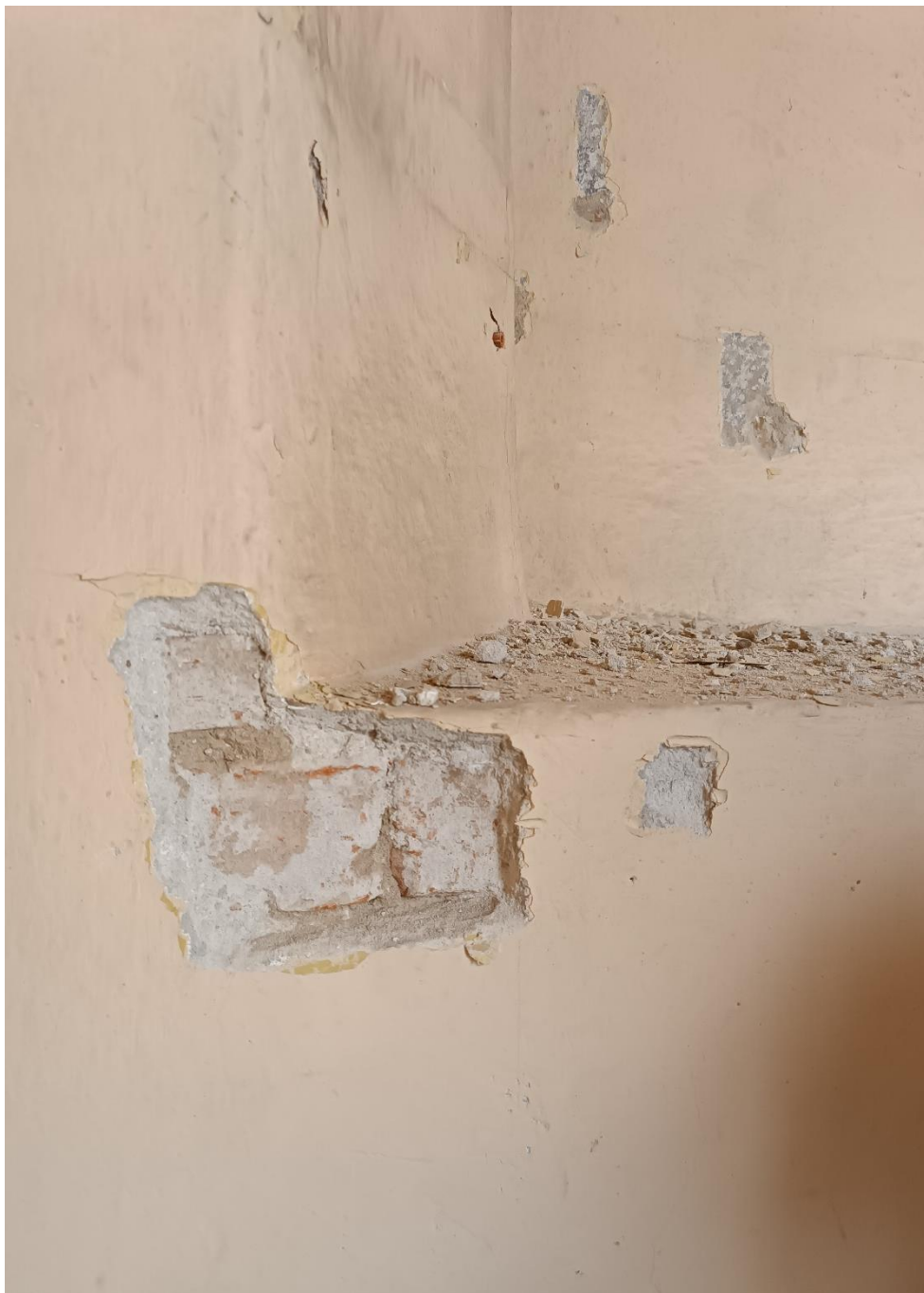
Fot.57 Synagoga Nowomiejska w Dębicy. Odkrywka architektoniczna na ścianie wschodniej górnej kondygnacji. Widać oryginalne wykończenie krawędzi glifu okiennego w cegle.
