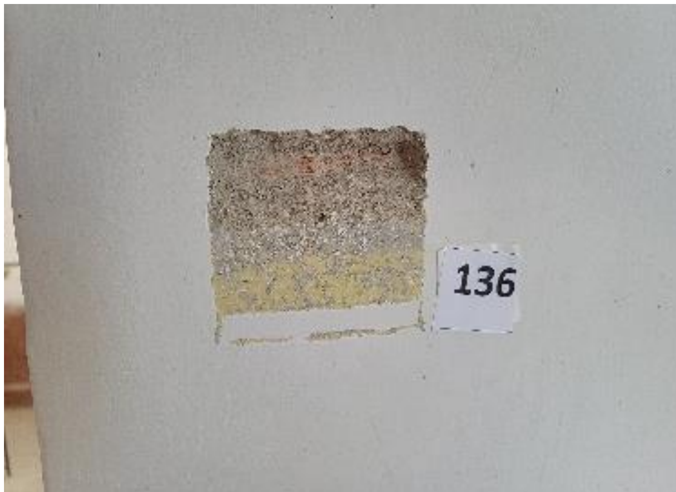
Fot. 27 Synagoga Nowomiejska w Dębicy. Odkrywka stratygraficzna na prostokątnym filarze. Widoczne wtórne nawarstwienia z zaprawy wapienno-piaskowej i powłok malarskich.
