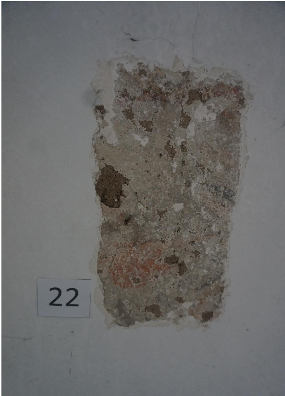
Fot. 8. Synagoga Nowomiejska w Dębicy. Odkrywka stratygraficzna w narożniku sklepienia. Pod kilkoma warstwami pobiałej wapiennej i cienkim zatarciu z zaprawy cementowej znajdują się fragmenty zabytkowej polichromii z 2 poł XVIII w. z przedstawieniem wazonu z kwiatami. (?) Widoczna warstwa malarska wymaga doczyszczenia, posiada ubytki i przetarcia do zaprawy.
