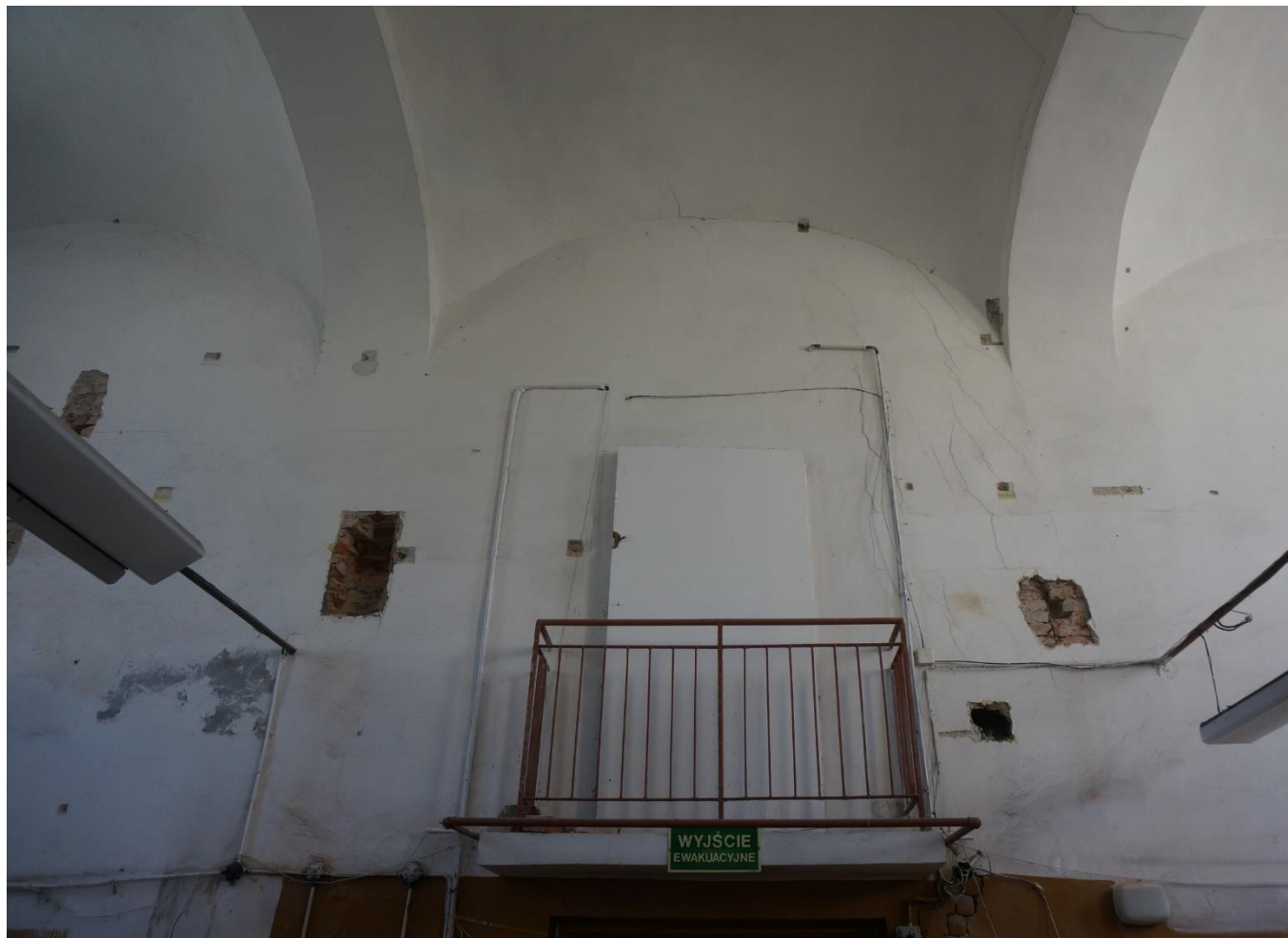
Fot.45 Synagoga Nowomiejska w Dębicy. Widok na odkrywki stratygraficzne i architektoniczne na ścianie zachodniej synagogi. W dużych odkrywkach znajdujących się po prawej i lewej stronie otworu drzwiowego odsłonięte zostały oryginalne glify okienne z początku powstania synagogi (koniec XVII w.) Po prawej stronie od drzwi widoczne są pionowe pęknięcia ściany – miejsce w którym znajdował się komin.
