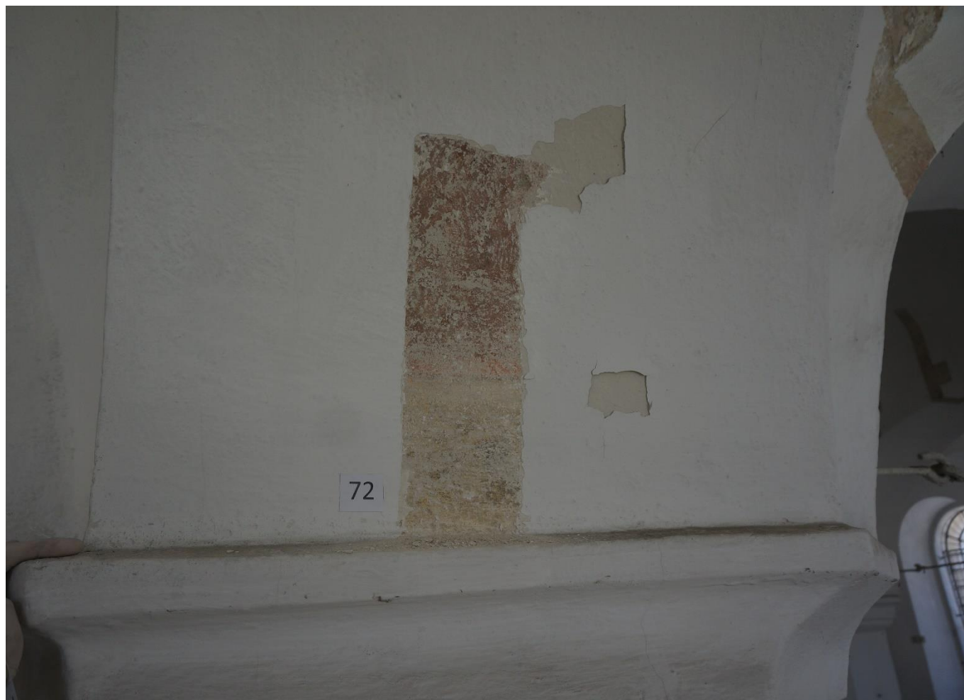
Fot. 18 Synagoga Nowomiejska w Dębicy. Odkrywka stratygraficzna na łuku gurty sklepiennej. Pod kilkoma warstwami pobiałej wapiennej i cienkim zatarciu z zaprawy cementowej znajdują się fragmenty zabytkowej polichromii z 2 poł XVIII w. z dekoracją ramowo-płycinową. Widoczna warstwa malarska jest źle zachowana, posiada liczne przetarcia i wymaga doczyszczenia z zaprawy cementowej.
