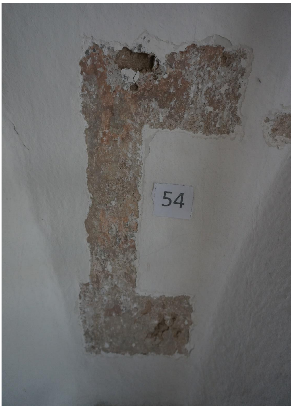
Fot. 16 Synagoga Nowomiejska w Dębicy. Odkrywka stratygraficzna na sklepieniu. Pod kilkoma warstwami pobiaty wapiennej i cienkim zatarciu z zaprawy cementowej znajdują się fragmenty zabytkowej polichromii z 2 poł XVIII w. Widoczna warstwa malarska jest źle zachowana, posiada liczne ubytki i przetarcia. Warstwa zaprawy ma tendencję do odspajania się od podłoża.
