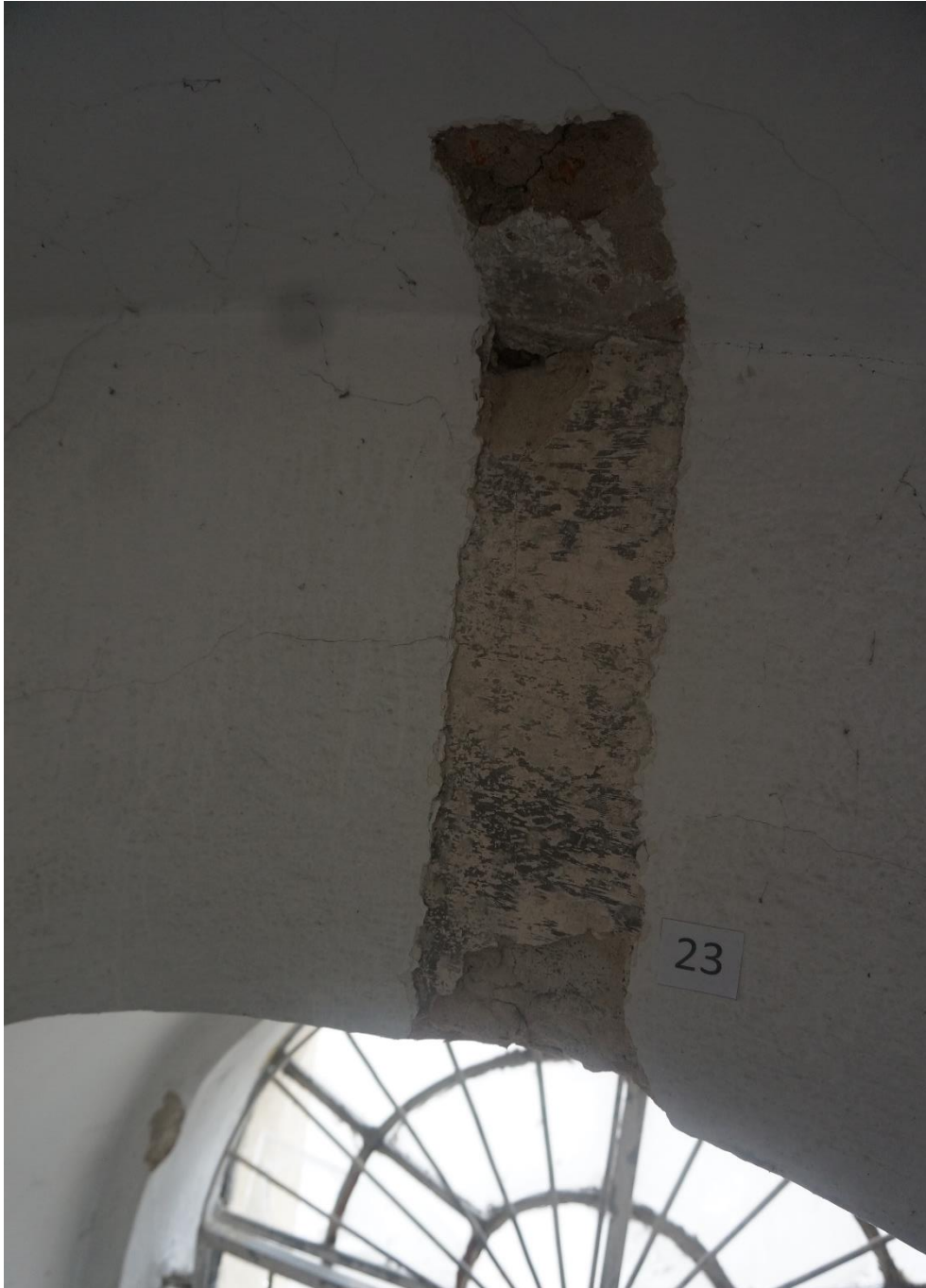
Fot. 30 Synagoga Nowomiejska w Dębicy. Odkrywka stratygraficzna na granicy sklepienia i ściany wschodniej, tuż nad oknem. Pod kilkoma warstwami pobiałej wapiennej i cienkim zatarciu z zaprawy cementowej znajdują się fragmenty starszych nawarstwień z 2 poł. XVIII w. Zabytkowa warstwa malarska jest bardzo źle zachowana, wymaga doczyszczenia powierzchni z zabrudzeń.
