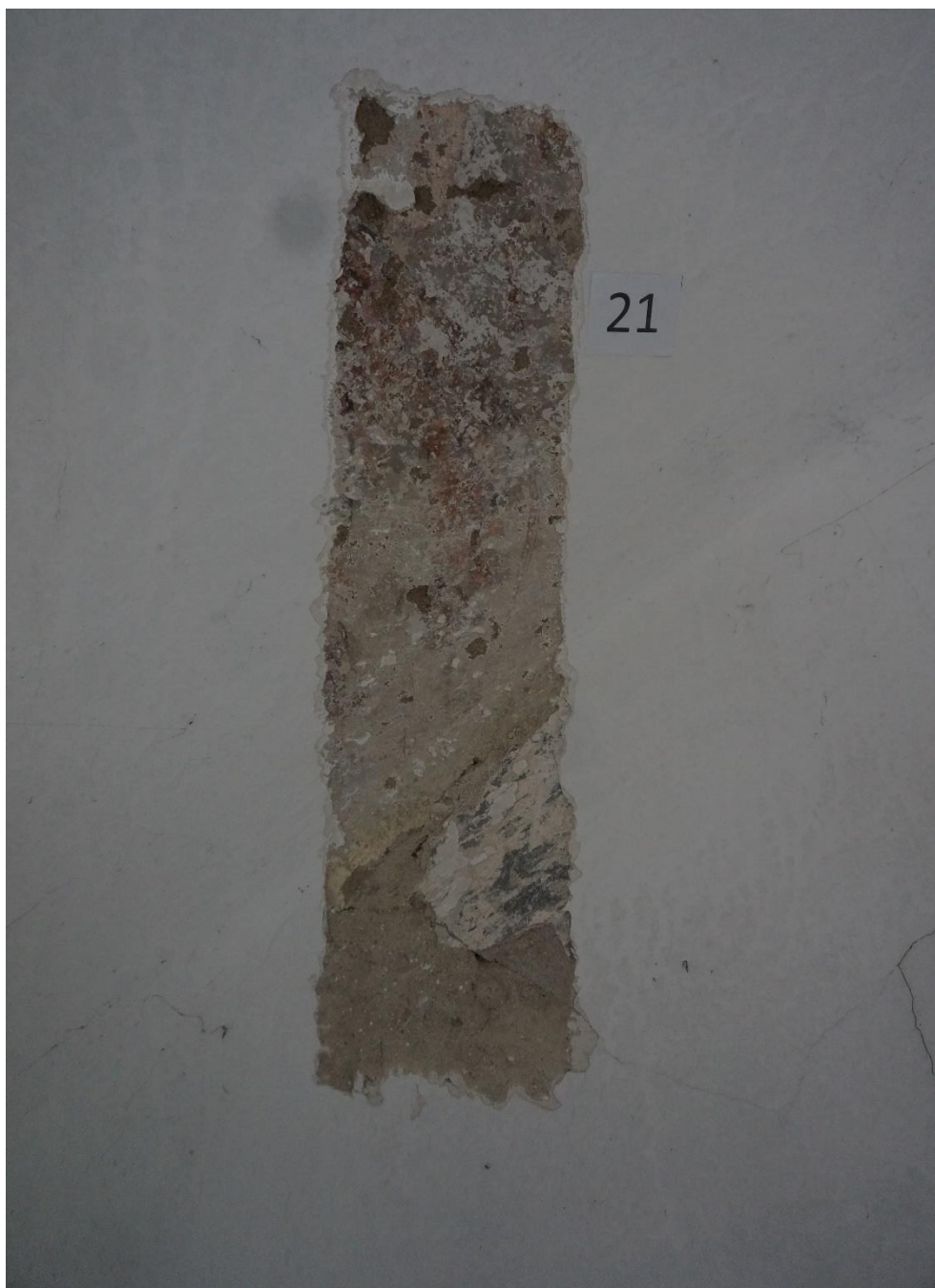
Fot. 7. Synagoga Nowomiejska w Dębicy. Odkrywka stratygraficzna na sklepieniu. Pod kilkoma warstwami pobiąły wapiennej i cienkim zatarciu z zaprawy cementowej znajdują się fragmenty zabytkowej polichromii z 2 poł XVIII w. Widoczna warstwa malarska wymaga doczyszczenia, posiada ubytki i przetarcia do zaprawy.
