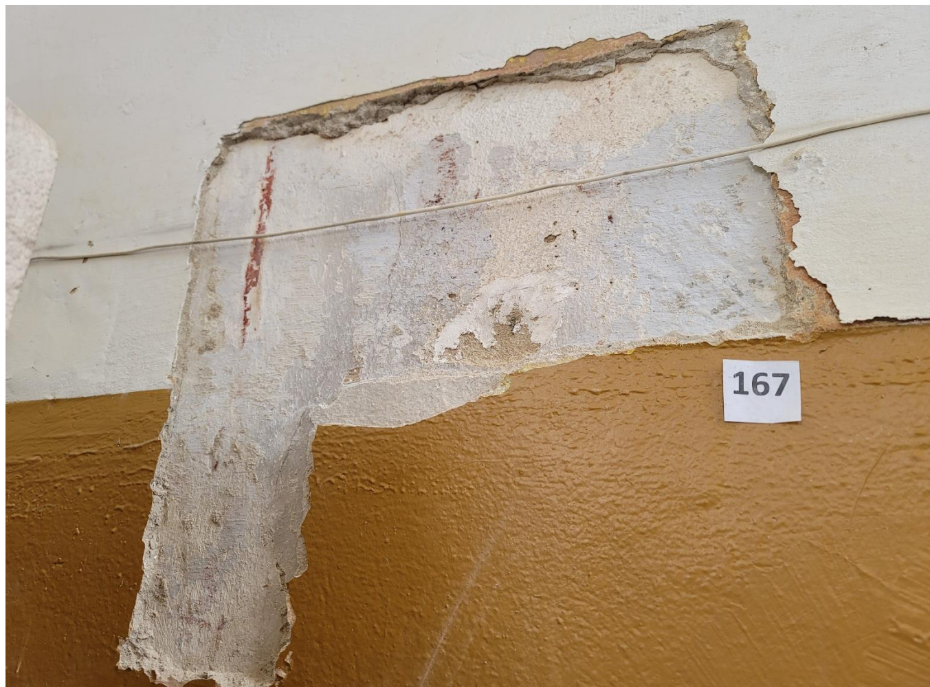
Fot.55 Synagoga Nowomiejska w Dębicy. Odkrywka stratygraficzna na ścianie zachodniej w oryginalnej sali modlitw. Widoczne fragmenty dekoracji malarskiej z 2 poł XVIII w. w formie jasno niebieskiego tła z czerwonymi pionowymi pasami. Prawdopodobnie są to jedyne pozostałości barokowej polichromii, które zachowały się na wysokości ok. 3 m od poziomu posadzki. Warstwa malarska jest silnie spudrowana i odspojona od podłoża.
