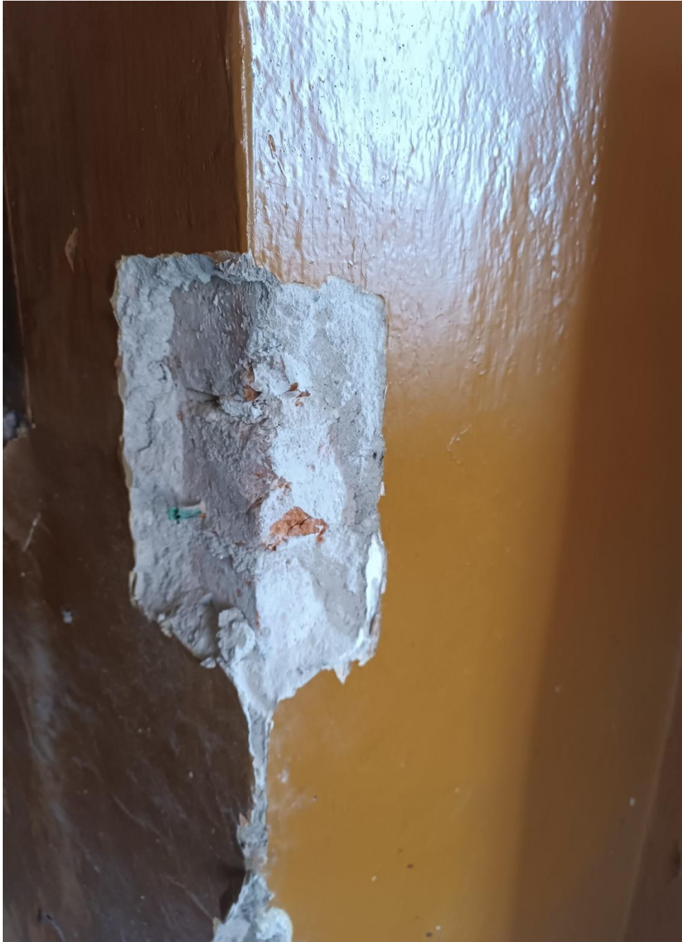
Fot.58 Synagoga Nowomiejska w Dębicy. Odkrywka architektoniczna na ścianie wschodniej górnej kondygnacji. Widać oryginalne wykończenie krawędzi otworu drzwiowego w cegle.
