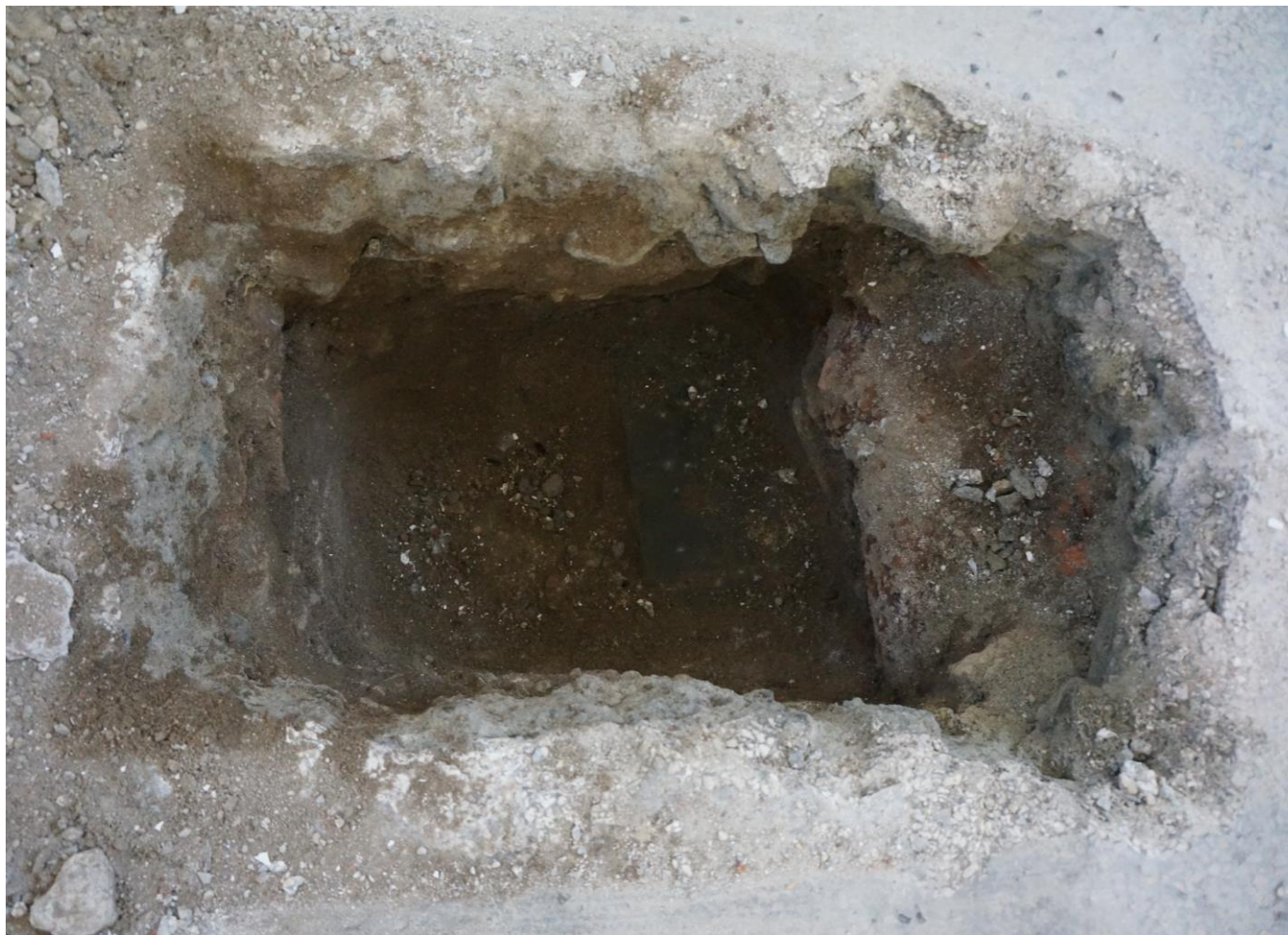
Fot. 62 Synagoga Nowomiejska w Dębicy. Odkrywka stratygraficzna w posadzce w dawnej sali modlitw w pobliżu bimy. W najniższej warstwie widać fragment kamiennej płyty (wapień dębnicki(?)) który wskazuje oryginalny poziom posadzki synagogi.
