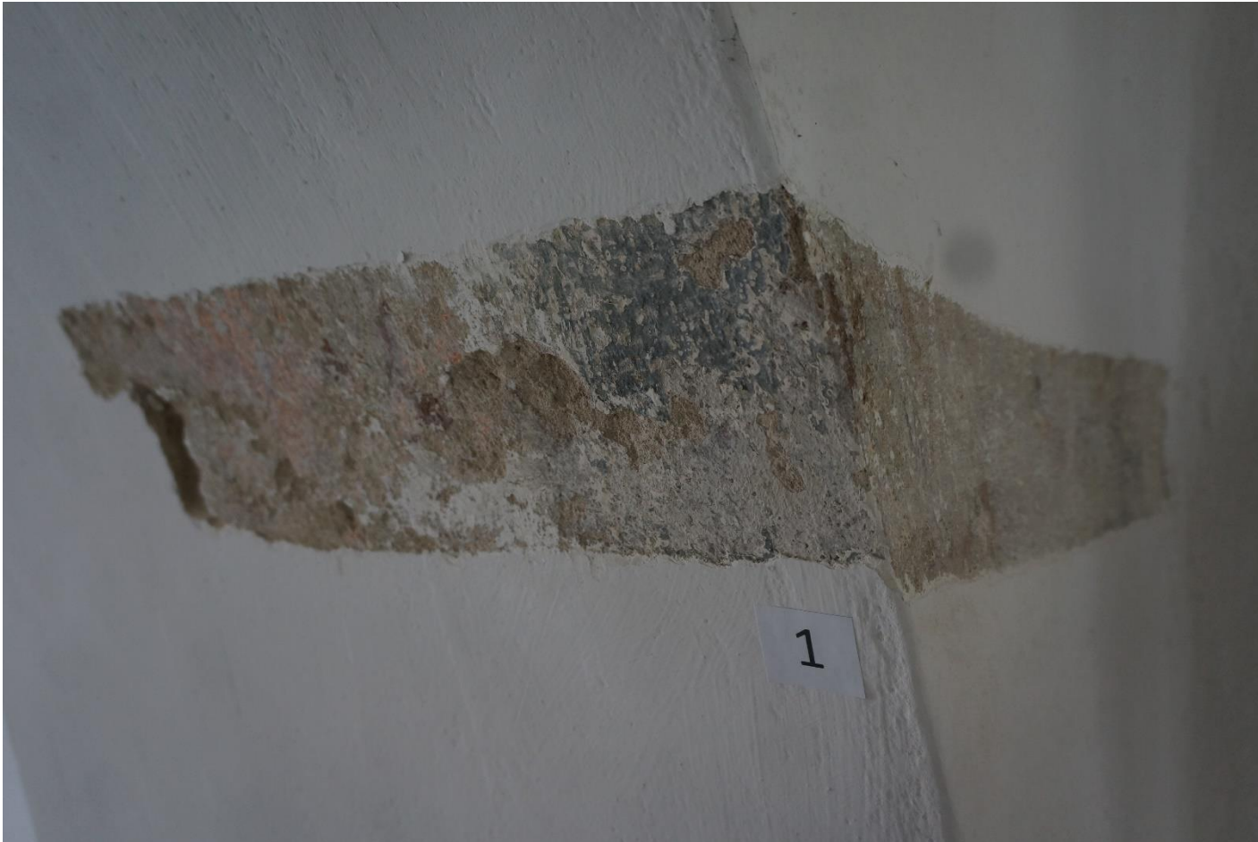
Fot. 1. Synagoga Nowomiejska w Dębicy. Odkrywka stratygraficzna w części sklepienia znajdującego się nad bimą. Widoczne fragmenty zabytkowej warstwy malarskiej z 2 poł XVIII w. Warstwa malarska posiada tendencję do osypywania się, jest silnie zabrudzona i zespojona z cienką warstwą zaprawy cementowej.
