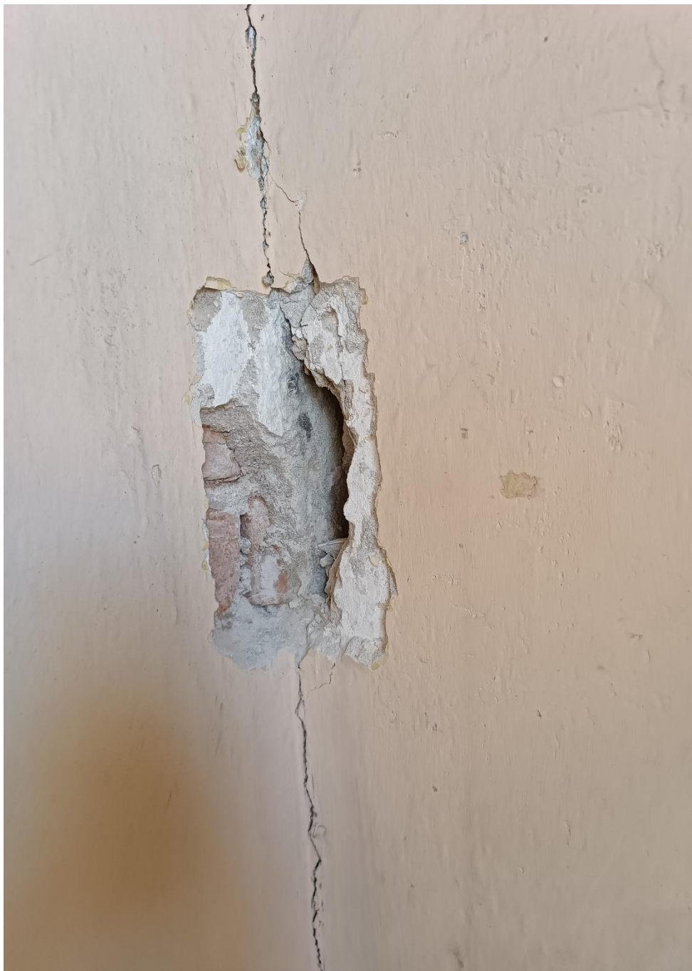
Fot.56 Synagoga Nowomiejska w Dębicy. Odkrywka architektoniczna na ścianie wschodniej górnej kondygnacji. Widoczne fragmenty zaprawy i pobiaty wapiennej z końca XVII w. zachowane w miejscu przylegania ścian XVIII-wiecznego (?) ryzalitu.
