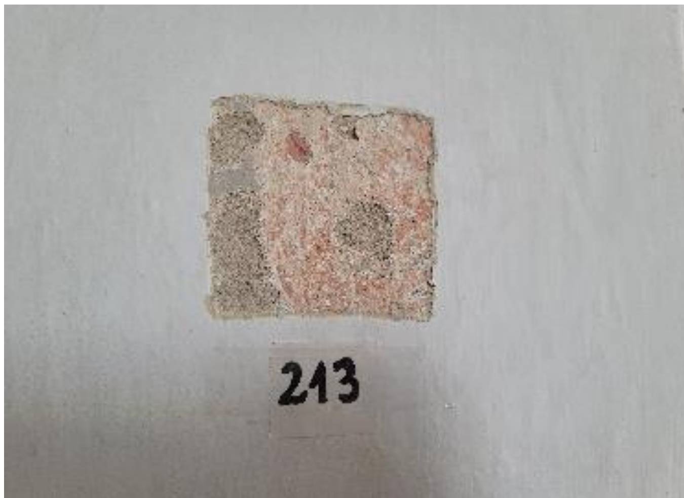
Fot. 28 Synagoga Nowomiejska w Dębicy. Odkrywka stratygraficzna na filarze bimy. Pod kilkoma warstwami pobiaty wapiennej i przemalowań znajdują się fragmenty zabytkowej polichromii z 2 poł XVIII w. z trójbarwnym pseudoboniowaniem. Widoczna warstwa malarska jest źle zachowana. Warstwa zaprawy wapienno-piaskowej ma tendencję do wykruszania się, prawdopodobnie jest to spowodowane degradacją ceglanego podłoża.
