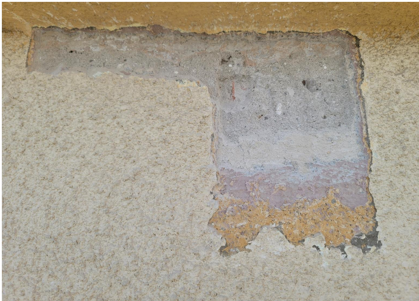
Fot. 60 Synagoga Nowomiejska w Dębicy. Odkrywka stratygraficzna na ścianie południowej elewacji budynku. Widoczne fragmenty zaprawy z warstwą malarską z XVIII w. oraz wtórne przekształcenia malarskie ścian elewacji.
