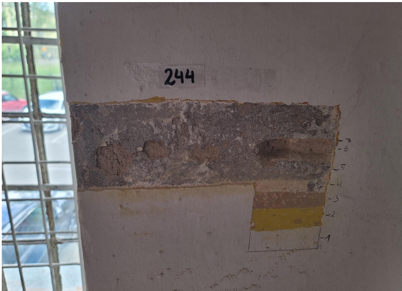
Fot.44 Synagoga Nowomiejska w Dębicy. Odkrywka stratygraficzna na ścianie południowej w oryginalnym babińcu. Widoczne współczesne przekształcenia malarskie i architektoniczne ścian (przemurowanie glifów okiennych). Najniżej położona ciemnoszara warstwa stanowi pobiałę wapienną zabrudzoną na skutek pożaru w czasie II wojny światowej.
