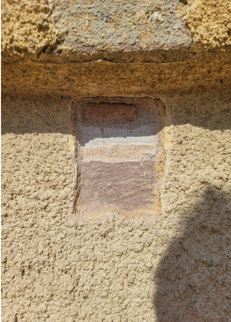
Fot.61 Synagoga Nowomiejska w Dębicy. Odkrywka stratygraficzna na ścianie zachodniej elewacji budynku. Widoczne fragmenty zaprawy z XVIII w. oraz wtórne przekształcenia malarskie ścian elewacji.
