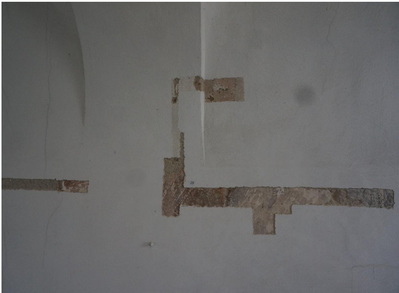
Fot. 31 Synagoga Nowomiejska w Dębicy. Odkrywki stratygraficzne na ścianie wschodniej. Widać odsłonięte fragmenty zabytkowej polichromii z 2 poł XVIII w. Widoczny łuk sklepienny wspiera się na iluzjonistycznie malowanym filarze. Barokowa warstwa malarska jest źle zachowana, posiada ubytki i przetarcia do zaprawy.
