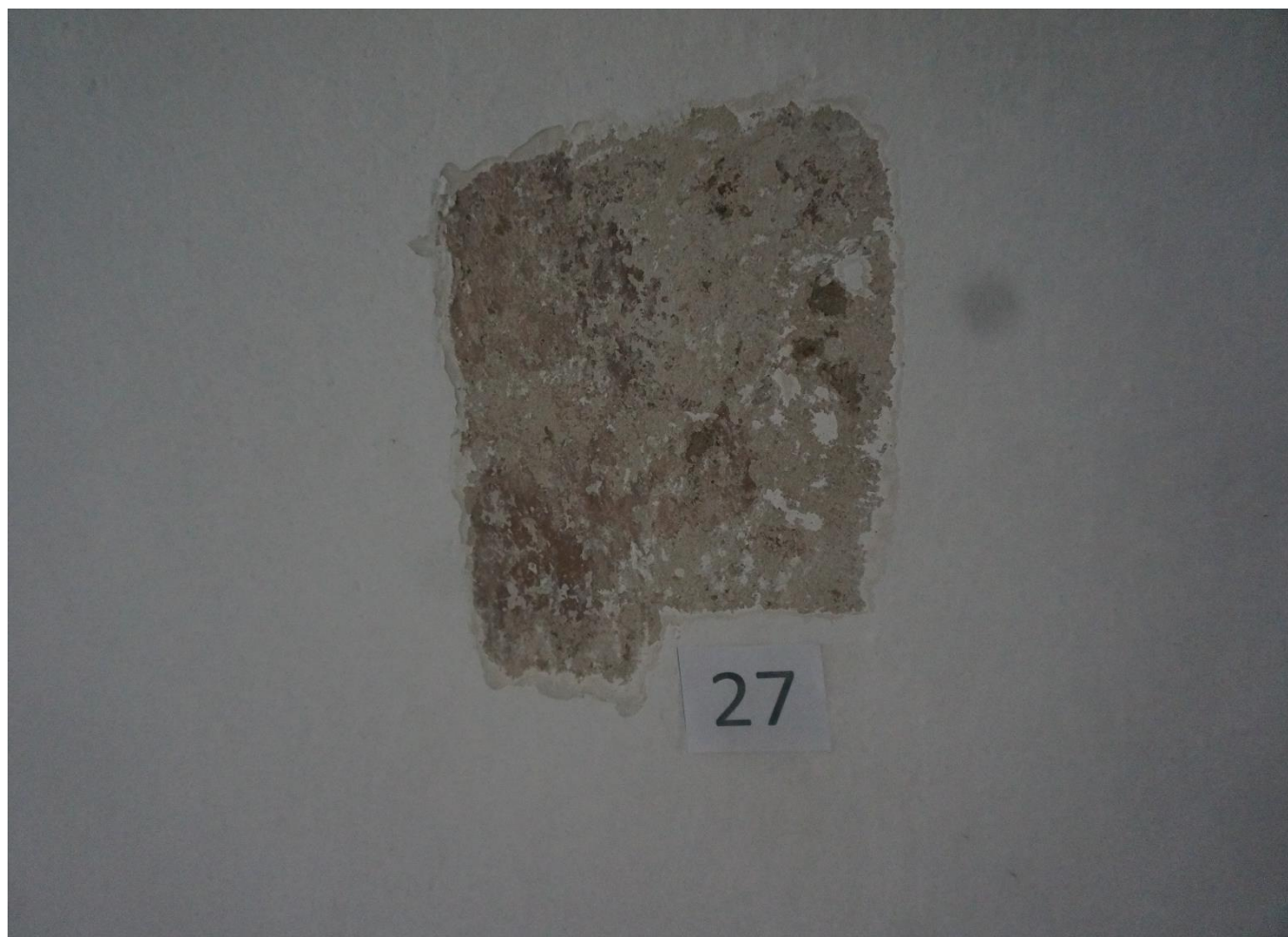
Fot. 9 Synagoga Nowomiejska w Dębicy. Odkrywka stratygraficzna na sklepieniu. Pod kilkoma warstwami pobiaty wapiennej i cienkim zatarciu z zaprawy cementowej znajdują się fragmenty zabytkowej polichromii z 2 poł XVIII w. Widoczna warstwa malarska jest bardzo źle zachowana, wymaga doczyszczenia, posiada ubytki i przetarcia do zaprawy.
