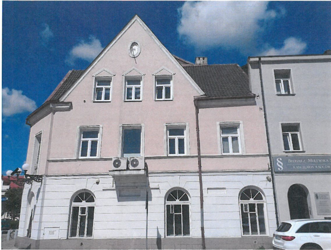
Elewacja Budynku Galerii - widok od strony ul. Kościuszki
