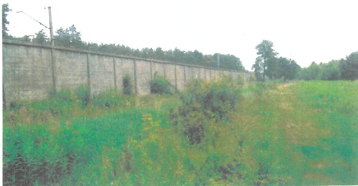
fot. 3 – ogrodzenie istniejące od strony torów
