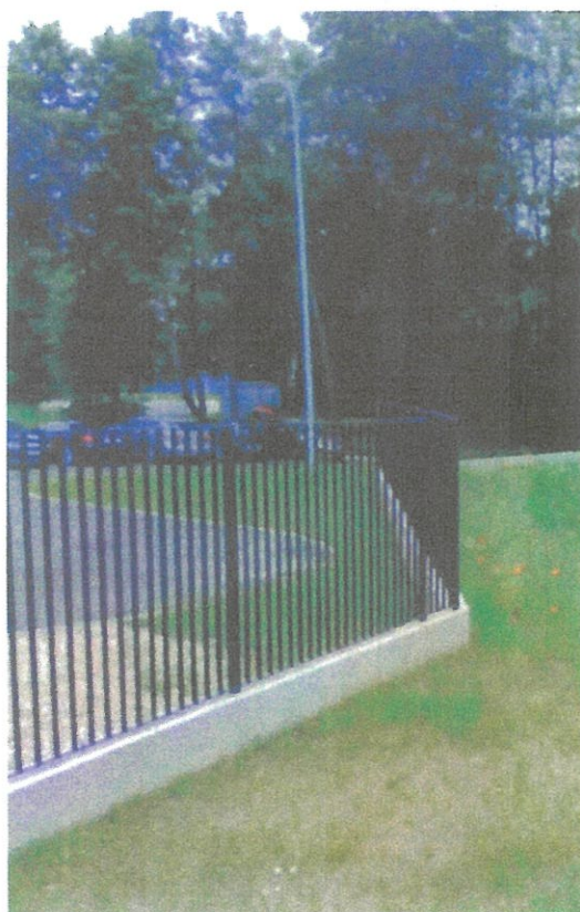
fot. 9 – ogrodzenie istniejące ul. Zegrzyńska
