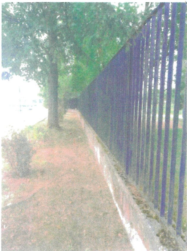
fot. 8 – ogrodzenie istniejące ul. Zegrzyńska
