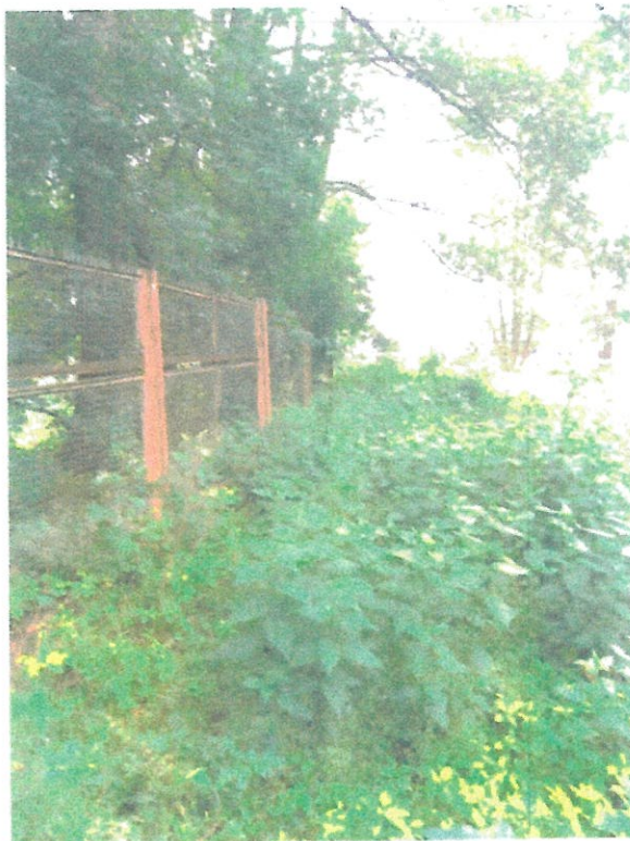
fot. 2 – ogrodzenie istniejące od strony kanału Bródnowskiego
