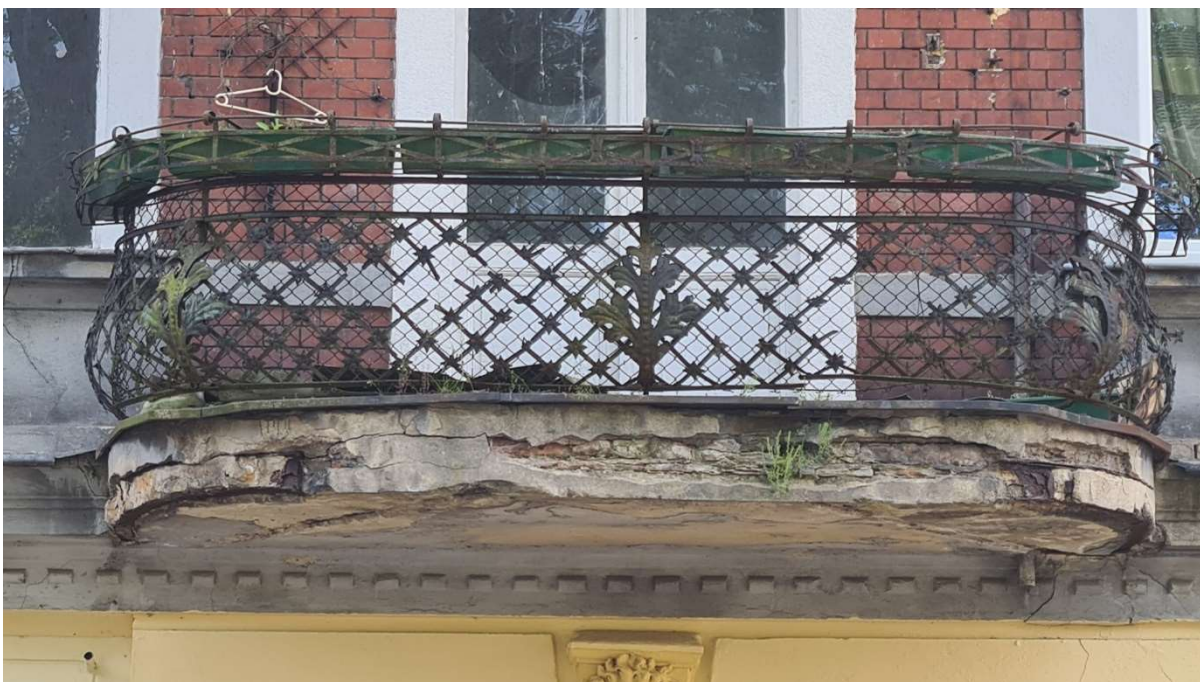
Fot.1 Widok balkonu od strony ul. Łokietka w kierunku północnym.
