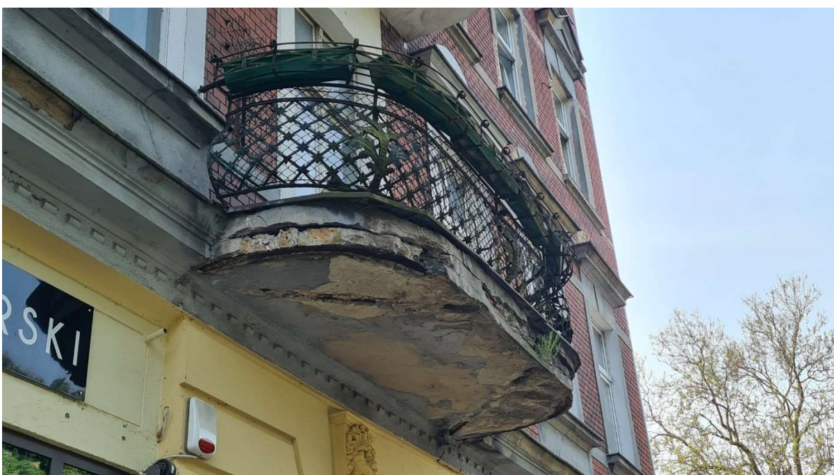
Fot.2 Widok balkonu w kierunku południowo-zachodnim.
