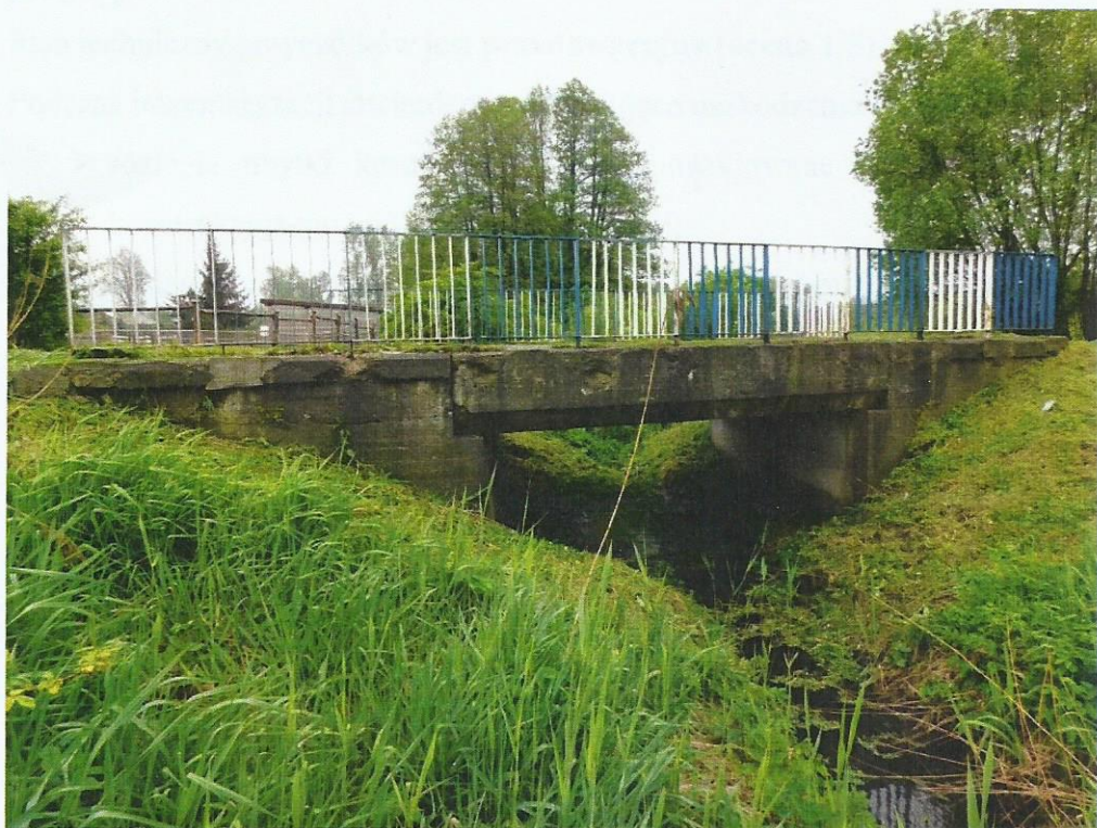
Widok mostu z boku od strony górnej wody (GW).
