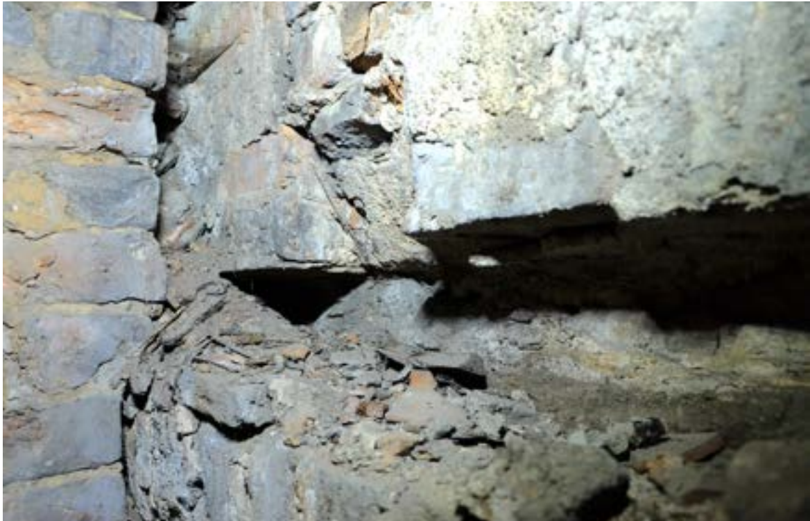
Fot. 113. Poznań, Stary Rynek 42. Poddasze, trakt tylny, ściana północna. Widoczne ślady po belce leżącej na rolce (murlacie) oraz ukośnie opracowana cegła stanowiącą ślad po miejscu oparcia krokwi na murlacie. Fot. K. Pietrzak, maj 2023 r.
