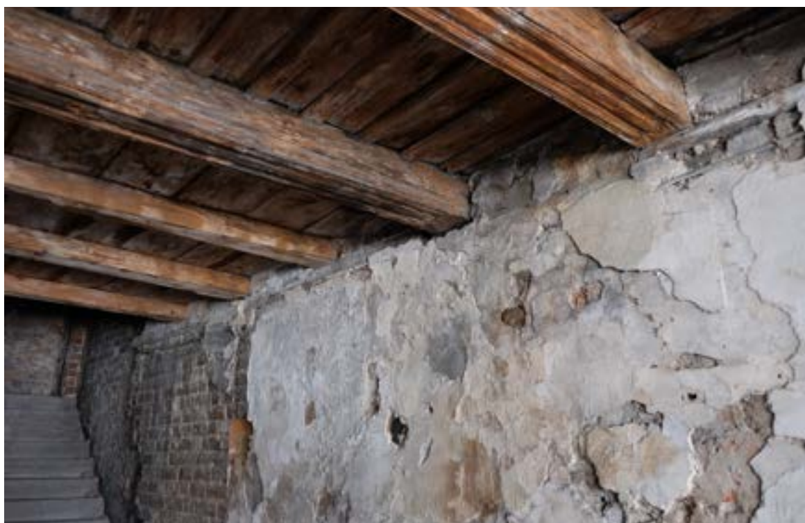
Fot. 40. Poznań, Stary Rynek 42. Piętro I, trakt frontowy, ściana południowa. Widok w kierunku klatki schodowej. Widoczna zmiana wysokości stropu oraz wielkości i sposobu opracowania belki stropowej (dawna granica pomieszczeń). Fot. K. Pietrzak, maj 2023 r.
