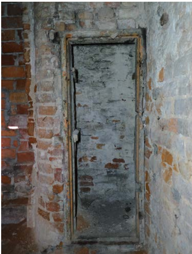
Fot. 30. Poznań, Stary Rynek 42. Piętro I, trakt tylny, ściana wschodnia (tylna kamienicy). Drewniane obramienie zamurowanego otworu dawnego wyjścia na ganek w południowo wschodnim narożniku kamienicy. Fot. K. Pietrzak, maj 2023 r.
