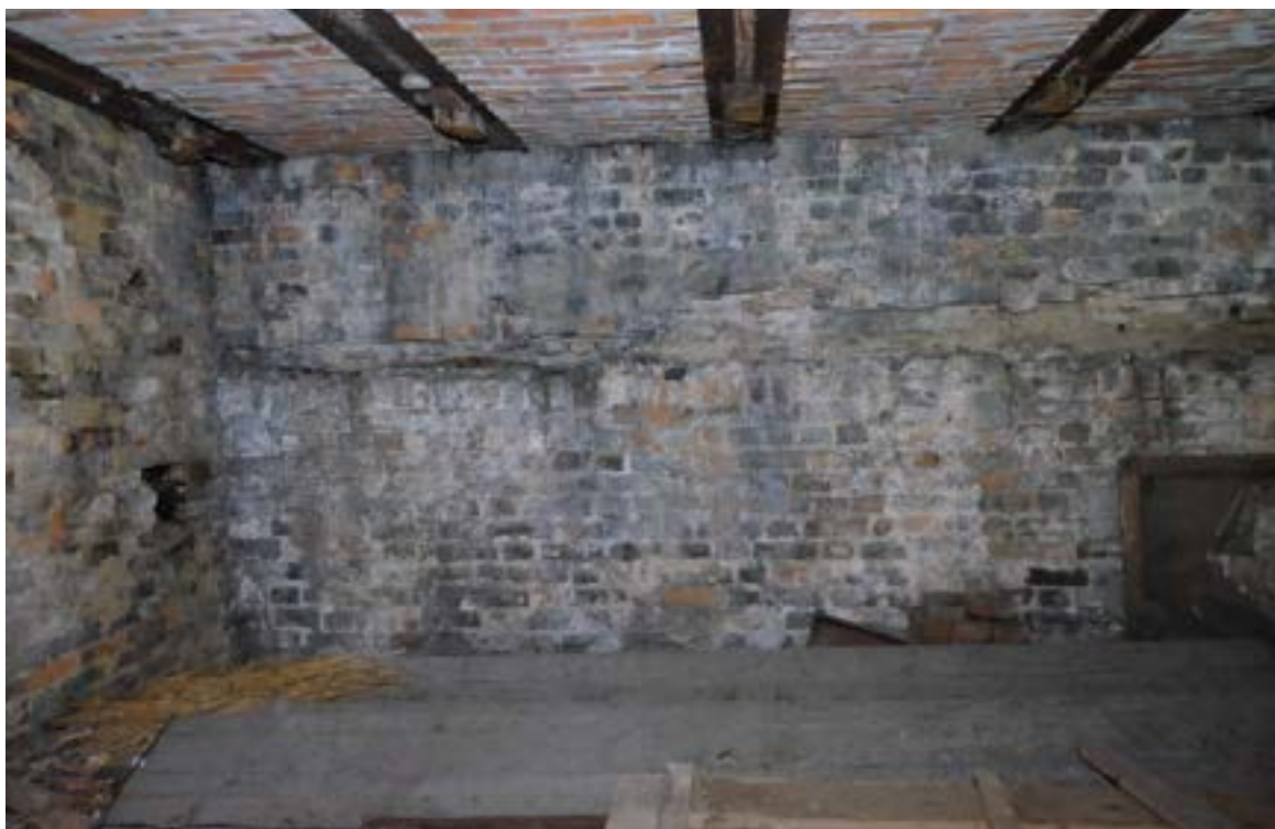
Fot. 110. Poznań, Stary Rynek 42. Poddasze, trakt tylny, ściana północna. Widoczny fragment ściany zachodniej, rolka z cegły układanej główkowo (w połowie wysokości ściany) oraz ślady po belce leżącej na rolce - murłacie Fot. K. Pietrzak, maj 2023 r.
