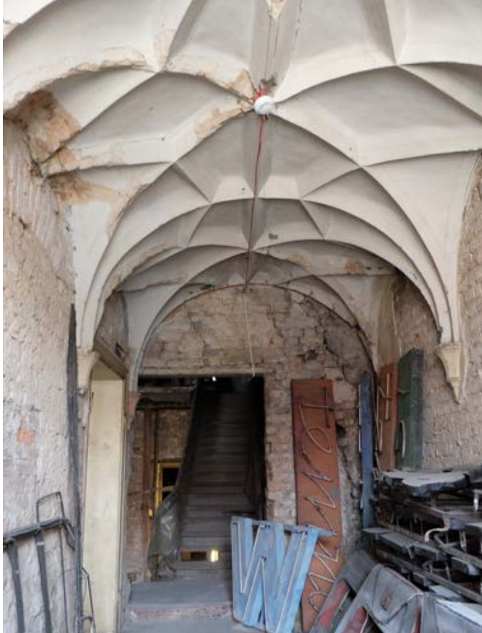
Fot. 62. Poznań, Stary Rynek 43. Piętro I, trakt frontowy, ściana wschodnia. Widoczne sklepienie kryształowe, fragment łuku w ścianie północnej pomieszczenia (ściana działowa wewnętrzna budynku) oraz wtórnie przebity otwór w ścianie wschodniej i schody na wyższą kondygnację. Fot. K. Pietrzak, maj 2023 r.
