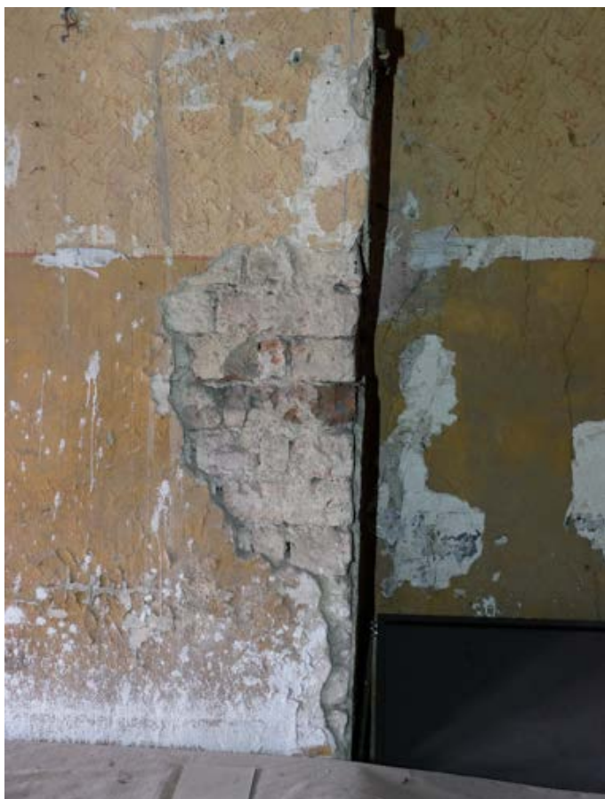
Fot. 15. Poznań, Stary Rynek 42. Piętro I, trakt frontowy, ściana północna. Widoczna krawędź wtórnej wnęki. Fot. K. Pietrzak, maj 2023 r.
