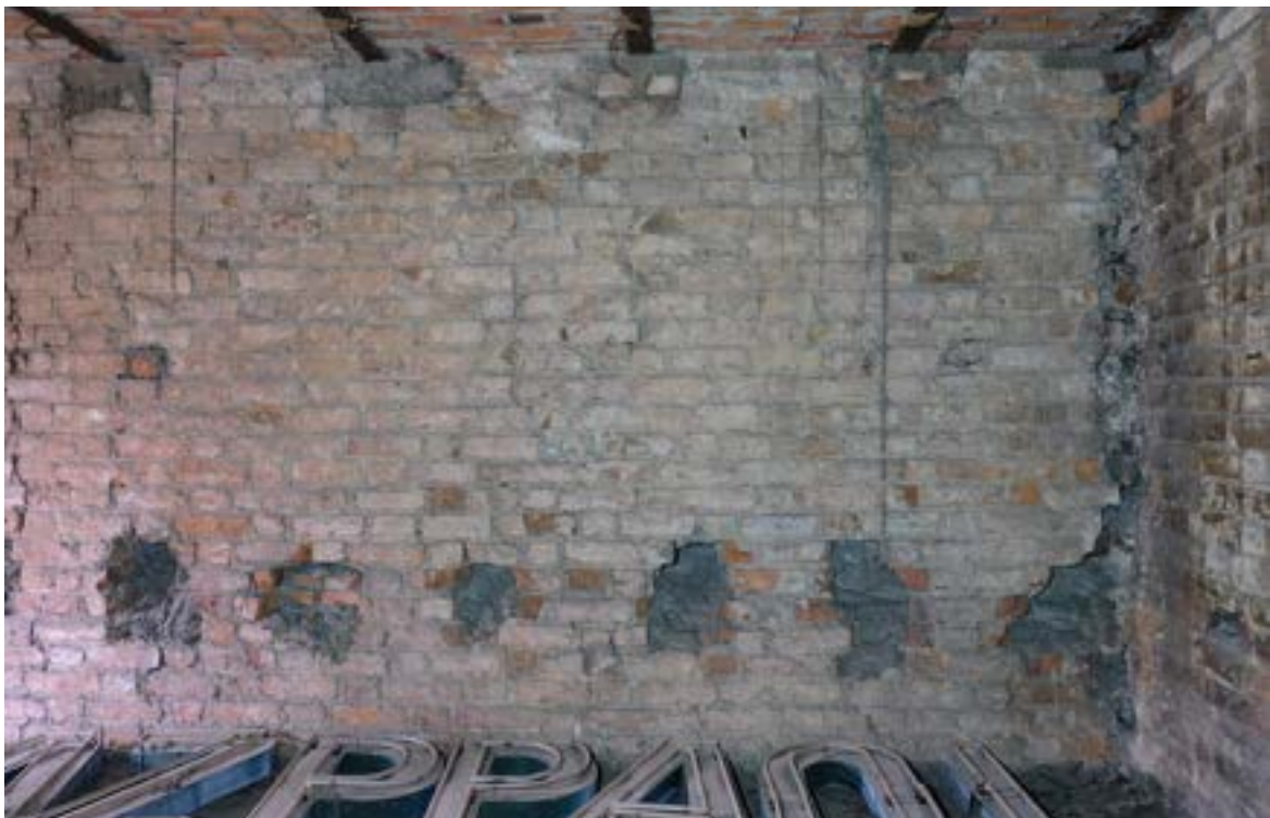
Fot. 82. Poznań, Stary Rynek 42. Piętro II, trakt tylny, ściana południowa, widok ogólny. Widoczny fragment ściany zachodniej, zamurowane gniazda belek stropowych (w dolnej i górnej partii ściany). Fot. K. Pietrzak, maj 2023 r.
