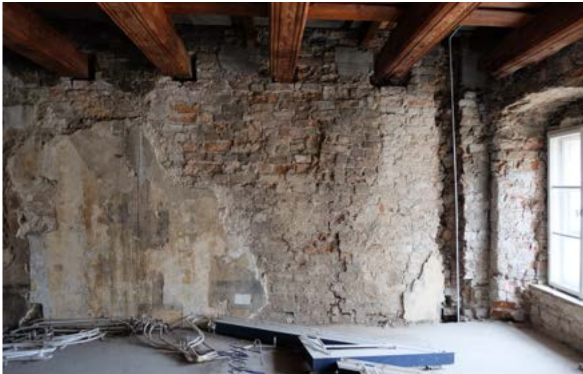
Fot. 90. Poznań, Stary Rynek 42. Piętro II, trakt środkowy, ściana południowa, widok ogólny. Widoczne pozostałości tynków, przemurowania w południowo-zachodnim narożniku pomieszczenia, fragment ściany zachodniej (elewacji frontowej) oraz profilowane belki stropu nad pomieszczeniem. Fot. K. Pietrzak, maj 2023 r.
