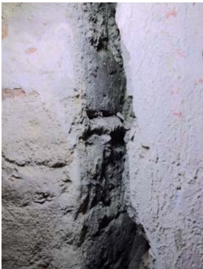
Fot. 13. Poznań, Stary Rynek 42. Piętro I, trakt frontowy, ściana północna na styku ze ścianą zachodnią (elewacji frontowej). Szczelina na styku ściany zachodniej (elewacji frontowej) i ściany północnej budynku, widoczne lico cegły i spoiny dostawionego muru. Fot. K. Pietrzak, maj 2023 r.
