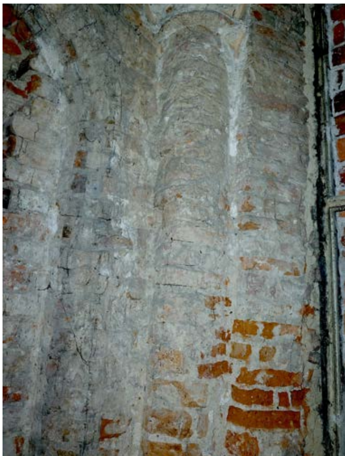
Fot. 25. Poznań, Stary Rynek 42. Piętro I, trakt tylny, styk ściany północnej i wschodniej (północno-wschodni narożnik budynku). Widoczna półkolumna obok zamurowanego otworu okiennego. Fot. K. Pietrzak, maj 2023 r.
