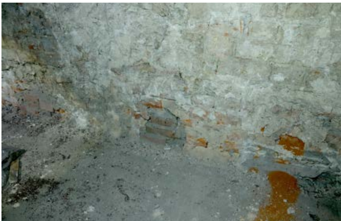
Fot. 24. Poznań, Stary Rynek 42. Piętro I, trakt tylny, ściana północna. Widoczne zamurowane gniazda belek stropowych. Fot. K. Pietrzak, maj 2023 r.
