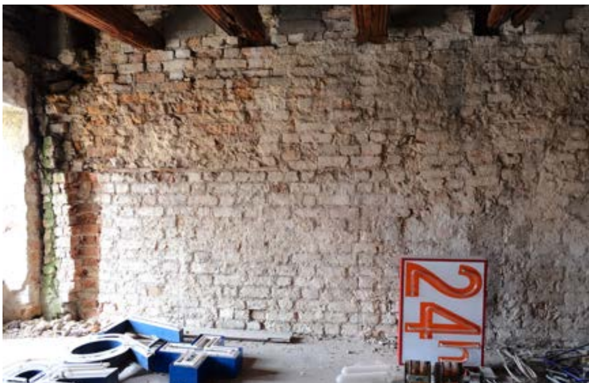
Fot. 63. Poznań, Stary Rynek 42. Piętro II, trakt frontowy, ściana północna, widok ogólny. Widoczne zamurowanie (uzupełnienie) ściany w sąsiedztwie otworu okiennego, wążek wendyjski w dolnej partii ściany oraz belki drewnianego stropu nad помещением. Fot. K. Pietrzak, maj 2023 r.
