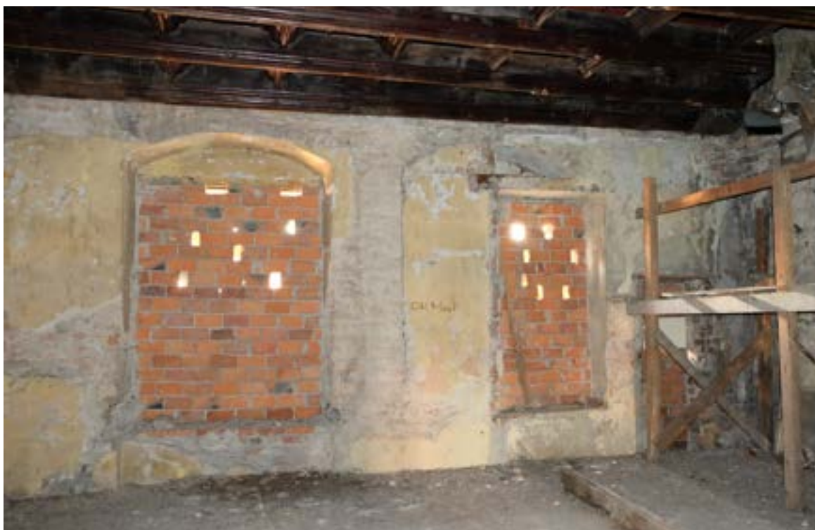
Fot. 109. Poznań, Stary Rynek 43. Piętro II, trakt tylny, ściana wschodnia (tylna kamienicy) widok ogólny. Widoczne zamurowane otwory okienne, fragment drewnianego stropu kasetonowego oraz fragment rusztowania przy ścianie południowej, na której zachowały się polichromie (przekryte i zabezpieczone obecnie bibulką japońską). Fot. K. Pietrzak, maj 2023 r.
