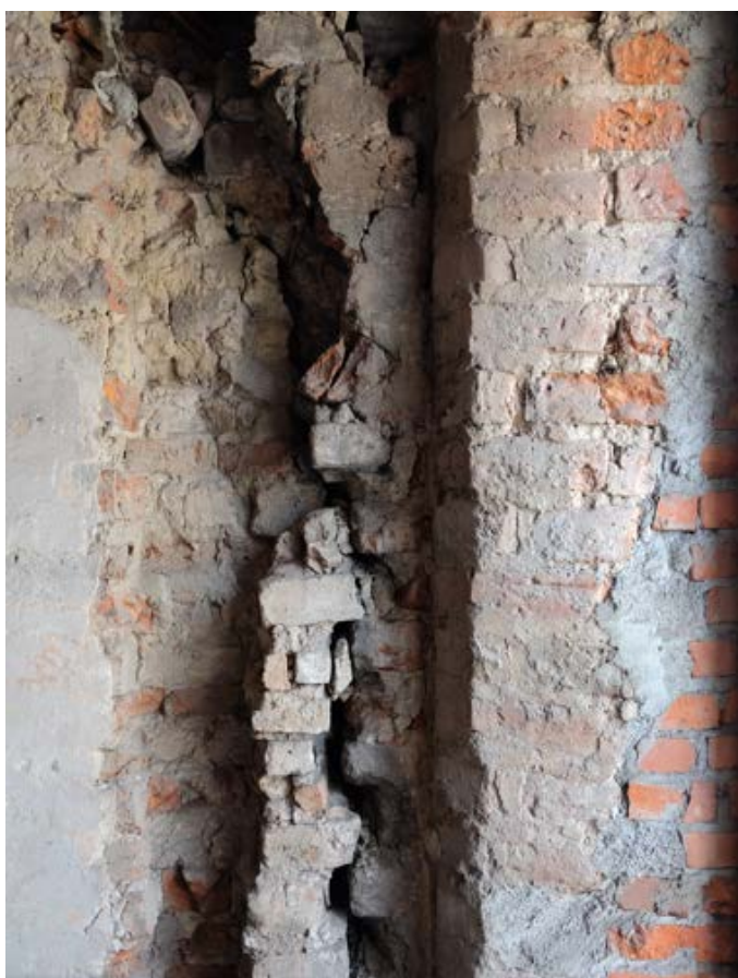
Fot. 46. Poznań, Stary Rynek 42. Piętro I, trakt frontowy, ściana południowa na styku ze ścianą zachodnią (narożnik przy oknie). Widoczne przemurowania (uzupełnienia) ściany w narożniku i fragment pierwotnego łuku. Fot. K. Pietrzak, maj 2023 r.
