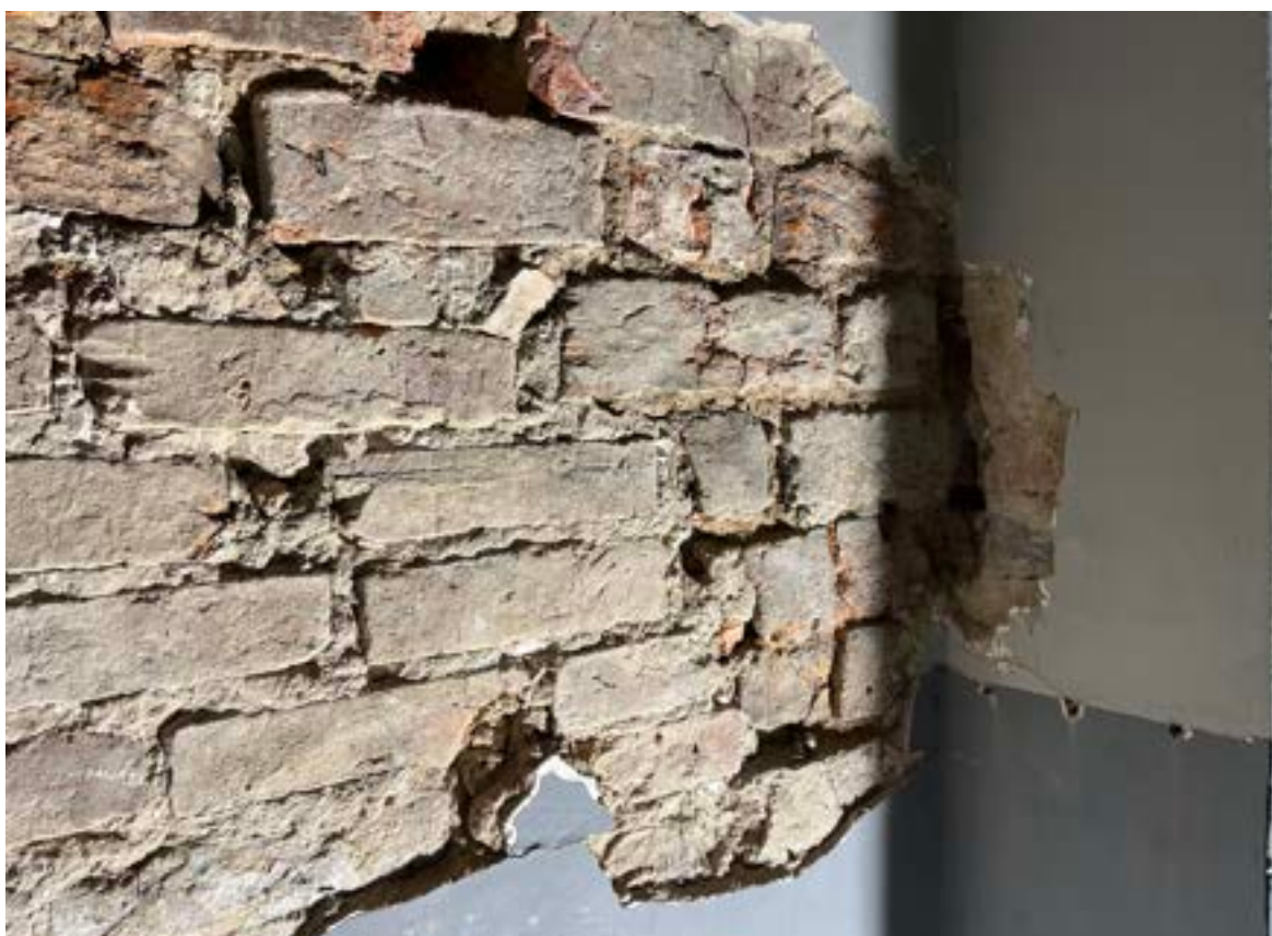
Fot. 6. Poznań, Stary Rynek 42. Parter, trakt frontowy, ściana południowa (sąsiedzka). Odkrywka lica muru we wnęce, widoczne dostawienie muru i sięgający wgląb mur pierwotny. Fot. B. Pietrzak, listopad 2022 r.
