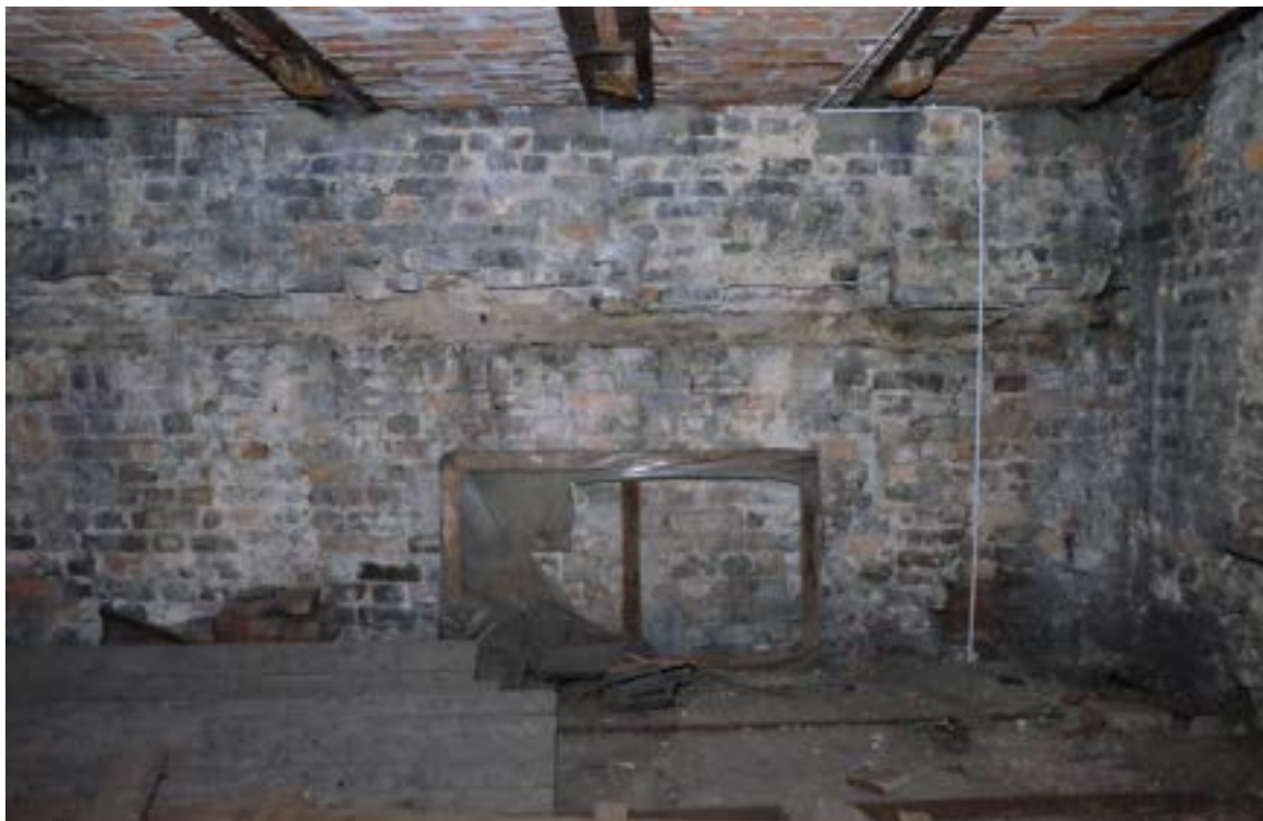
Fot. 111. Poznań, Stary Rynek 42. Poddasze, trakt tylny, ściana północna, widok ogólny. Widoczny fragment ściany wschodniej, rolka z cegły układanej główkowo (w połowie wysokości ściany) oraz ślady po belce leżącej na rolce (murlacie). Fot. K. Pietrzak, maj 2023 r.
