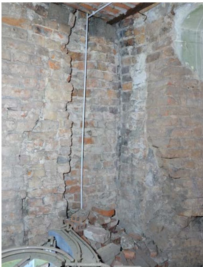
Fot. 74. Poznań, Stary Rynek 42. Piętro II, trakt tylny, północno- wschodni narożnik pomieszczenia (przy ścianie tylnej budynku). Widoczna niejednolita struktura muru z licznymi przemurowaniami (uzupełnieniami). Fot. K. Pietrzak, maj 2023 r.
