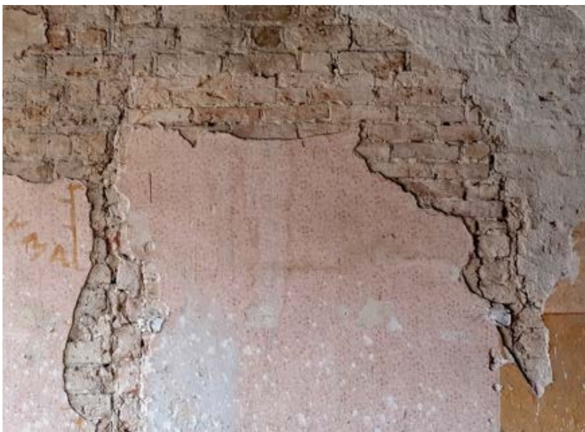
Fot. 14. Poznań, Stary Rynek 42. Piętro I, trakt frontowy, ściana północna. W centrum widoczne zamurowanie (uzupełnienie) ściany. Fot. K. Pietrzak, maj 2023 r.
