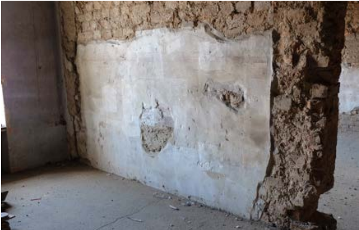
Fot. 101. Poznań, Stary Rynek 43. Piętro II, trakt frontowy, ścianka działowa pośrodku pomieszczenia, widok ogólny. Widoczne zachowane tynki z polichromiami (przesłonięte i zabezpieczone bibułą japońską) oraz fragment ściany zachodniej (elewacji frontowej). Fot. K. Pietrzak, maj 2023 r.
