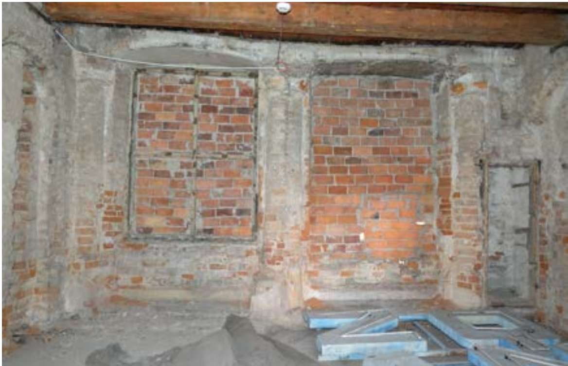
Fot. 29. Poznań, Stary Rynek 42. Piętro I, trakt tylny, ściana wschodnia (tylna kamienicy). Widoczne zamurowane okna, zarys półkolumn flankujących otwory okienne oraz drewniane obramienie zamurowanego otworu dawnego wyjścia na ganek (po prawej stronie). Fot. K. Pietrzak, maj 2023 r.
