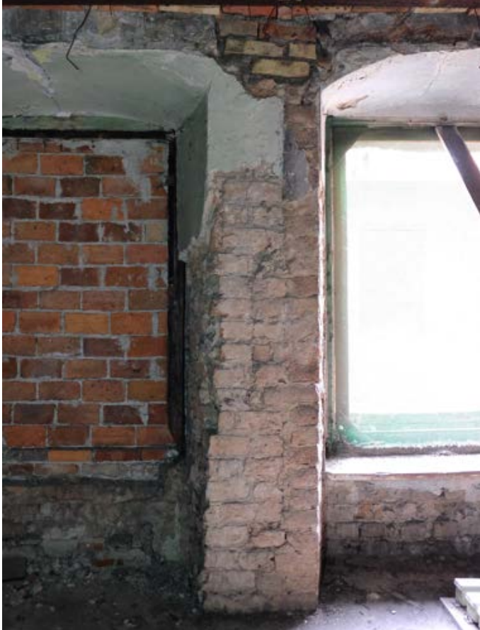
Fot. 78. Poznań, Stary Rynek 42. Piętro II, trakt tylny, ściana wschodnia. Widoczne przemurowania muru pomiędzy otworami okiennymi. Fot. K. Pietrzak, maj 2023 r.
