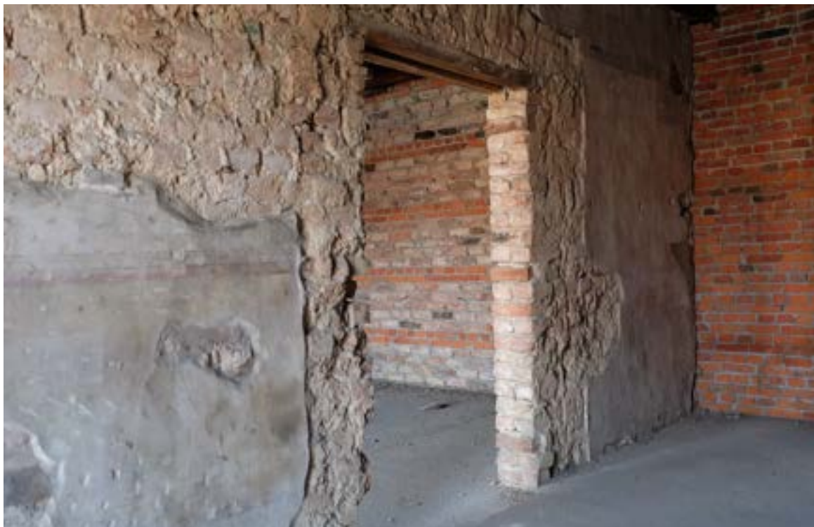
Fot. 103. Poznań, Stary Rynek 43. Piętro II, trakt frontowy, ścianka działowa pośrodku pomieszczenia, widok ogólny. Widoczne zachowane tynki z polichromiami (przesłonięte i zabezpieczone bibułą japońską) oraz fragmenty ściany wschodniej (oddzielającej trakt środkowy). Fot. K. Pietrzak, maj 2023 r.
