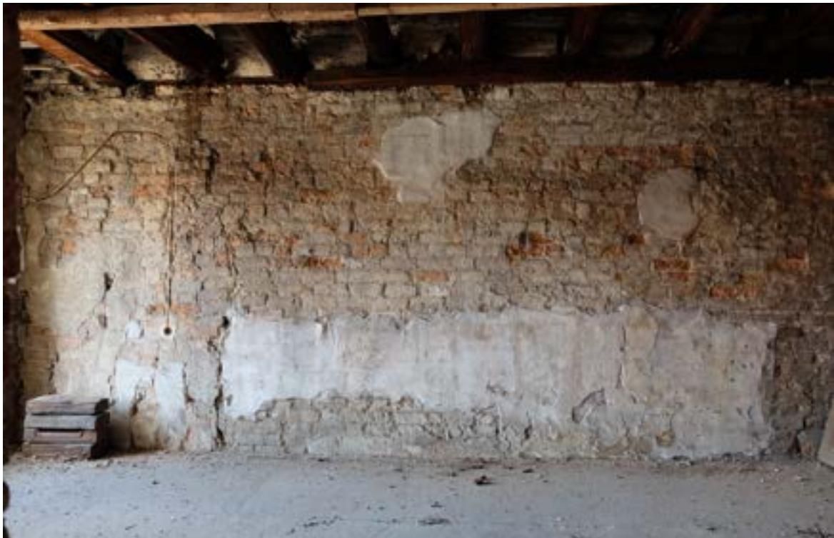
Fot. 93. Poznań, Stary Rynek 43. Piętro II, trakt frontowy, ściana północna, widok ogólny. Widoczne pozostałości tynków, przemurowania (uzupełnienia) ściany oraz profilowane belki stropu nad помещением. Fot. K. Pietrzak, maj 2023 r.
