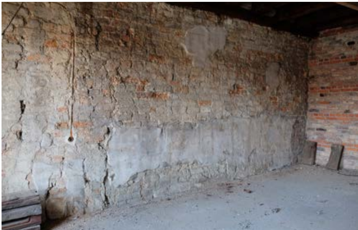
Fot. 94. Poznań, Stary Rynek 43. Piętro II, trakt frontowy, ściana północna, widok ogólny. Widoczny fragment ściany wschodniej oddzielającej trakt środkowy oraz pozostałości tynków i przemurowania (uzupełnienia) ściany. Fot. K. Pietrzak, maj 2023 r.
