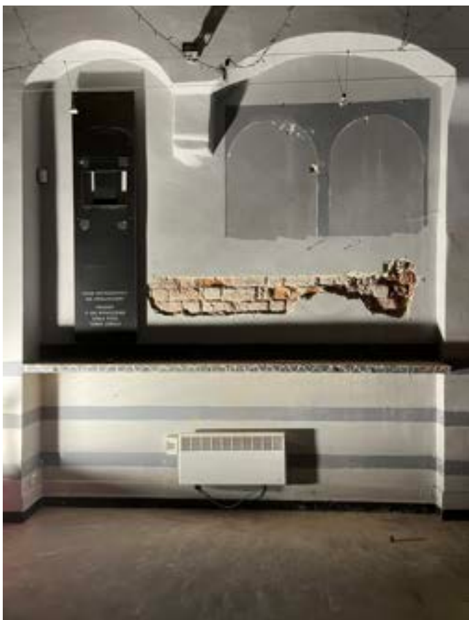
Fot. 7. Poznań, Stary Rynek 42. Parter, trakt frontowy, ściana południowa (sąsiedzka). Odkrywka lica muru we wnęce. Fot. B. Pietrzak, listopad 2022 r.
