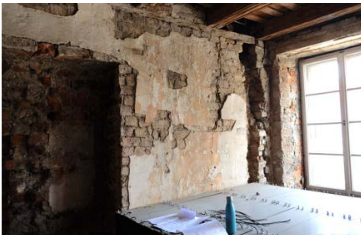
Fot. 45. Poznań, Stary Rynek 42. Piętro I, trakt frontowy, ściana południowa. Widoczny fragment otworu okiennego w ścianie zachodniej oraz przemurowania (uzupełnienia) ściany w narożniku. Fot. K. Pietrzak, maj 2023 r.
