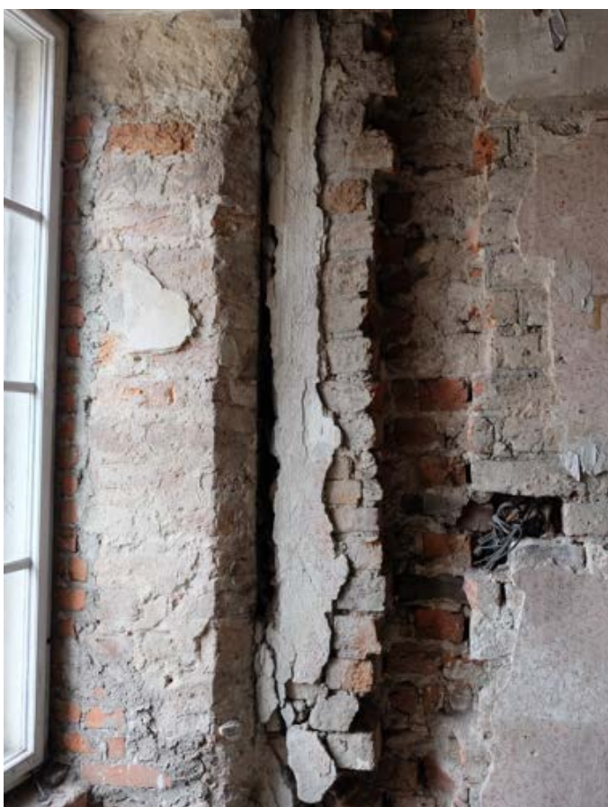
Fot. 12. Poznań, Stary Rynek 42. Piętro I, trakt frontowy, ściana północna na styku ze ścianą zachodnią (elewacji frontowej). Widoczne zamurowanie (uzupełnienie) ściany w sąsiedztwie otworu okiennego. Fot. K. Pietrzak, maj 2023 r.
