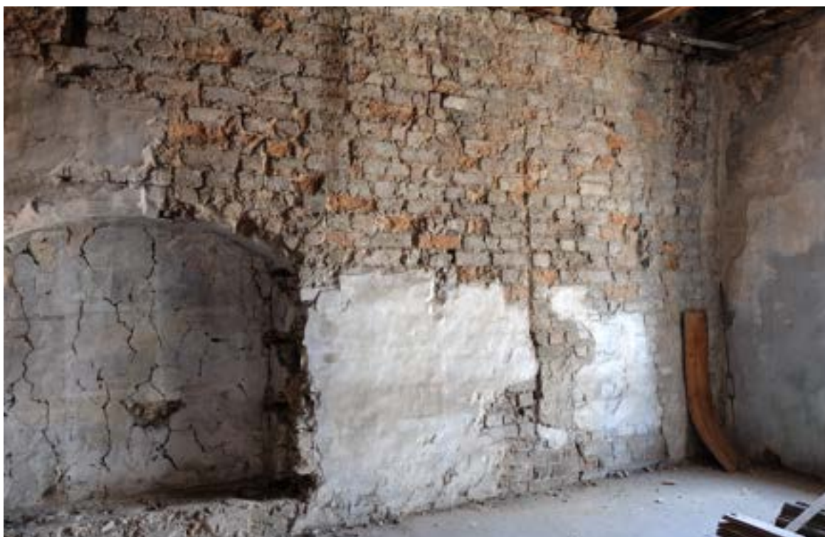
Fot. 99. Poznań, Stary Rynek 43. Piętro II, trakt frontowy, ściana południowa, widok ogólny. Widoczne zachowane tynki z polichromiami (przesłonięte i zabezpieczone bibułą japońską) oraz fragment ściany wschodniej (elewacji frontowej). Fot. K. Pietrzak, maj 2023 r.
