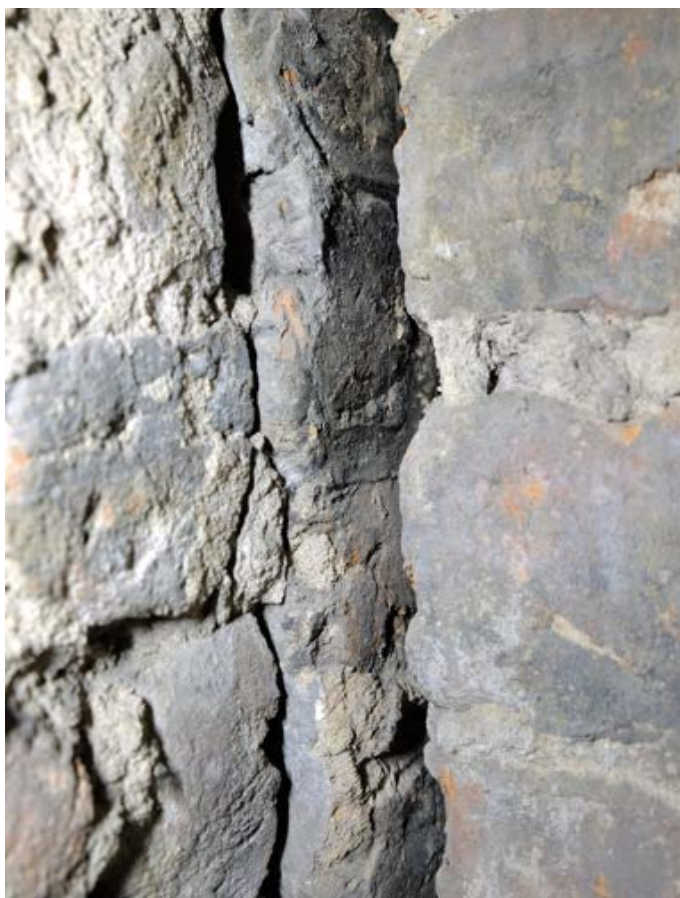
Fot. 76. Poznań, Stary Rynek 42. Piętro II, trakt tylny, północno- wschodni narożnik pomieszczenia (przy ścianie tylnej budynku). Widoczne lico pierwotnej ściany (z lewej, wchodząca w głąb struktury istniejącego muru) z pozostałościami tynku, do którego dostawiono późniejszy mur (uzupełnienie widoczne z prawej strony). Fot. K. Pietrzak, maj 2023 r.
