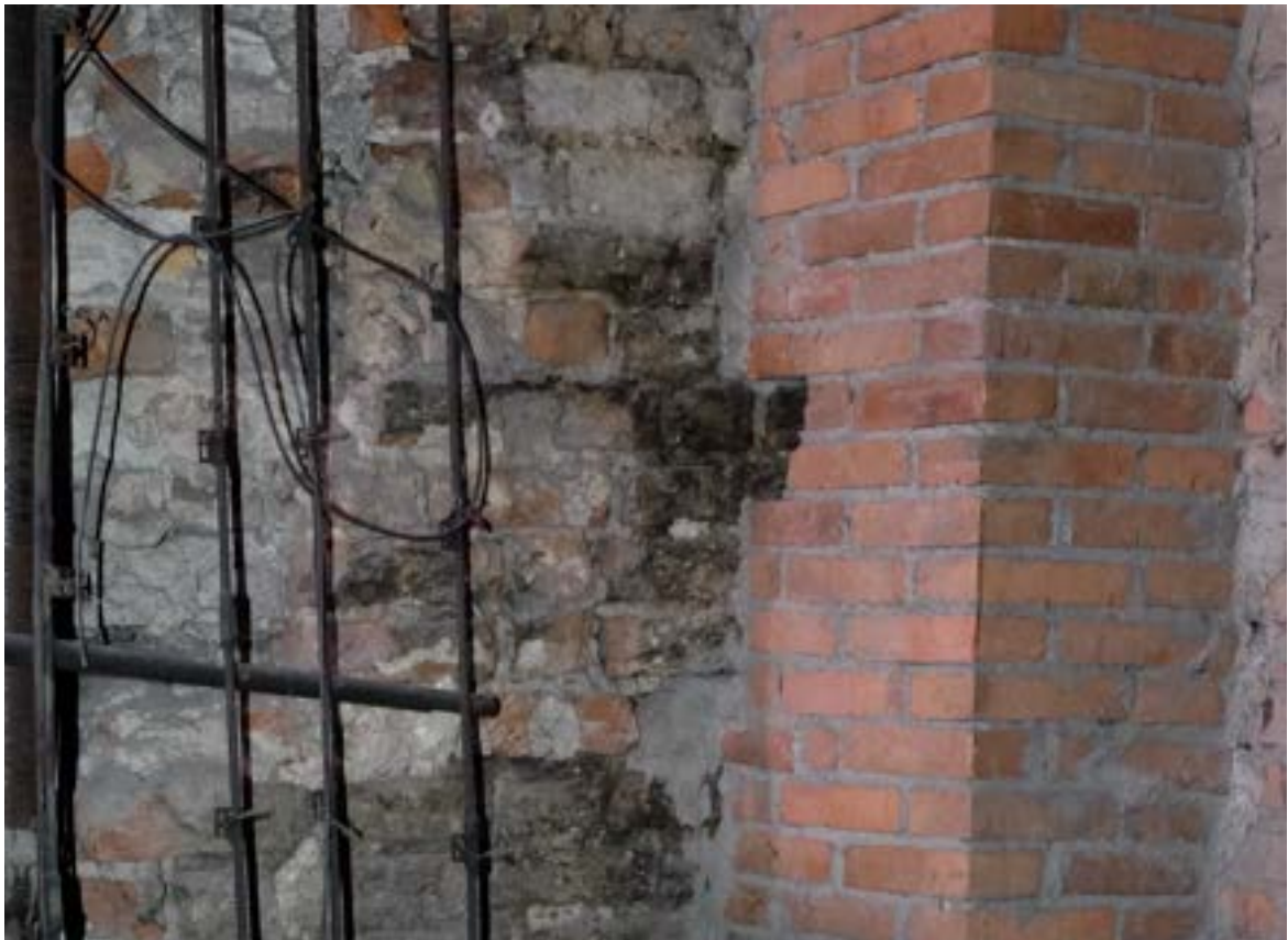
Fot. 21. Poznań, Stary Rynek 42. Piętro I, trakt środkowy, styk ściany północnej ze wschodnią. Widoczny wtórny komin dostawiony do pierwotnej ściany. Fot. K. Pietrzak, maj 2023 r.
