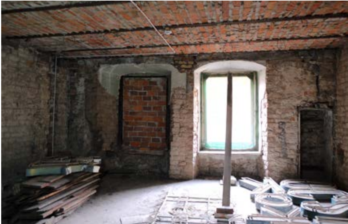
Fot. 77. Poznań, Stary Rynek 42. Piętro II, trakt tylny, ściana wschodnia, widok ogólny. Widoczne zamurowany otwór okienny (z lewej) oraz z drewniane obramienie zamurowanego otworu dawnego wyjścia na ganek (z prawej) i łuk dawnej wnęki powyżej. Fot. K. Pietrzak, maj 2023 r.
