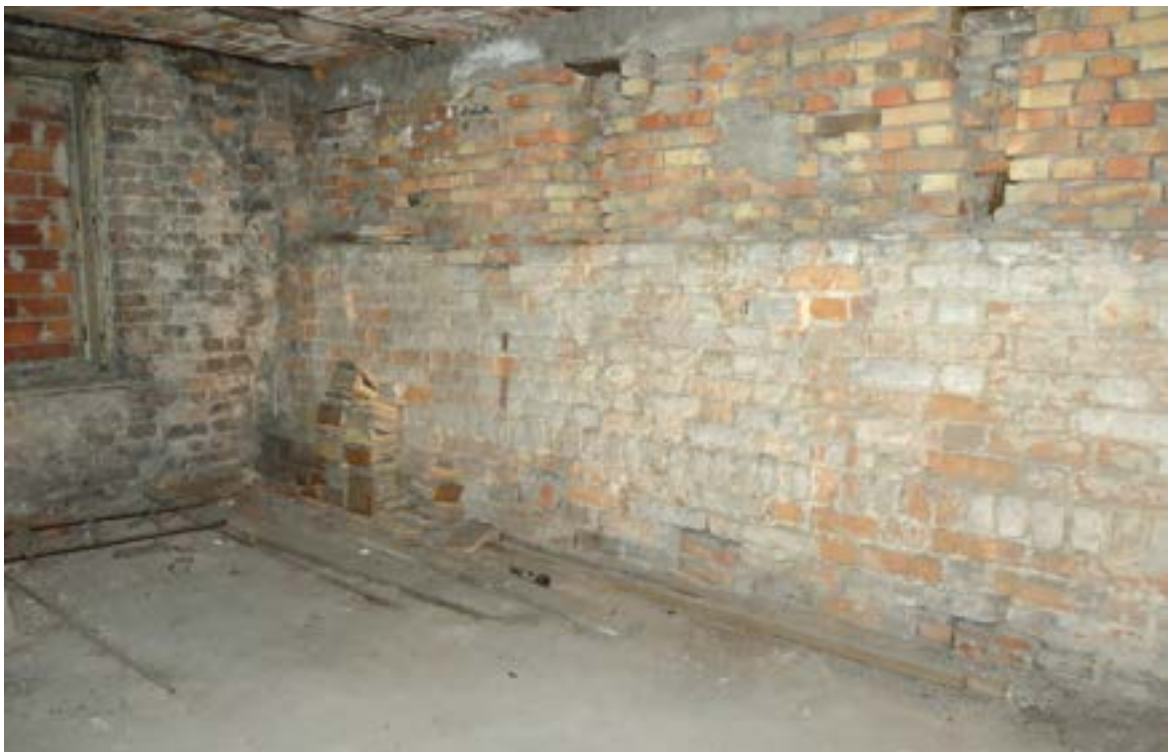
Fot. 114. Poznań, Stary Rynek 42. Poddasze, trakt tylny, ściana południowa. Widoczny fragment ściany wschodniej z zamurowanym otworem okiennym, rolka z cegły układanej główkowo (w dolnej partii ściany) oraz współczesna nadbudowa ściany powyżej 2/3 obecnej wysokości pomieszczenia. Fot. K. Pietrzak, maj 2023 r.
