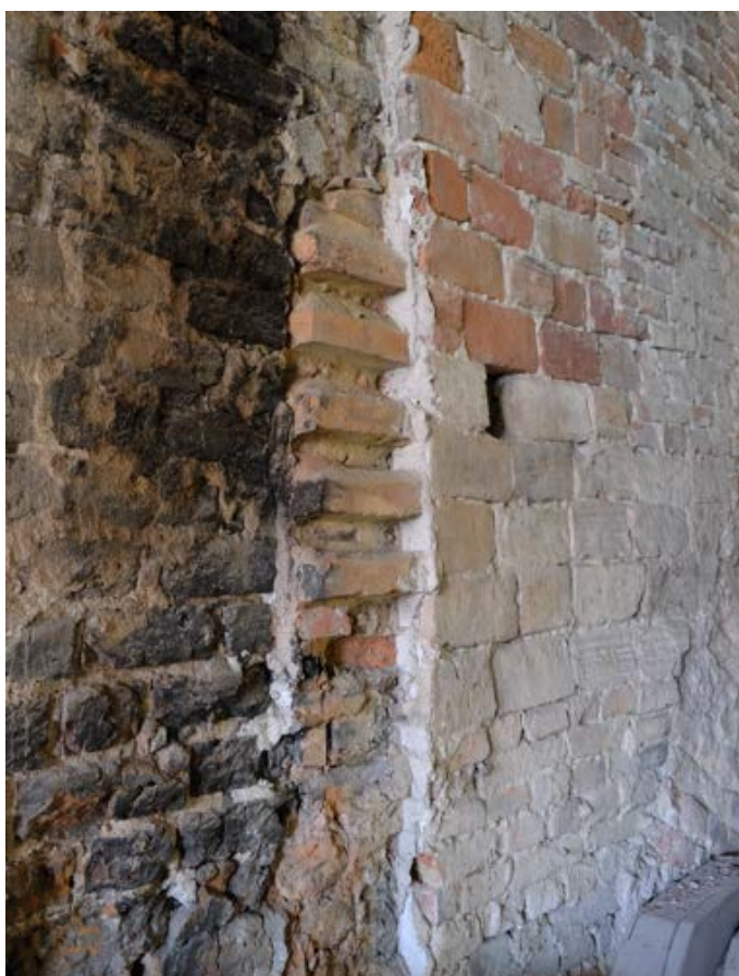
Fot. 56. Poznań, Stary Rynek 43. Piętro I, trakt frontowy, ściana północna. Widoczne strzępia rozebranej ściany dzielącej trakt frontowy i środkowy, oraz ślady sadzy na ścianie. Fot. K. Pietrzak, maj 2023 r.
