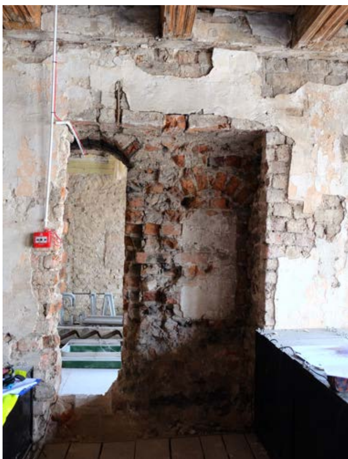
Fot. 42. Poznań, Stary Rynek 42. Piętro I, trakt frontowy, ściana południowa. Widoczne wtórne przejście pomiędzy kamienicami (przejście do kamienicy nr 43), przy nim odsłonięta pierwotna wnęka z zachowanymi fragmentarycznie tynkami. Fot. K. Pietrzak, maj 2023 r.
