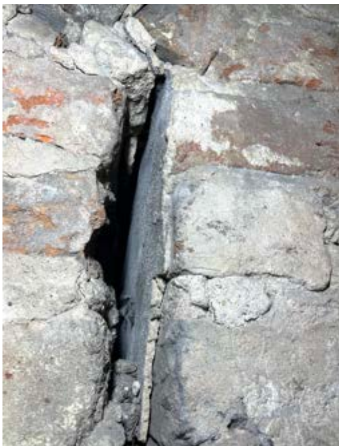
Fot. 80. Poznań, Stary Rynek 42. Piętro II, trakt tylny, ściana wschodnia. Widoczne opracowanie lica ściany (tynk) wewnątrz dawnej (zamurowanej obecnie) wnęki.
