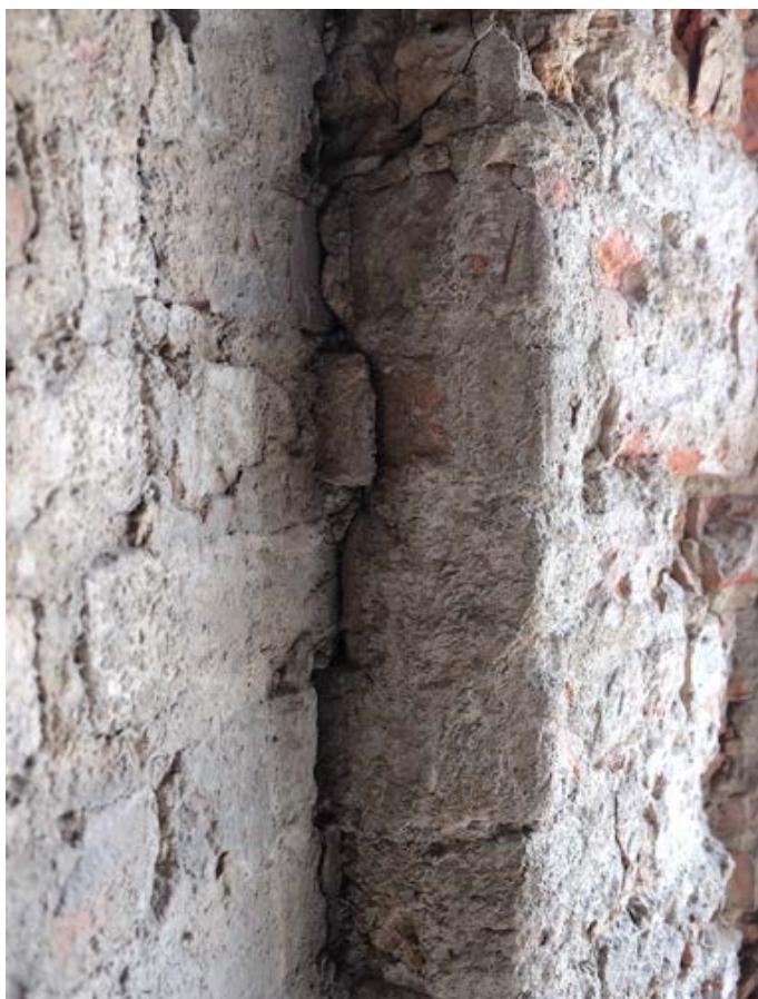
Fot. 92. Poznań, Stary Rynek 42. Piętro II, trakt środkowy, ściana południowa. Południowo-zachodni narożnik pomieszczenia, widoczne przewiązanie narożnika muru. Fot. K. Pietrzak, maj 2023 r.
