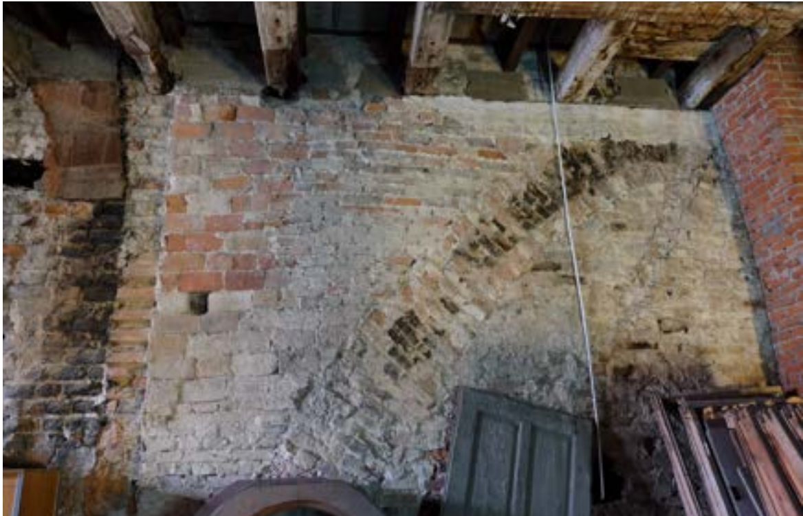
Fot. 57. Poznań, Stary Rynek 43. Piętro I, trakt środkowy, ściana północna, widok ogólny. Widoczne murowany łuk przebiegający po przekątnej przez całe pomieszczenie, pokryty zabrudzeniem sadzowym. Fot. K. Pietrzak, maj 2023 r.
