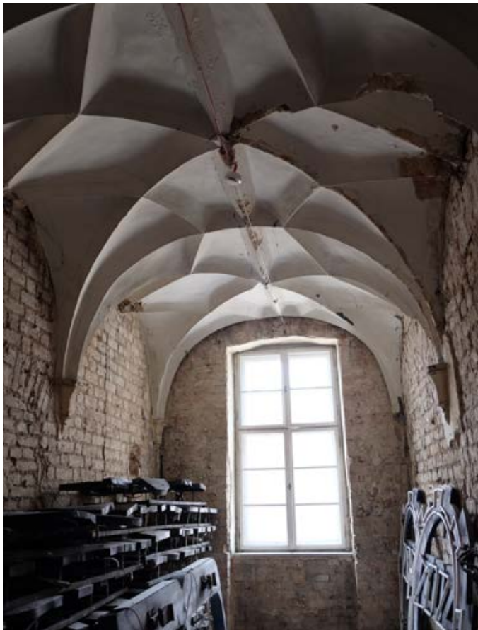
Fot. 60. Poznań, Stary Rynek 43. Piętro I, trakt frontowy, ściana zachodnia. Widoczne sklepienie kryształowe i okno elewacji zachodniej (rynkowej). Fot. K. Pietrzak, maj 2023 r.
