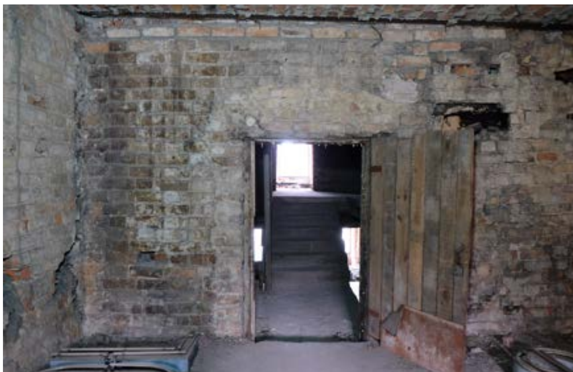
Fot. 84. Poznań, Stary Rynek 42. Piętro II, trakt tylny, ściana zachodnia (oddzielająca trakt środkowy), widok ogólny. Widoczne wtórne przemurowania (uzupełnienia ściany), otwór drzwiowy i skucie lica muru w południowo zachodnim narożniku pomieszczenia (z lewej strony fotografii). Fot. K. Pietrzak, maj 2023 r.
