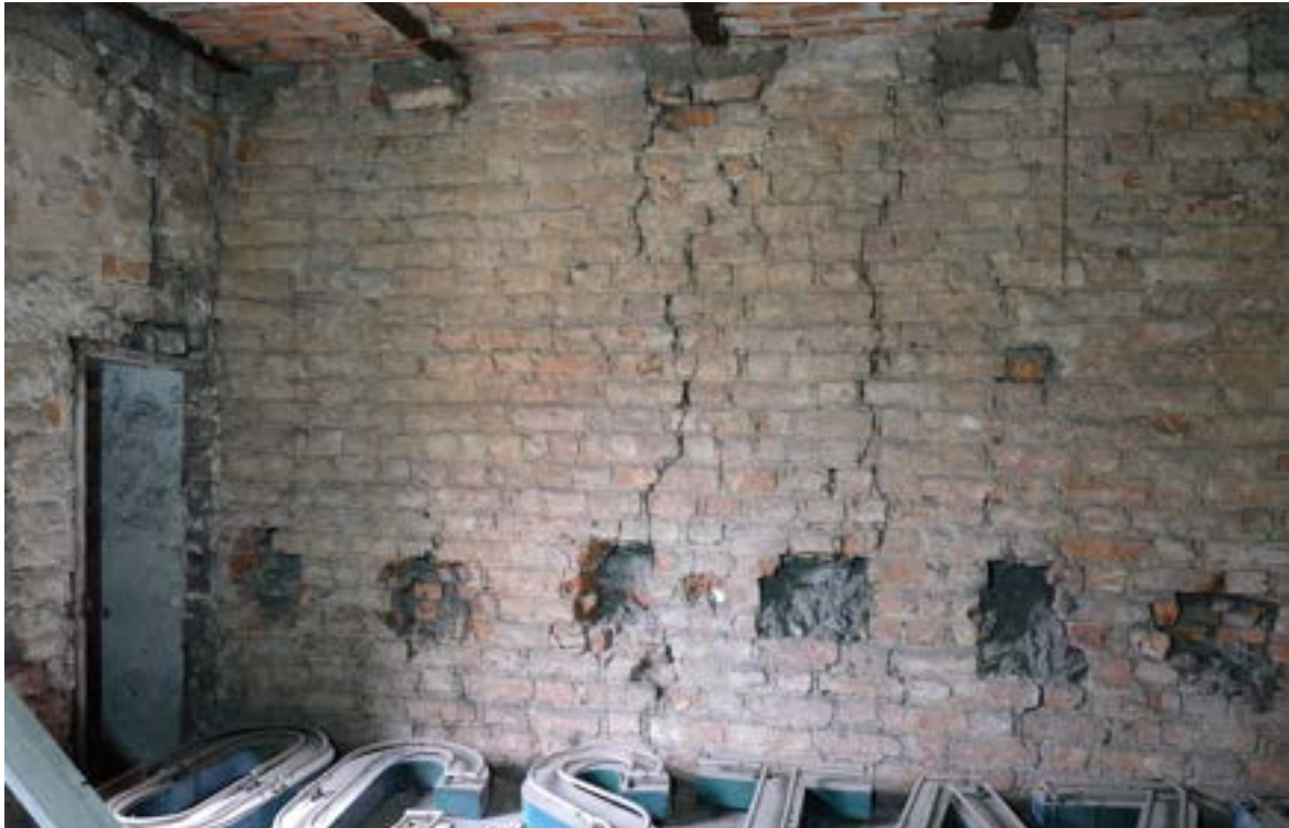
Fot. 81. Poznań, Stary Rynek 42. Piętro II, trakt tylny, ściana południowa, widok ogólny. Widoczny fragment ściany wschodniej, zamurowane gniazda belek stropowych (w dolnej i górnej partii ściany) oraz spękania biegnące od górnych do dolnych gniazd (po środku). Fot. K. Pietrzak, maj 2023 r.
