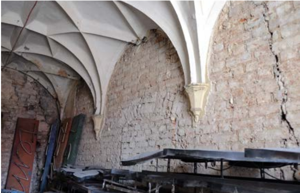
Fot. 61. Poznań, Stary Rynek 43. Piętro I, trakt frontowy, ściana południowa. Widoczne sklepienie kryształowe, zamurowana wnęka z łukiem odcinkowym oraz pęknięcie ściany (z prawej strony fotografii). Fot. K. Pietrzak, maj 2023 r.
