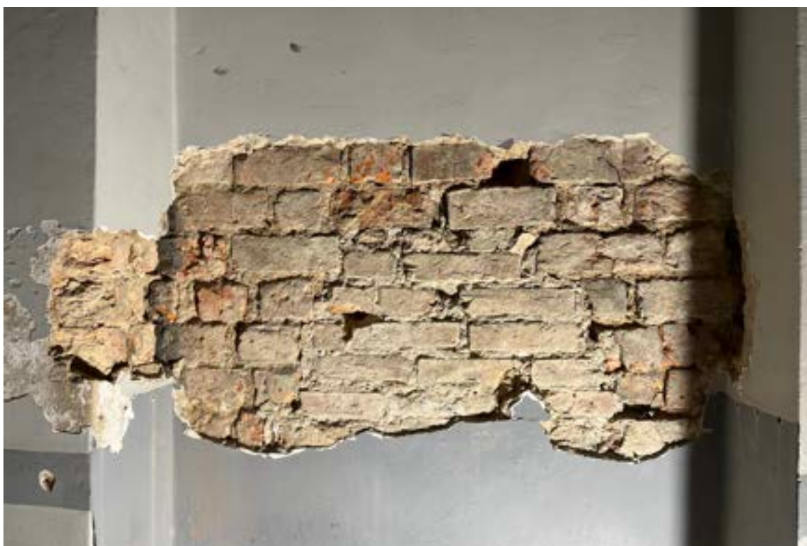
Fot. 4. Poznań, Stary Rynek 42. Parter, trakt frontowy, ściana południowa (sąsiedzka). Odkrywka lica muru we wnęce. Fot. B. Pietrzak, listopad 2022 r.
