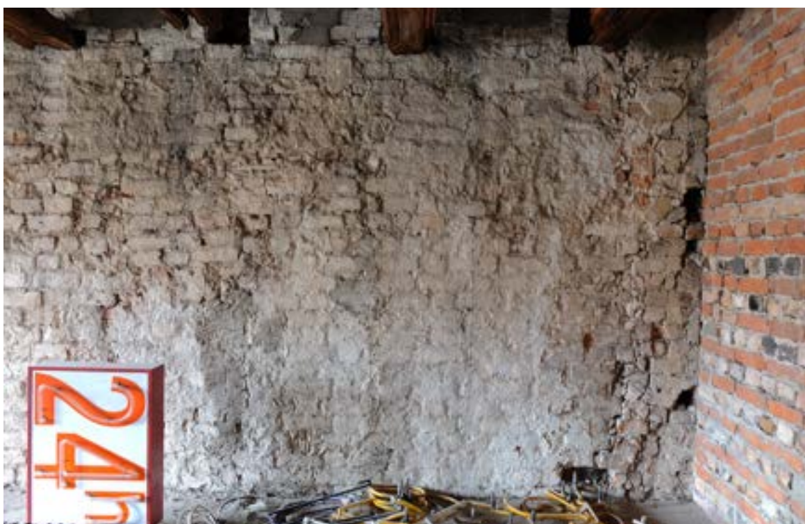
Fot. 64. Poznań, Stary Rynek 42. Piętro II, trakt frontowy, ściana północna, widok ogólny. Widoczne zamurowanie (uzupełnienie) ściany na styku z wtórną ścianką działową (z prawej) oraz belki drewnianego stropu nad помещением. Fot. K. Pietrzak, maj 2023 r.
