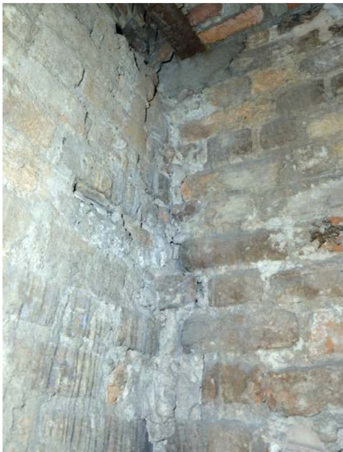
Fot. 73. Poznań, Stary Rynek 42. Piętro II, trakt tylny, północno- zachodni narożnik pomieszczenia (przy ścianie oddzielającej trakt środkowy). Widoczna niejednolita struktura muru z uzupełnieniami. Fot. K. Pietrzak, maj 2023 r.
