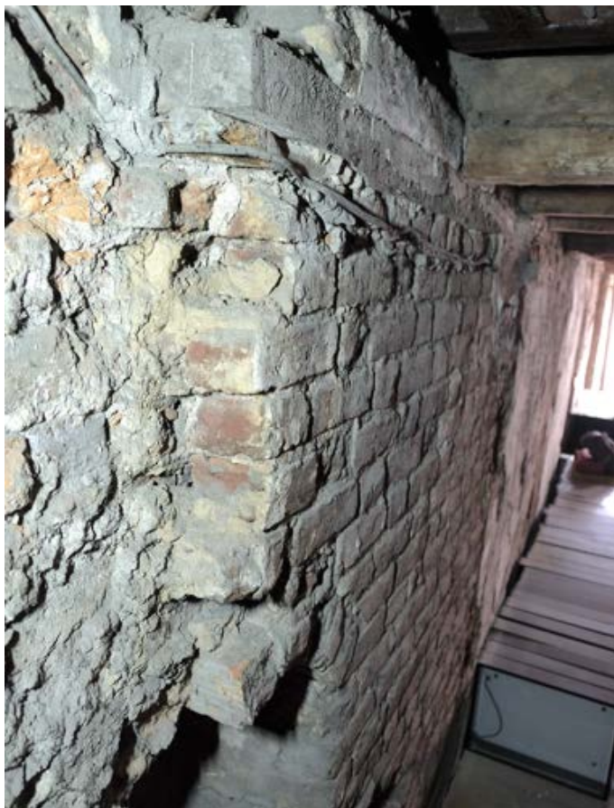
Fot. 39. Poznań, Stary Rynek 42. Piętro I, trakt środkowy, ściana południowa. Widok z biegu schodów w kierunku traktu przedniego. Widoczne skucie lica muru na szerokość wozówki. Fot. K. Pietrzak, maj 2023 r.
