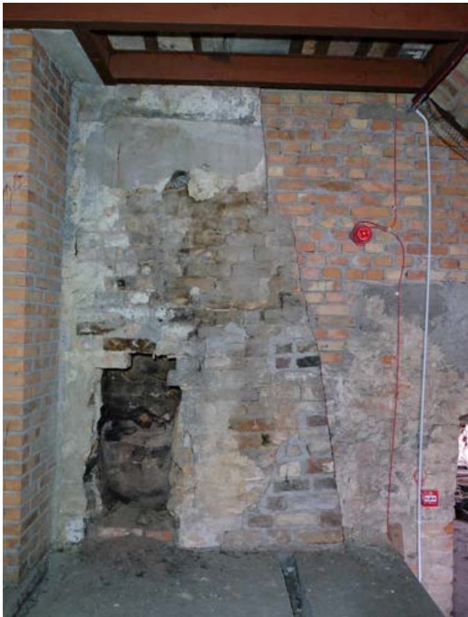
Fot. 68. Poznań, Stary Rynek 42. Piętro II, trakt środkowy, ściana wschodnia. Widoczny dawny komin z zabrudzeniami sadzowymi oraz fragment współczesnego dostawionego komina (z lewej strony). Fot. K. Pietrzak, maj 2023 r.
