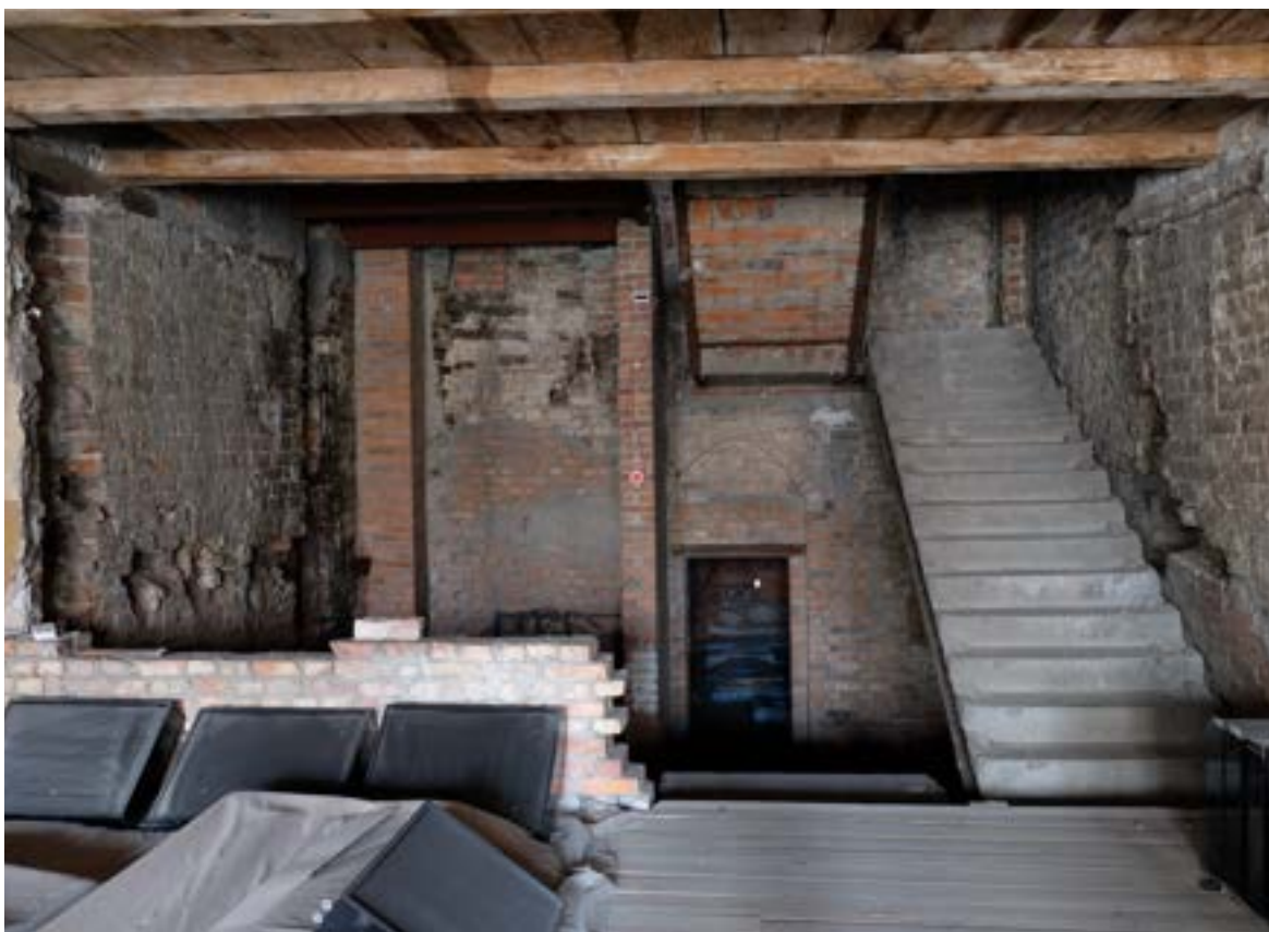
Fot. 20. Poznań, Stary Rynek 42. Piętro I, trakt środkowy, ściana wschodnia, widok ogólny. Widoczna wtórna klatka schodowa (wtórne biegi schodów) Fot. K. Pietrzak, maj 2023 r.
