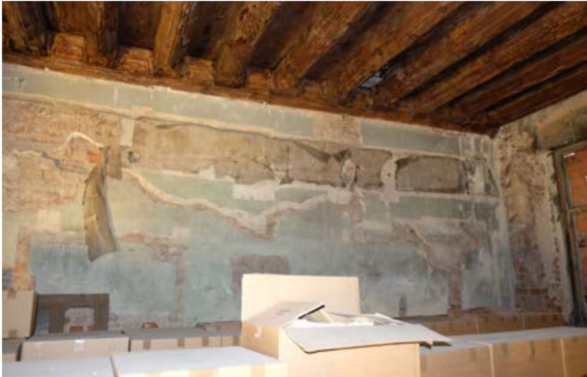
Fot. 59. Poznań, Stary Rynek 43. Piętro I, trakt tylny, ściana północna, widok ogólny. Widoczny fragment ściany wschodniej z zamurowanym otworem okiennym, drewniany strop przekrywający pomieszczenie oraz zabezpieczone bibulką japońską fragmenty polichromii. Fot. K. Pietrzak, maj 2023 r.
