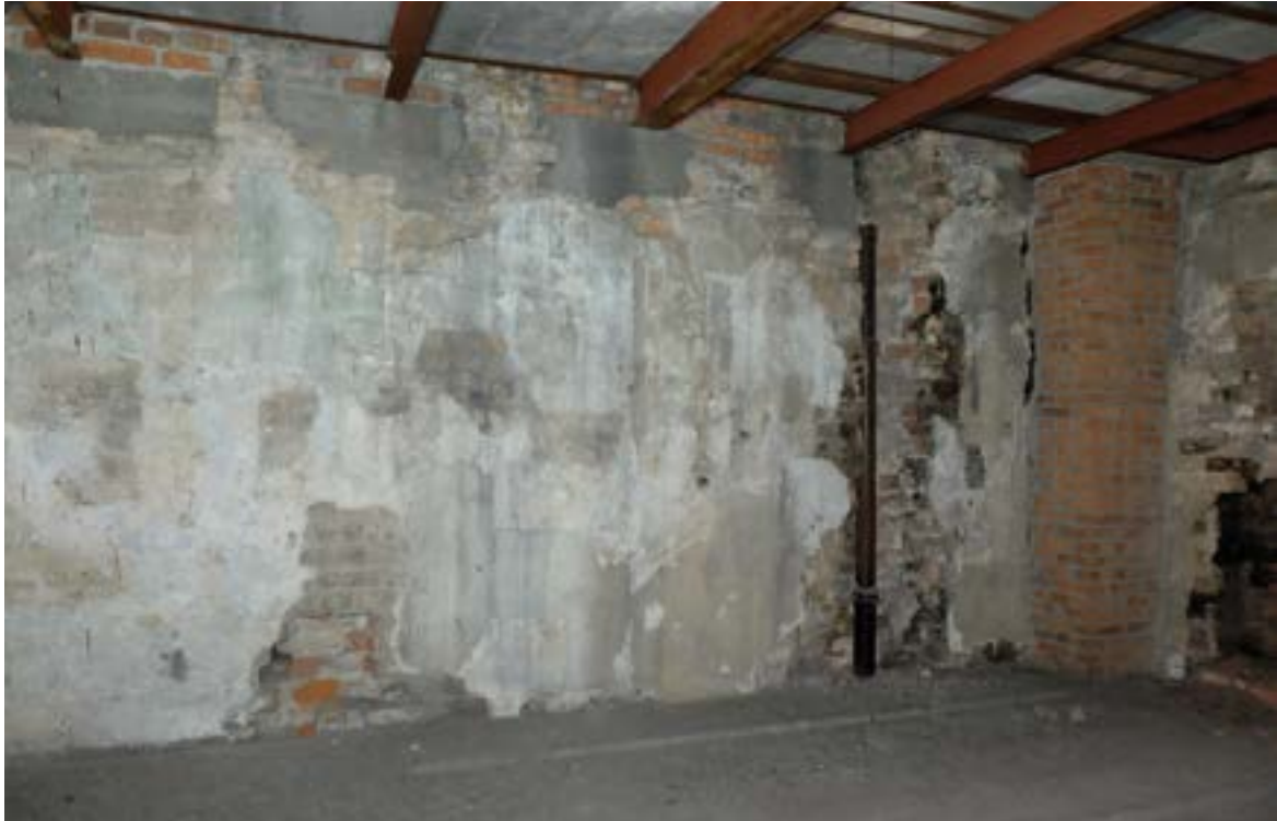
Fot. 67. Poznań, Stary Rynek 42. Piętro II, trakt środkowy, ściana północna, widok ogólny. Widoczny fragment ściany wschodniej (oddzielającej trakt tylny) oraz wtórny dostawiony komin. Fot. K. Pietrzak, maj 2023 r.
