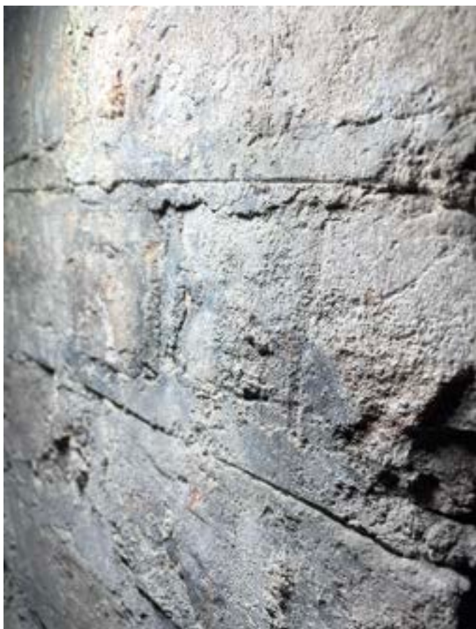
Fot. 75. Poznań, Stary Rynek 42. Piętro II, trakt tylny, północno- wschodni narożnik pomieszczenia (przy ścianie tylnej budynku). Widoczne lico cegieł i opracowanie spoiny na fragmencie uzupełnienia ściany wschodniej. Fot. K. Pietrzak, maj 2023 r.
