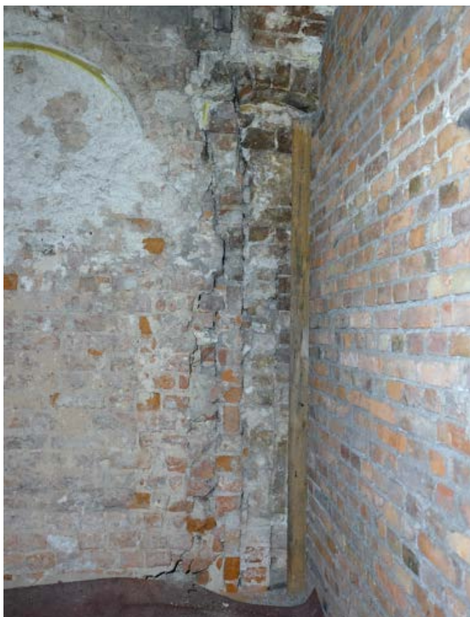
Fot. 28. Poznań, Stary Rynek 42. Piętro I, trakt tylny, styk ściany południowej i zachodniej. Widoczne przemurowanie (uzupełnienie) ściany w narożniku i fragment pierwotnego łuku. Fot. K. Pietrzak, maj 2023 r.
