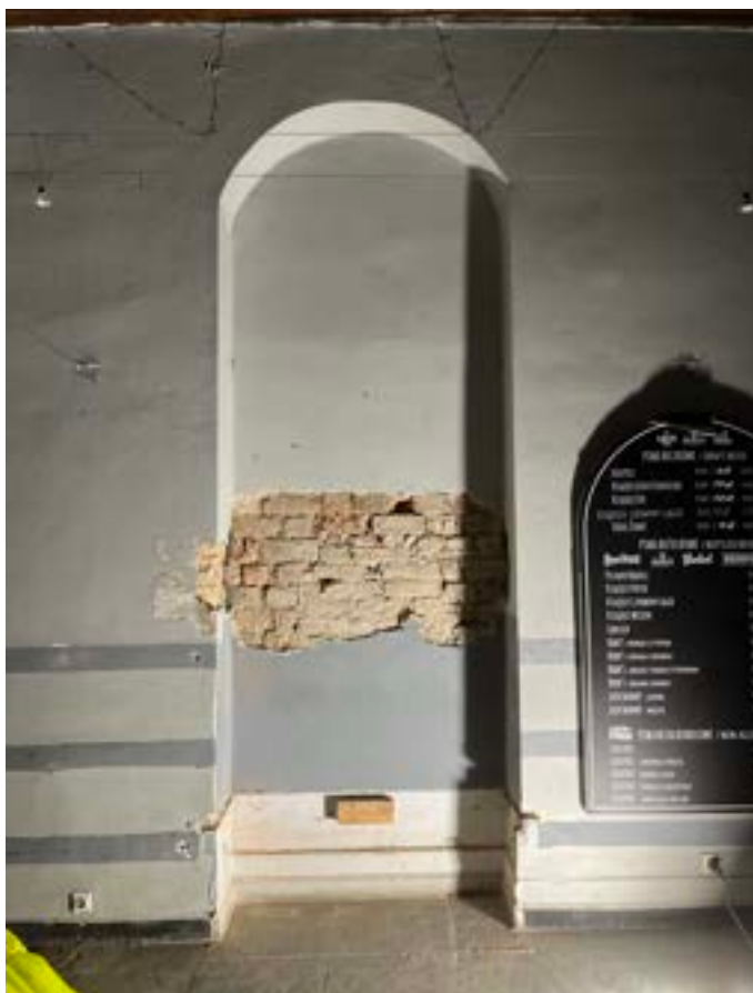
Fot. 3 Poznań, Stary Rynek 42. Parter, trakt frontowy, ściana południowa (sąsiedzka). Odkrywka lica muru we wnęce. Fot. B. Pietrzak, listopad 2022 r.
