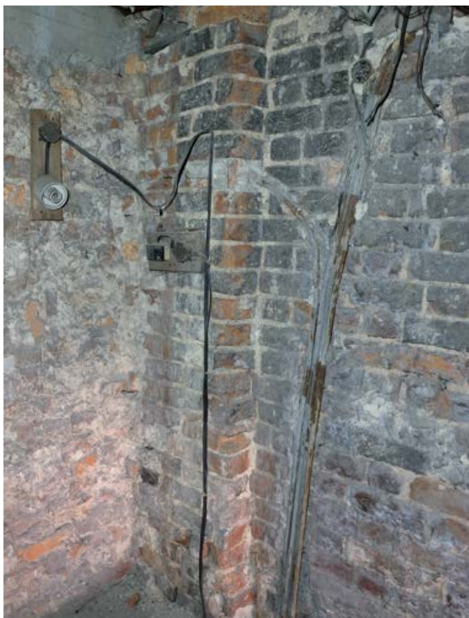
Fot. 87. Poznań, Stary Rynek 42. Piętro II, trakt środkowy, ściana południowa. Widoczne wysunięcie lica muru do przodu (w formie lizeny) po drugiej stronie ściany oddzielającej trakt środkowy i tylny (na wysokości skucia lica muru z fotografii nr 86). Fot. K. Pietrzak, maj 2023 r.
