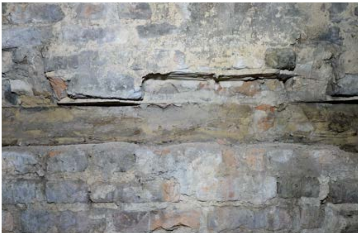
Fot. 112. Poznań, Stary Rynek 42. Poddasze, trakt tylny, ściana północna. Widoczne ślady po belce (murlacie). Fot. K. Pietrzak, maj 2023 r.
