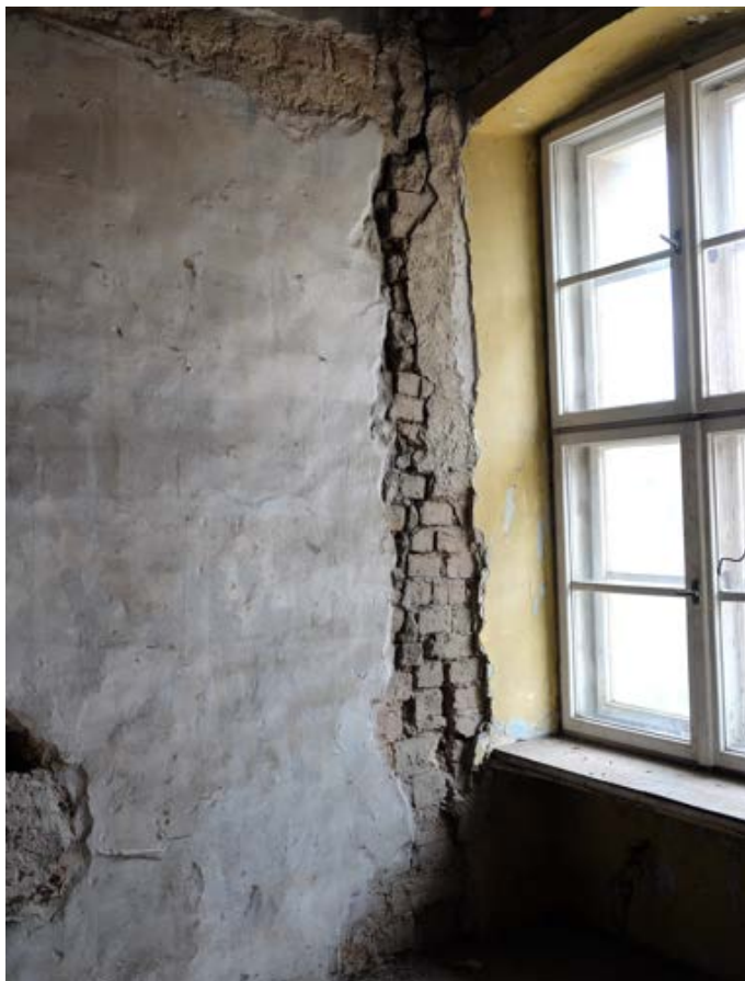
Fot. 97. Poznań, Stary Rynek 43. Piętro II, trakt frontowy, narożnik przy ścianie działowej (zbliżenie fragmentu widocznego na zdjęciu nr 96). Widoczne zachowane tynki z polichromiami (przesłonięte i zabezpieczone bibułą japońską) oraz fragment ściany zachodniej (elewacji frontowej). Widoczne także pęknięcie w miejscu dostawienia elewacji frontowej do powstałej prawdopodobnie wcześniej ścianki działowej. Fot. K. Pietrzak, maj 2023 r.
