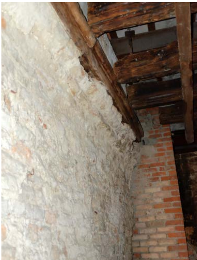
Fot. 106. Poznań, Stary Rynek 43. Piętro II, trakt środkowy, ściana północna. Widoczny murowany gzyms, profilowane belki stropu drewnianego oraz dostawiony współcześnie komin na końcu ściany (przy ścianie wschodniej traktu środkowego). Fot. K. Pietrzak, maj 2023 r.
