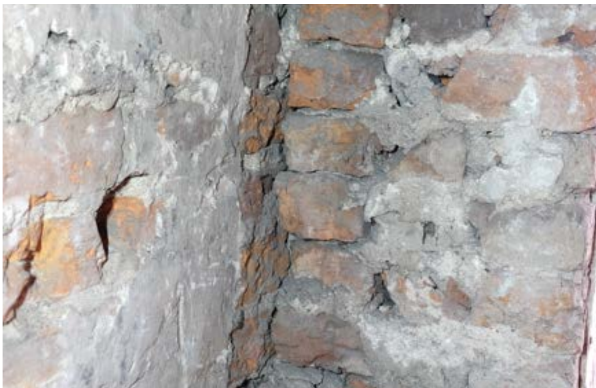
Fot. 44. Poznań, Stary Rynek 42. Piętro I, trakt frontowy, ściana południowa. Odsłonięta pierwotna wnęka z zachowanymi fragmentarycznie tynkami. Widoczne skucie lica muru oraz przesłonięcie pierwotnego muru przez później dostawioną ścianę wewnętrzną (brak przewiązania warstw). Fot. K. Pietrzak, maj 2023 r.
