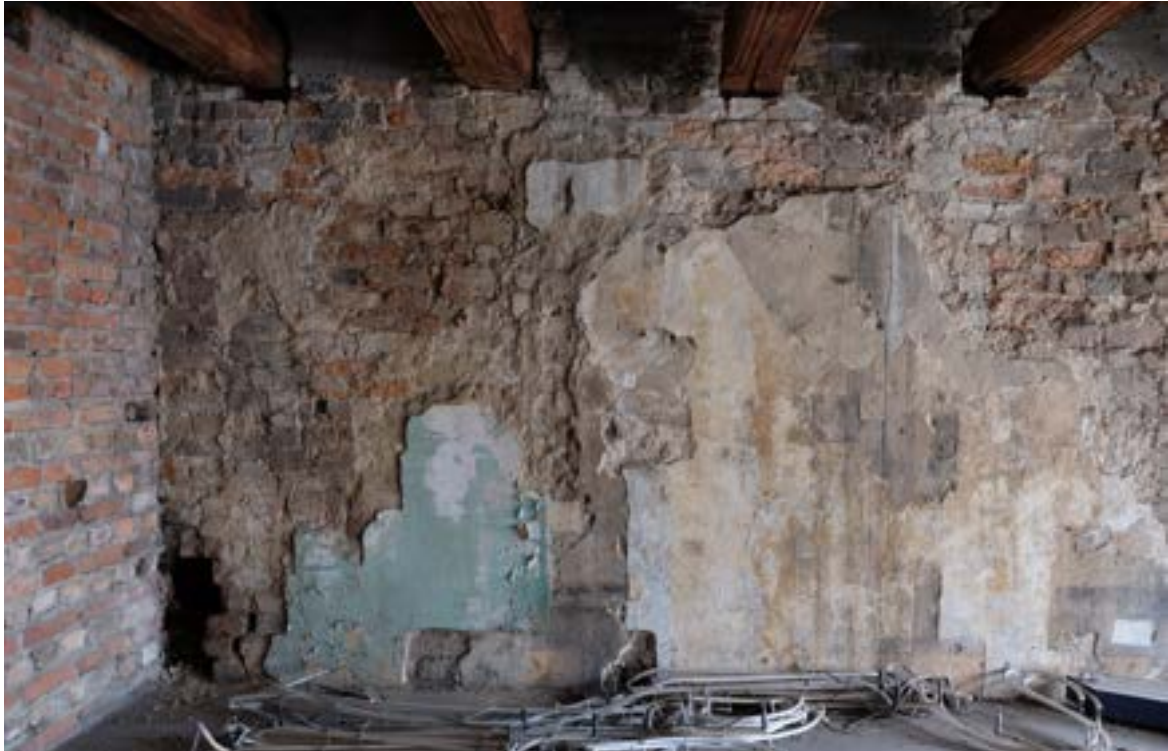
Fot. 89. Poznań, Stary Rynek 42. Piętro II, trakt środkowy, ściana południowa, widok ogólny. Widoczne pozostałości tynków, fragment ściany wschodniej oddzielającej trakt środkowy (po lewej) oraz profilowane belki stropu nad pomieszczeniem. Fot. K. Pietrzak, maj 2023 r.
