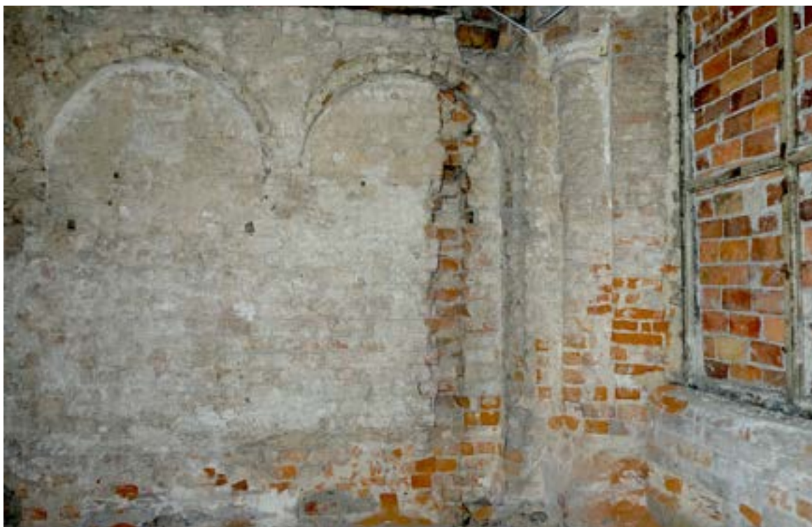
Fot. 23. Poznań, Stary Rynek 42. Piętro I, trakt tylny, ściana północna, widok ogólny. Widoczny fragment ściany wschodniej (ściana tylna kamienicy), z zamurowanym otworem okiennym. Fot. K. Pietrzak, maj 2023 r.
