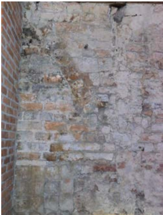
Fot. 105. Poznań, Stary Rynek 43. Piętro II, trakt środkowy, ściana północna. Widoczne przemurowanie (uzupełnienia) ściany i fragment murowanego łuku oraz fragment dostawionego współcześnie komina (z lewej strony). Fot. K. Pietrzak, maj 2023 r.
