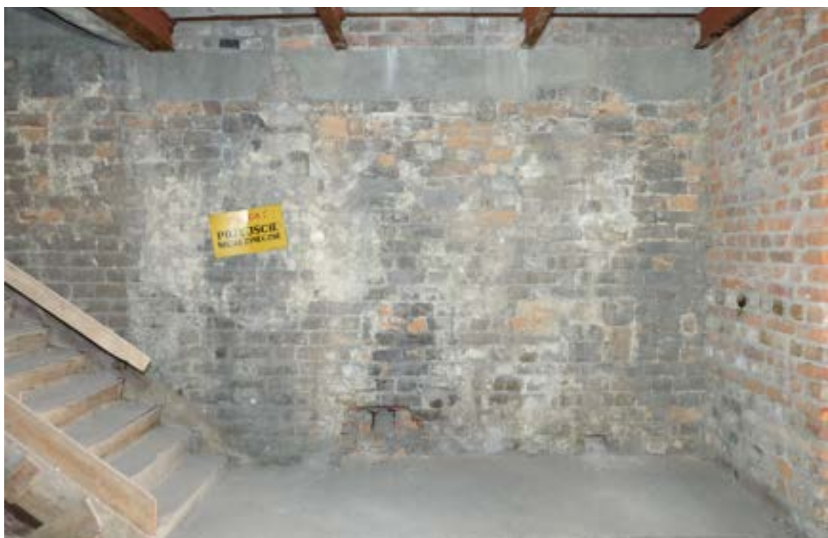
Fot. 88. Poznań, Stary Rynek 42. Piętro II, trakt środkowy, ściana południowa, widok ogólny. Widoczna niejednolita struktura muru z licznymi przemurzeniami oraz fragment ściany zachodniej oddzielającej trakt frontowy (po prawej) i fragment biegu schodów (współczesny). Fot. K. Pietrzak, maj 2023 r.
