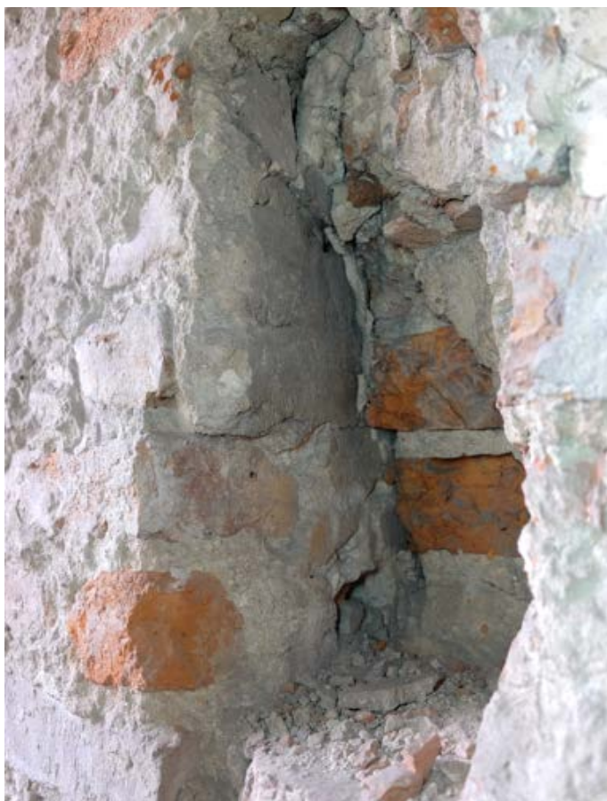
Fot. 52. Poznań, Stary Rynek 43. Piętro I, trakt frontowy, ściana północna. Widoczny fragment opracowanego (otynkowanego) lica muru w miejscu ubytku cegieł późniejszego przemurowania. Fot. K. Pietrzak, maj 2023 r.
