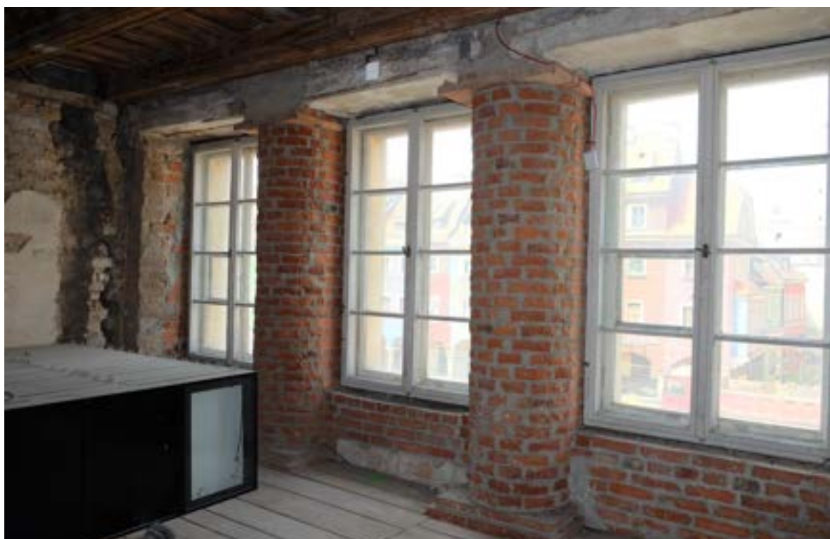
Fot. 48. Poznań, Stary Rynek 42. Piętro I, trakt frontowy, ściana zachodnia (elewacji frontowej), widok ogólny. Widoczne wtórne przemurowania i betonowe nadproża okienne. Fot. K. Pietrzak, maj 2023 r.
