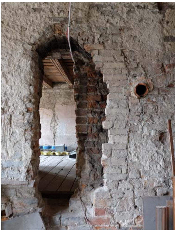
Fot. 53. Poznań, Stary Rynek 43. Piętro I, trakt frontowy, ściana północna. Wtórnie wykonane przejście między kamienicami w miejscu dawnej wnęki (widoczny łuk). Widoczne także wtórne przemurowanie (uzupełnienie) lica ściany oraz skucie muru wewnątrz otworu. Fot. K. Pietrzak, maj 2023 r.
