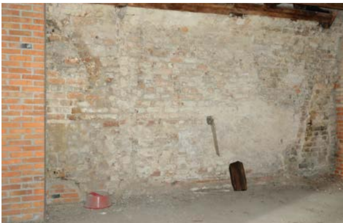
Fot. 104. Poznań, Stary Rynek 43. Piętro II, trakt środkowy, ściana północna, widok ogólny. Widoczne przemurowania (uzupełnienia ściany) oraz dostawione współczesne kominy na dwóch końcach ściany (przy ścianie zachodniej i wschodniej traktu środkowego). Fot. K. Pietrzak, maj 2023 r.
