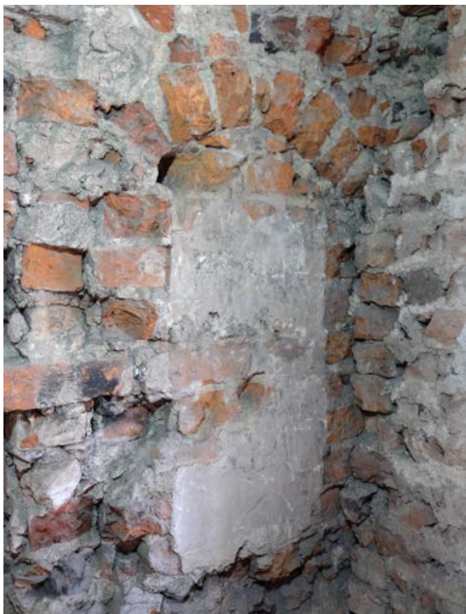
Fot. 43. Poznań, Stary Rynek 42. Piętro I, trakt frontowy, ściana południowa. Odsłonięta pierwotna wnęka z zachowanymi fragmentarycznie tynkami. Widoczne także skucie lica muru oraz przesłonięcie pierwotnego zakończenia łuku wnęki przez później dostawioną ścianę wewnętrzną. Fot. K. Pietrzak, maj 2023 r.
