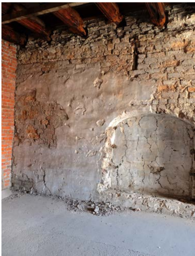
Fot. 98. Poznań, Stary Rynek 43. Piętro II, trakt frontowy, ściana południowa. Widoczne zachowane tynki z polichromiami (przesłonięte i zabezpieczone bibułą japońską) wnętrza oraz belki stropu drewnianego nad pomieszczeniem. Fot. K. Pietrzak, maj 2023 r.
