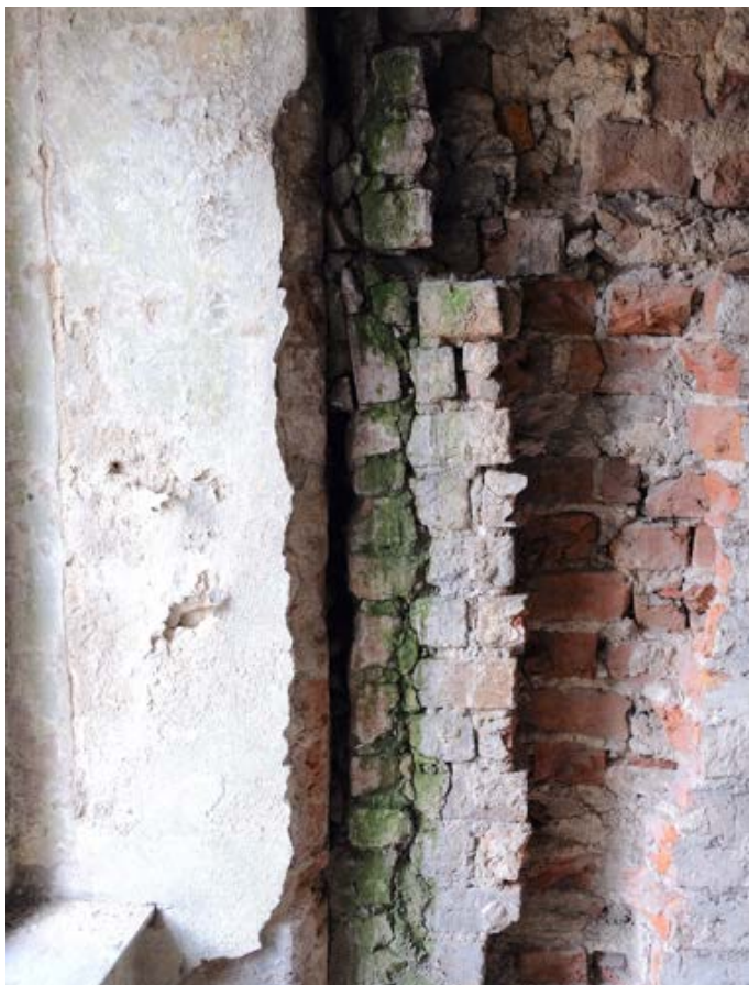
Fot. 65. Poznań, Stary Rynek 42. Piętro II, trakt frontowy, ściana północna. Zamurowanie (uzupełnienie) ściany w sąsiedztwie otworu okiennego. Widoczne dostawienie ściany zachodniej (elewacji frontowej) do ściany północnej (sąsiedzkiej) oraz porażenie biologiczne cegieł i spoiny spowodowane zaciekaniami wody opadowej z nieszczelnego dachu. Fot. K. Pietrzak, maj 2023 r.
