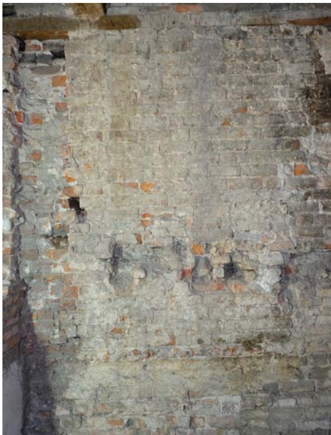
Fot. 17. Poznań, Stary Rynek 42. Piętro I, trakt środkowy, ściana północna. Widoczny wątek wendyjski fragment skutego gzymsu oraz gniazda po belkach. Fot. K. Pietrzak, maj 2023 r.
