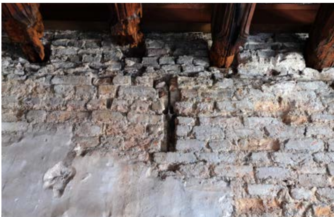
Fot. 100. Poznań, Stary Rynek 43. Piętro II, trakt frontowy, ściana południowa. Widoczne zachowane tynki z polichromiami (przesłonięte i zabezpieczone bibułą japońską), drewniane, profilowane belki stropu nad pomieszczeniem oraz zakończenie metalowej kotwy ściągającej konstrukcyjnie mury sąsiednich kamienic (nr 43 i 44). Fot. K. Pietrzak, maj 2023 r.
