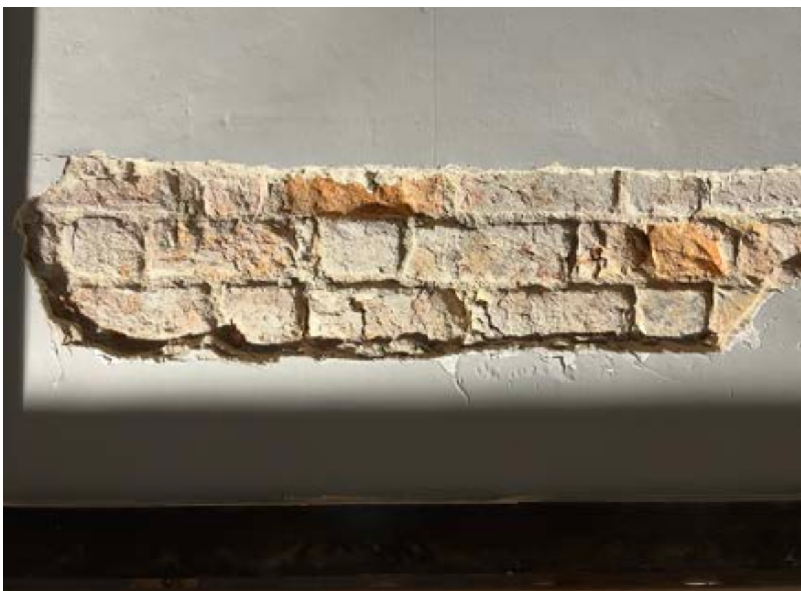
Fot. 8. Poznań, Stary Rynek 42. Parter, trakt frontowy, ściana południowa (sąsiedzka). Odkrywka lica muru we wnęce. Widoczny wątek wendyjski muru. Fot. B. Pietrzak, listopad 2022 r.
