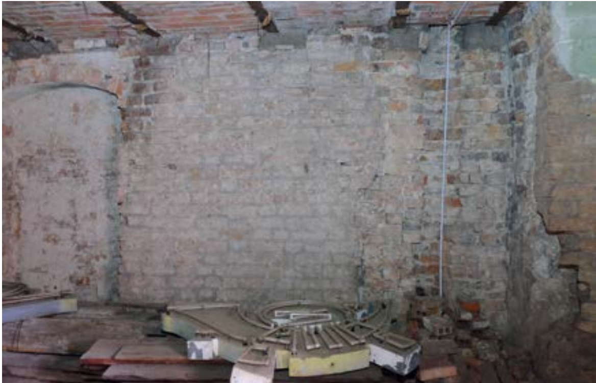
Fot. 71. Poznań, Stary Rynek 42. Piętro II, trakt tylny, ściana północna, widok ogólny. Widoczne przemurowania (uzupełnienia) ściany w północno-wschodnim narożniku budynku i pomieszczenia (z prawej strony fotografii). Fot. K. Pietrzak, maj 2023 r.
