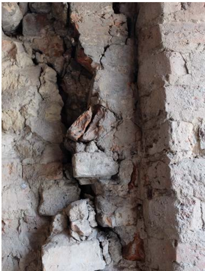
Fot. 47. Poznań, Stary Rynek 42. Piętro I, trakt frontowy, ściana południowa na styku ze ścianą zachodnią (narożnik przy oknie). Widoczne przemurowania (uzupełnienia) ściany w narożniku i fragment pierwotnego łuku. Fot. K. Pietrzak, maj 2023 r.
