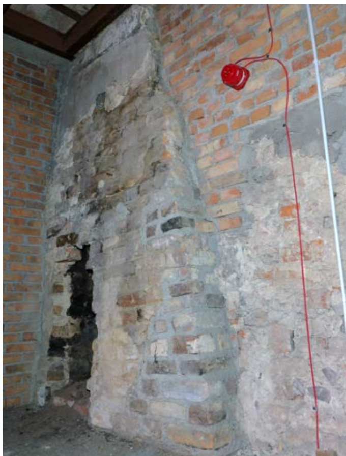
Fot. 69. Poznań, Stary Rynek 42. Piętro II, trakt środkowy, ściana wschodnia. Widoczny dawny komin z zabrudzeniami sadzowymi oraz fragment współczesnego dostawionego komina (z lewej strony). Fot. K. Pietrzak, maj 2023 r.
