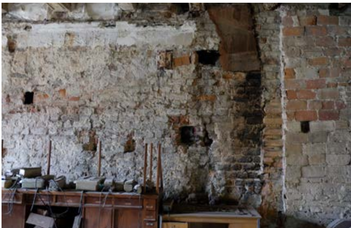
Fot. 55. Poznań, Stary Rynek 43. Piętro I, trakt frontowy, ściana północna, widok ogólny. Widoczne strzępia rozebranej ściany dzielącej trakt frontowy i środkowy. Fot. K. Pietrzak, maj 2023 r.
