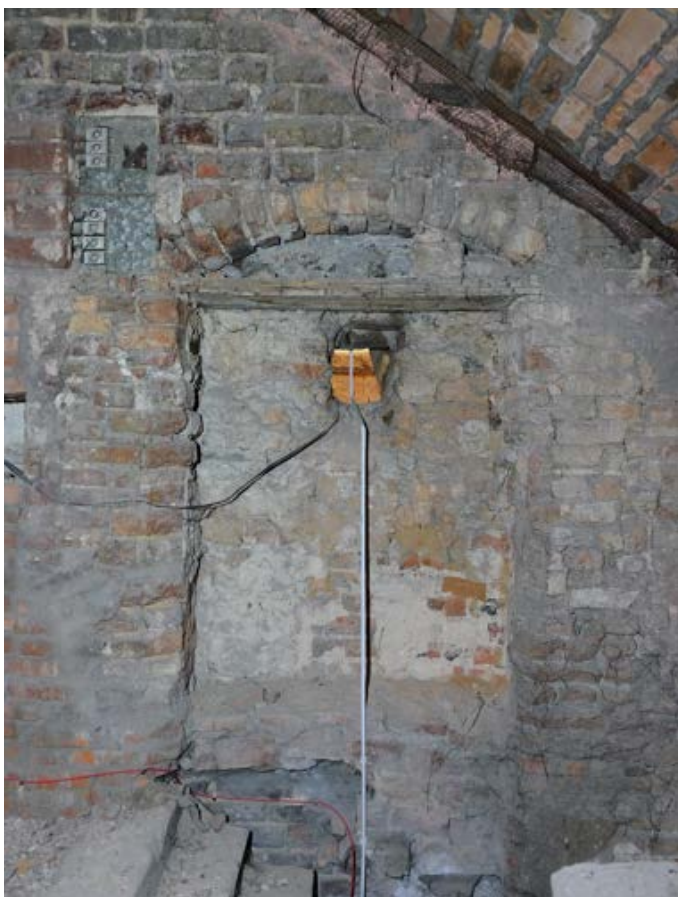
Fot. 33. Poznań, Stary Rynek 42. Piętro I, trakt środkowy, ściana południowa. Wtórna wnęka i przemurowania ściany na poziomie podestu schodów pomiędzy traktem frontowym i tylnym. Fot. K. Pietrzak, maj 2023 r.
