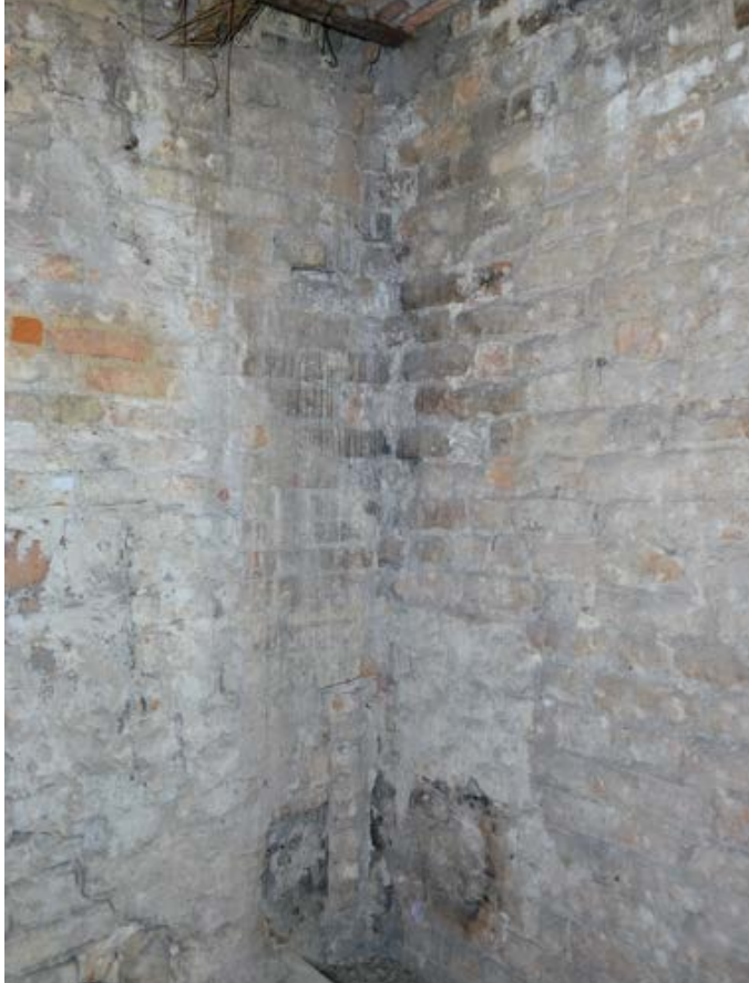
Fot. 72. Poznań, Stary Rynek 42. Piętro II, trakt tylny, północno-zachodni narożnik pomieszczenia (przy ścianie oddzielającej trakt środkowy). Widoczna niejednolita struktura muru z uzupełnieniami. Fot. K. Pietrzak, maj 2023 r.
