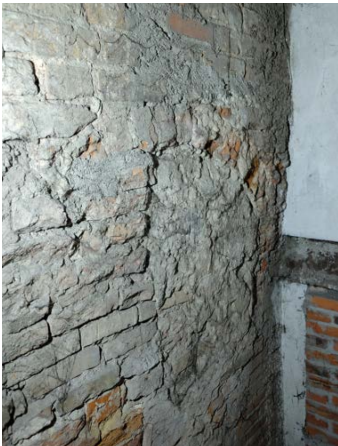
Fot. 35. Poznań, Stary Rynek 42. Piętro I, trakt środkowy, ściana południowa, zejście na parter budynku. Widoczne wtórne przemurowania i pierwotny łuk konstrukcyjny ściany lub dawnej wnęki. Fot. K. Pietrzak, maj 2023 r.
