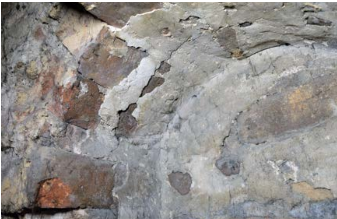
Fot. 38. Poznań, Stary Rynek 42. Piętro I, trakt środkowy, ściana południowa. Fragmenty tynku zachowane w pierwotnej wnęcie za schodami. Fot. K. Pietrzak, maj 2023 r.
