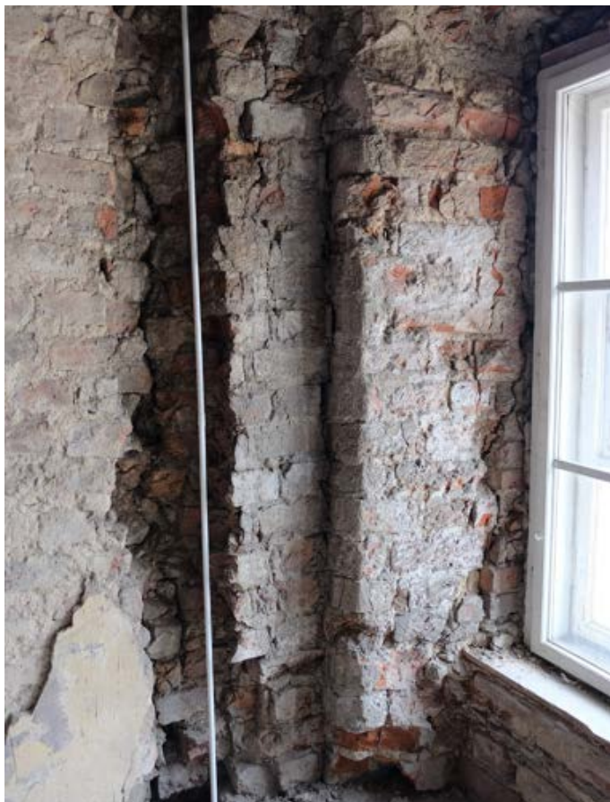
Fot. 91. Poznań, Stary Rynek 42. Piętro II, trakt środkowy, ściana południowa. Południowo-zachodni narożnik pomieszczenia, widoczne przemurowania (uzupełnienia) ściany i fragment otworu okiennego w ścianie zachodniej. Fot. K. Pietrzak, maj 2023 r.
