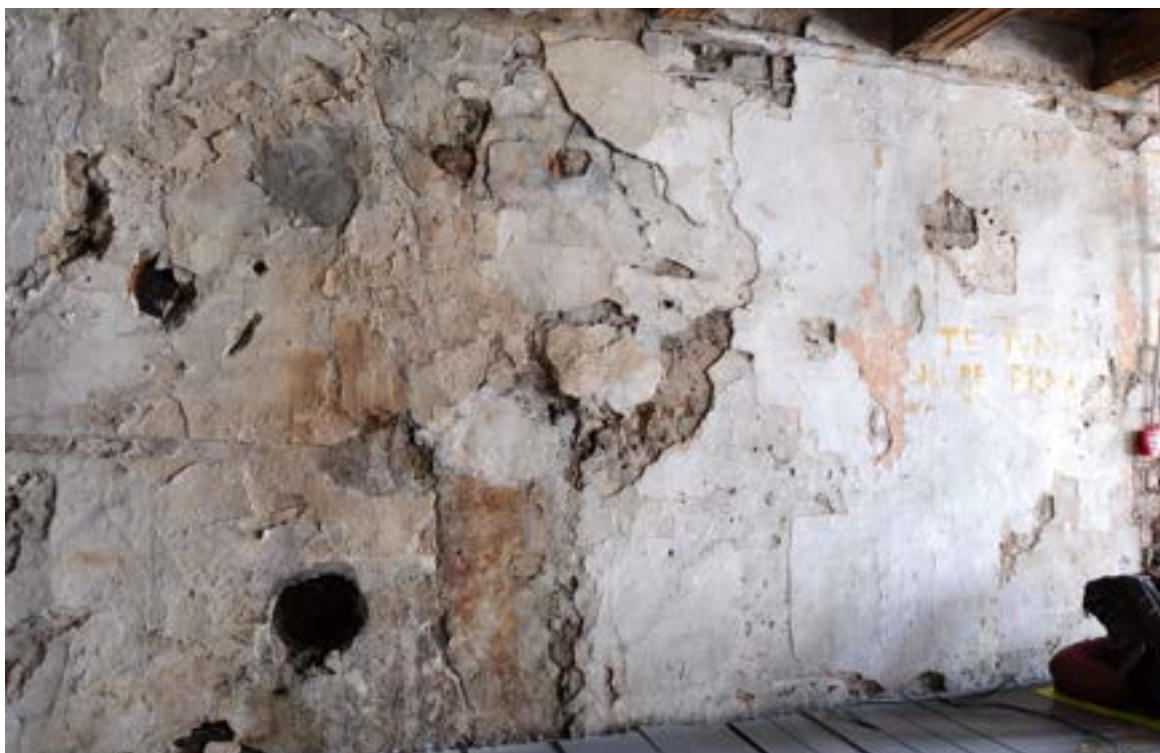
Fot. 41. Poznań, Stary Rynek 42. Piętro I, trakt frontowy, ściana południowa. Widoczne wtórne otwory w ścianie (przypuszczalnie pozostałości podłączenia do komina), zabrudzenia oraz ubytki istniejących tynków. Fot. K. Pietrzak, maj 2023 r.
