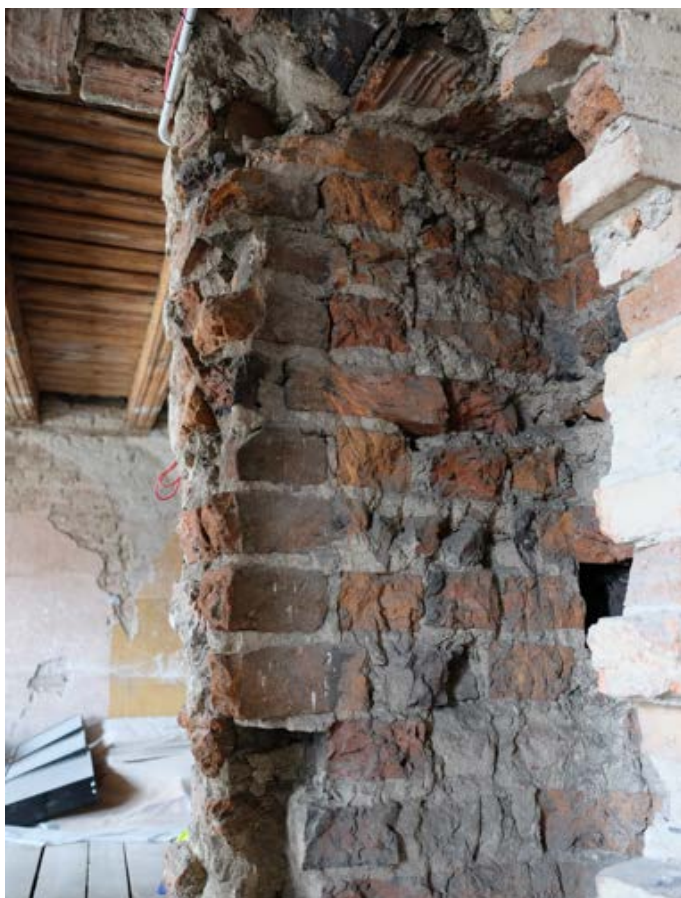
Fot. 54. Poznań, Stary Rynek 43. Piętro I, trakt frontowy, ściana północna. Wnętrze wtórnie wykonanego przejście między kamienicami w miejscu dawnej wnęki. Widoczne czyste lico cegieł dawnej wnęki oraz skucie muru stanowiące obecnie wnętrze otworu przejścia. Fot. K. Pietrzak, maj 2023 r.
