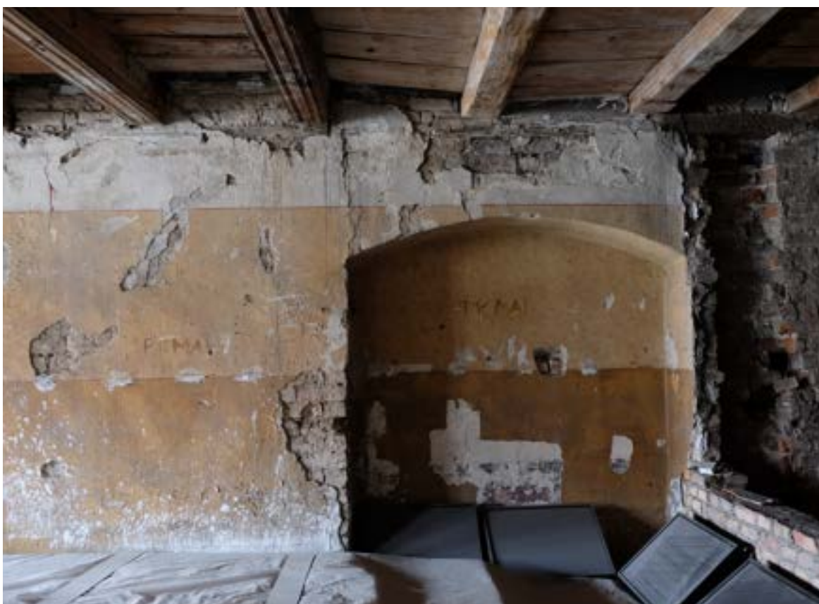
Fot. 10. Poznań, Stary Rynek 42. Piętro I, trakt frontowy, ściana północna, widok ogólny. Po prawej stronie widoczna wtórna wnęka. Fot. K. Pietrzak, maj 2023 r.
