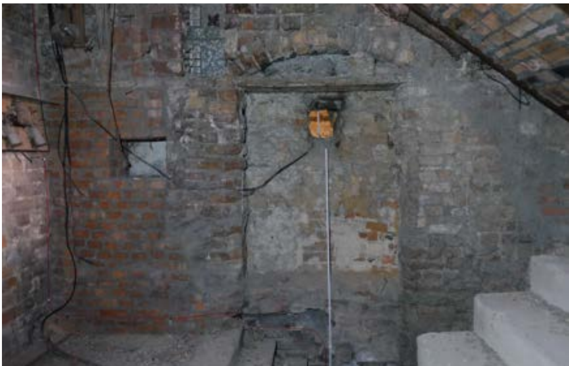
Fot. 32. Poznań, Stary Rynek 42. Piętro I, trakt środkowy, ściana południowa. Widoczna wtórna wnęka i przemurowania ściany na poziomie podestu schodów pomiędzy traktem frontowym i tylnym. Fot. K. Pietrzak, maj 2023 r.
