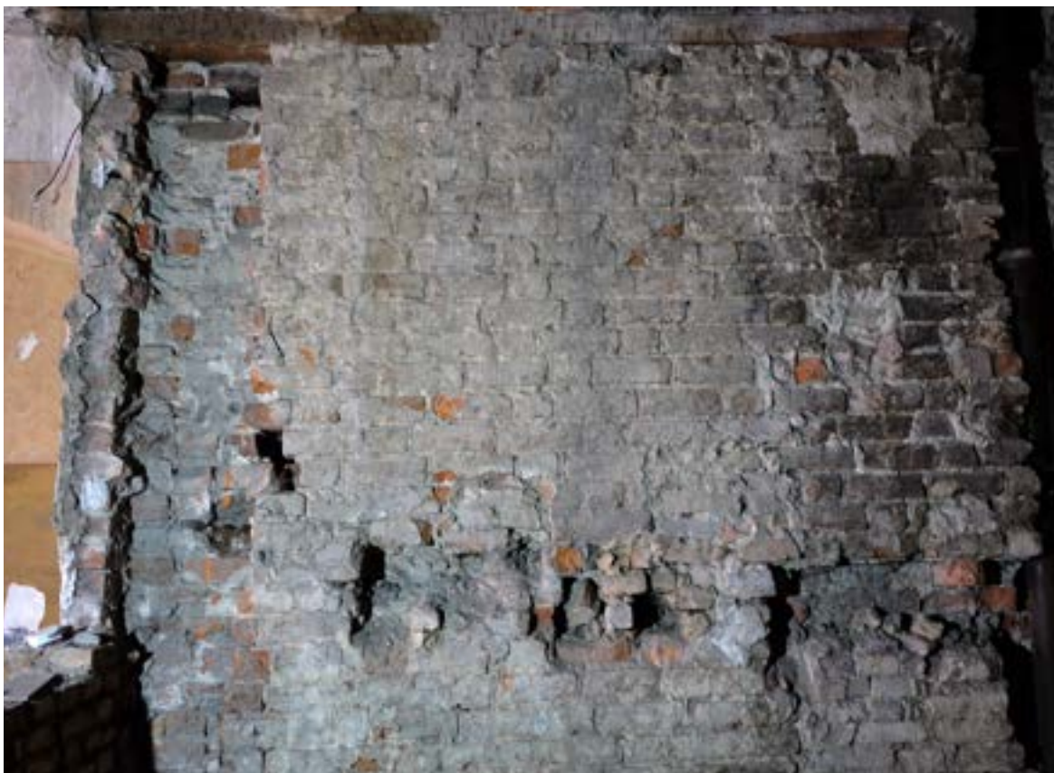
Fot. 19. Poznań, Stary Rynek 42. Piętro I, trakt środkowy, ściana północna. Widoczny wątek wendyjski i wykute gniazda pod belki. Fot. K. Pietrzak, maj 2023 r.
