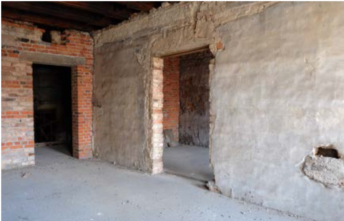
Fot. 95. Poznań, Stary Rynek 43. Piętro II, trakt frontowy, ścianka działowa pośrodku pomieszczenia, widok ogólny. Widoczne zachowane tynki z polichromiami (przesłonięte i zabezpieczone bibułą japońską) oraz fragment ściany wschodniej oddzielającej trakt środkowy. Fot. K. Pietrzak, maj 2023 r.
