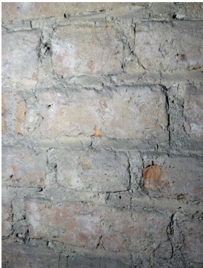
Fot. 83. Poznań, Stary Rynek 42. Piętro II, trakt tylny, ściana południowa. Widoczne lico cegieł z zatartą na gładko spoiną. Fot. K. Pietrzak, maj 2023 r.
