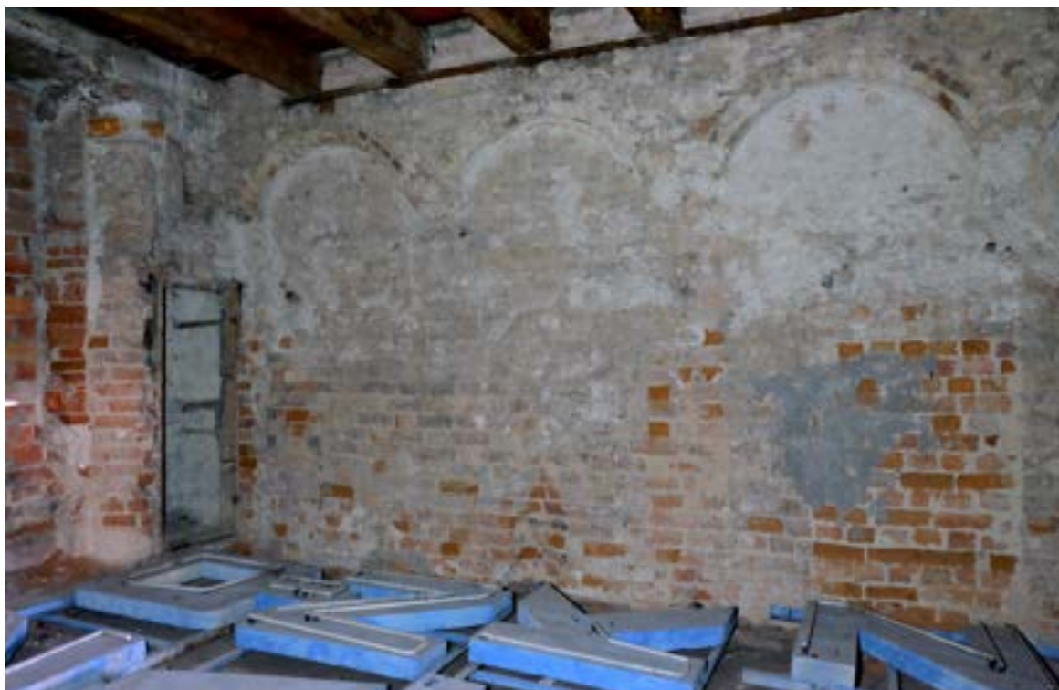
Fot. 26. Poznań, Stary Rynek 42. Piętro I, trakt tylny, ściana południowa. Widoczny fragment ściany wschodniej z drewnianym obramieniem zamurowanego otworu dawnego wyjścia na ganek. Fot. K. Pietrzak, maj 2023 r.
