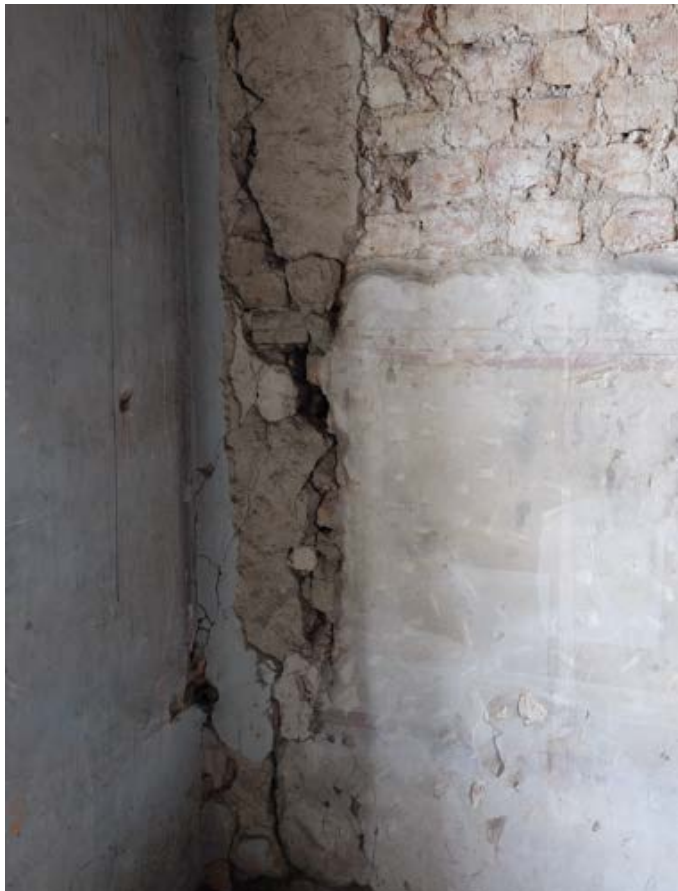
Fot. 102. Poznań, Stary Rynek 43. Piętro II, trakt frontowy, narożnik przy ścianie działowej (zbliżenie fragmentu widocznego na zdjęciu nr 101). Widoczne zachowane tynki z polichromiami (przesłonięte i zabezpieczone bibułą japońską) oraz fragment ściany zachodniej (elewacji frontowej). Widoczne także pęknięcie w miejscu dostawienia elewacji frontowej do powstałej prawdopodobnie wcześniej ścianki działowej. Fot. K. Pietrzak, maj 2023 r.
