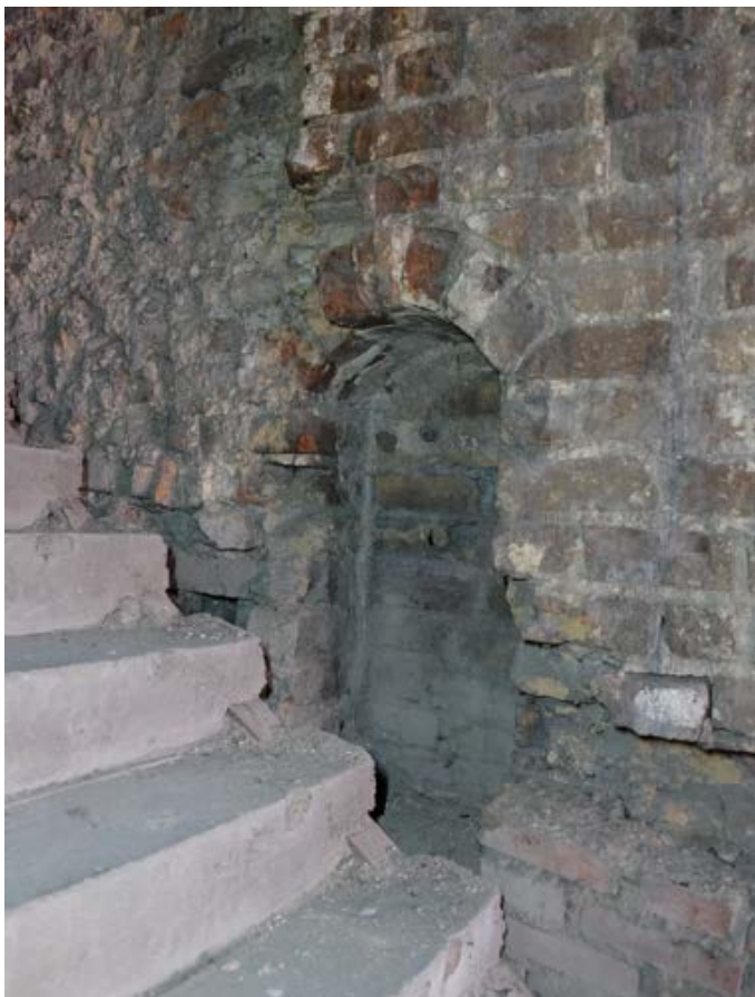
Fot. 37. Poznań, Stary Rynek 42. Piętro I, trakt środkowy, ściana południowa. Widoczny bieg schodów pomiędzy I i II piętrem, za nim pierwotna wnęka z zachowanymi śladami tynku oraz częściowo skute lico muru (ponad biegiem schodów). Fot. K. Pietrzak, maj 2023 r.
