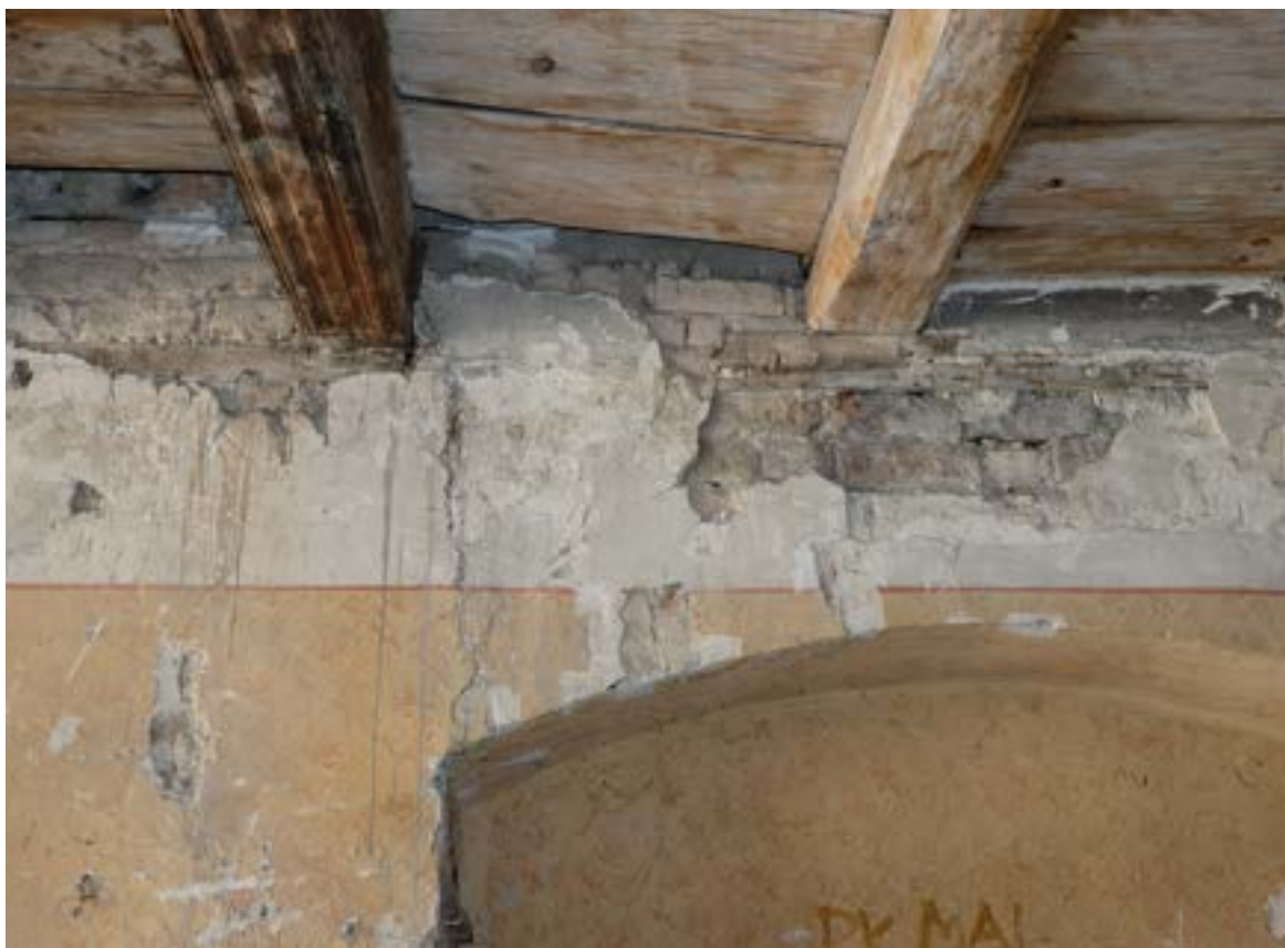
Fot. 16. Poznań, Stary Rynek 42. Piętro I, trakt frontowy, ściana północna. Widoczna górna krawędź wtórnej wnęki, powyżej przemurowania oraz zmiana wysokości stropu i opracowania belki stropowej (dawna granica pomieszczeń). Fot. K. Pietrzak, maj 2023 r.
