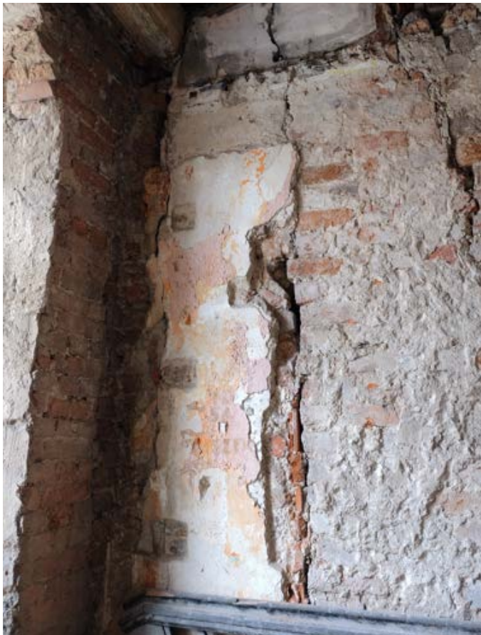
Fot. 50. Poznań, Stary Rynek 43. Piętro I, trakt frontowy, ściana północna. Widoczne przemurowania (uzupełnienia) ściany w narożniku (przy styku ze ścianą zachodnią). Fot. K. Pietrzak, maj 2023 r.
