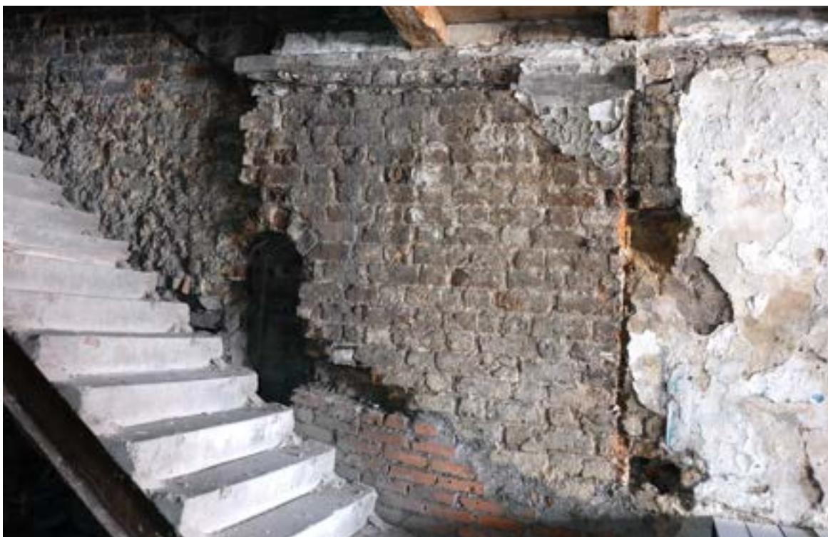
Fot. 36. Poznań, Stary Rynek 42. Piętro I, trakt środkowy, ściana południowa. Widoczny bieg schodów pomiędzy I i II piętrem, za nim pierwotna wnęka z zachowanymi śladami tynku oraz częściowo skute lico muru i wtórne przemurowanie (przypuszczalnie pod montaż wtórnego biegu schodów). Fot. K. Pietrzak, maj 2023 r.
