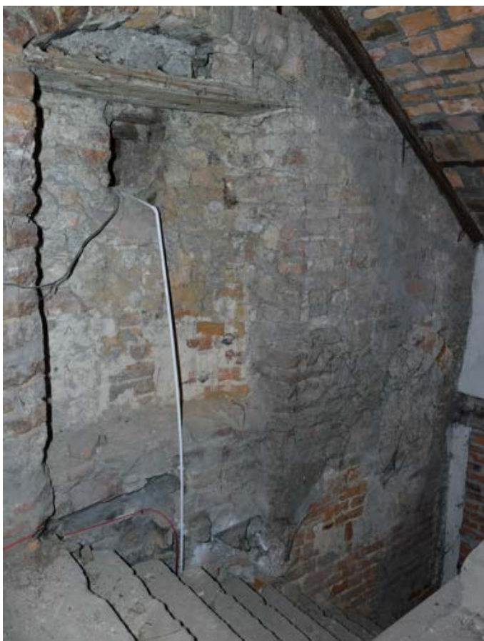
Fot. 34. Poznań, Stary Rynek 42. Piętro I, trakt środkowy, ściana południowa, zejście na parter budynku. Widoczne wtórne przemurowania. Fot. K. Pietrzak, maj 2023 r.
