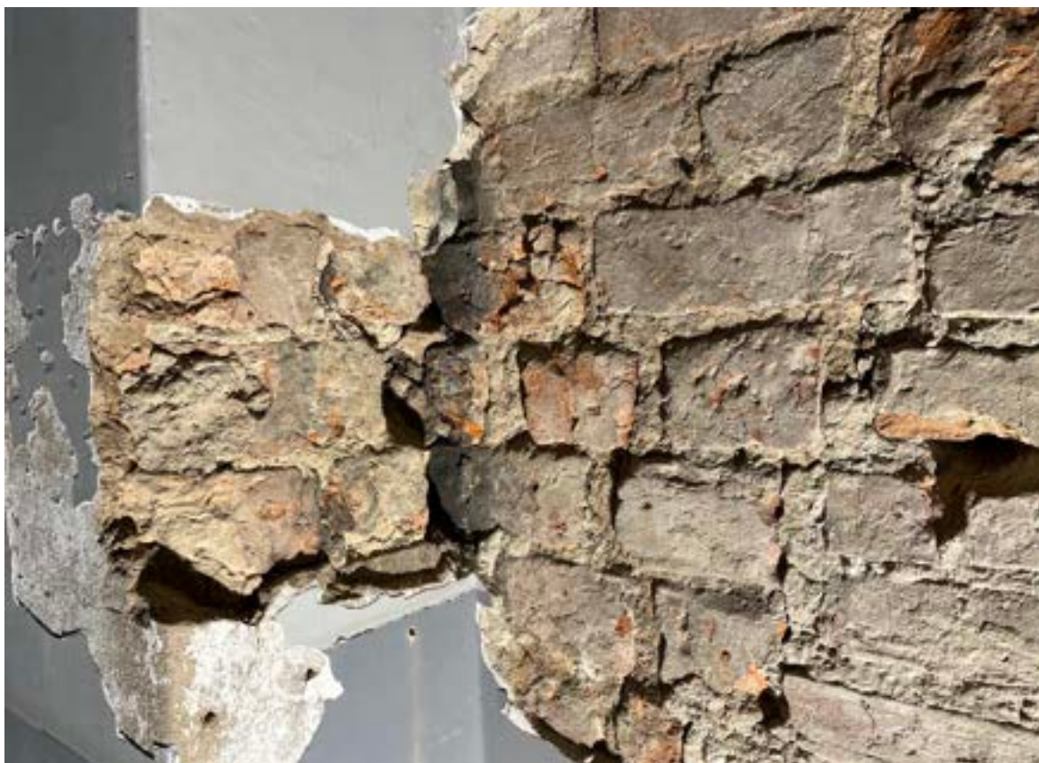
Fot. 5. Poznań, Stary Rynek 42. Parter, trakt frontowy, ściana południowa (sąsiedzka). Odkrywka lica muru we wnęce, widoczne dostawienie muru i sięgający wgląb mur pierwotny. Fot. B. Pietrzak, listopad 2022 r.
