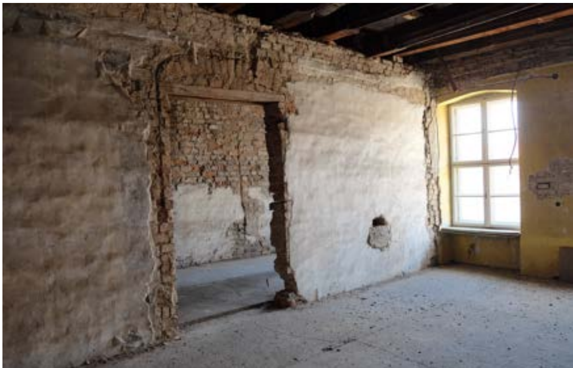
Fot. 96. Poznań, Stary Rynek 43. Piętro II, trakt frontowy, ścianka działowa pośrodku pomieszczenia, widok ogólny. Widoczne zachowane tynki z polichromiami (przesłonięte i zabezpieczone bibułą japońską) oraz fragment ściany zachodniej (elewacji frontowej). Fot. K. Pietrzak, maj 2023 r.
