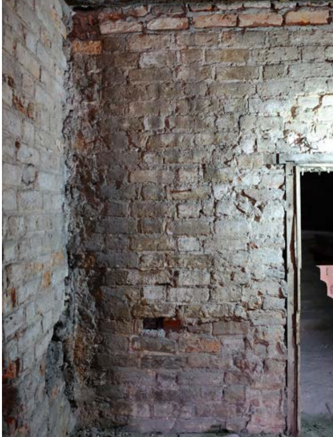
Fot. 86. Poznań, Stary Rynek 42. Piętro II, trakt tylny, ściana zachodnia (oddzielająca trakt środkowy). Widoczny fragment wtórnego otworu drzwiowego i skucie lica muru w południowo zachodnim narożniku pomieszczenia (z lewej strony fotografii). Fot. K. Pietrzak, maj 2023 r.
