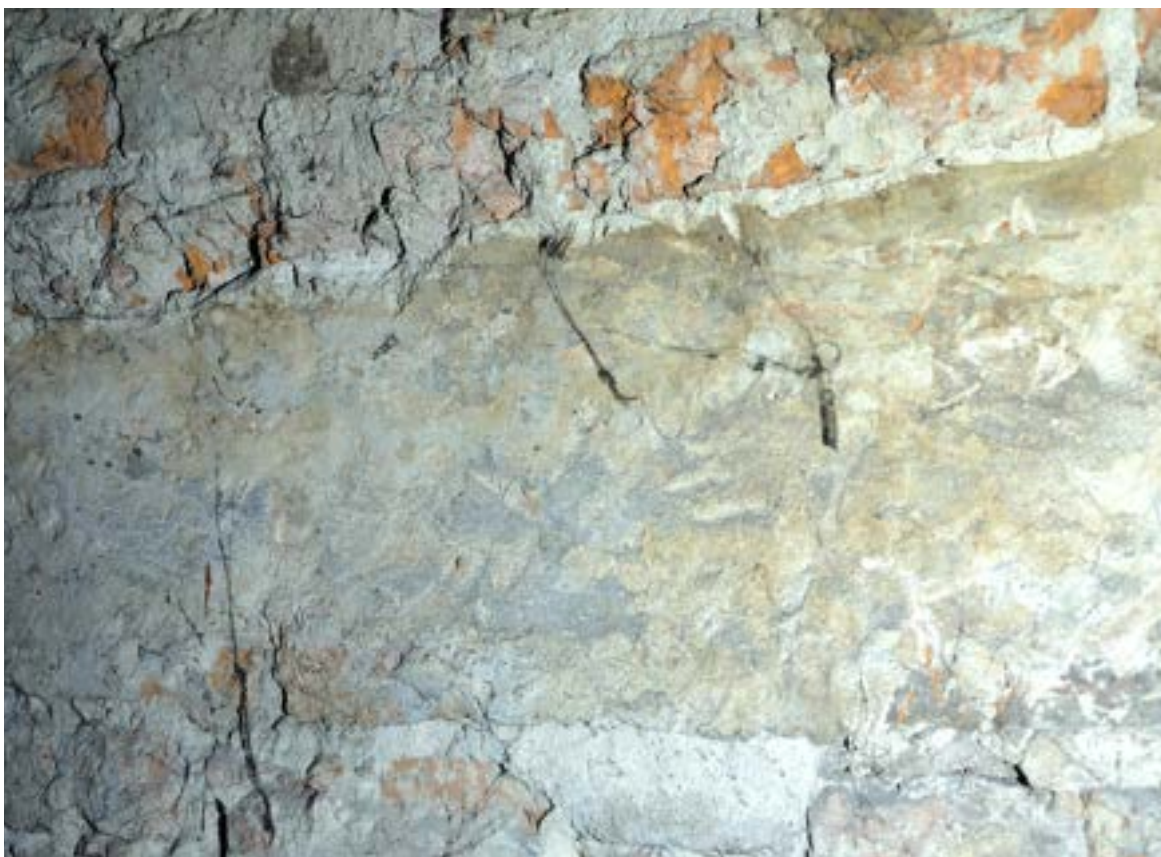
Fot. 18. Poznań, Stary Rynek 42. Piętro I, trakt środkowy, ściana północna. Widoczny fragment skutego gzymsu oraz pozostałości tynku poniżej skutych cegieł. Fot. K. Pietrzak, maj 2023 r.
