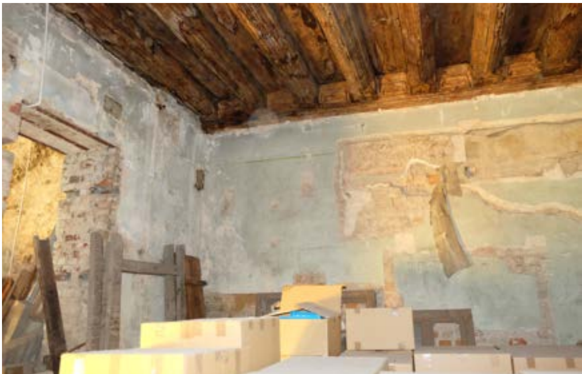
Fot. 58. Poznań, Stary Rynek 43. Piętro I, trakt tylny, ściana północna, widok ogólny. Widoczny fragment ściany zachodniej z otworem wejściowym, drewniany strop przekrywający pomieszczenie oraz zabezpieczone bibulką japońską fragmenty polichromii. Fot. K. Pietrzak, maj 2023 r.
