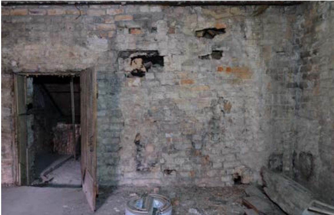
Fot. 85. Poznań, Stary Rynek 42. Piętro II, trakt tylny, ściana zachodnia (oddzielająca trakt środkowy), widok ogólny. Widoczne wtórne przemurowania (uzupełnienia ściany), otwór drzwiowy i zabrudzenia sadzowe w miejscach ubytku cegieł (jest to fragment muru komina). Fot. K. Pietrzak, maj 2023 r.
