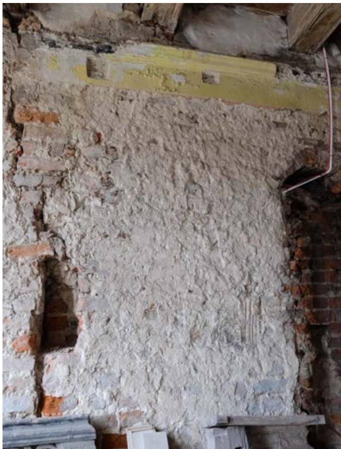
Fot. 51. Poznań, Stary Rynek 43. Piętro I, trakt frontowy, ściana północna. Widoczne przemurowania (uzupełnienia) ściany i ubytek cegieł z lewej strony fotografii oraz fragment zachowanego profilowanego gzymsu pod drewnianym stropem u góry. Fot. K. Pietrzak, maj 2023 r.
