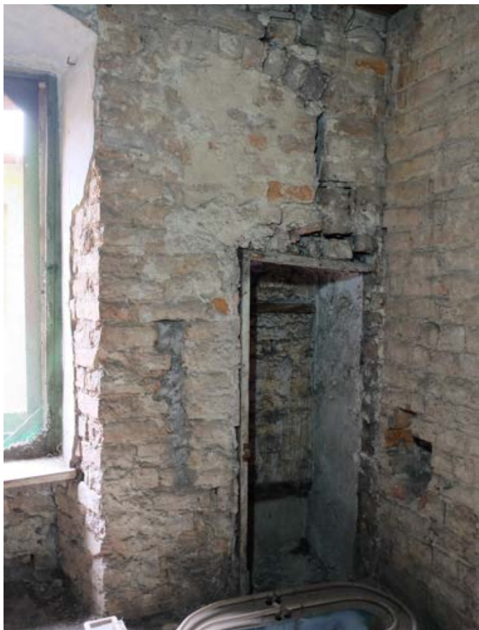
Fot. 79. Poznań, Stary Rynek 42. Piętro II, trakt tylny, ściana wschodnia. Widoczne drewniane obramienie zamurowanego otworu dawnego wyjścia na ganek w południowo wschodnim narożniku budynku (i pomieszczenia) oraz łuk dawnej wnęki powyżej.
