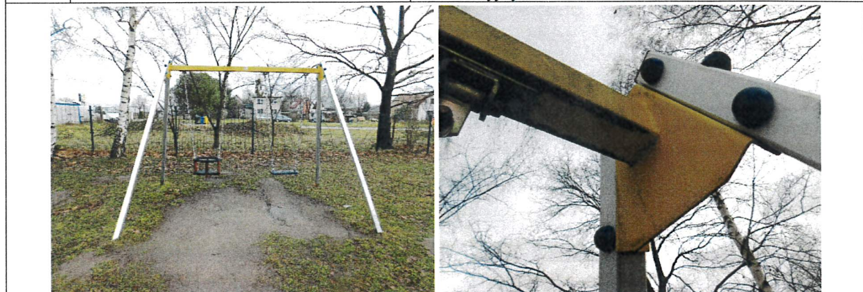
6 Huśtawka wahadłowa podwójna SH2, producent – InterFlora/ ARCADIA Należy uzupełnić brakujące/ uszkodzone zaślepki/ nakrętki. Skorodowane podkładki/ nakrętki/ śruby należy wymienić na nowe – ocynkowane. Należy dokręcić dolne śruby przy siedzisku „deska” oraz nasmarować górne zawiesia (4 sztuki). Ponadto urządzenie należy oczyścić z kurzu, piasku, pyłu, zielonych nalotów i porostów. Górną belkę należy po oczyszczeniu pomalować – kolorystyka identyczna lub zbliżona do obecnej. Pod urządzeniem należy wykonać nawierzchnię bezpieczną piaskową bez obrzeży; wymiary – 7,2m x 3,2m – zgodnie z kartą techniczną urządzenia; głębokość - 30 cm. Po wykorytowaniu należy ułożyć na podłożu geowłókninę i przypiąć ją szpilkami do podłoża, a następnie wypełnić piaskiem o wielkości ziarna od 0,2 do 2 mm z atestem do celów rekreacyjnych.
