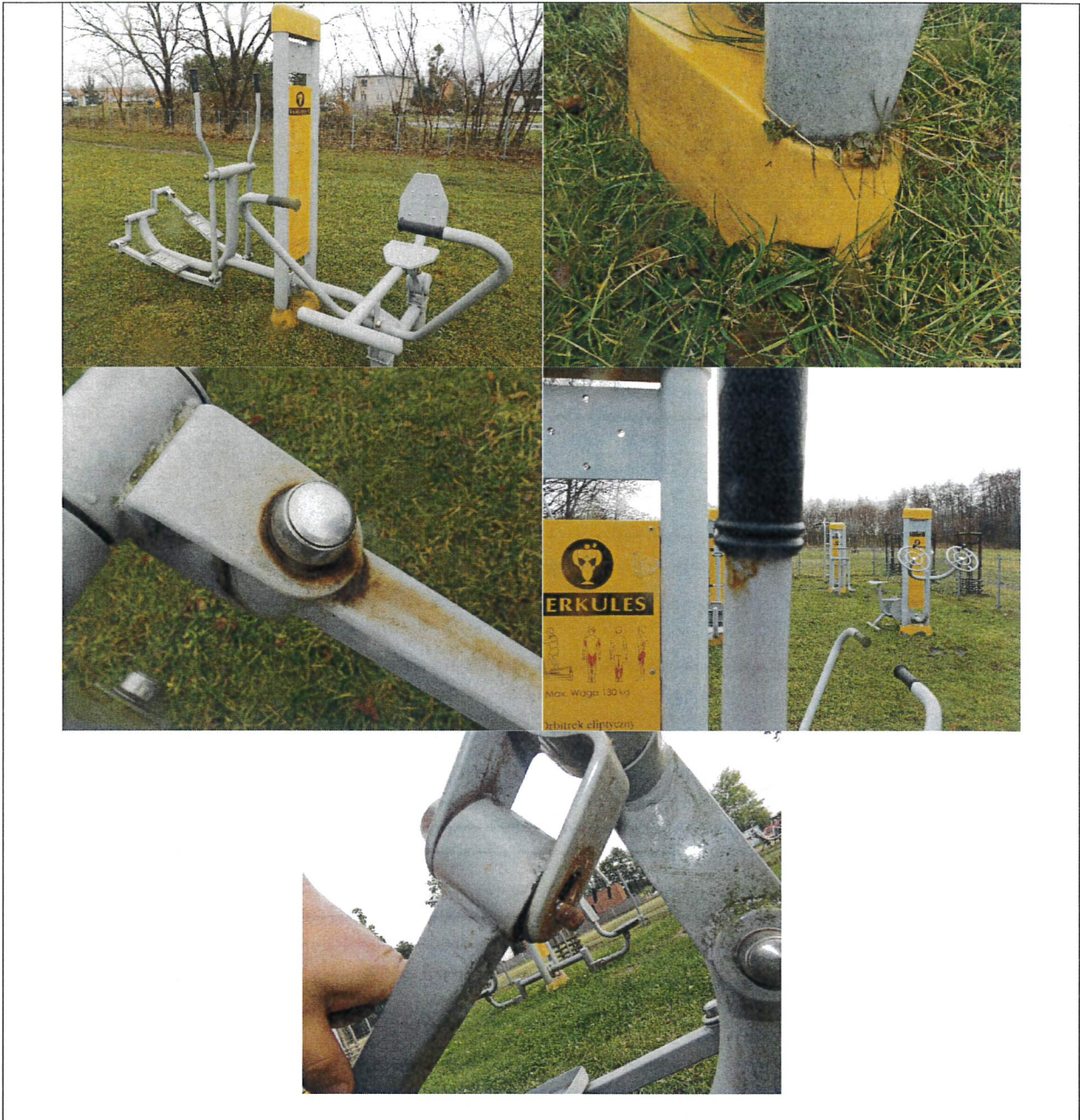
3 Biegacz + Prasa Nożna Urządzenie należy oczyścić z kurzu, piasku, pyłu, zielonych nalotów i porostów.
