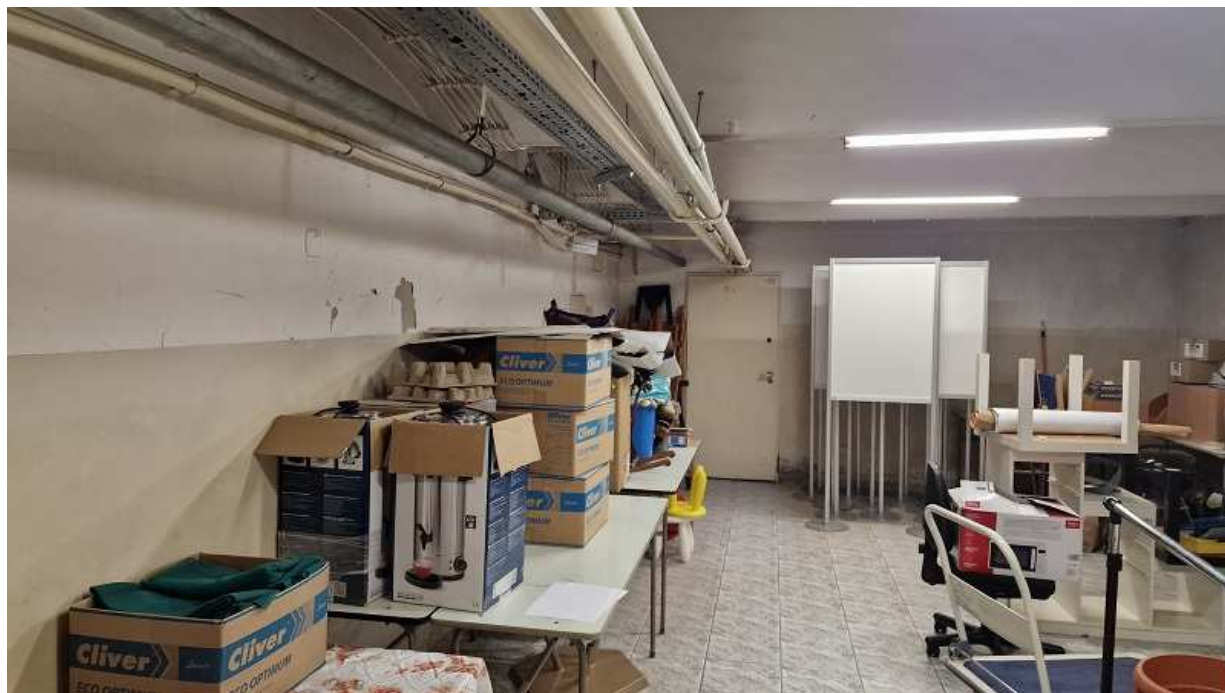
Zdjęcie – piwnica – widok na instalacje będące w kolizji z proponowaną lokalizacją szybu windowego.
