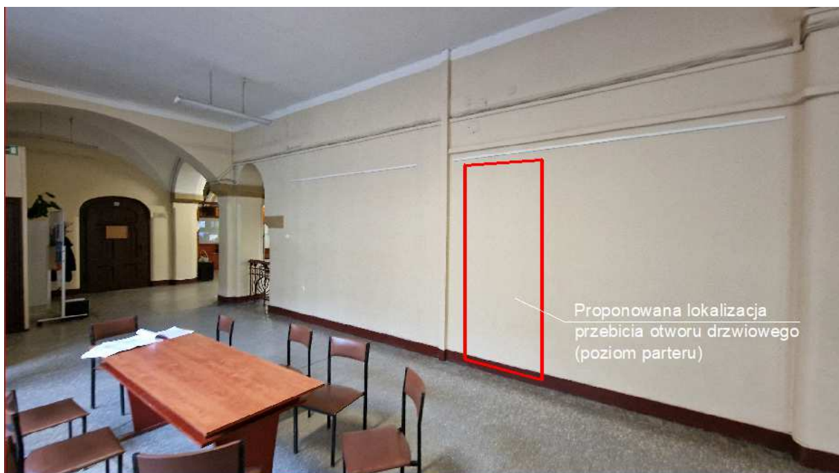
Zdjęcie – proponowana lokalizacja przebicia otworu drzwiowego – obręb proponowanego szybu windowego (korytarz – poziom parteru).
