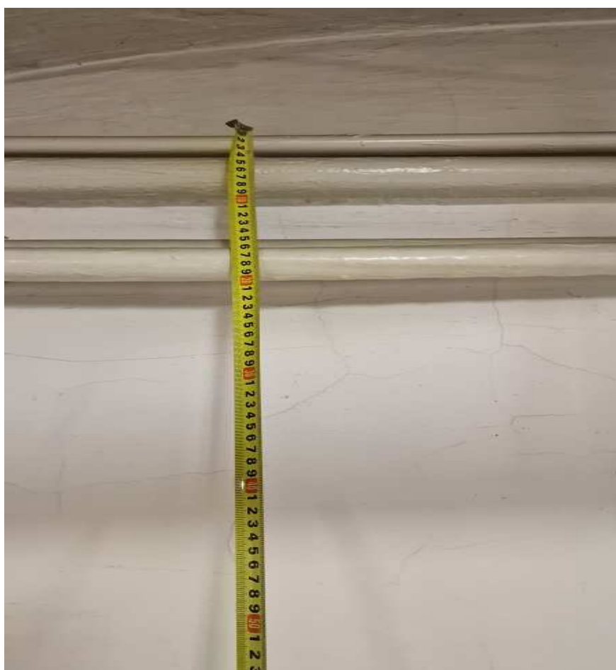
Zdjęcie – piwnica – widok na instalacje sanitarne będące w kolizji z proponowaną lokalizacją szybu windowego.
