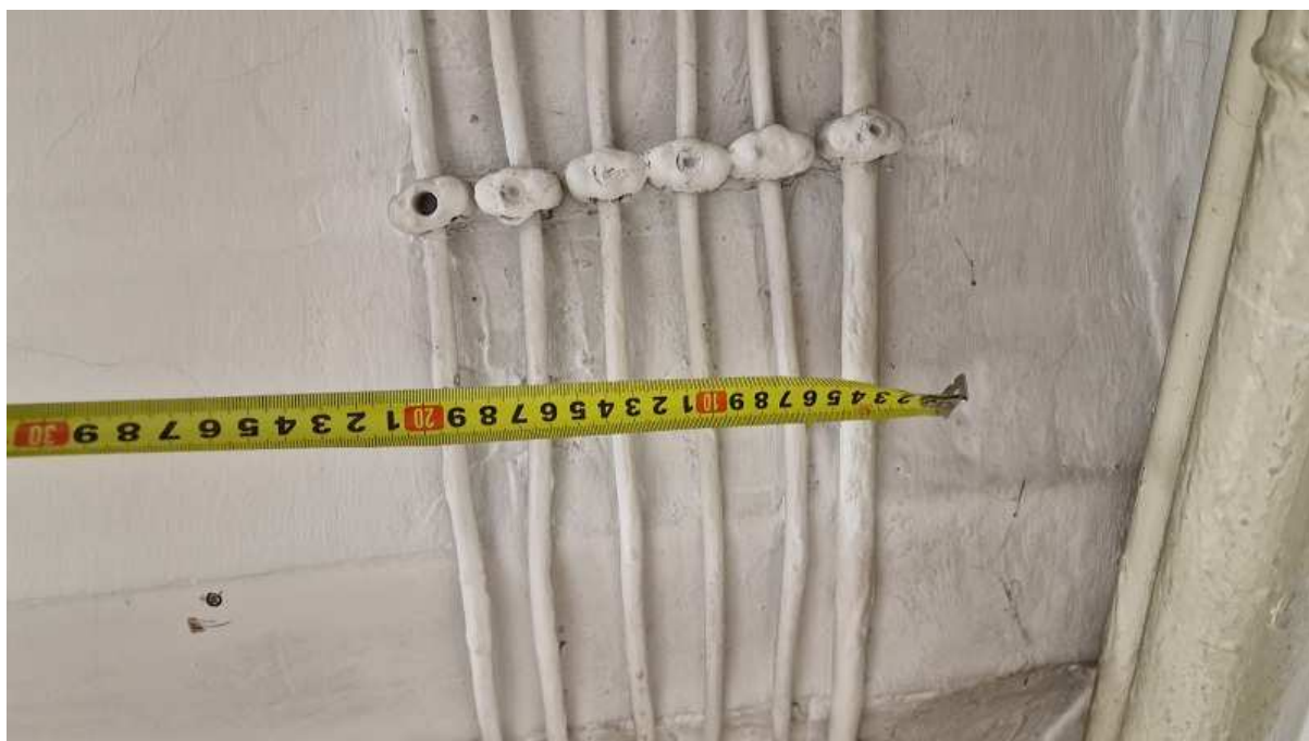
Zdjęcie – piwnica – widok na instalacje elektryczne będące w kolizji z proponowaną lokalizacją szybu windowego.
