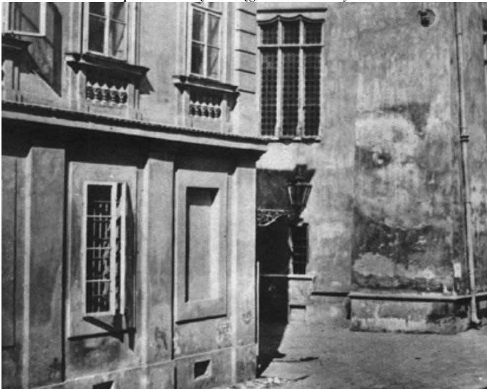
Fot. Krieger 1875. Kolegium Kollątaja, okna w sieni 1850- 1853, na zdjęciu widoczne jeszcze kwatery zewnętrzne.
