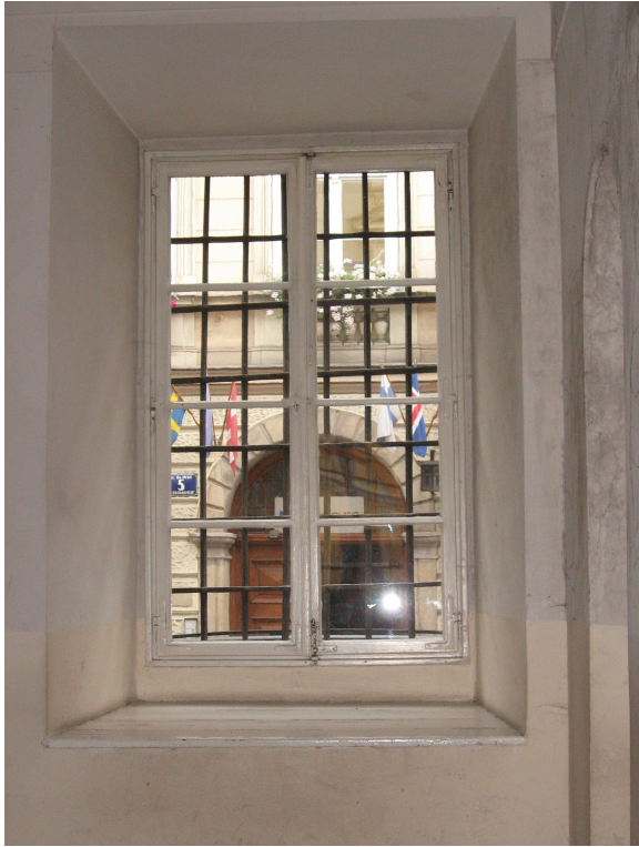
Kolegium Kollątaja, okna w sieni 1850- 1853, kwatery zewnętrzne zlikwidowane ok. 1910-13, pozostał wręb w węgarku kamiennym.
