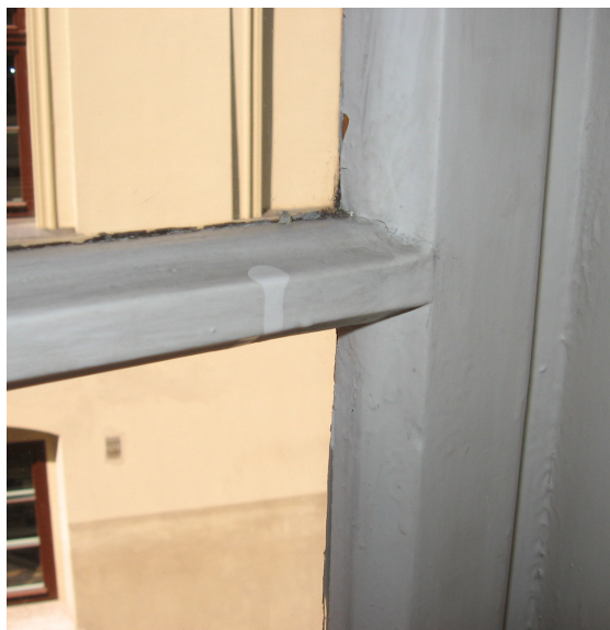
Rygiel zasuwownicy o prostokątnej formie, profile przyszybowe z okresu PRL
