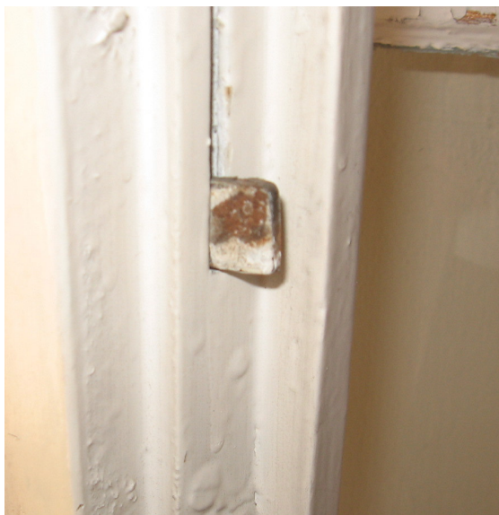
Rygiel zasuwownicy o prostokątnej formie, profile przyszybowe z okresu PRL
