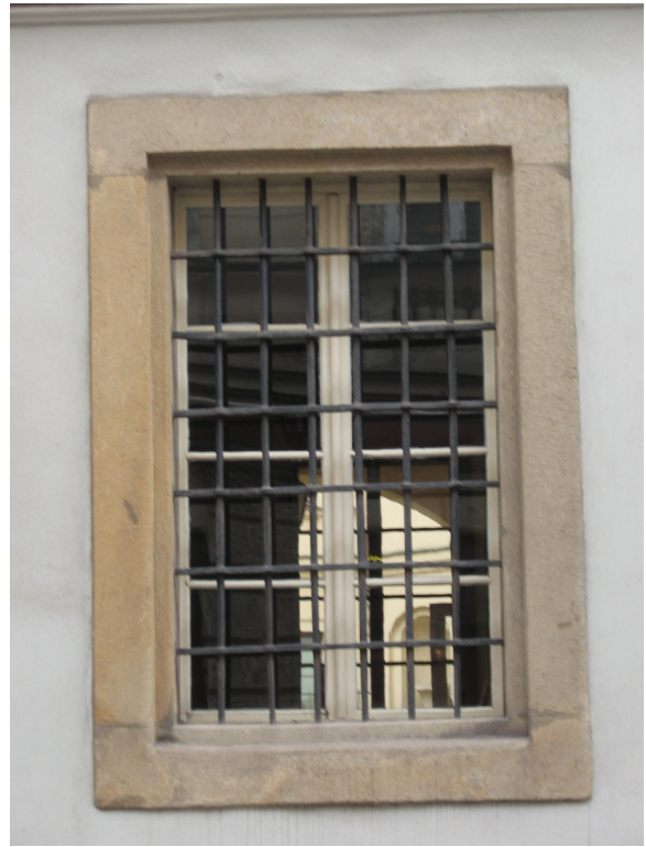
Kolegium Kollątaja, okna w sieni 1850- 1853, kwatery zewnętrzne zlikwidowane ok. 1910-13, pozostał wręb w węgarku kamiennym.
