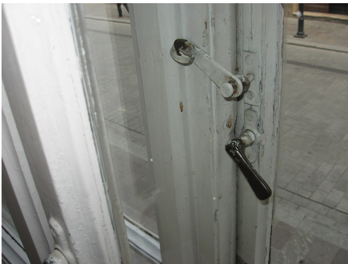
Skręcenia kwater, użyto dodatkowych zakrętek.
