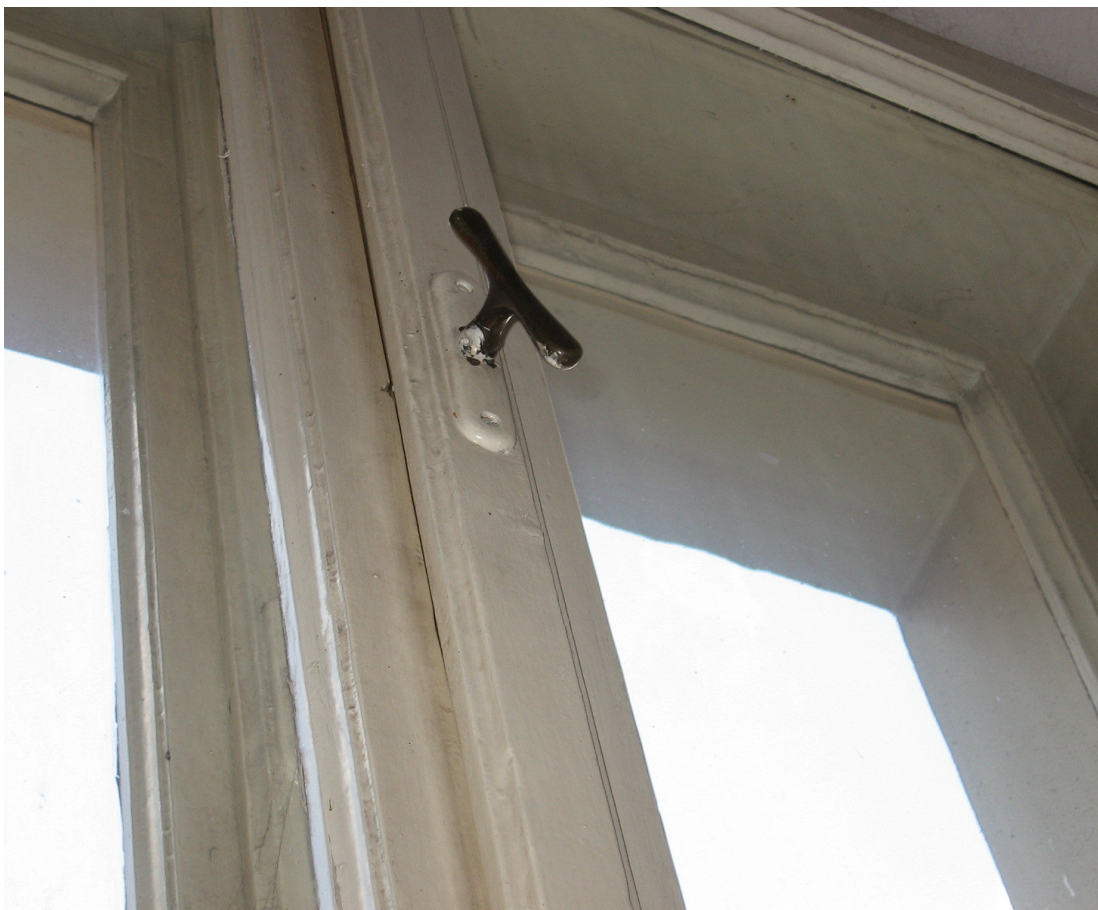
Skrecona kwatery, nieszczelności na przylgach
