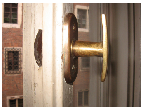
Okapnik drewniany, klamka nieoryginalna, rygiel zasuwniczy oryginalny
