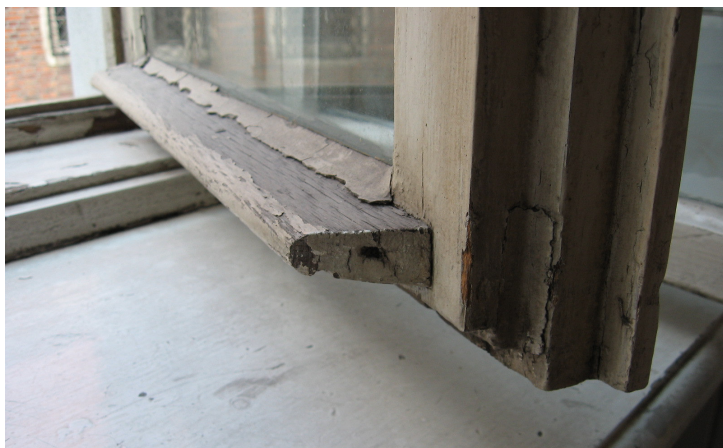
Okapnik drewniany, klamka nieoryginalna, rygiel zasuwniczy oryginalny
