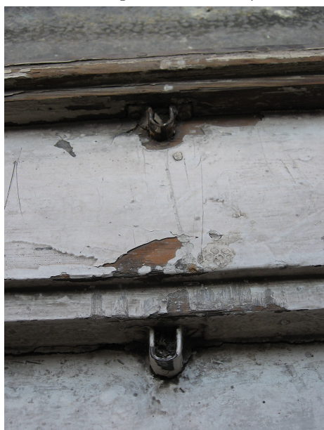
Okapnik drewniany, klamka nieoryginalna, rygiel zasuwniczy oryginalny
