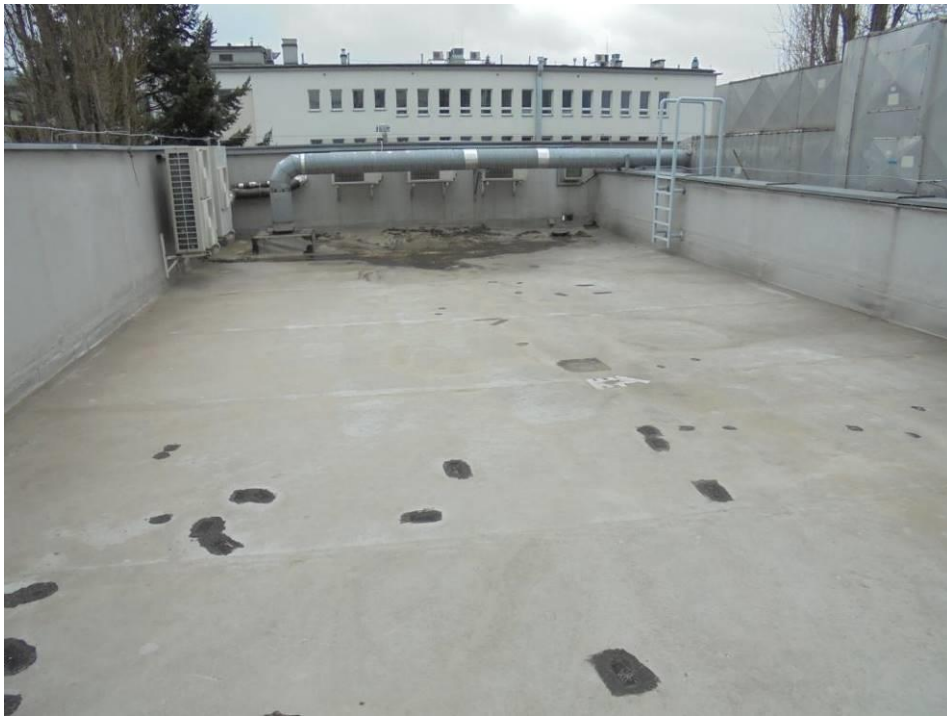
Foto 2. Widok ogólny fragmentu dachu objętego badaniem szczelności.
