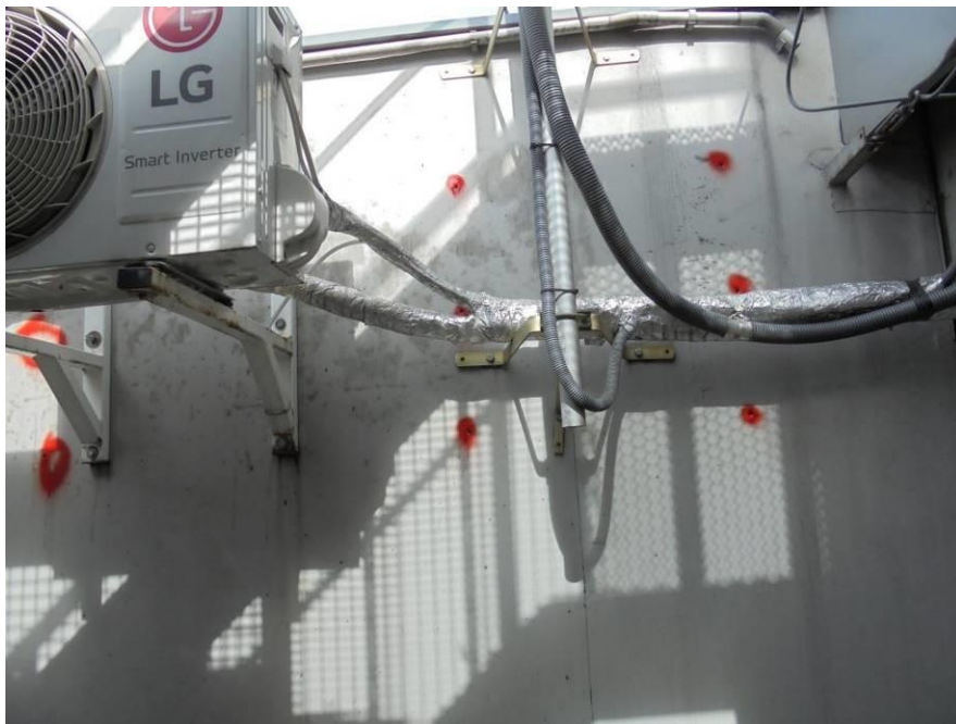
Foto 48. Liczne nieuszczelnione otwory w izolacji wodochronnej na ścianie pionowej– patrz zbliżenie na foto poniżej.
