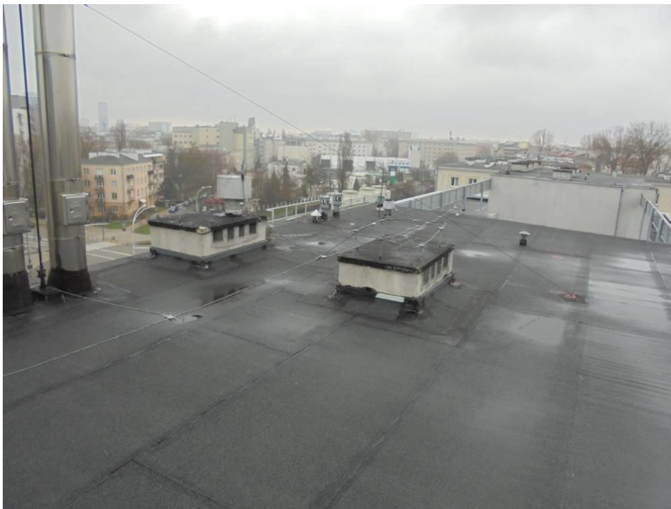
Foto 102. Widok ogólny przebadanego fragmentu dachu.
