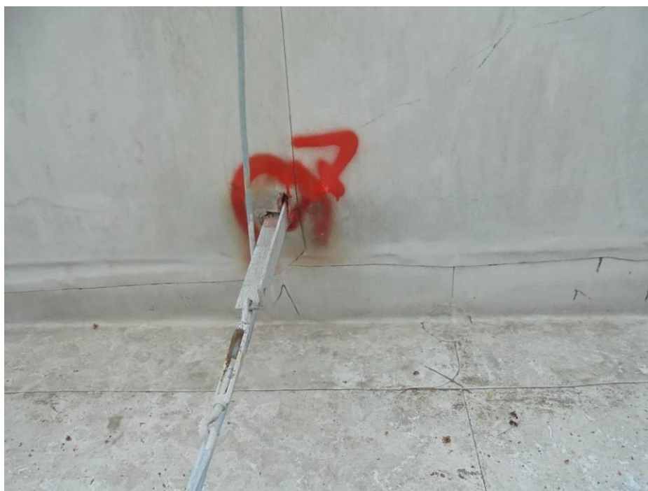
Foto 15. Nieszczelność nr 7 – brak prawidłowego połączenia izolacji wodochronnej na attyce ze stalową konstrukcją przebijającą membranę.
