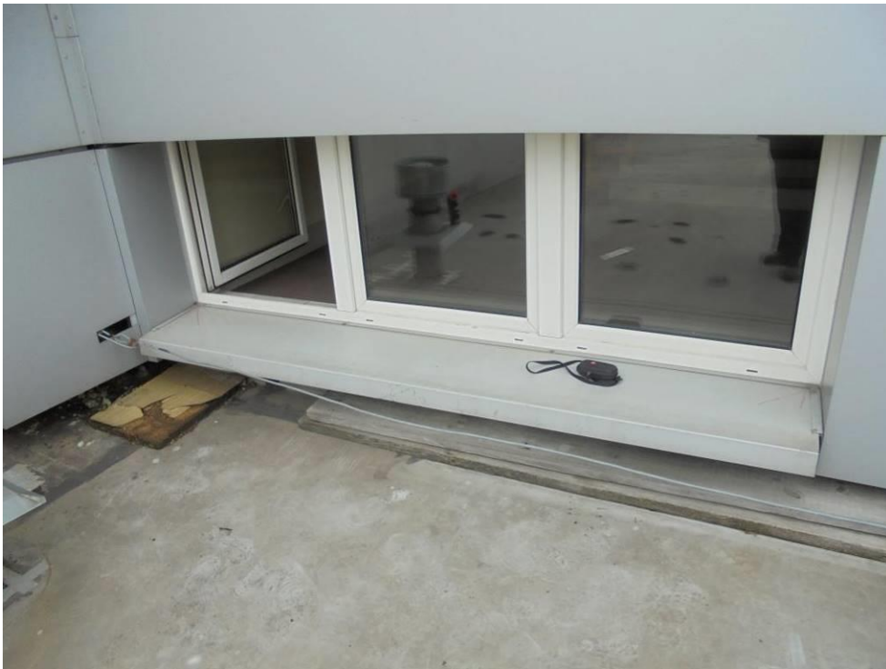
Foto 4. Widok ogólny styku połaci dachu ze ścianą budynku przy oknie – patrz również foto poniżej.
