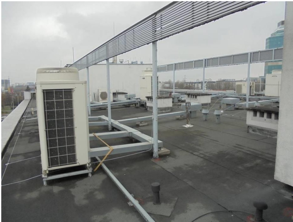
Foto 90. Widok ogólny przebadanego fragmentu dachu.
