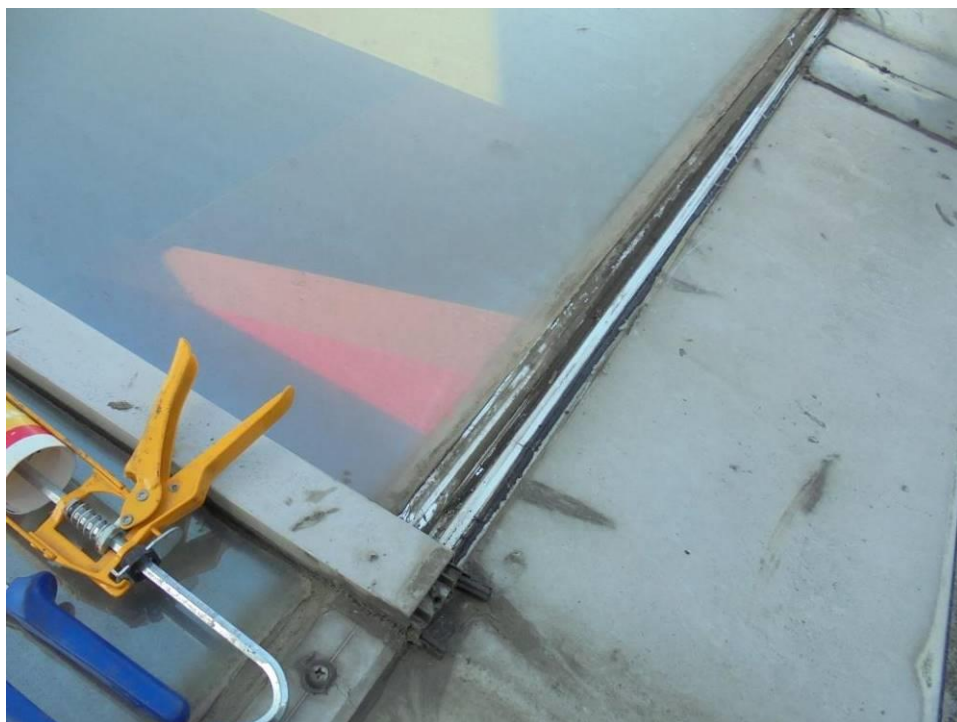
Foto 56. Zdemontowana listwa maskująca na profilu poprzecznym świetlika.
