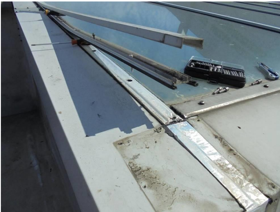
Foto 61. Odkrywka mająca na celu sprawdzenie poprawności wykonania profili podłużnych świetlika.
