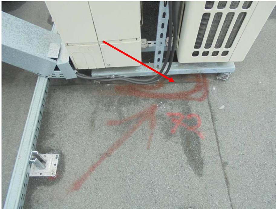
Foto 98. Nieszczelność nr 72 – rozszczelnienie styku pomiędzy sąsiednimi arkuszami papy.
