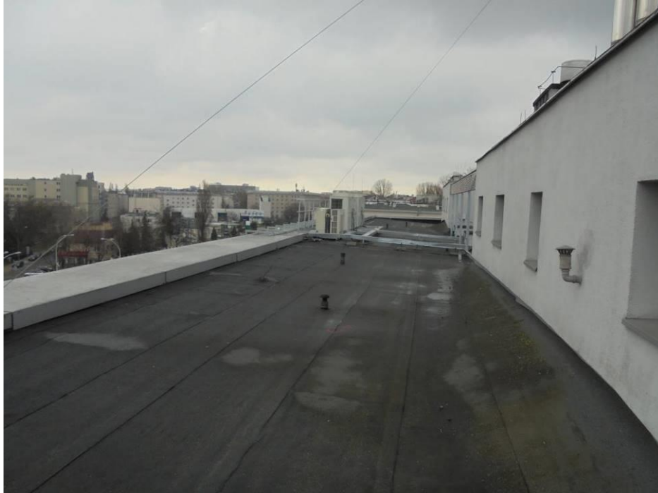
Foto 63. Widok ogólny fragmentu dachu objętego badaniem szczelności.
