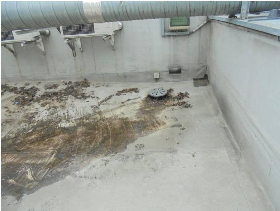
Foto 1. Widok ogólny fragmentu dachu objętego badaniem szczelności.
