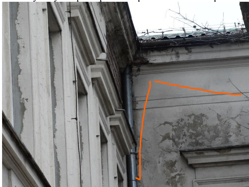
Foto 39 Ubytek tynku na gzymsie do przecierania nad oknami
