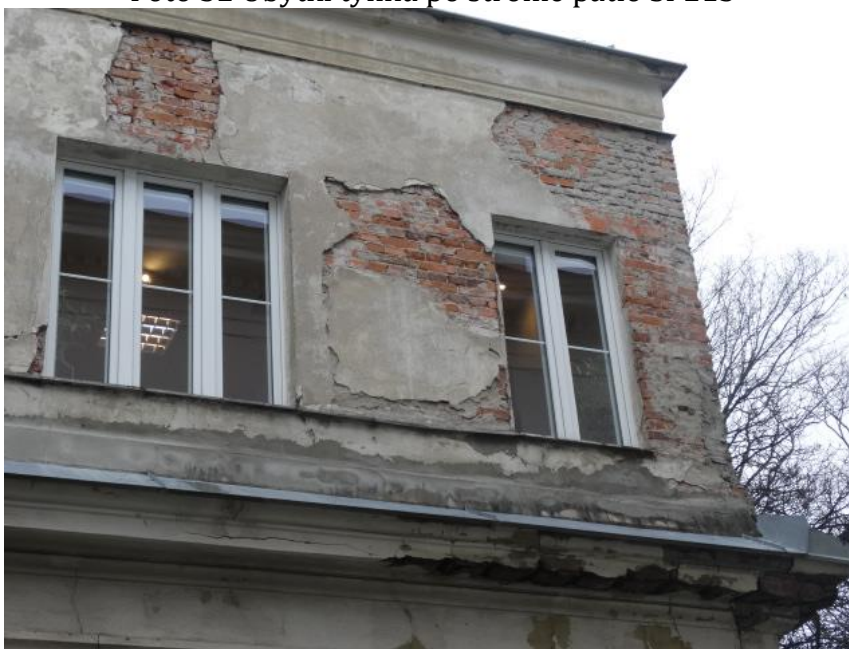
Foto 33 Ubytki tynku na gzymsie po stronie SP213 patio
