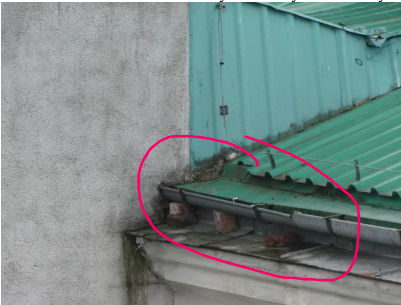
Foto nr 36 Obróbki blacharskie wymiana cały obwód budynku
