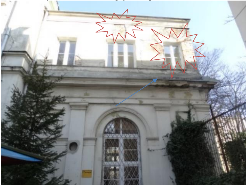
Foto nr 2 Patio SP 213 strona zachodnia ubytki tynku
