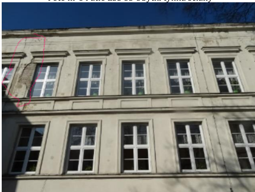
Foto nr 6 Patio ZSS 85 Ubytki tynku ściany
