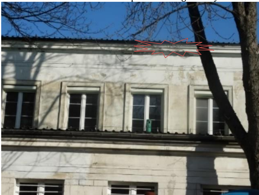
Foto nr 20 Patio ZSS85 strona wschodnio południowa
