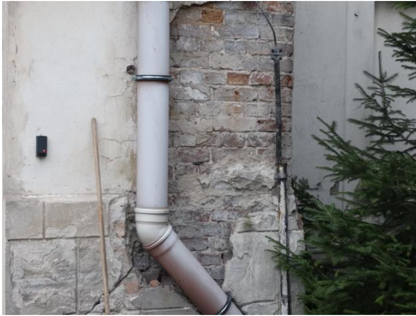
Foto nr 35 Widok szyb windowy od parkingu -przetarcie tynku
