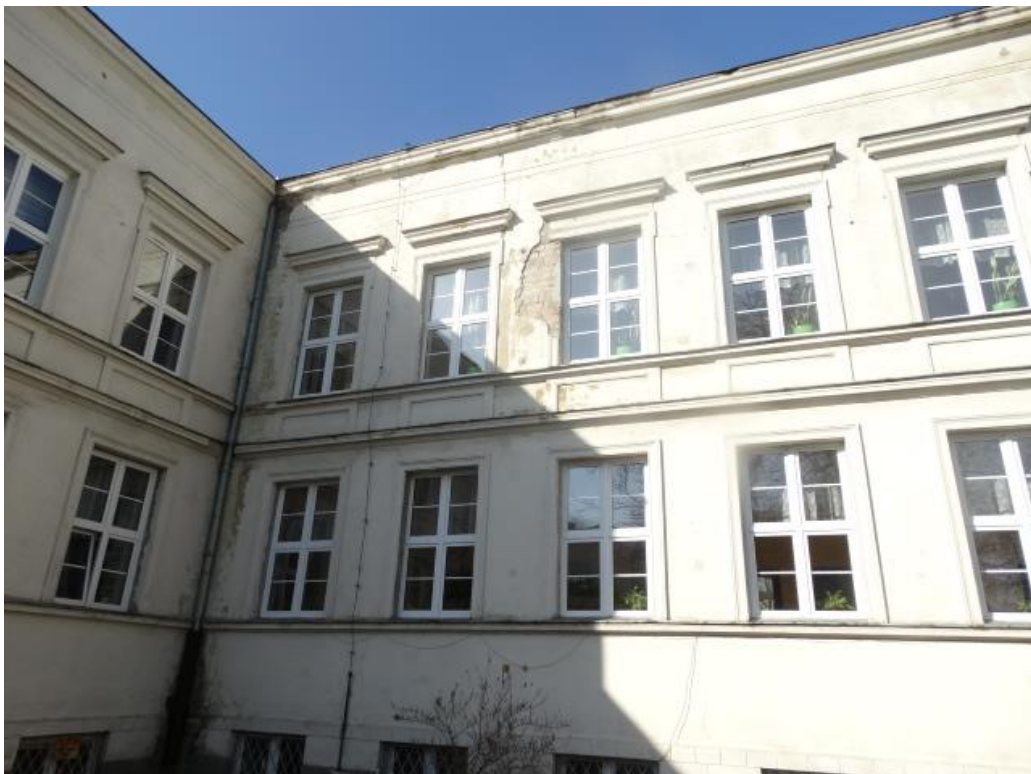
Fot. 5 - Budynek Szkoły - elewacja zachodnia wewnętrzna patio.
