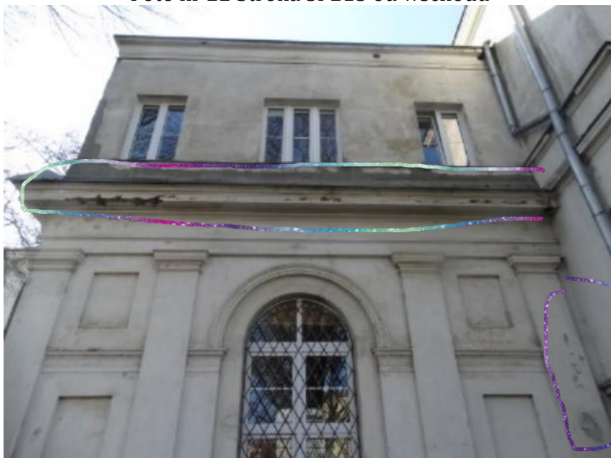
Foto nr 23 SP213 strona od boiska przetarcie tynku
