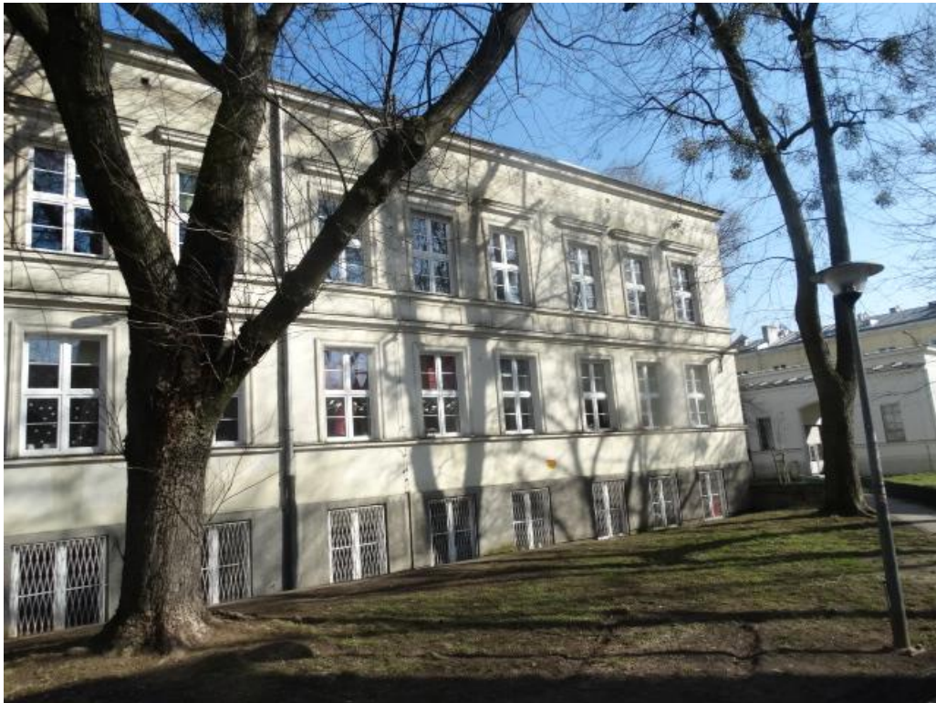
Fot. 2 - Budynek Szkoły- elewacja zachodnia od strony osiedla
