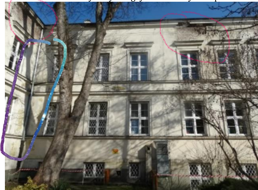
Foto nr 6 Patio ZSS 85 Ubytki tynku ściany
