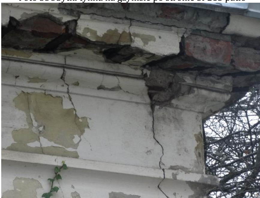
Foto 33 Ubytki tynku na gzymsie po stronie SP213 patio
