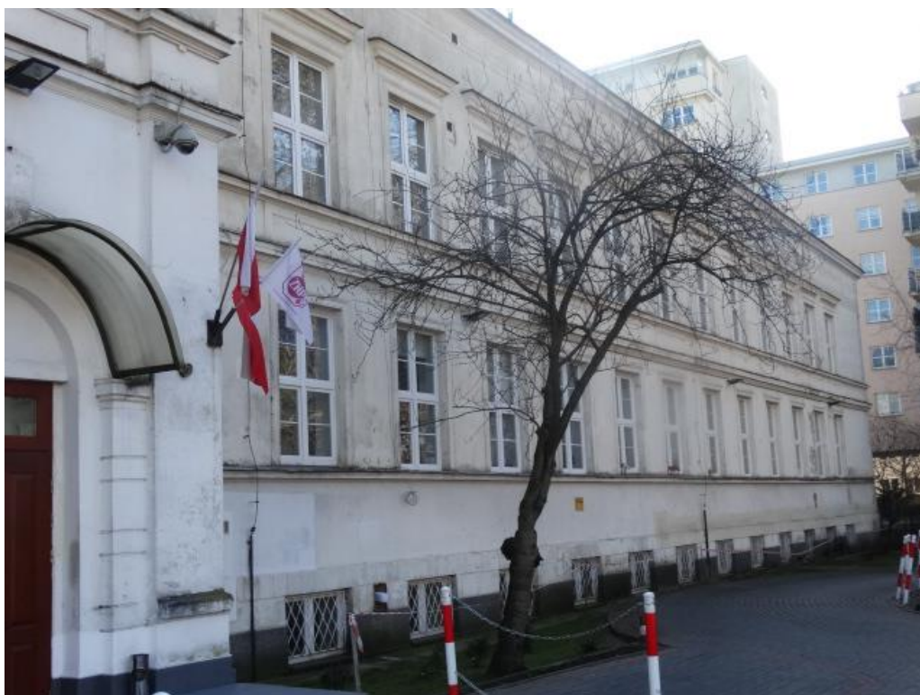
Fot. 1 - Budynek Szkoły - elewacja północna -od strony zachodniej.
