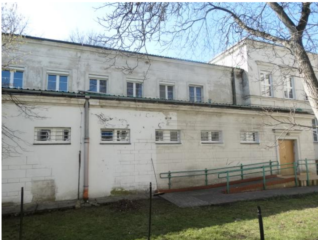
Fot. 6 - Budynek Szkoły - elewacja wschodnia Sali gim wewnętrzna patio.
