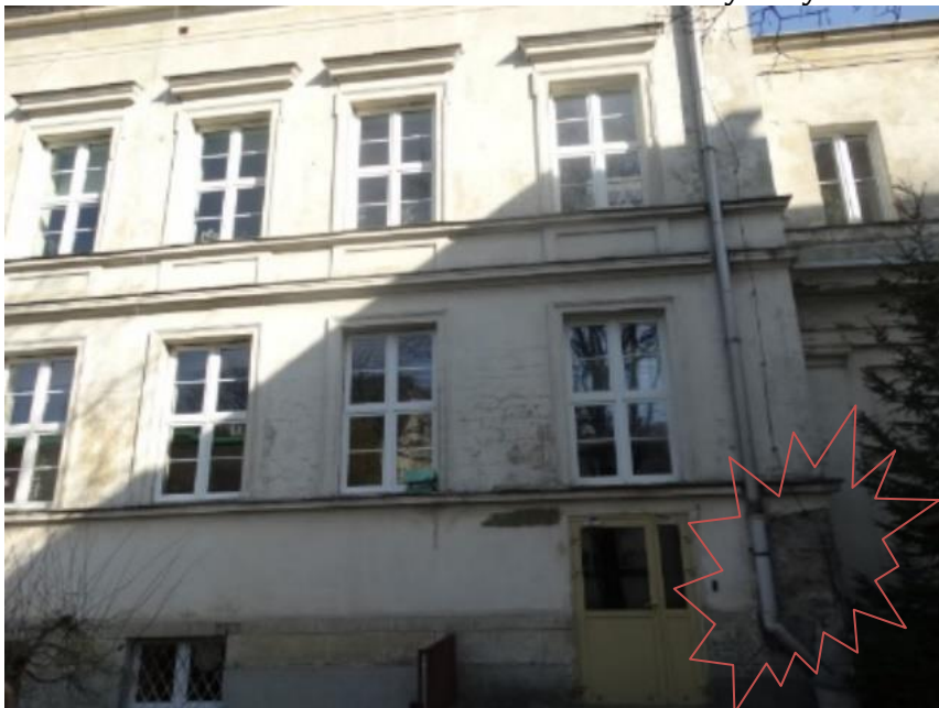
Foto nr 2 Patio SP 213 strona zachodnia ubytki tynku
