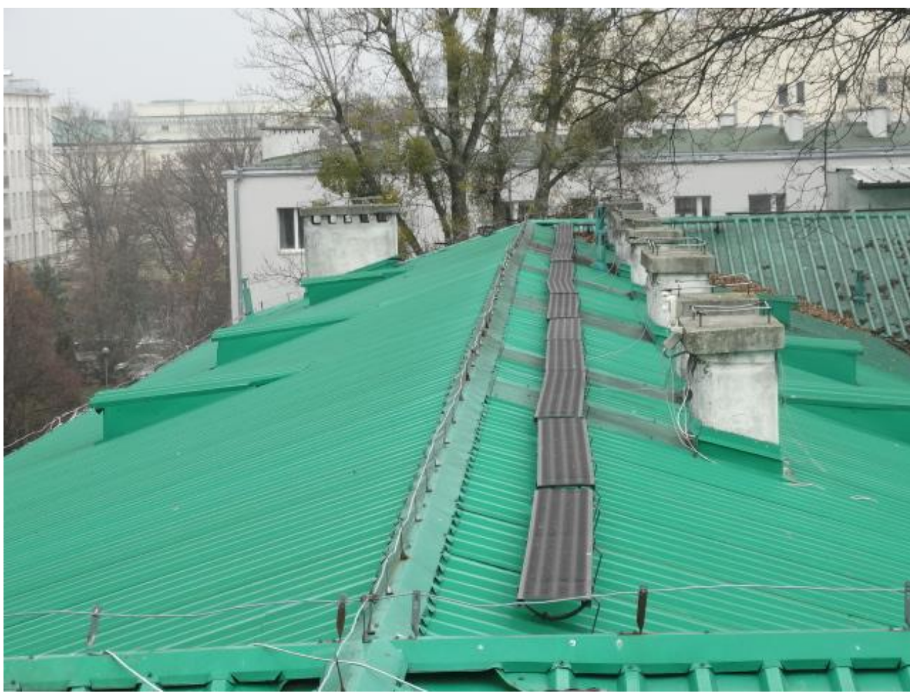
Fot. 7 – Widok dachu część środkowa.
