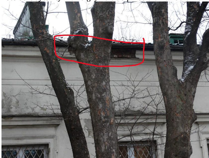
Foto 39 Ubytek tynku na gzymsie do przecierania nad oknami
