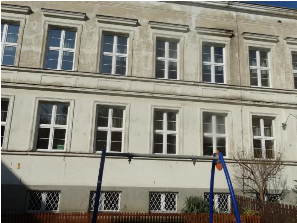
Fot. 4 - Budynek Szkoły - elewacja wschodnia wewnętrzna patio.
