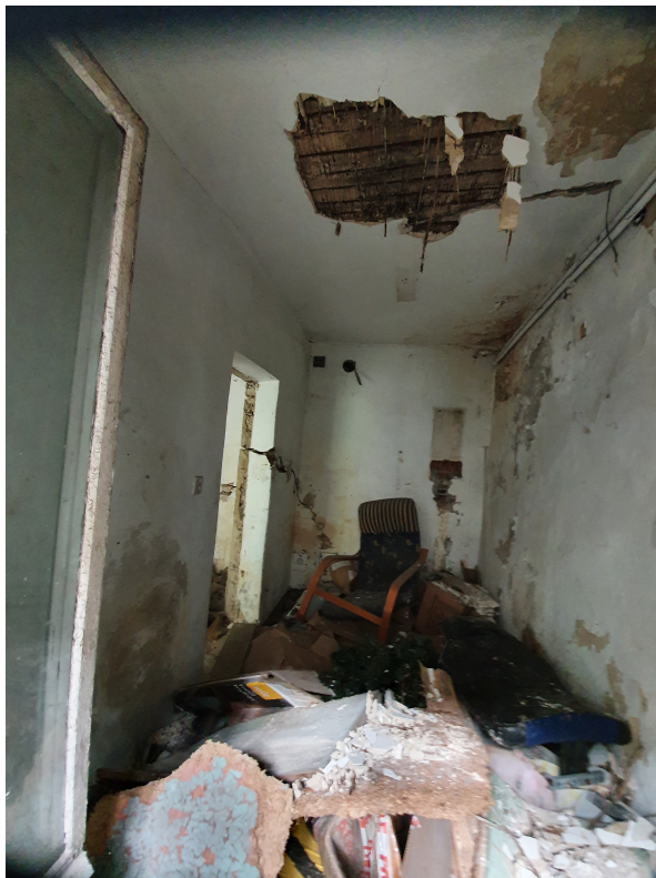
Zdj.4 . Widok stanu technicznego wnętrza budynku gospodarczego – uszkodzone stropy parteru.
