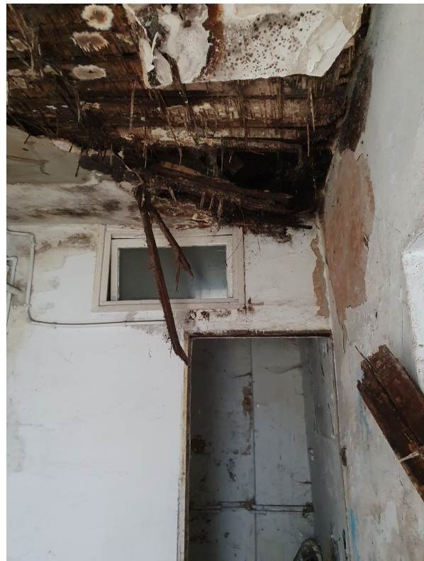
Zdj.4 . Widok stanu technicznego wnętrza budynku gospodarczego – uszkodzone stropy parteru.
