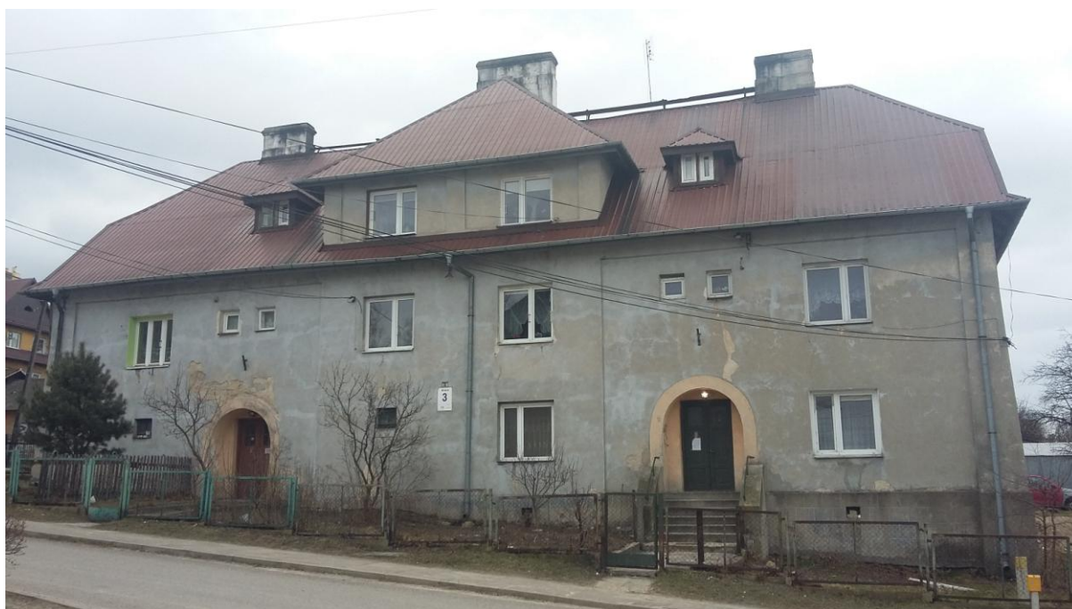
widok stolarki okiennej i drzwiowej zewnętrznej od strony zachodniej
