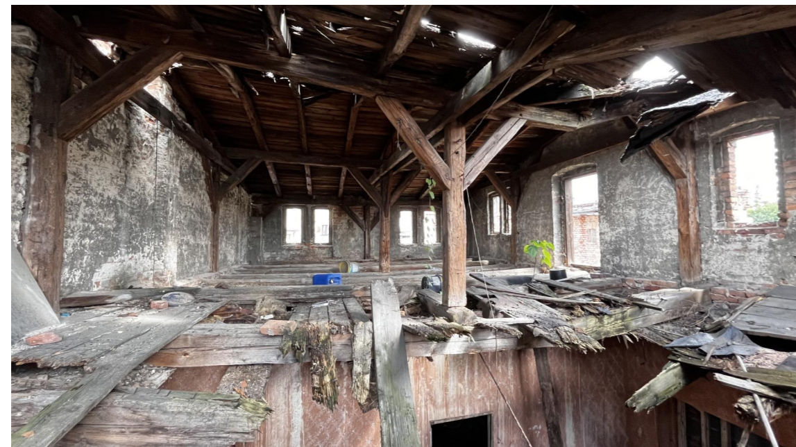
Fot.07 WNĘTRZE BUDYNKU PRZEZNACZONEGO DO ROZBIÓRKI
