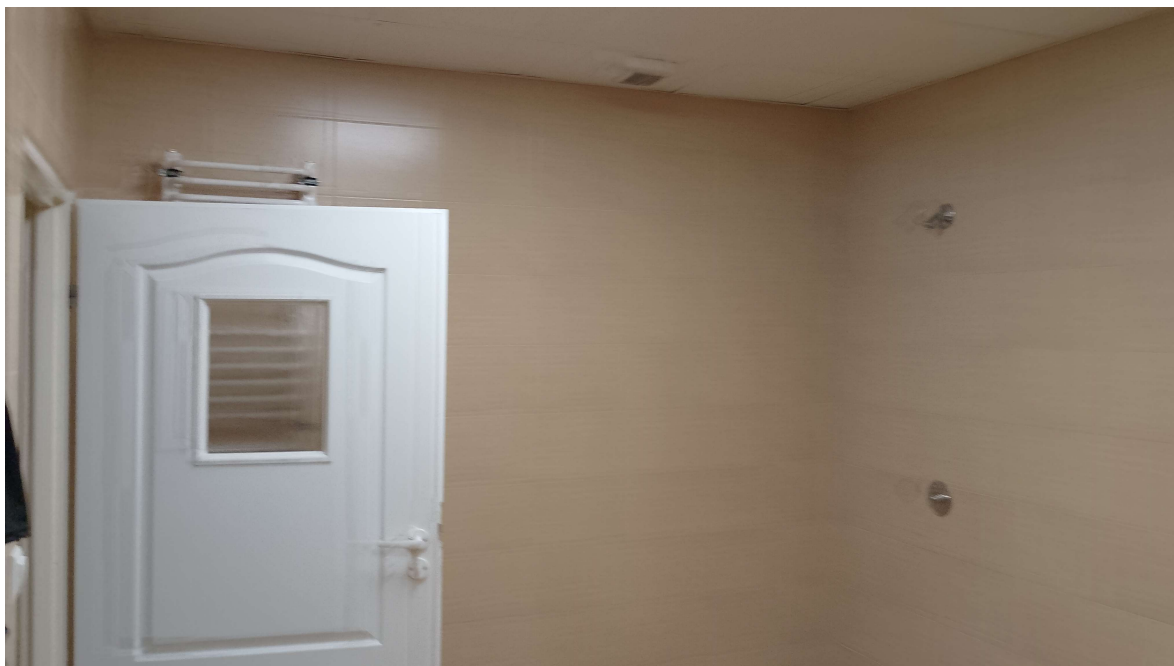
Zdj. nr 7. Ściany i stolarka łazienki dużej
