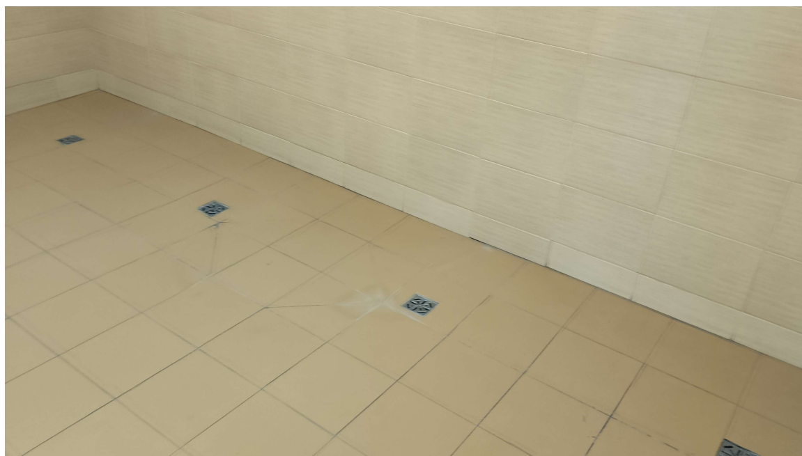
Zdj. nr 6. Posadzki łazienki dużej
