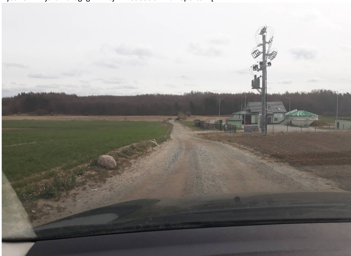
Rysunek 2. Ulica Sportowa w tle widok oczyszczalni ścieków.
