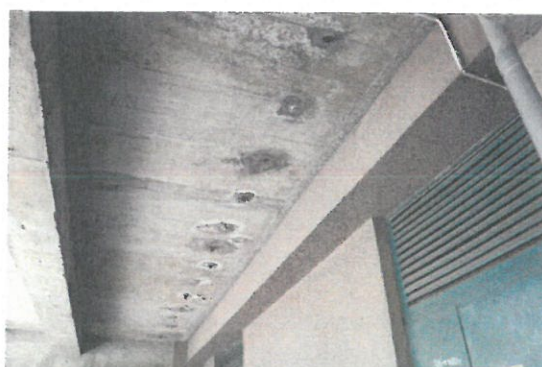
Fot. 6. Sączki zamontowane w płycie żelbetowej estakady i widoczne wykwyty węglanowe
