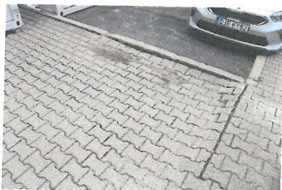
Fot. 11. Zapadliny nawierzchni i ślady po zastoinach wód opadowych
