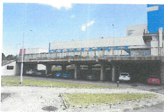
Fot. 2. Segment nr 1 po lewej i segment nr 2 po prawej
