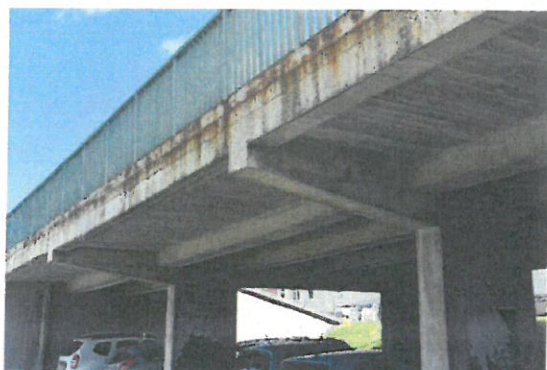
Fot. 4. Konstrukcja estakady
