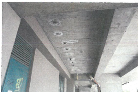
Fot. 6. Sączki zamontowane w płycie żelbetowej estakady i widoczne wykwyty węglanowe
