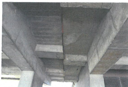
Fot. 5. Połączenie segmentów nr 1 i nr 2
