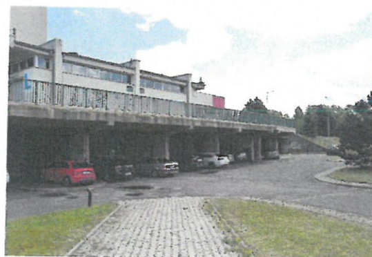
Fot. 3. Segment nr 2 po lewej i segment nr 3 po prawej
