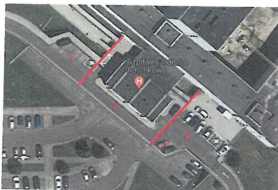
Fot. 1. Estakada – podział na segmenty
