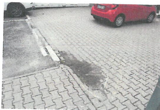
Fot. 11. Zapadliny nawierzchni i ślady po zastoinach wód opadowych
