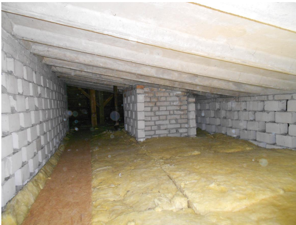
Fot. 11: Niskie poddasze nieużytkowe nad II piętrem – widoczna konstrukcja dachu z płyt korytkowych prefabrykowanych.
