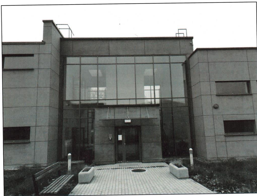
Widok na budynek nr H – hol wejściowy od strony wejścia głównego
