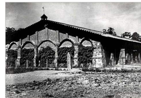
Ryc. 12 Widok na południową, reprezentacyjną elewację stajni-wozowni z sygnaturką w szczycie kalenicy i ozdobnymi listwami drewnianymi osłaniającą krokwie.
