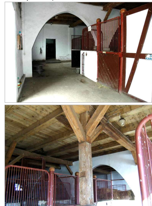
Ryc. 13 Wnętrze stajni z widokiem na: (1) ściankę arkadową oddzielającą stajnię od wozowni i podziały stanowisk dla koni wprowadzone w latach 90. XX w., (2) widok na słupek i konstrukcję belkowania stropu parteru oraz ściankę arkadową oddzielającą stajnię od wozowni.
