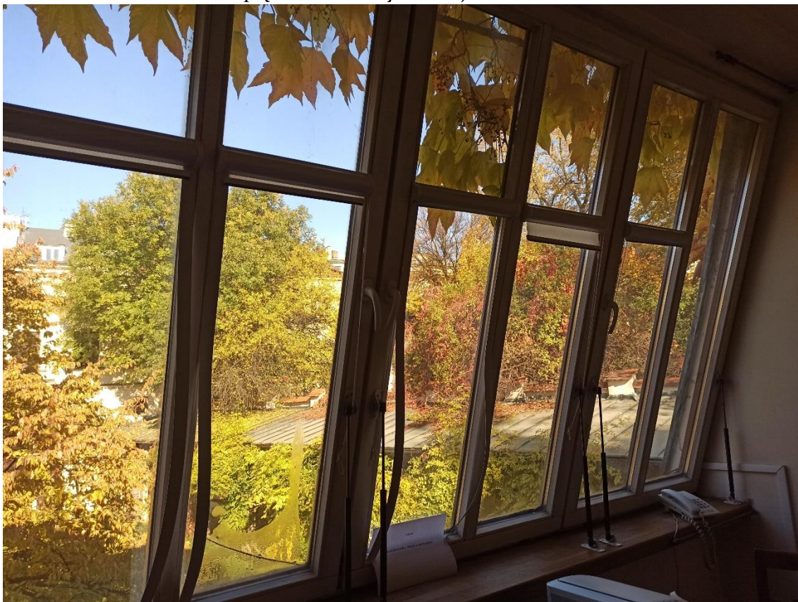
Fot.2. Widok od wnętrza pomieszczenia
