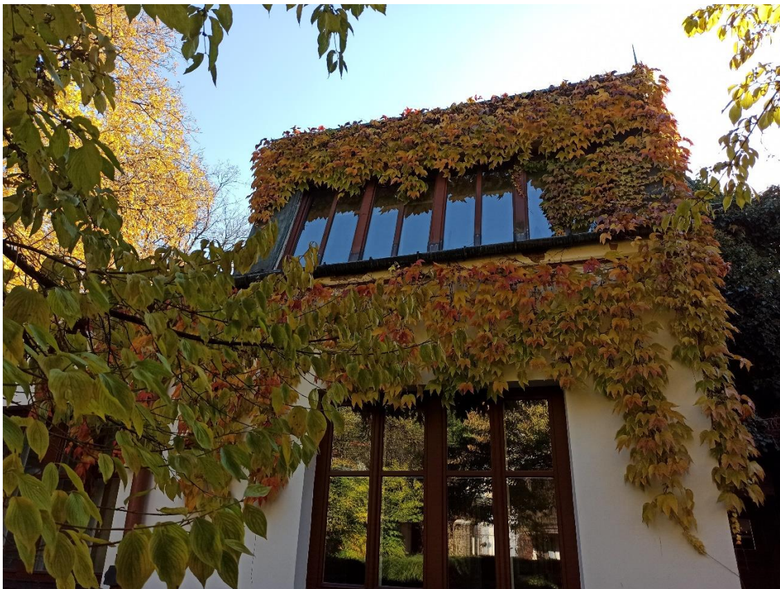
Fot. 1. Widok na okno na I piętrze od strony elewacji
