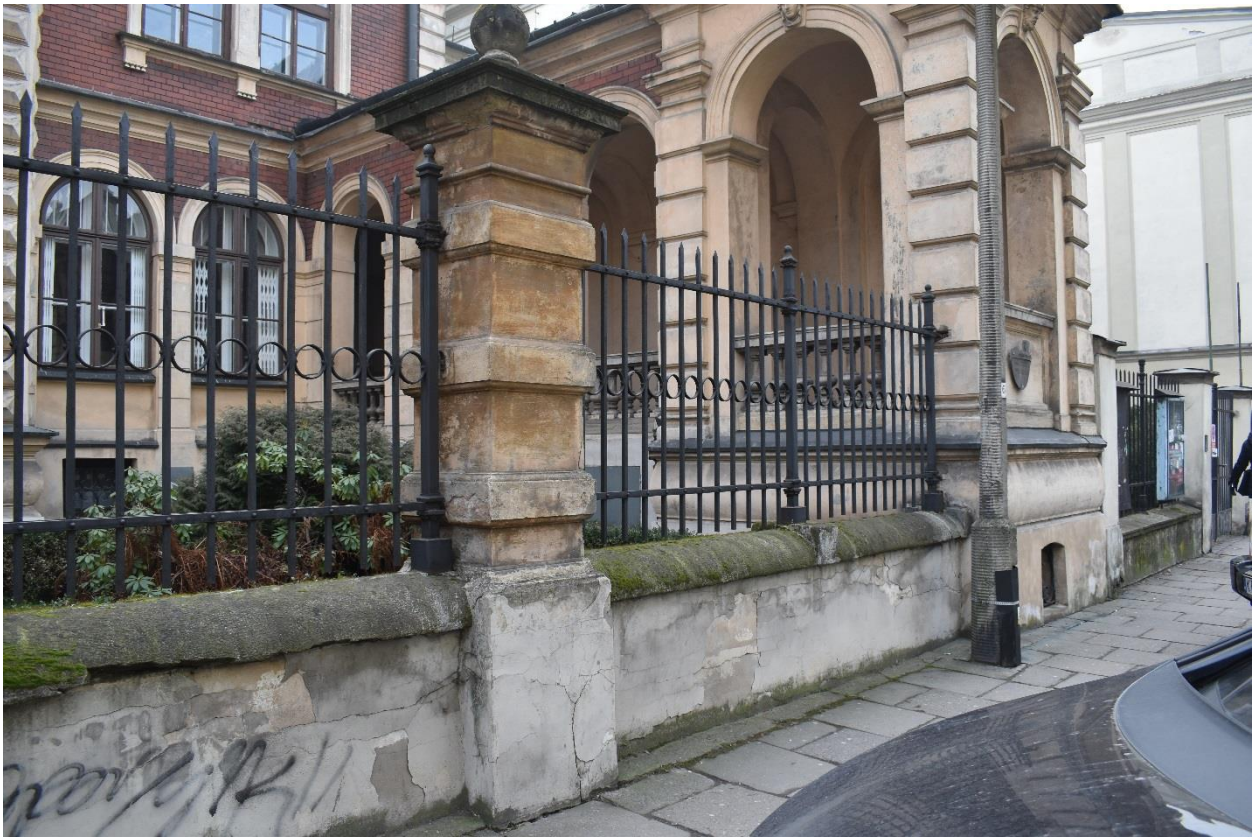
Fot. nr 57 Dom „Pod Stańczykiem”, obecnie Collegium Sanockie UJ, ul. Batorego 12 w Krakowie. Widok ogólny przeszła ogrodzenia od strony ulicy Batorego. Stan przed konserwacją. Kraków, grudzień 2016 r.
