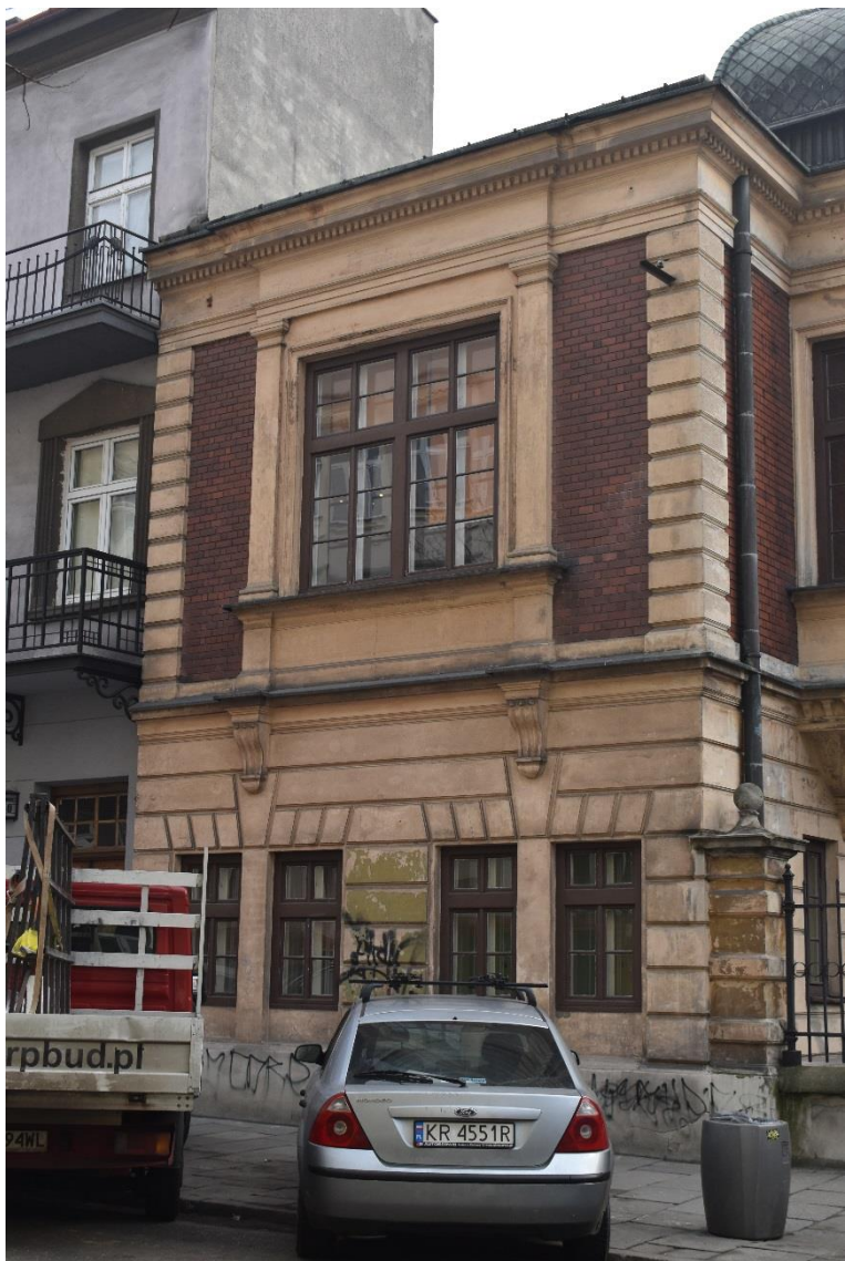
Fot. nr 2 Dom „Pod Stańczykiem”, obecnie Collegium Sanockie UJ, ul. Batorego 12 w Krakowie. Widok ogólny elewacji bocznej skrzydła od strony ul. Batorego. Stan przed konserwacją. Kraków, grudzień 2016 r. fot. K. Sułkowska
