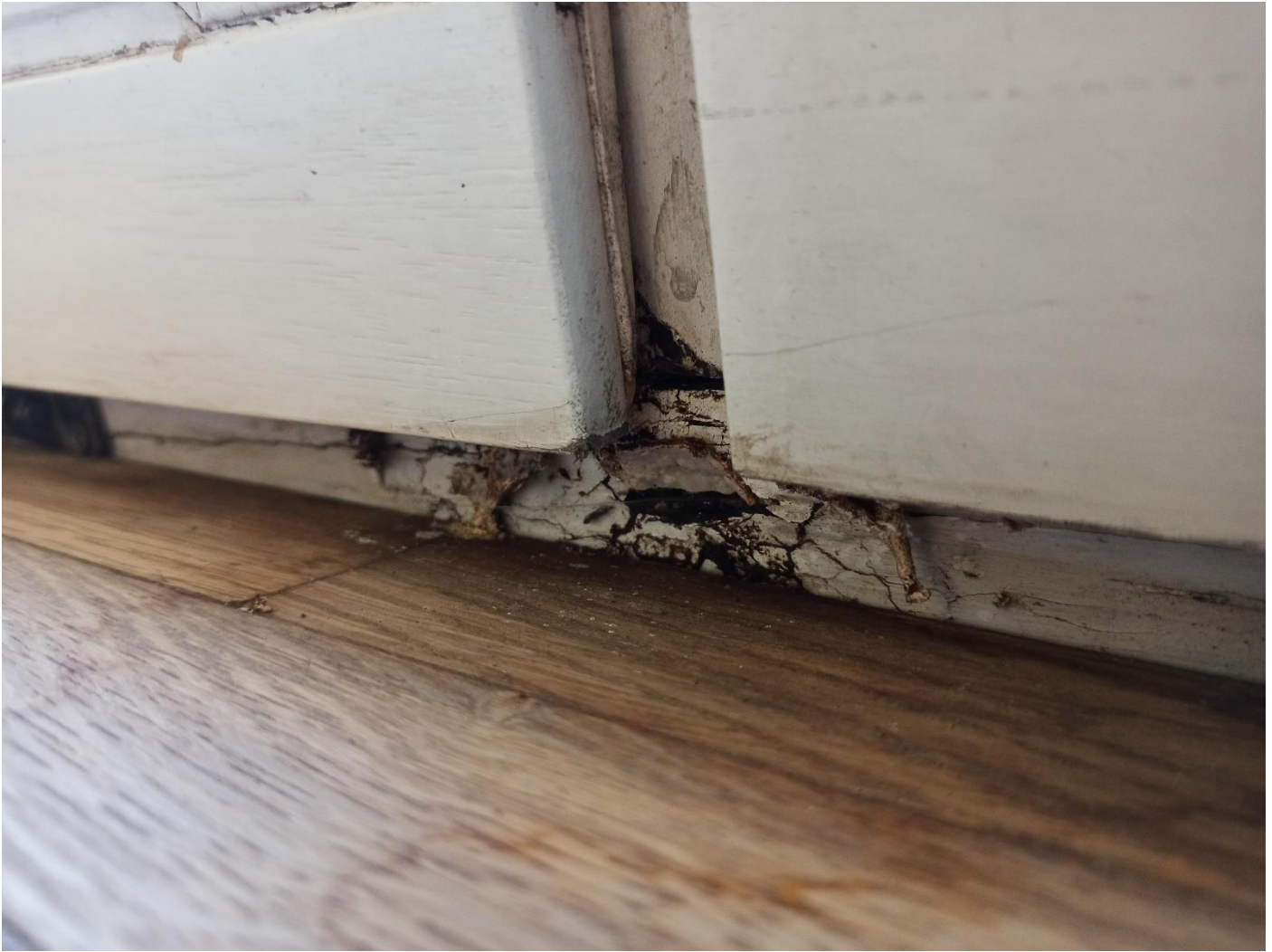
Fot. 3. Stan zachowania progów ościeżnic
