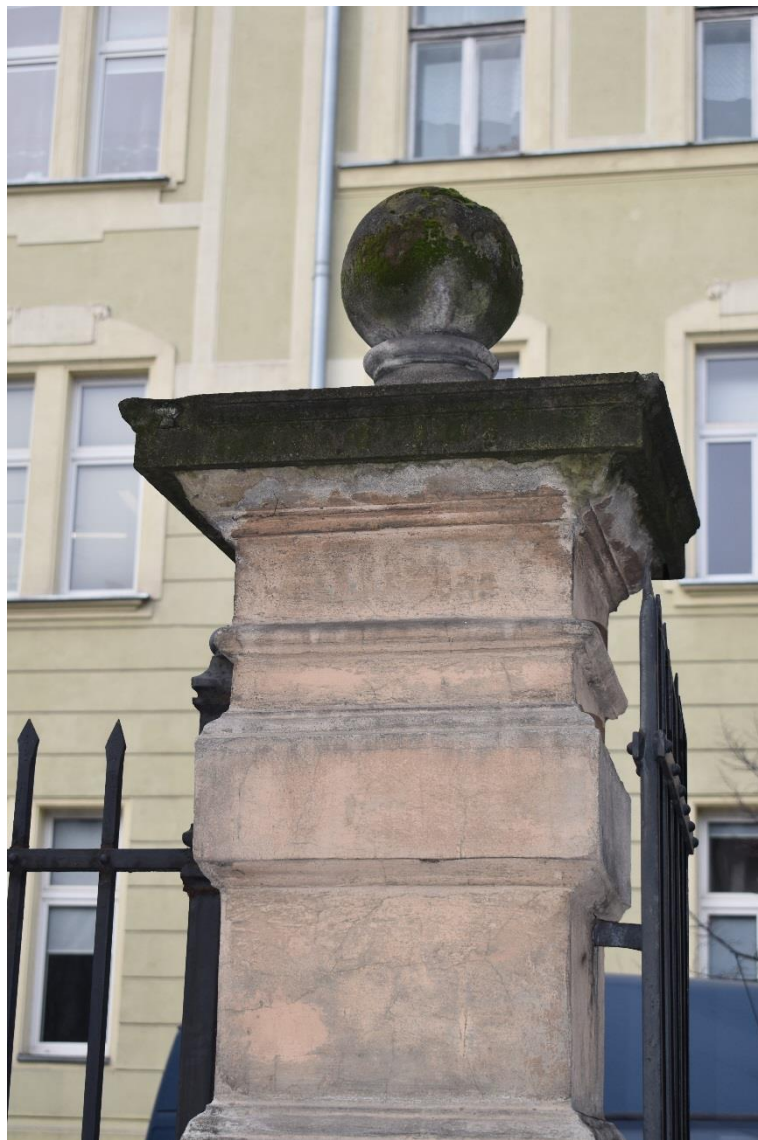
Fot. nr 64 Dom „Pod Stańczykiem”, obecnie Collegium Sanockie UJ, ul. Batorego 12 w Krakowie.
