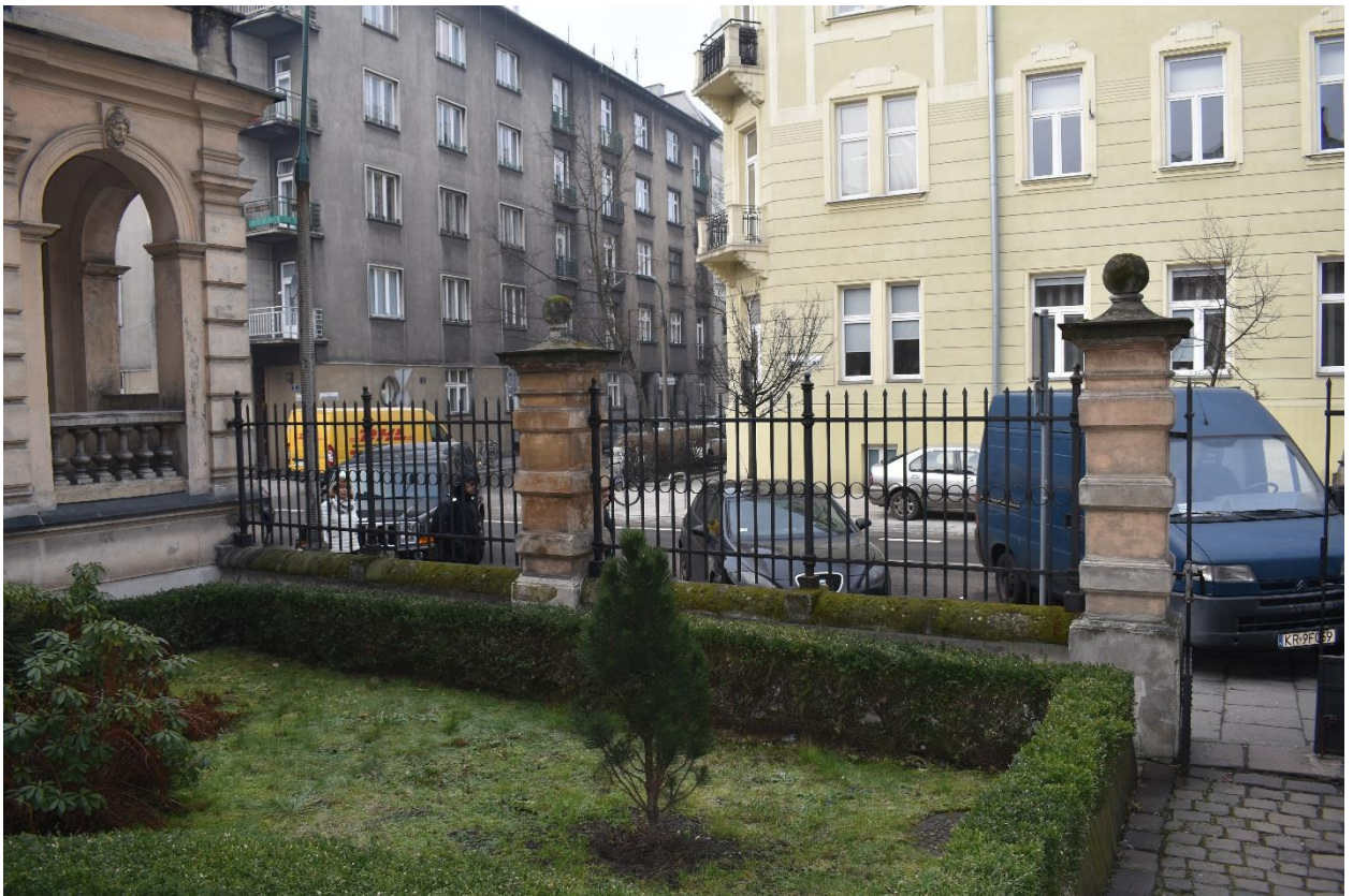
Fot. nr 58 Dom „Pod Stańczykiem”, obecnie Collegium Sanockie UJ, ul. Batorego 12 w Krakowie. Widok ogólny przeszła ogrodzenia od strony dziedzińca przed willą. Stan przed konserwacją. Kraków, grudzień 2016 r.
