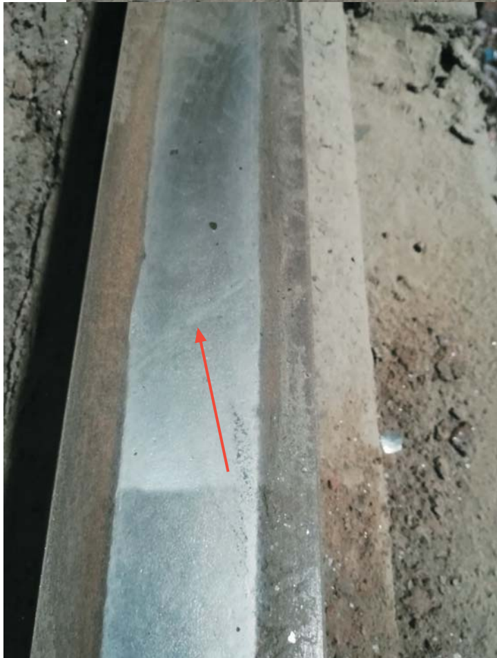
Elipsą oznaczono wzorec, przenoszony przez koło na powierzchni szyny jako cykliczny wzór. ( szyna północna )
