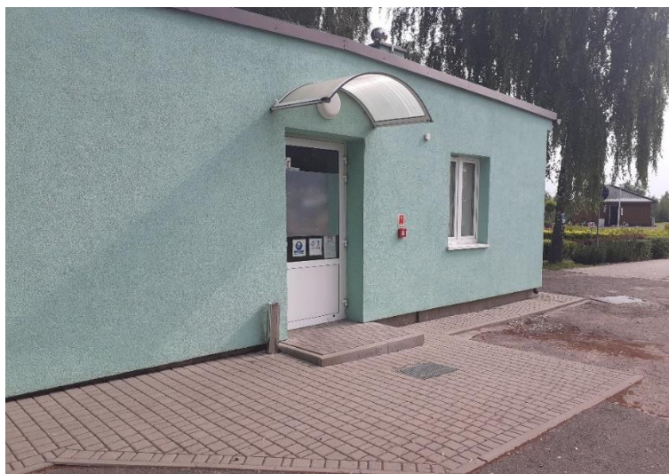
Wyłącznik ppoż. obiektu
