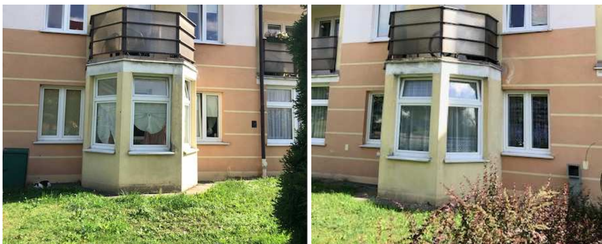
Zdjęcia balkonów – mieszkanie A5 i B5
