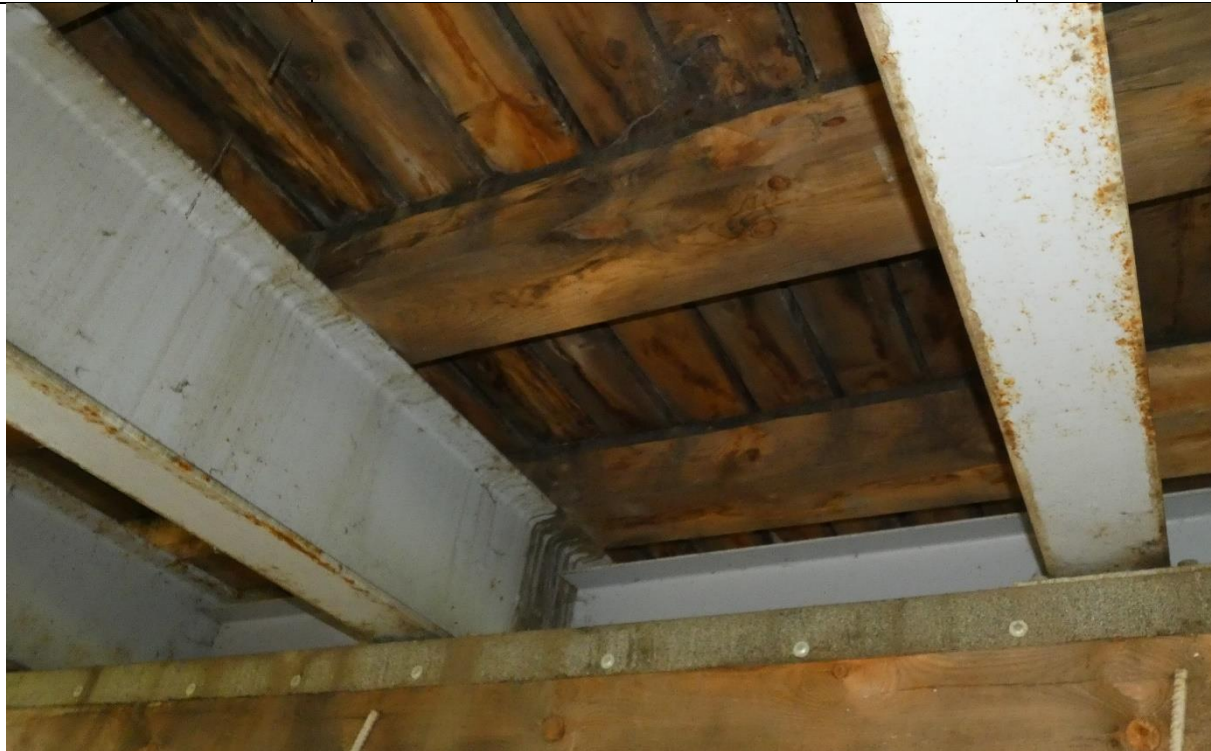
Fot. 15. Zacieki, ogniska korozji, zanieczyszczenia na konstrukcji stalowej przęsł obiektu
