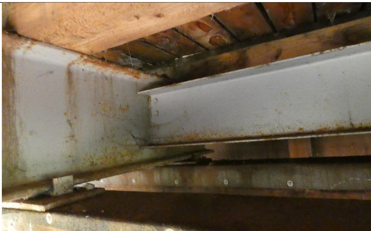
Fot. 15. Zacieki, ogniska korozji, zanieczyszczenia na konstrukcji stalowej przęsł obiektu
