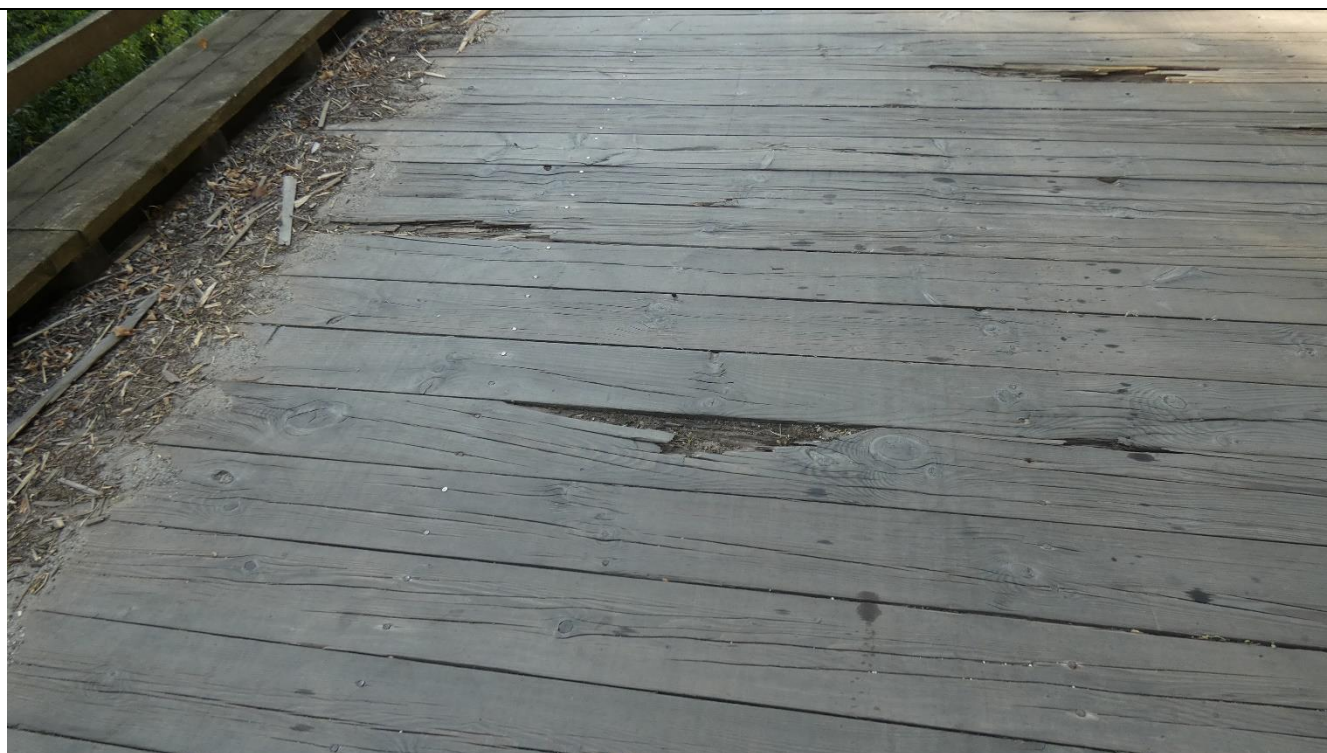
Fot. 2. Widok na nawierzchnię jezdni na obiekcie
