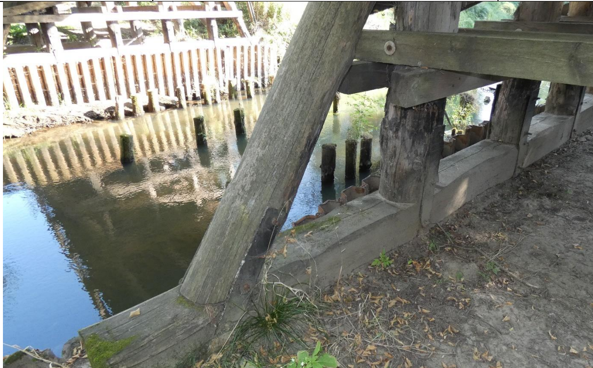
Fot. 7. Korozja biologiczna, zanieczyszczenia i zarysowania drewnianych bali jako podpór obiektu
