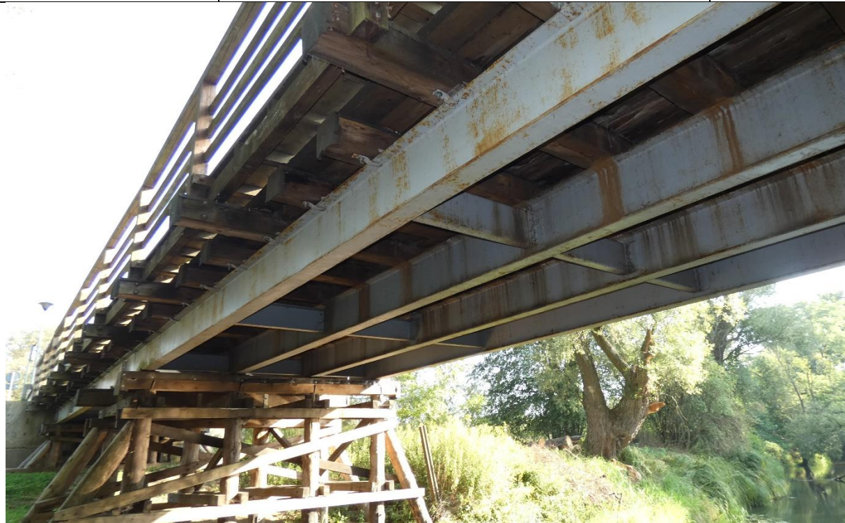
Fot. 11. Zacieki, ogniska korozji, zanieczyszczenia na konstrukcji stalowej przęsł obiektu
