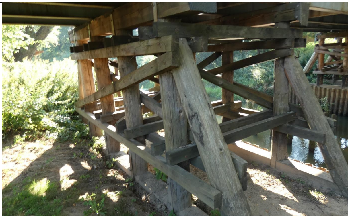
Fot. 5. Korozja biologiczna, zanieczyszczenia i zarysowania drewnianych bali jako podpór obiektu
