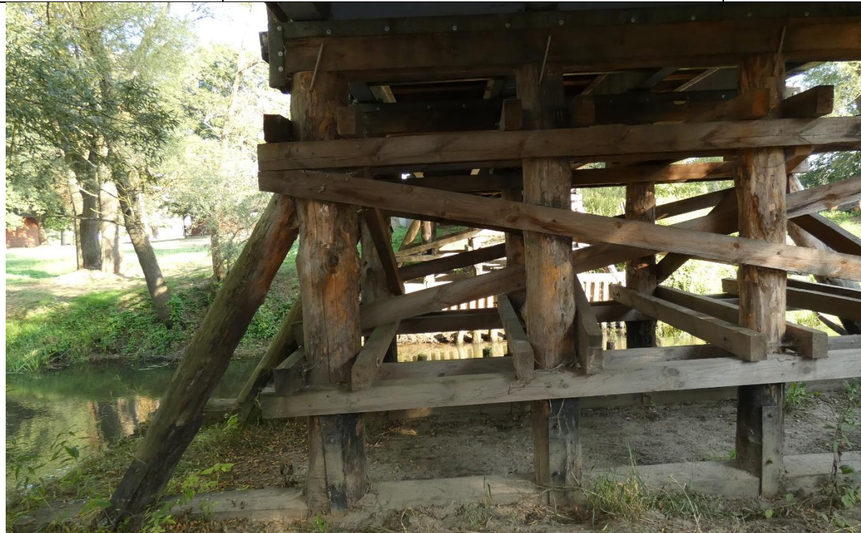
Fot. 5. Korozja biologiczna, zanieczyszczenia i zarysowania drewnianych bali jako podpór obiektu
