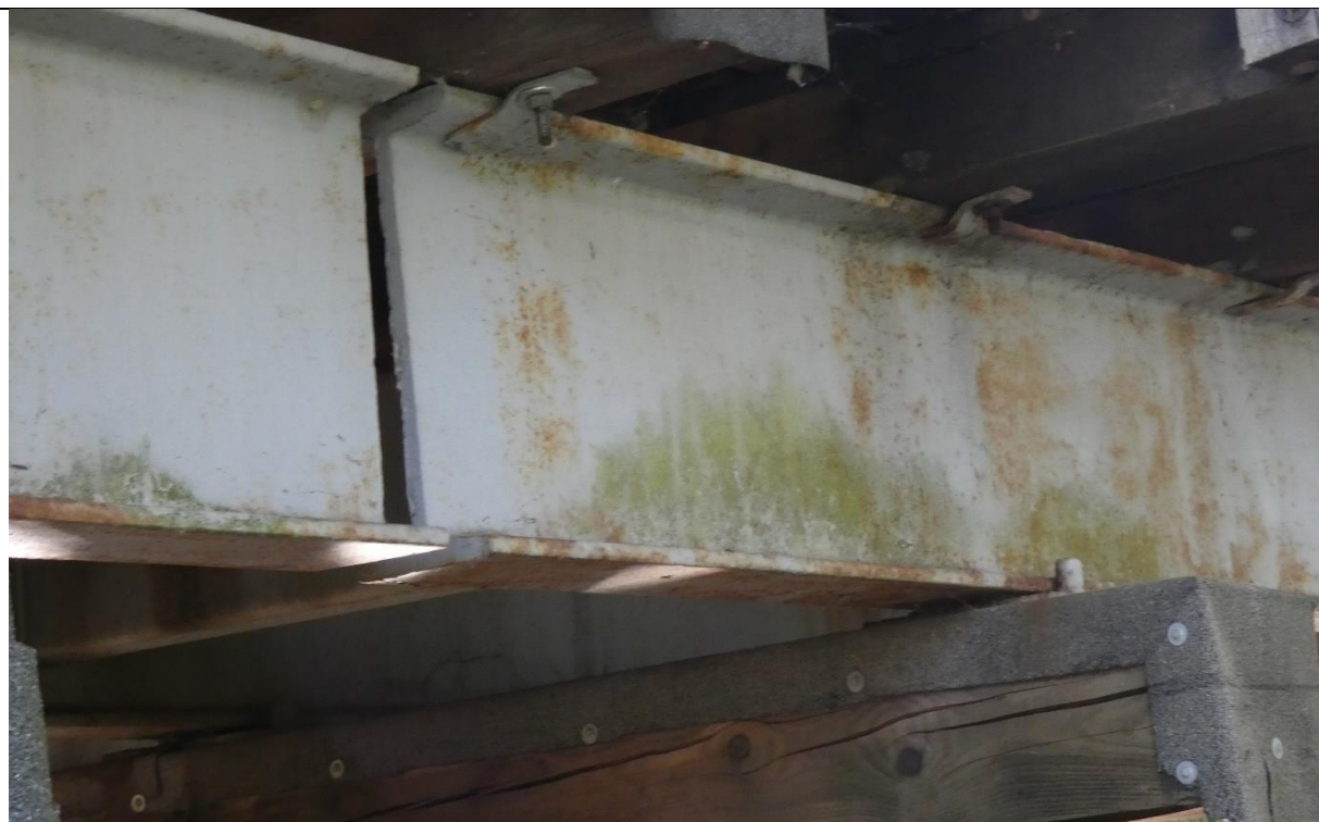
Fot. 11. Zacieki, ogniska korozji, zanieczyszczenia na konstrukcji stalowej przęsł obiektu
