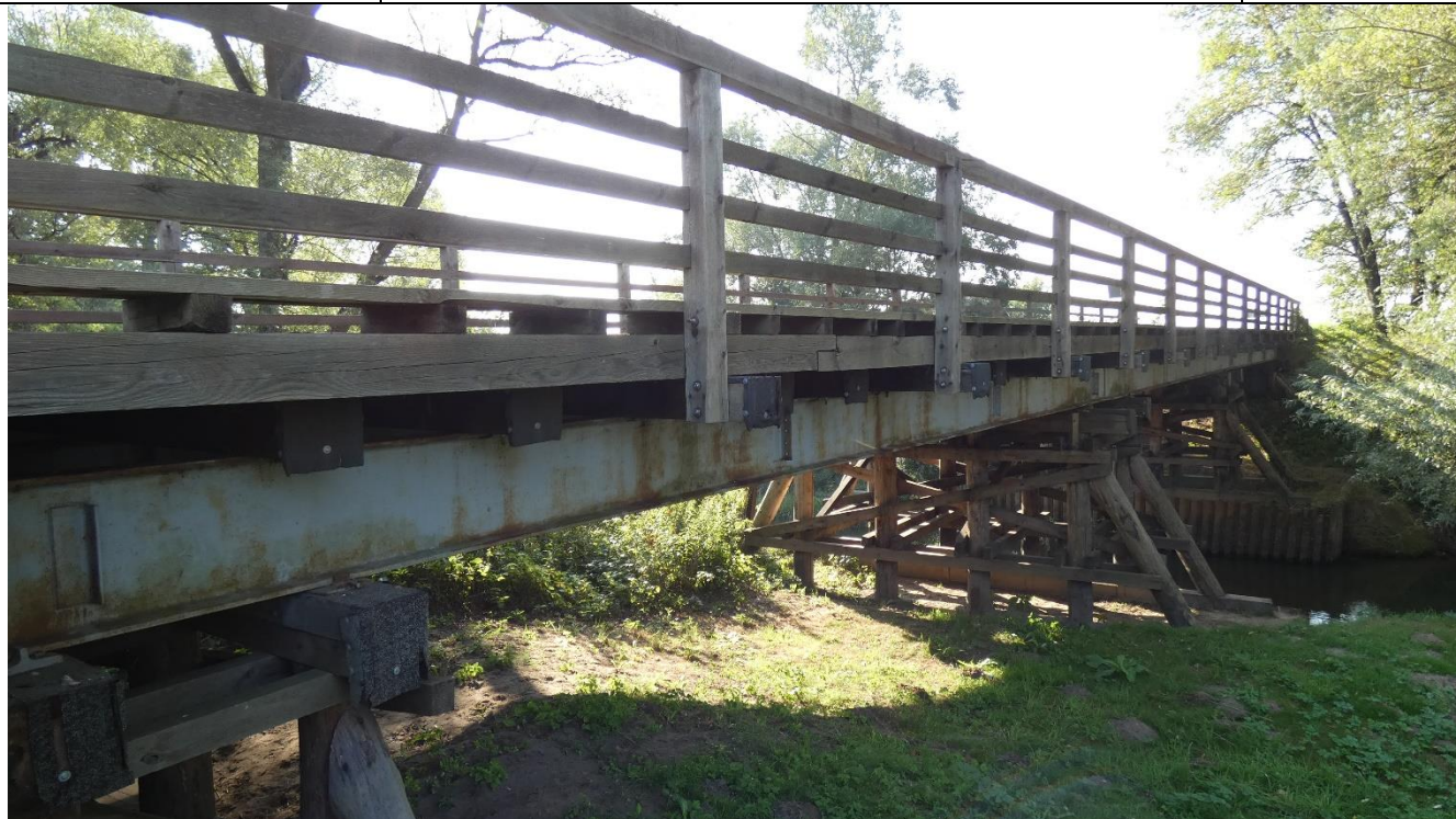
Fot. 1. Widok na obiekt
