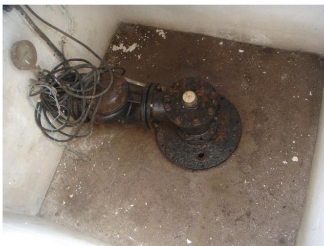
Wnętrze obudowy studni nr 2 w Ciężeniu
