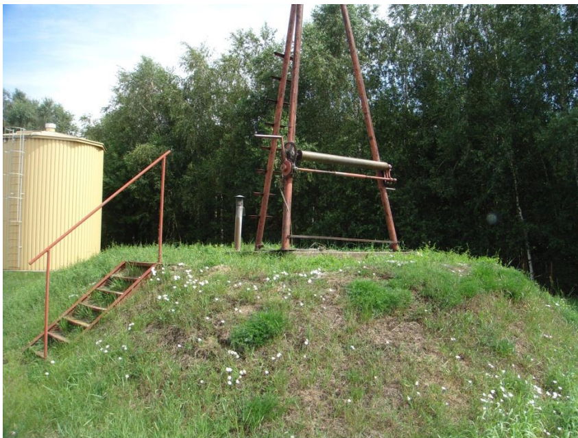
Obudowa studni głębinowej nr 2
