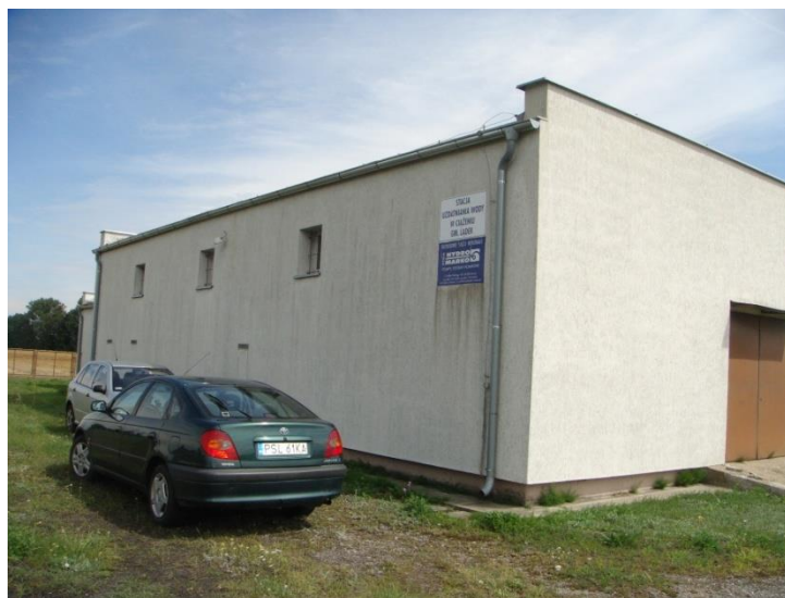
Stacja uzdatniania wody w Ciężeniu
