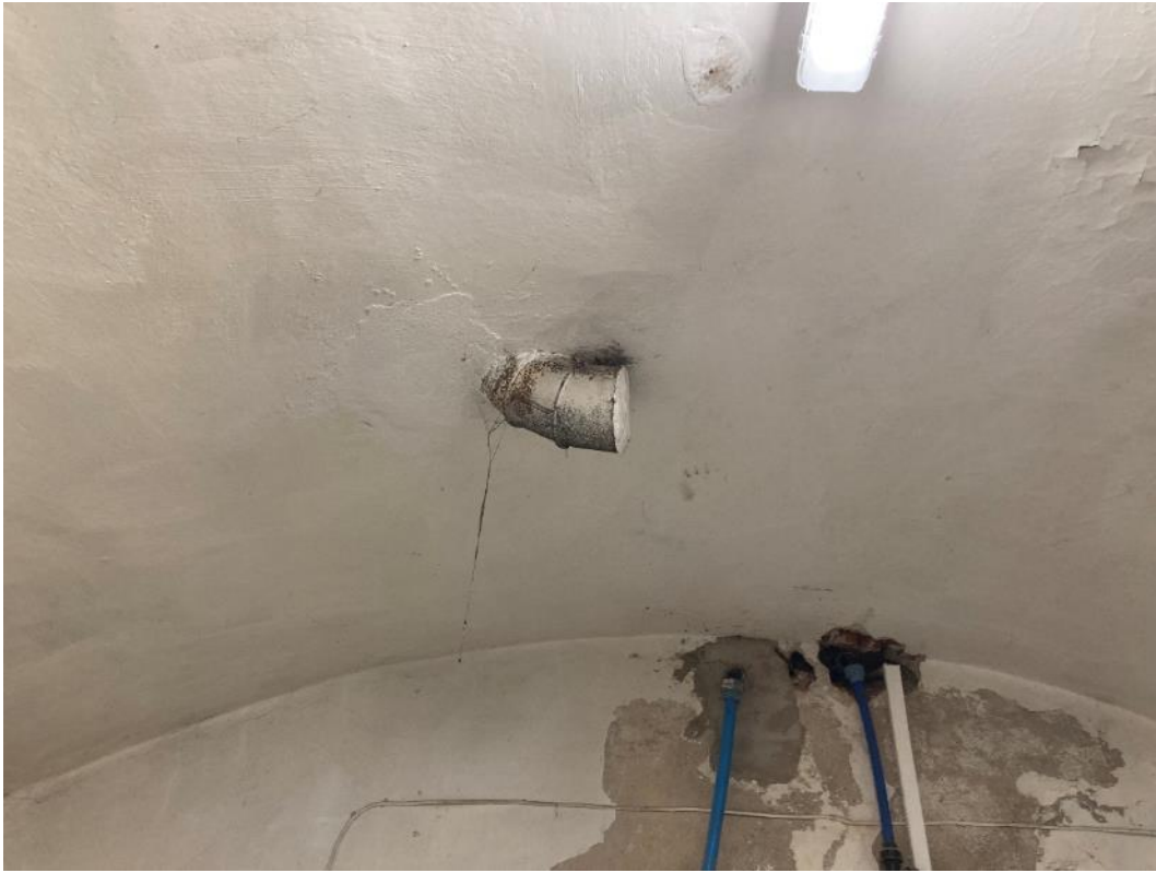
Fot. 66. Dawne Muzeum Techniczno-Przemysłowe, ul Smoleńsk 9, Kraków. Piwnice. Spękania i przebarwienia tynku w obrębie sufitu pomieszczenia. Stan przed konserwacją. Czerwiec 2022. Fot. K. Sułkowska.
