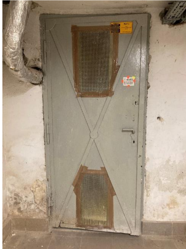
Fot. 41. Dawne Muzeum Techniczno-Przemysłowe, ul Smoleńsk 9, Kraków. Piwnice. Przekształcone historyczne drzwi stalowe. Stan przed konserwacją. Czerwiec 2022. Fot. K. Sułkowska.
