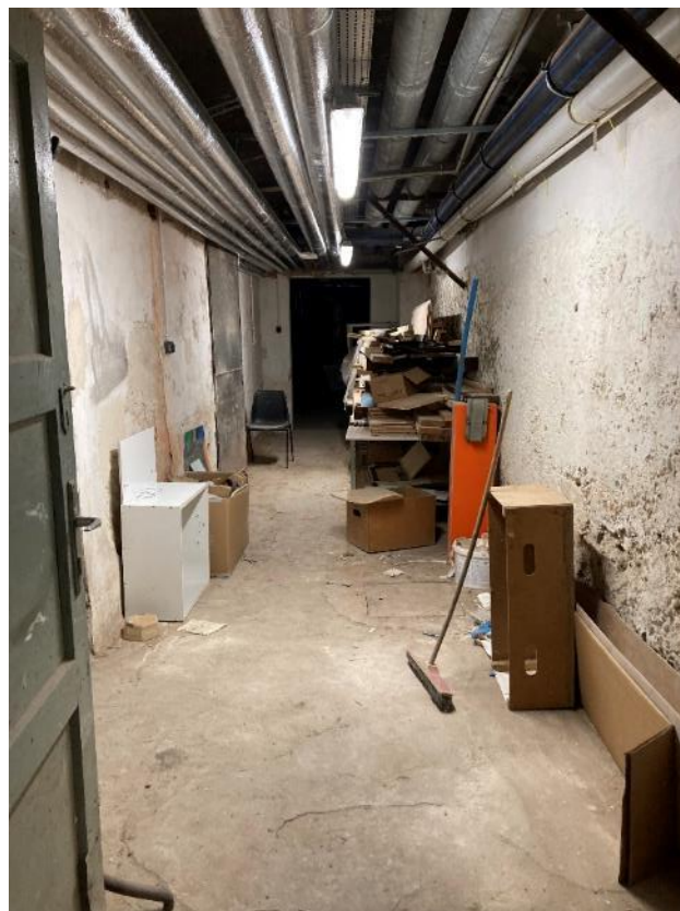
Fot. 44. Dawne Muzeum Techniczno-Przemysłowe, ul Smoleńsk 9, Kraków. Piwnice. Stan przed konserwacją. Czerwiec 2022. Fot. K. Sułkowska.
