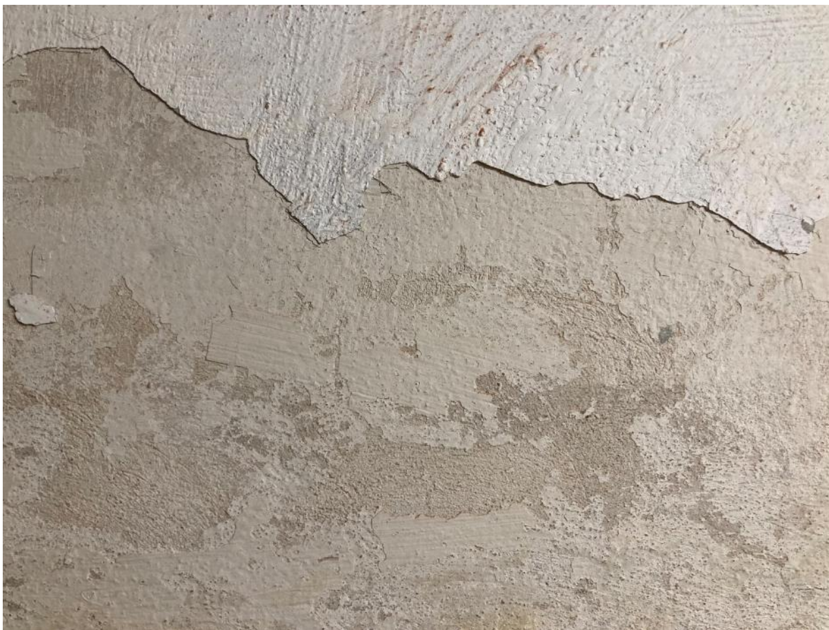
Fot. 71. Dawne Muzeum Techniczno-Przemysłowe, ul Smoleńsk 9, Kraków. Piwnice. Fragment tynków z łuszczącą się warstwą malarską. Stan przed konserwacją. Czerwiec 2022. Fot. K. Sułkowska.
