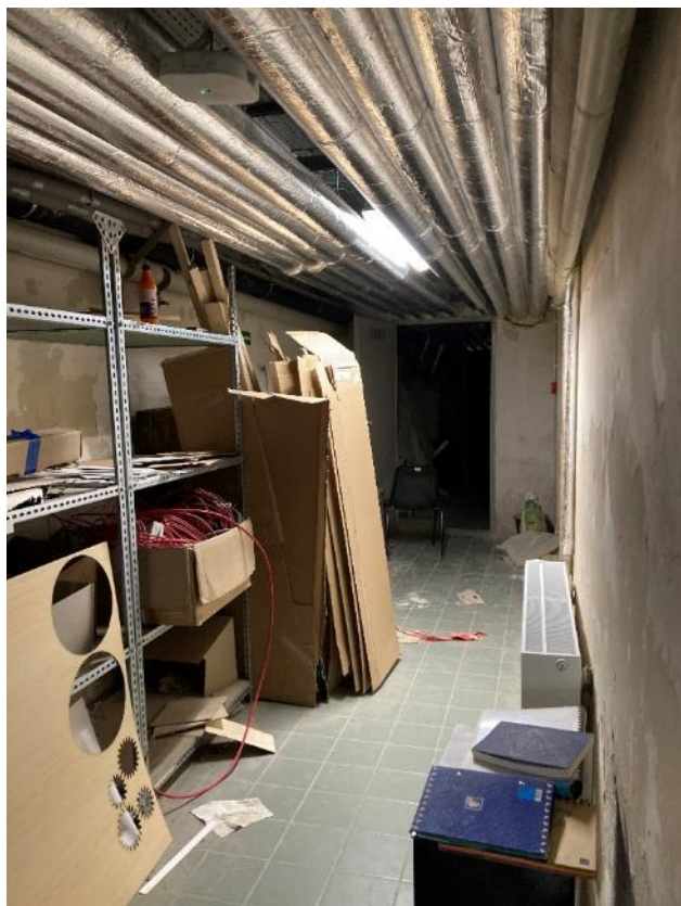
Fot. 19. Dawne Muzeum Techniczno-Przemysłowe, ul Smoleńsk 9, Kraków. Piwnice. Stan przed konserwacją. Czerwiec 2022. Fot. K. Sułkowska.
