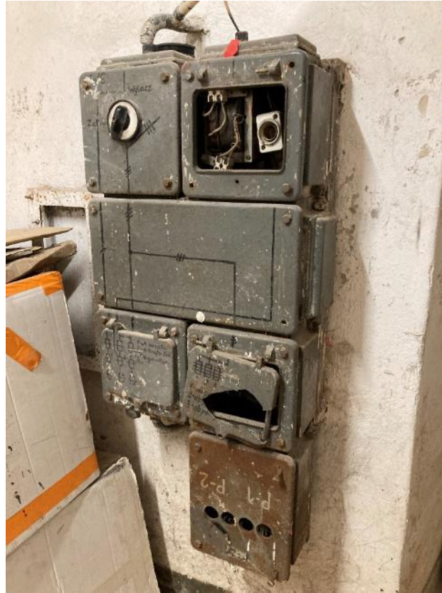
Fot. 23. Dawne Muzeum Techniczno-Przemysłowe, ul Smoleńsk 9, Kraków. Piwnice. Widoczne historyczne obudowy instalacji elektrycznej, Stan przed konserwacją. Czerwiec 2022. Fot. K. Sułkowska.
