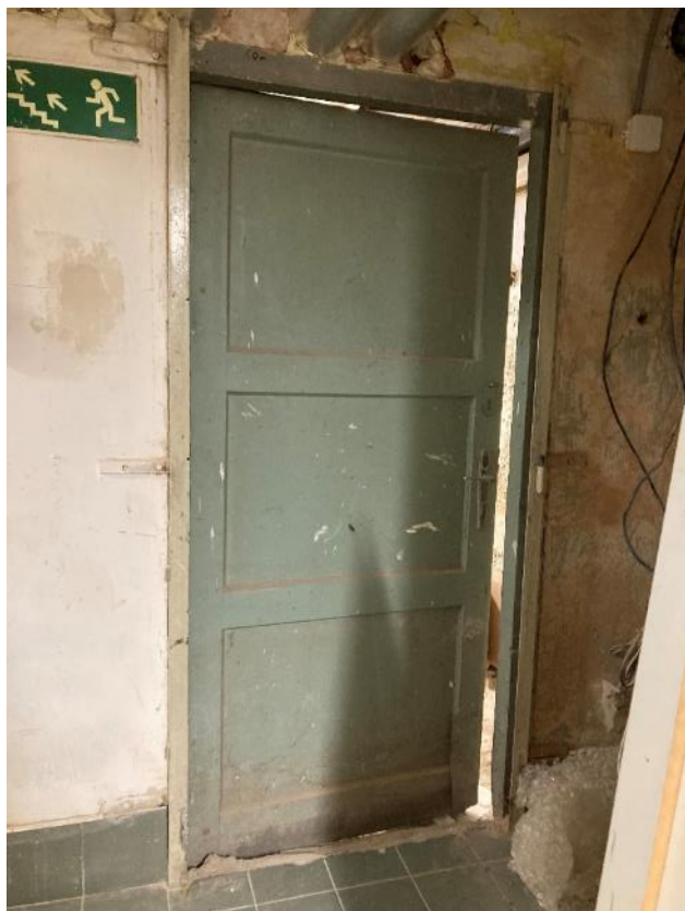
Fot. 43. Dawne Muzeum Techniczno-Przemysłowe, ul Smoleńsk 9, Kraków. Piwnice. Wtórne drzwi drewniane. Stan przed konserwacją. Czerwiec 2022. Fot. K. Sułkowska.
