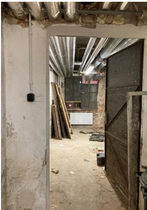
Fot. 5 Dawne Muzeum Techniczno-Przemysłowe, ul Smoleńsk 9, Kraków. Piwnice. Stan przed konserwacją. Czerwiec 2022. Fot. K. Sułkowska.
