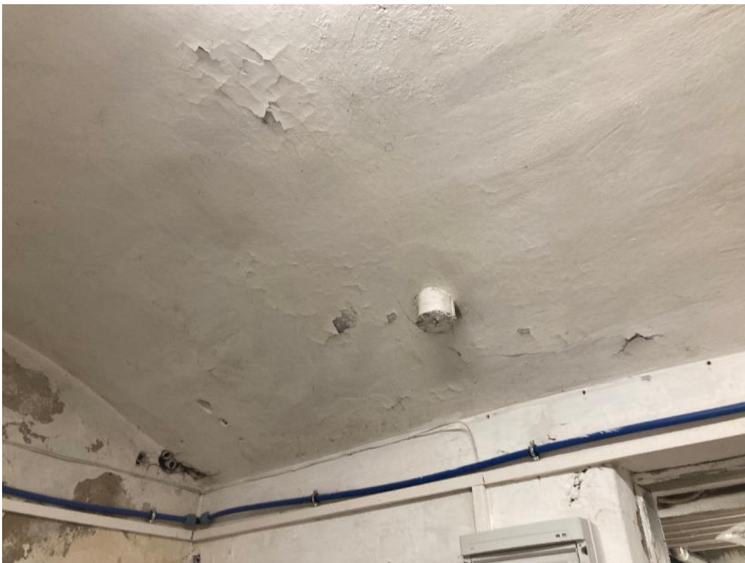
Fot. 67. Dawne Muzeum Techniczno-Przemysłowe, ul Smoleńsk 9, Kraków. Piwnice. Spękania i przebarwienia tynku w obrębie sufitu pomieszczenia. Stan przed konserwacją. Czerwiec 2022. Fot. K. Sułkowska.
