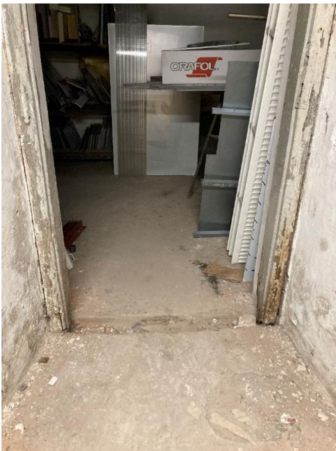
Fot. 68. Dawne Muzeum Techniczno-Przemysłowe, ul Smoleńsk 9, Kraków. Piwnice. Stan przed konserwacją. Czerwiec 2022. Fot. K. Sułkowska.
