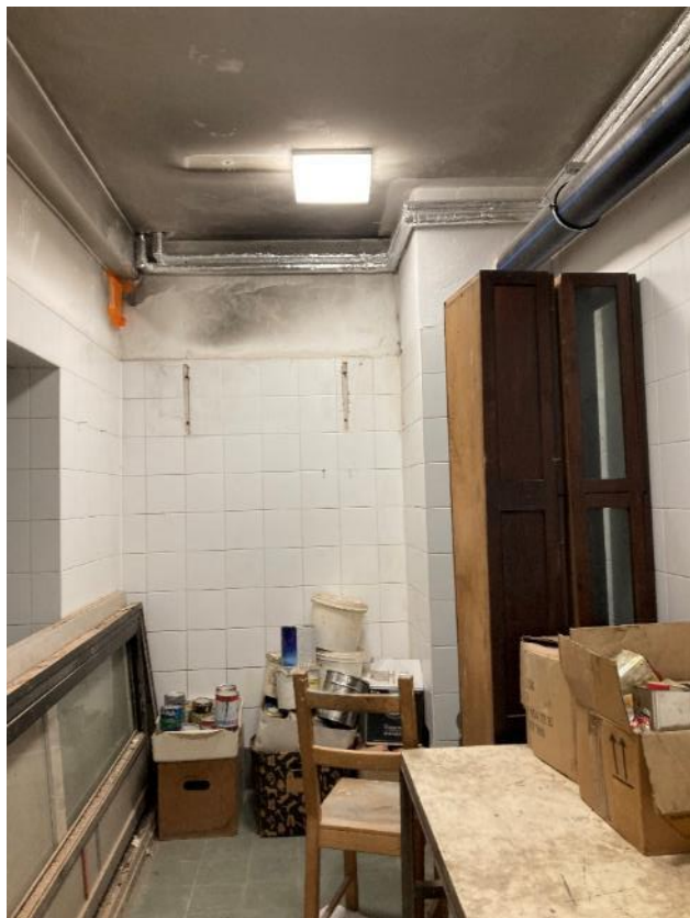
Fot. 37. Dawne Muzeum Techniczno-Przemysłowe, ul Smoleńsk 9, Kraków. Piwnice. Stan przed konserwacją. Czerwiec 2022. Fot. K. Sułkowska.
