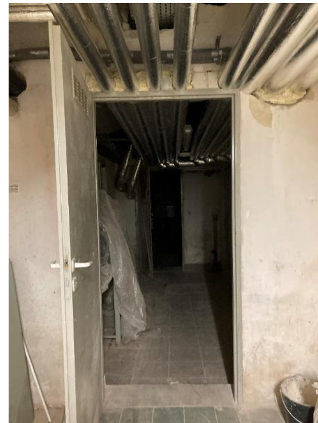
Fot. 39. Dawne Muzeum Techniczno-Przemysłowe, ul Smoleńsk 9, Kraków. Piwnice. Stan przed konserwacją. Czerwiec 2022. Fot. K. Sułkowska.
