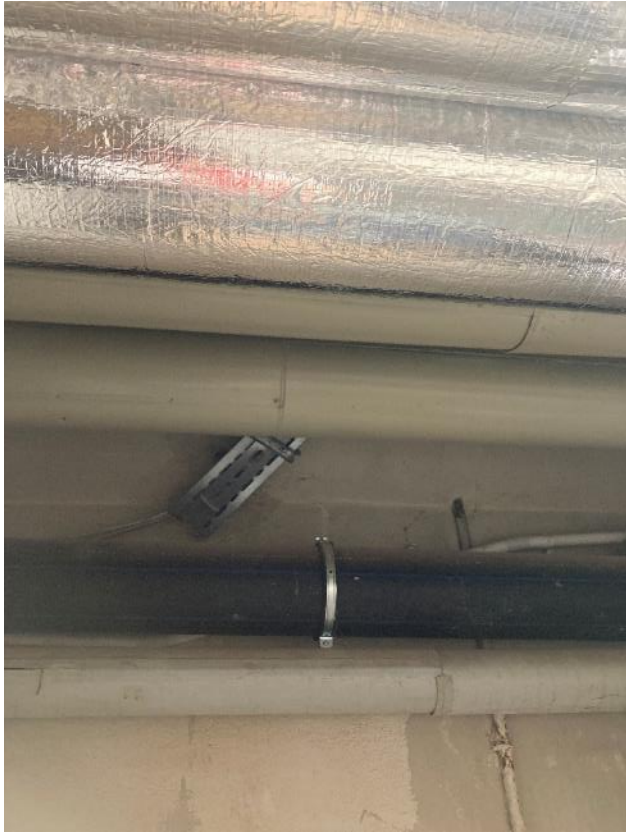
Fot. 25. Dawne Muzeum Techniczno-Przemysłowe, ul Smoleńsk 9, Kraków. Piwnice. Stan przed konserwacją. Czerwiec 2022. Fot. K. Sułkowska.
