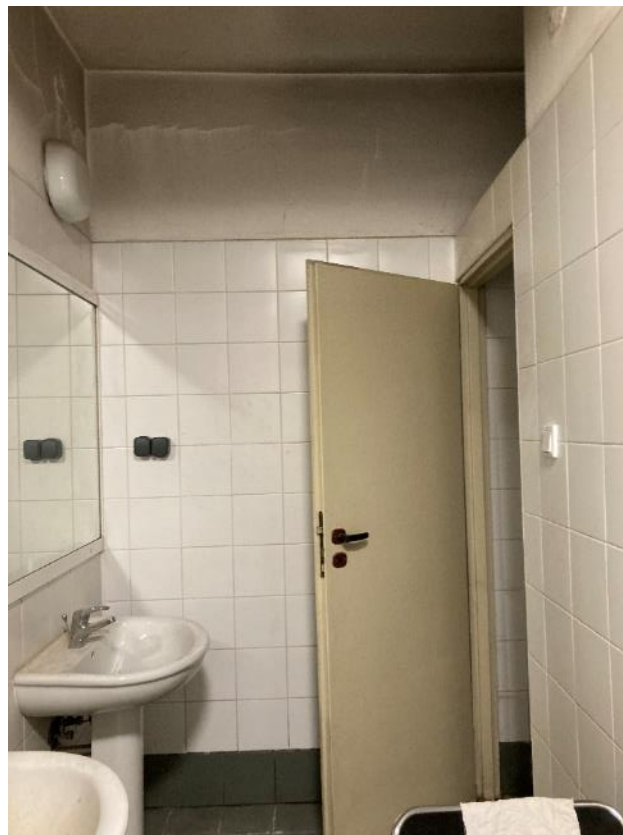
Fot. 38. Dawne Muzeum Techniczno-Przemysłowe, ul Smoleńsk 9, Kraków. Piwnice. Stan przed konserwacją. Czerwiec 2022. Fot. K. Sułkowska.
