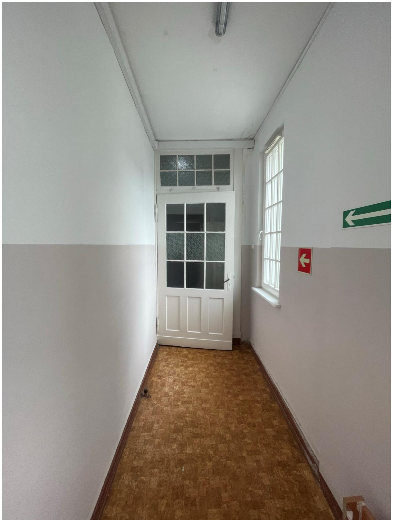
Drzwi D4, widok ogólny
