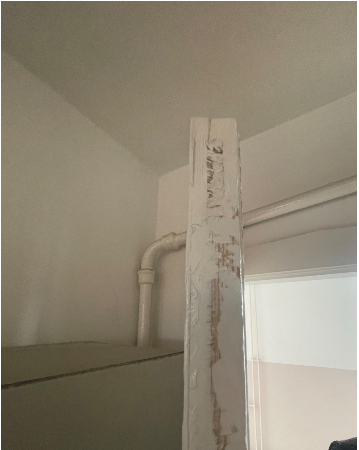
Czoło drzwi strychowych , obitych płytą pilśniową
