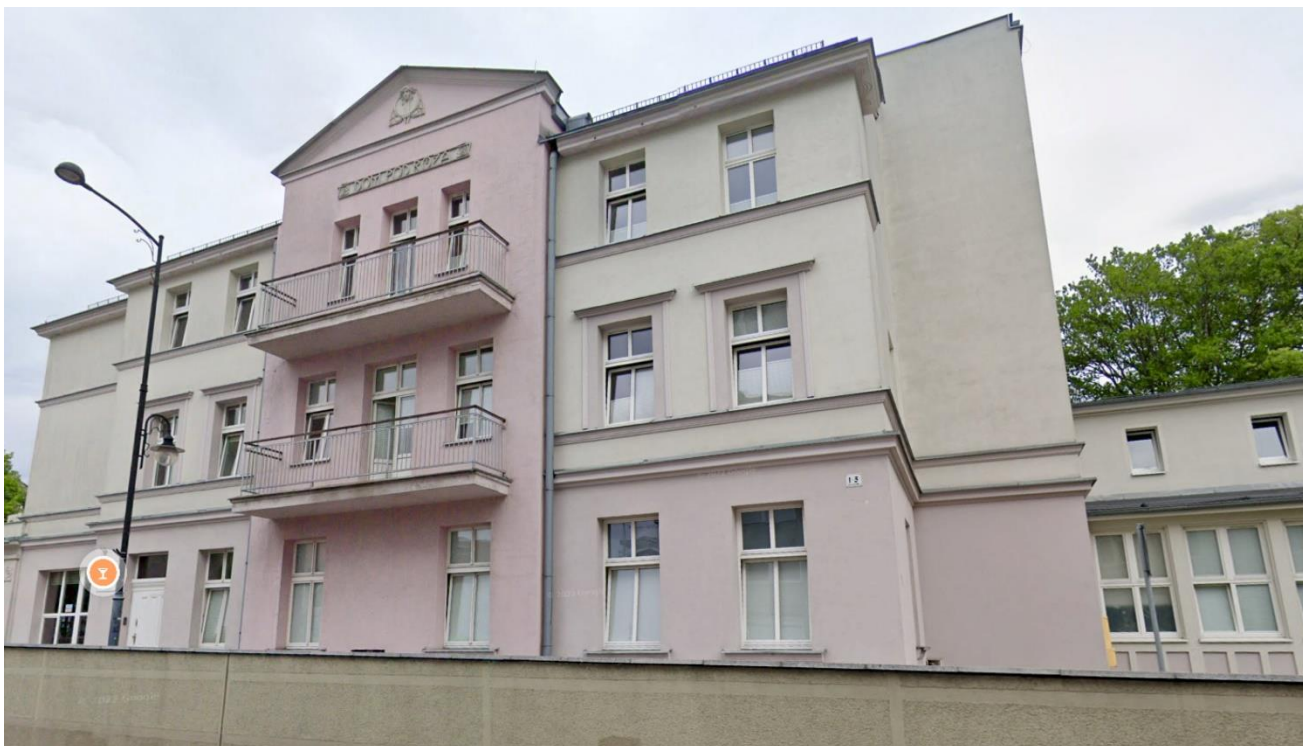
Fasada zachodnia , widok ogólny
