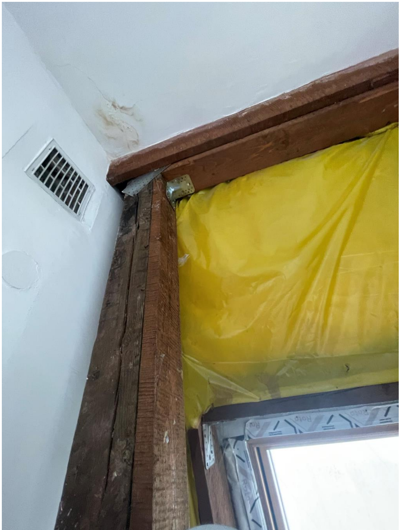
Korytarz strona północna, relikty więźby , naprawy i wzmocnienia współczesne
