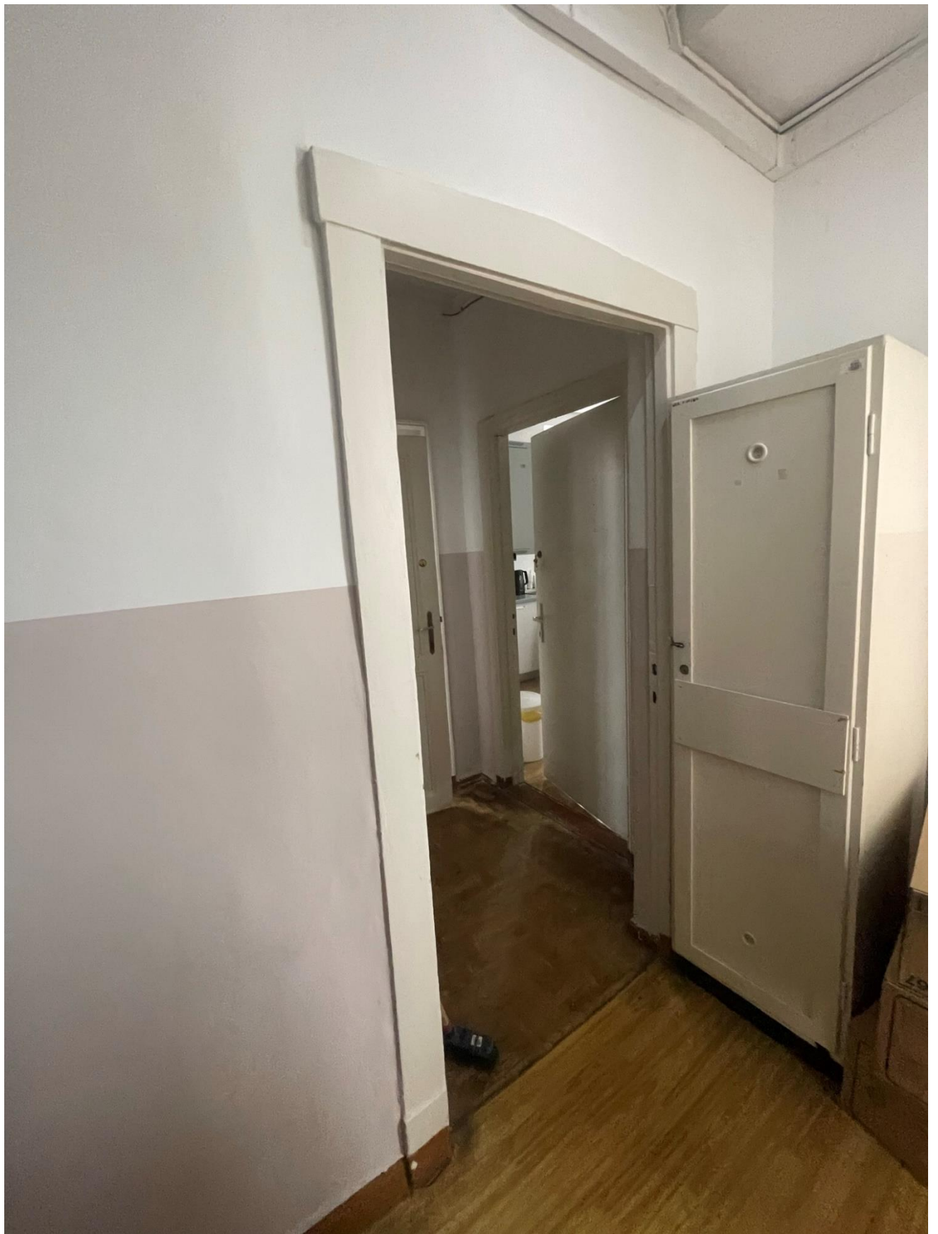
Ościeżnica z opaską po nieistniejących drzwiach D5, obok szafka do zachowania
