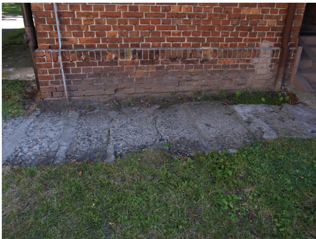
Fot.10. Budynek Administracji Szpitala Chorób Płuc w Pilchowicach, ul. Dworcowa 31, ceglana elewacja. Stan przed konserwacją. Widoczna: betonowa opaska oraz znaczne zniszczenia cegieł w partii cokołowej.
