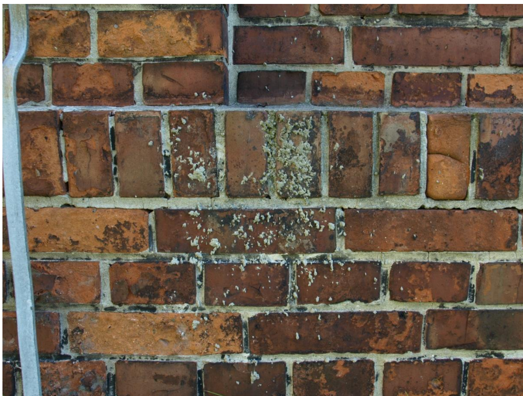
Fot.7. Budynek Administracji Szpitala Chorób Płuc w Pilchowicach, ul. Dworcowa 31, ceglana elewacja. Stan przed konserwacją. Widoczne: zachłapania zaprawą cementową.
