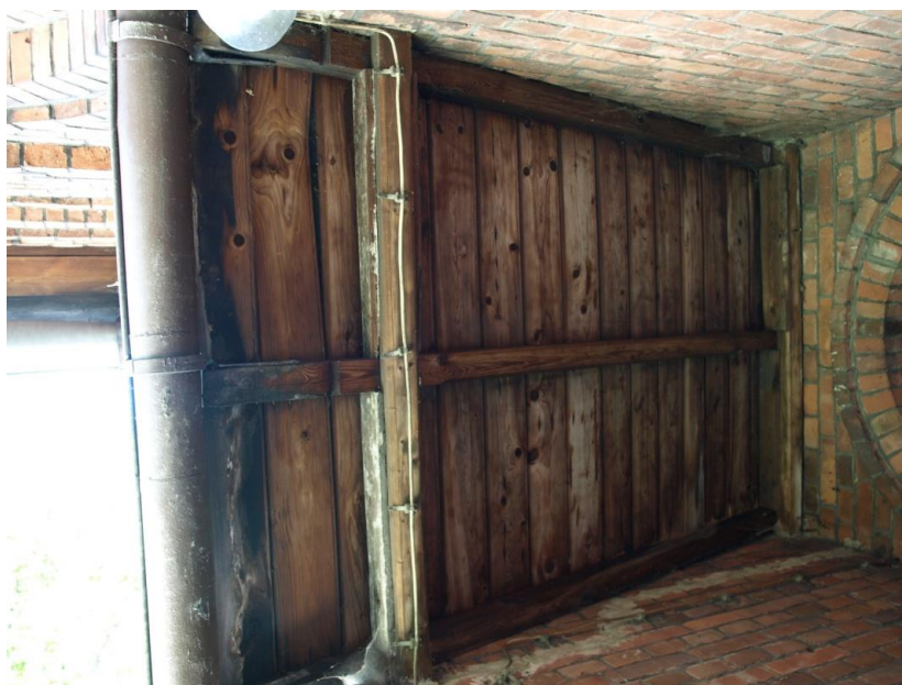
Fot.42. Budynek Administracji Szpitala Chorób Płuc w Pilchowicach, ul. Dworcowa 31. Stan przed konserwacją. Widoczna podbitka daszku nad wejściem.
