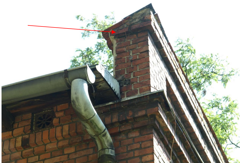
Attyka elewacji południowo-zachodniej większej części budynku. Strzałką zaznaczono warstwę cegieł, którą należy pozostawić jako wierzchnią. Wątki cegieł i dachówkę powyżej należy usunąć.
