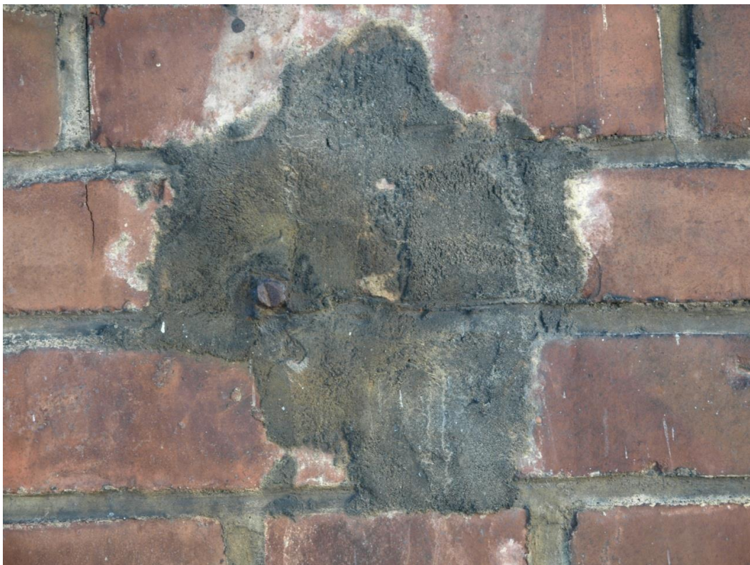
Fot.15. Budynek Administracji Szpitala Chorób Płuc w Pilchowicach, ul. Dworcowa 31, ceglana elewacja. Stan przed konserwacją. Widoczne: wtórne uzupełnienia zaprawą cementową.
