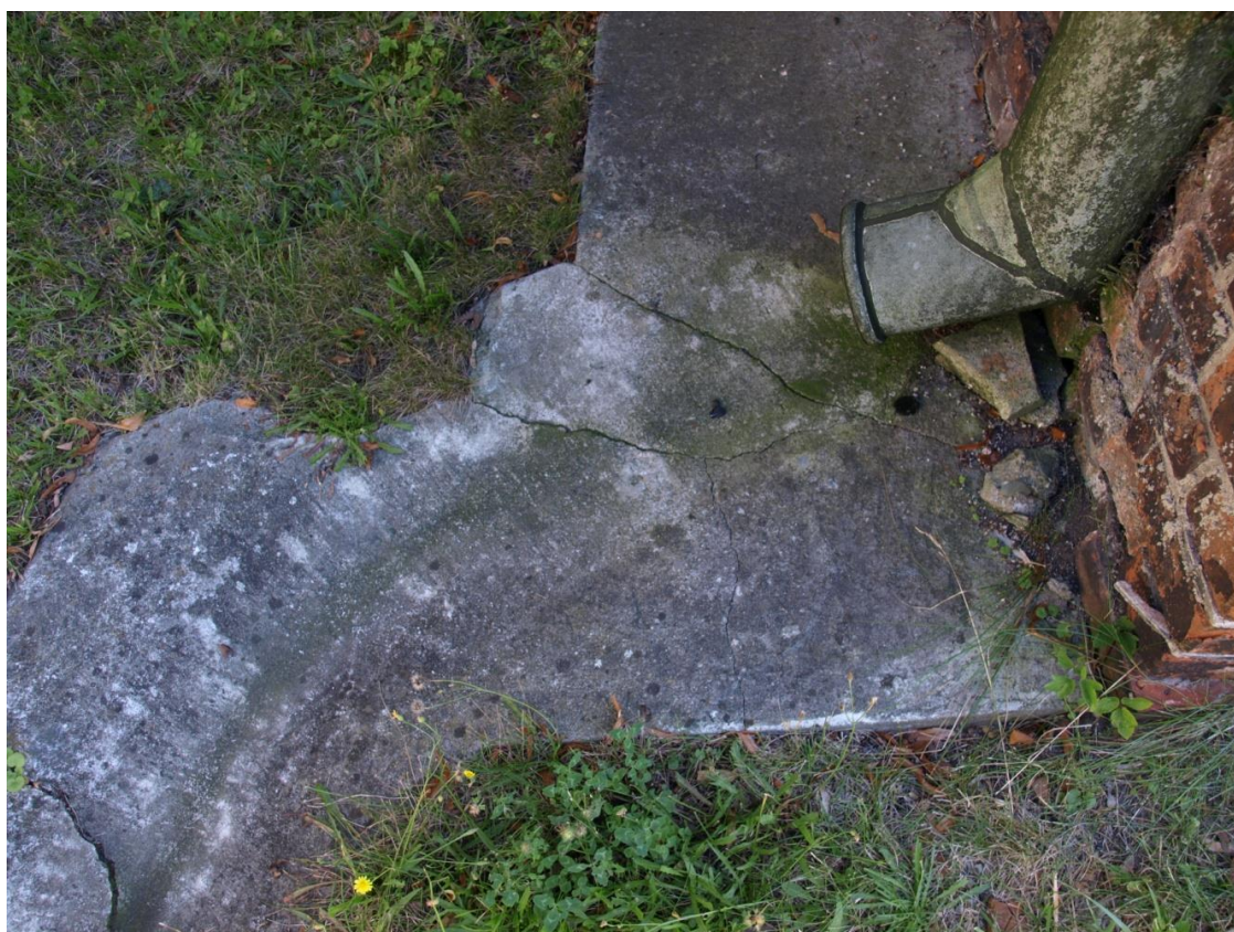
Fot.34. Budynek Administracji Szpitala Chorób Płuc w Pilchowicach, ul. Dworcowa 31. Stan przed konserwacją. Widoczna betonowa opaska wokół budynku.
