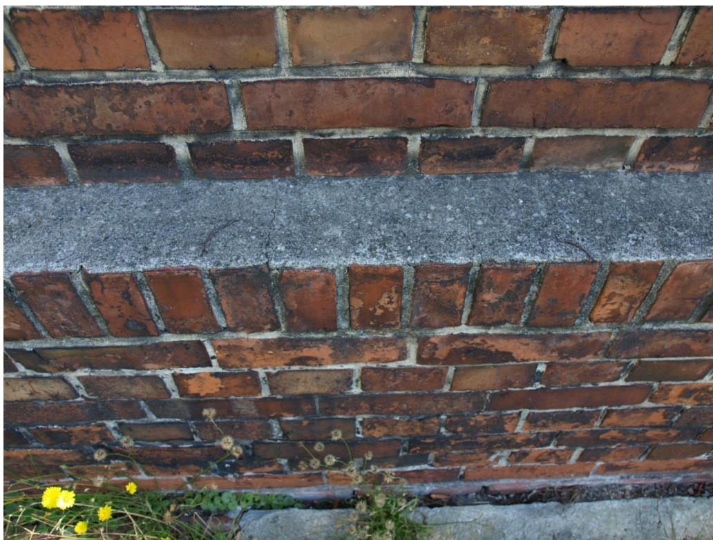
Fot.33. Budynek Administracji Szpitala Chorób Płuc w Pilchowicach, ul. Dworcowa 31. Stan przed konserwacją. Widoczna cementowa zaprawa na wysuniętej części cokołu.
