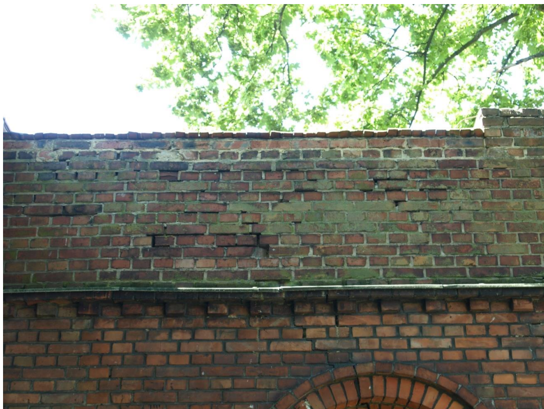
Fot.23. Budynek Administracji Szpitala Chorób Płuc w Pilchowicach, ul. Dworcowa 31, elewacja północno-wschodnia. Stan przed konserwacją. Widoczne zmiany formy attyki - wtórne nadmurowanie dwóch warstw cegieł i położenie dachówki-karpiówki.
