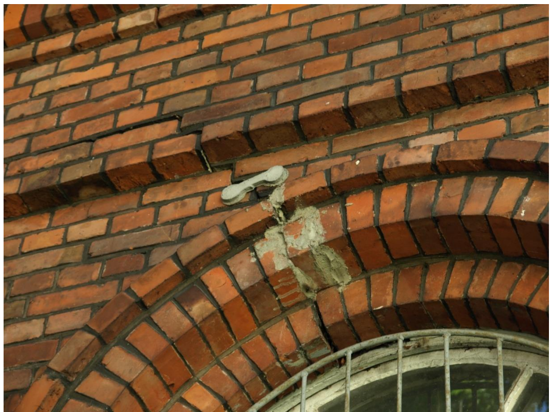
Fot.29 i 30. Budynek Administracji Szpitala Chorób Płuc w Pilchowicach, ul. Dworcowa 31. Stan przed konserwacją. Widoczne pęknięcia murów.
