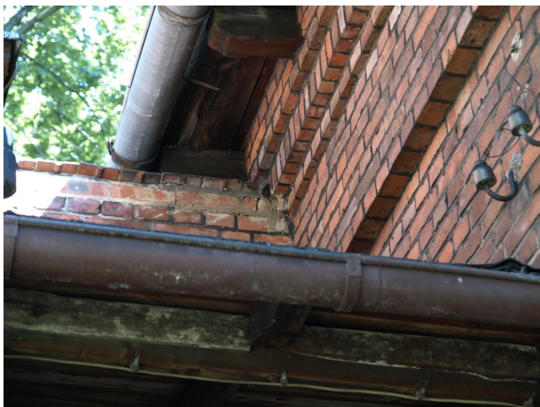
Fot.27 i 28. Budynek Administracji Szpitala Chorób Płuc w Pilchowicach, ul. Dworcowa 31. Stan przed konserwacją. Widoczne zmiany formy attyki - wtórne nadmurowanie dwóch warstw cegieł i położenie dachówki-karpiówki oraz pozostałości pierwotnego zakończenia attyk w postaci zachowanych fragmentów wysuniętych cegieł.
