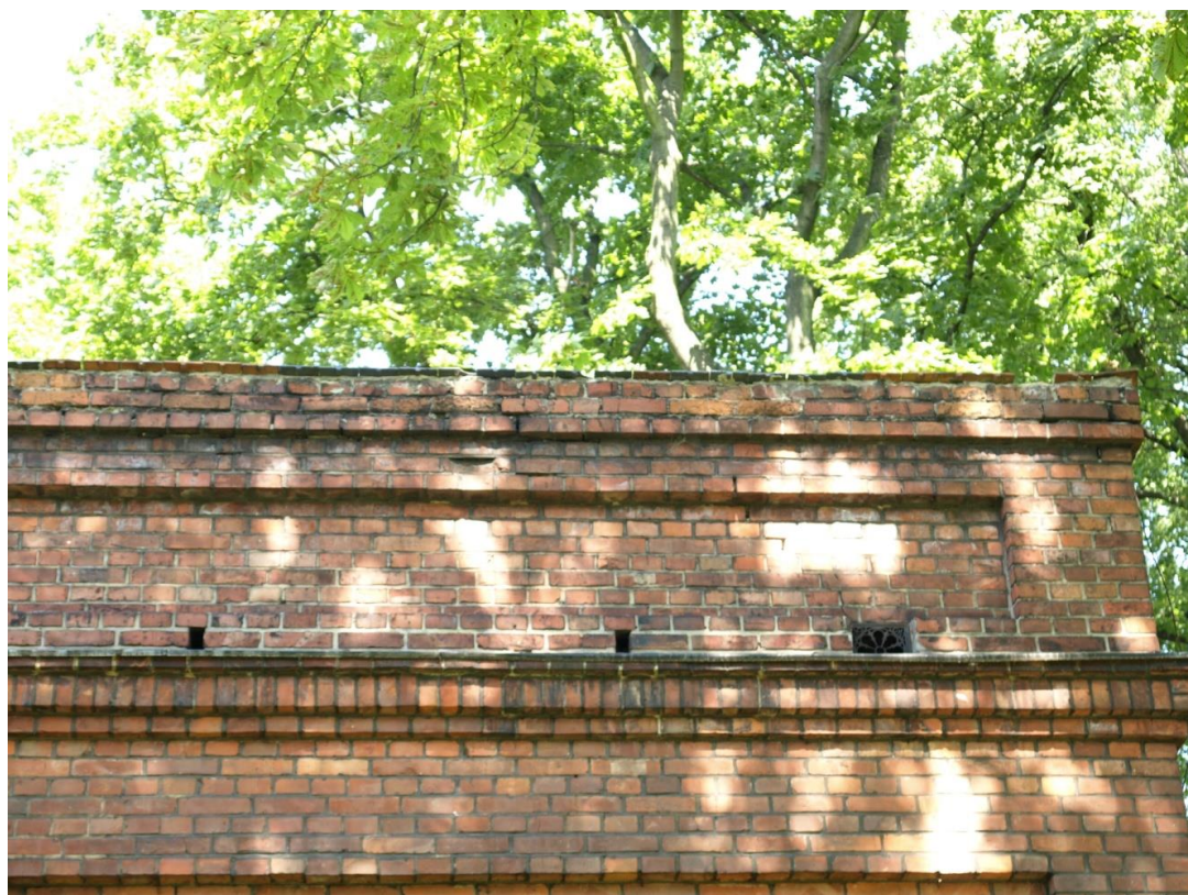
Fot.24. Budynek Administracji Szpitala Chorób Płuc w Pilchowicach, ul. Dworcowa 31, elewacja południowo-wschodnia. Stan przed konserwacją. Widoczne zmiany formy attyki - wtórne nadmurowanie dwóch warstw cegieł i położenie dachówki-karpiówki.
