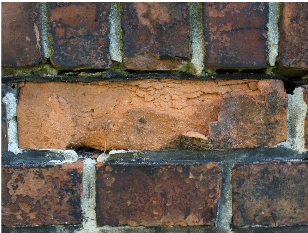
Fot.6. Budynek Administracji Szpitala Chorób Płuc w Pilchowicach, ul. Dworcowa 31, cokół budynku. Stan przed konserwacją. Widoczne: zniszczenia i ubytki cegły, zabrudzenia, ubytki spoiny.
