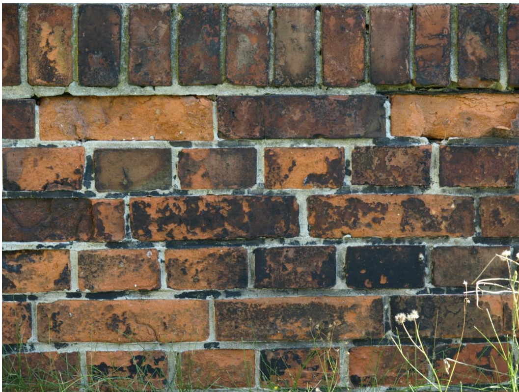
Fot.5. Budynek Administracji Szpitala Chorób Płuc w Pilchowicach, ul. Dworcowa 31, cokół budynku. Stan przed konserwacją. Widoczne zniszczenia i zabrudzenia wątku ceglanego.
