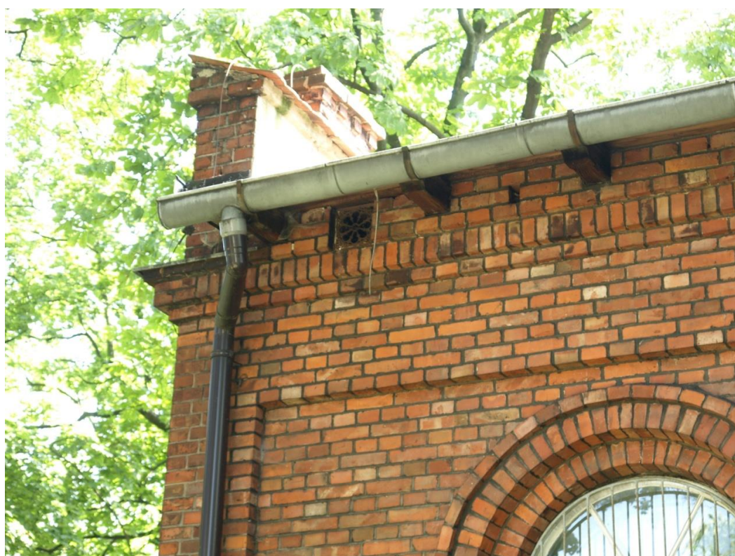
Fot.25 i 26. Budynek Administracji Szpitala Chorób Płuc w Pilchowicach, ul. Dworcowa 31. Stan przed konserwacją. Widoczne zmiany formy attyki - wtórne nadmurowanie dwóch warstw cegieł i położenie dachówki-karpiówki.
