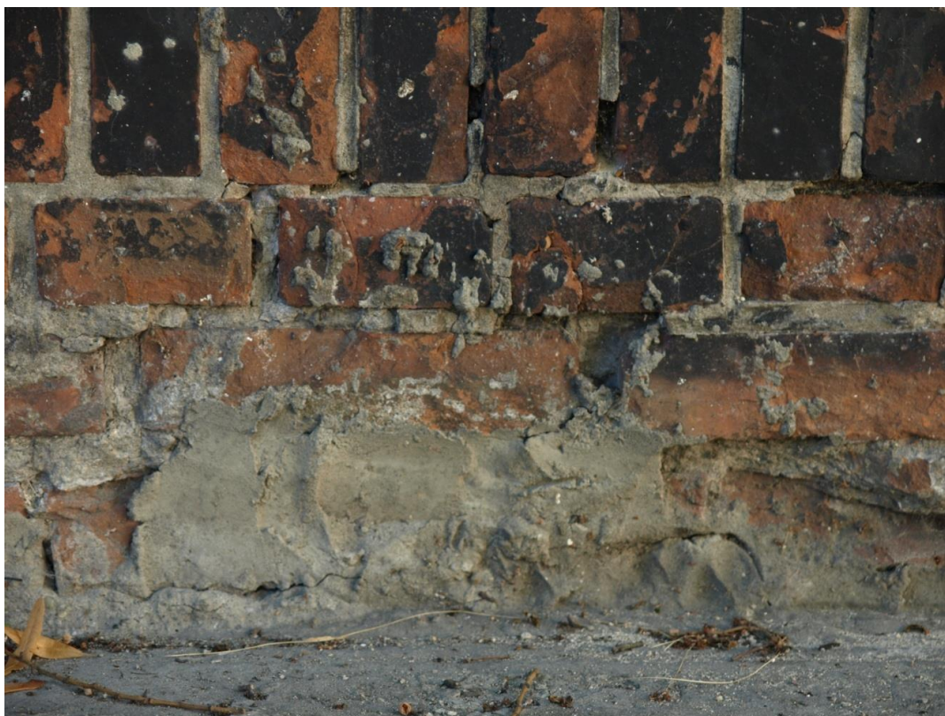
Fot.16. Budynek Administracji Szpitala Chorób Płuc w Pilchowicach, ul. Dworcowa 31, ceglana elewacja. Stan przed konserwacją. Widoczne uzupełnienia ubytków cegieł zaprawą cementowo-piaskową.
