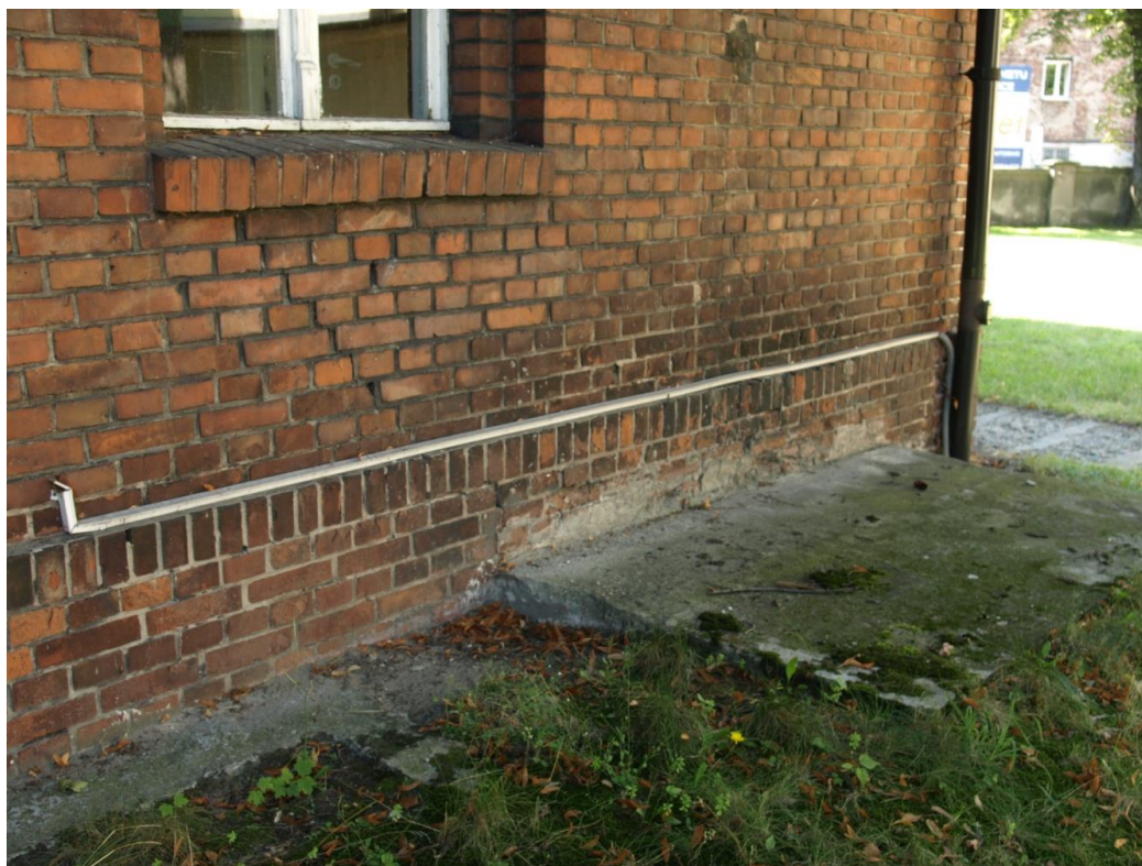
Fot.35. Budynek Administracji Szpitala Chorób Płuc w Pilchowicach, ul. Dworcowa 31. Stan przed konserwacją. Widoczna betonowa opaska wokół budynku.
