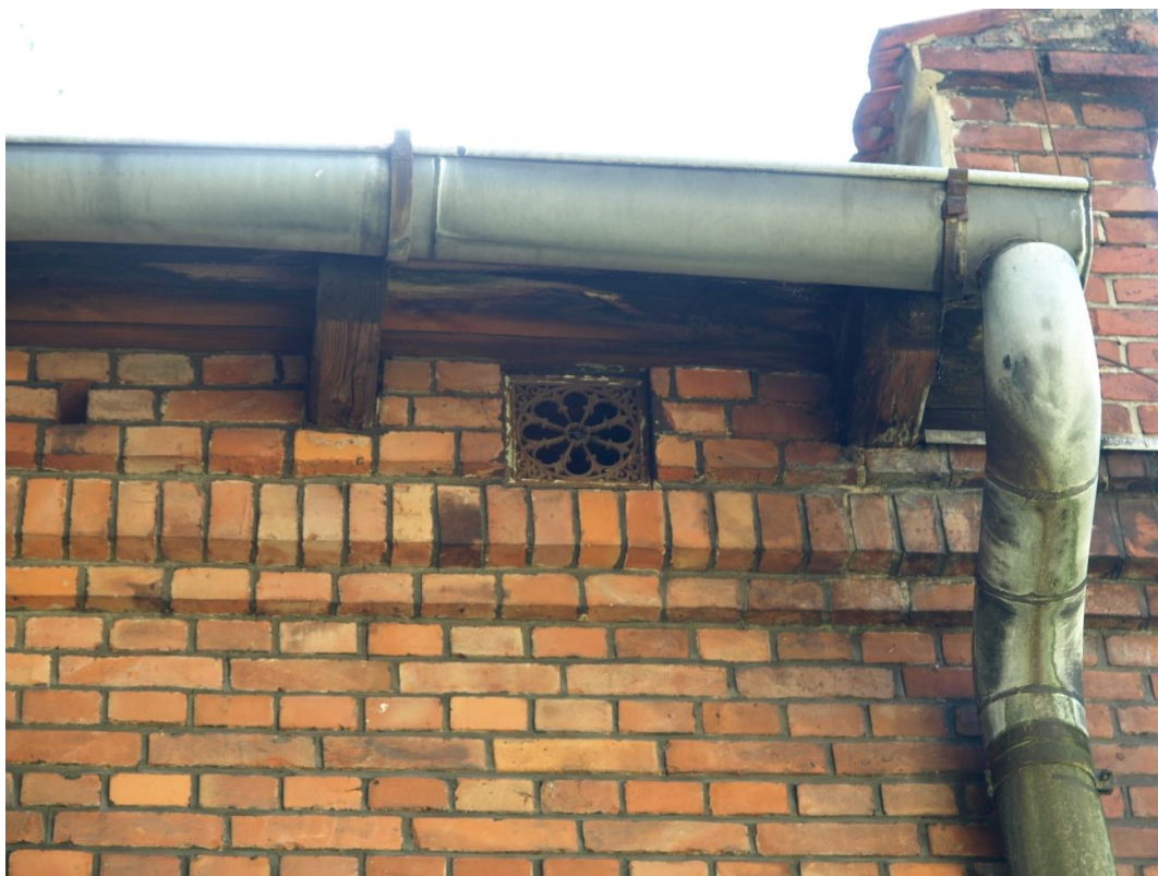
Fot.41. Budynek Administracji Szpitala Chorób Płuc w Pilchowicach, ul. Dworcowa 31. Stan przed konserwacją. Widoczna oryginalna kratka wentylacyjna.
