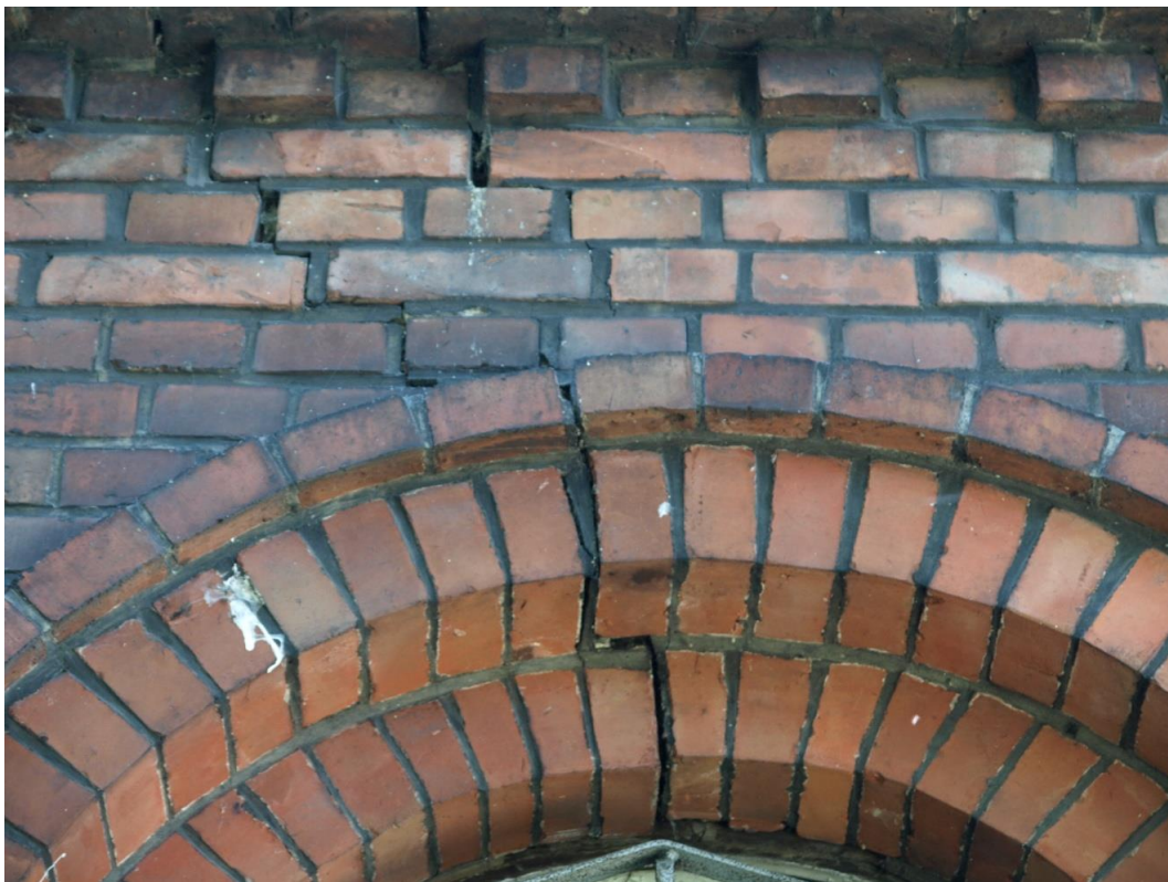
Fot.31. Budynek Administracji Szpitala Chorób Płuc w Pilchowicach, ul. Dworcowa 31. Stan przed konserwacją. Widoczne pęknięcia murów.
