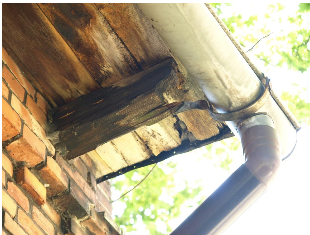
Fot.39 i 40. Budynek Administracji Szpitala Chorób Płuc w Pilchowicach, ul. Dworcowa 31. Stan przed konserwacją. Widoczny stan zachowania krokwi, drewnianej podbitki oraz rynien.
