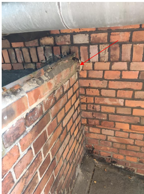
Attyka nad daszkiem, nad wejściem do budynku. Strzałką zaznaczono wysunięty fragment cegły z pierwotnego zakończenia attyki.
