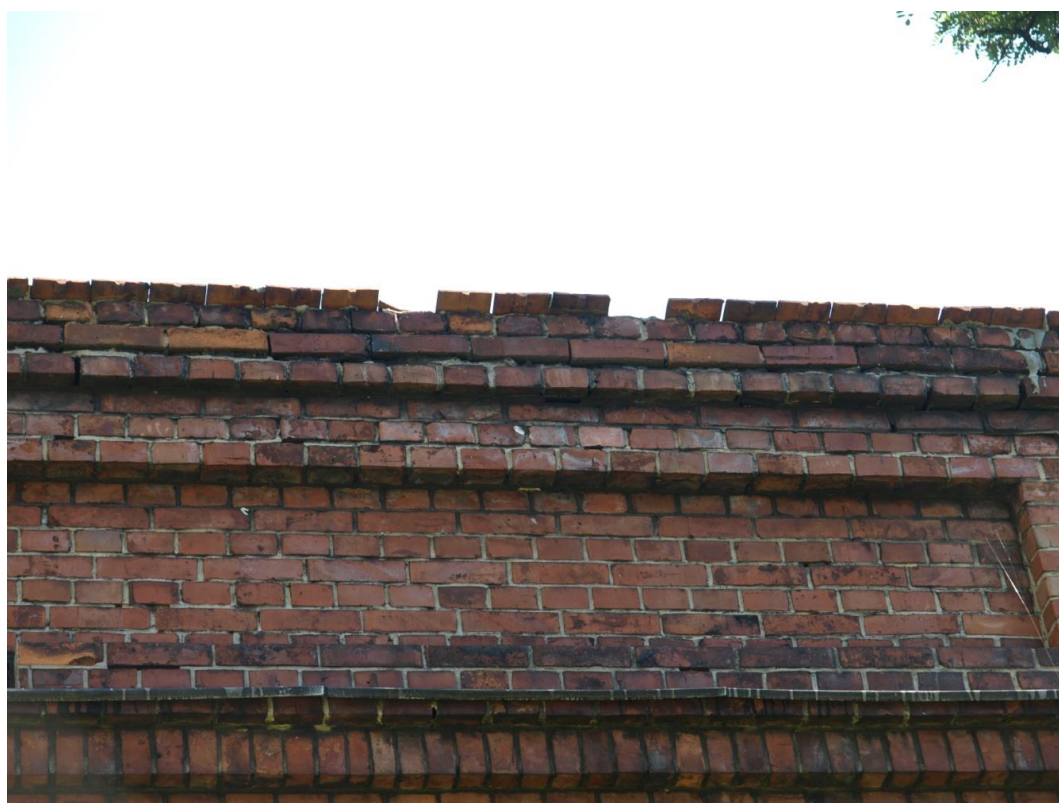
Fot.21 i 22. Budynek Administracji Szpitala Chorób Płuc w Pilchowicach, ul. Dworcowa 31, elewacja południowo-zachodnia. Stan przed konserwacją. Widoczne zmiany formy attyki - wtórne nadmurowanie dwóch warstw cegieł i położenie dachówki-karpiówki. W obrębie nadmurowań brakuje spoin. Oryginalnie attykę wieńczyła jedna warstwa cegieł ułożonych na płasko, wysunięta przed lico, zabezpieczona od góry blachą.
