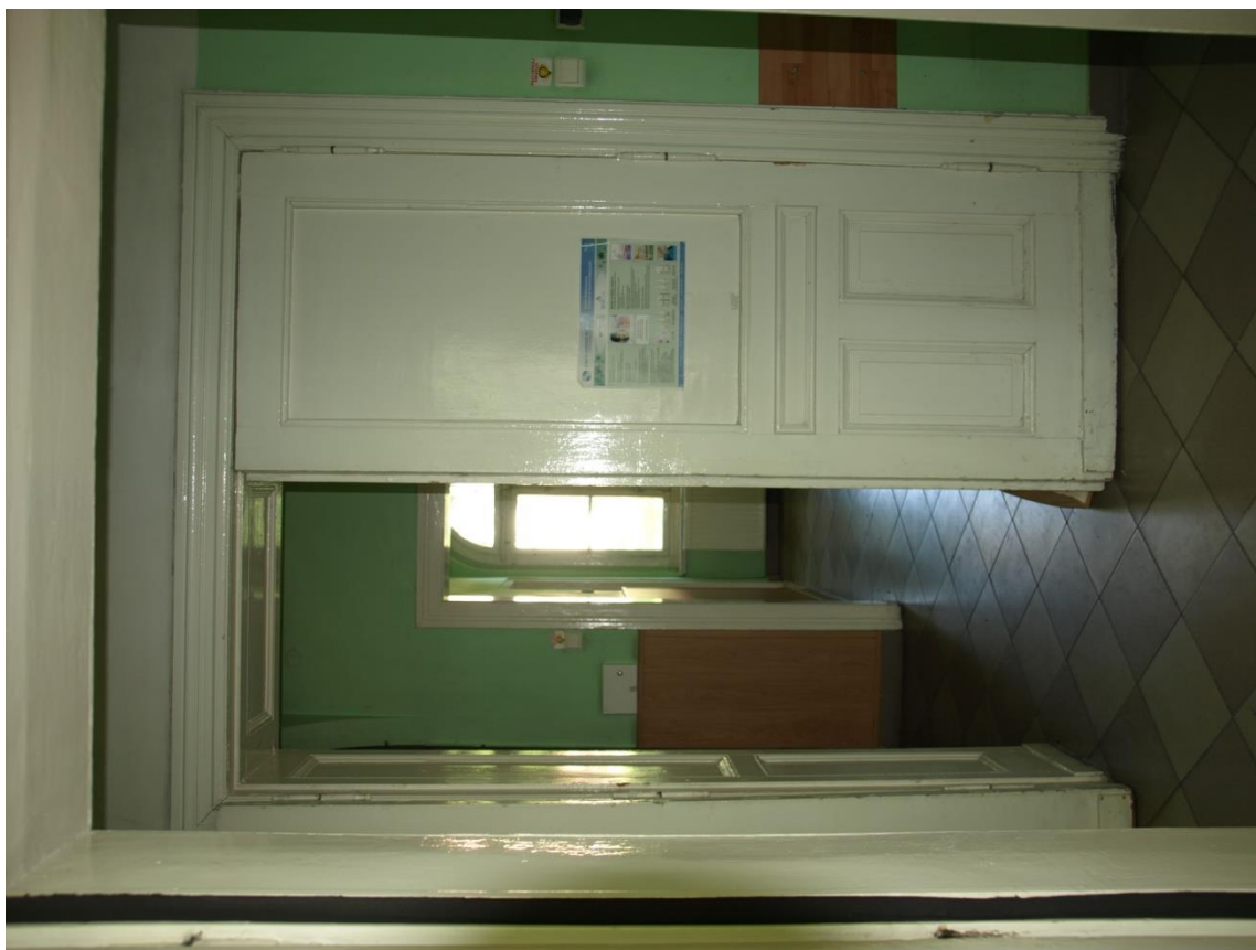
Fot.63. Budynek Administracji Szpitala Chorób Płuc w Pilchowicach, ul. Dworcowa 31. Stan przed konserwacją. Widoczne różne rodzaje drzwi ramowo-płycinowych.
