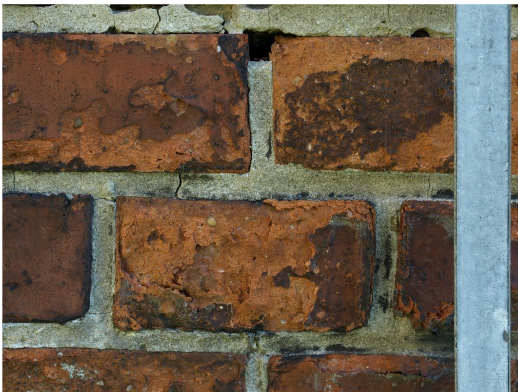
Fot.8. Budynek Administracji Szpitala Chorób Płuc w Pilchowicach, ul. Dworcowa 31, cokół budynku. Stan przed konserwacją. Widoczne: zniszczenia cegieł oraz ubytki spoiny.
