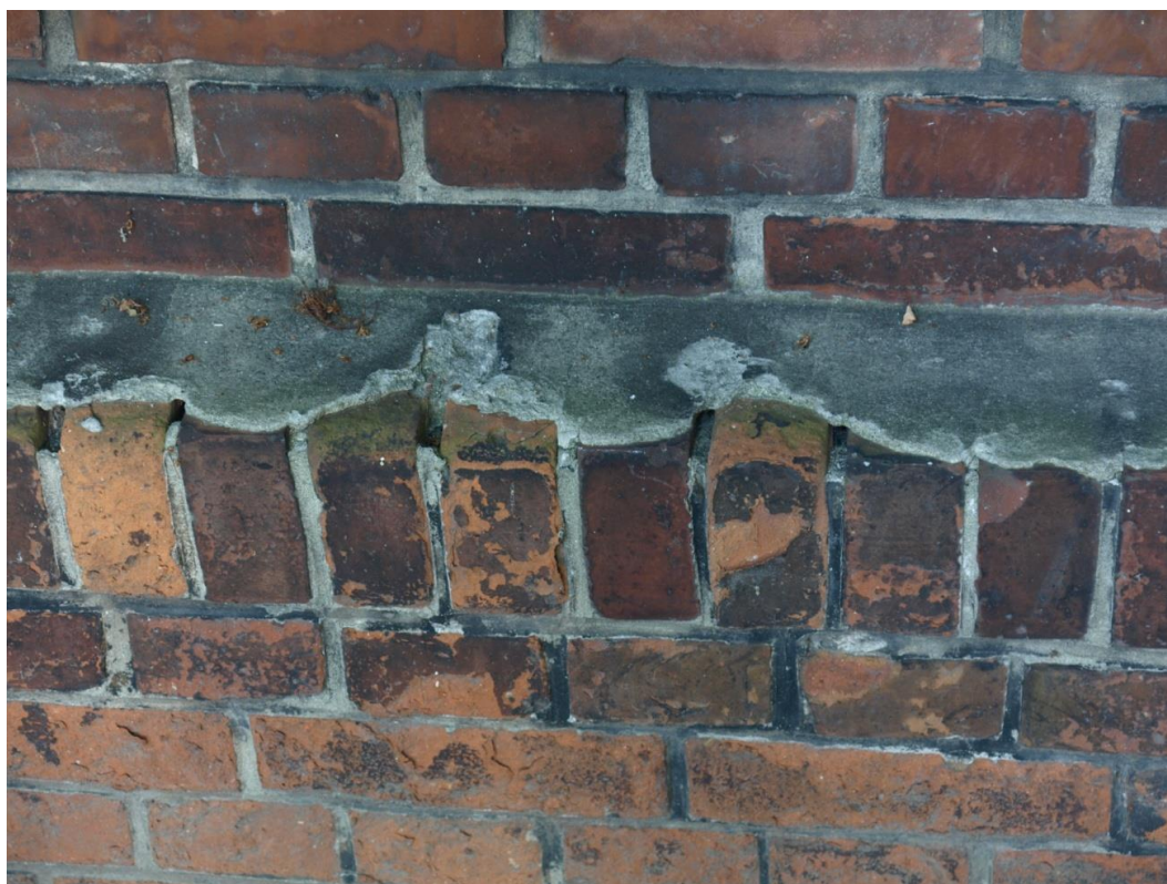
Fot.36. Budynek Administracji Szpitala Chorób Płuc w Pilchowicach, ul. Dworcowa 31. Stan przed konserwacją. Widoczna cementowa zaprawa na wysuniętej części cokołu.
