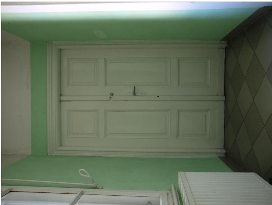
Fot.61 i 62. Budynek Administracji Szpitala Chorób Płuc w Pilchowicach, ul. Dworcowa 31. Stan przed konserwacją. Widoczne różne rodzaje drzwi ramowo-płycinowych.
