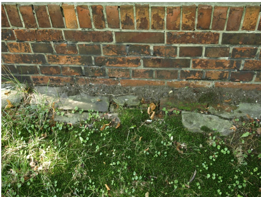
Fot.38. Budynek Administracji Szpitala Chorób Płuc w Pilchowicach, ul. Dworcowa 31. Stan przed konserwacją. Pod warstwą betonu widoczne jest dawne obejście z cegieł?/.
