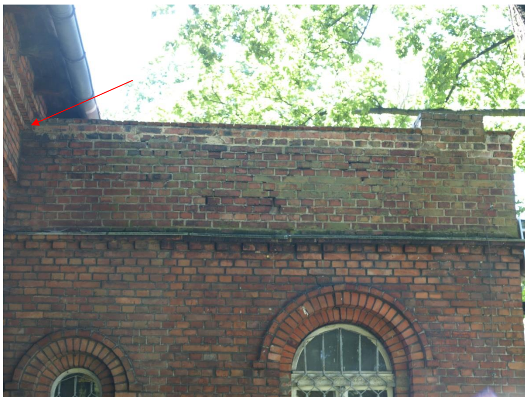
Attyka elewacji południowo-zachodniej większej części budynku. Strzałką zaznaczono warstwę cegieł, którą należy pozostawić jako wierzchnią. Wątki cegieł i dachówkę powyżej należy usunąć.
