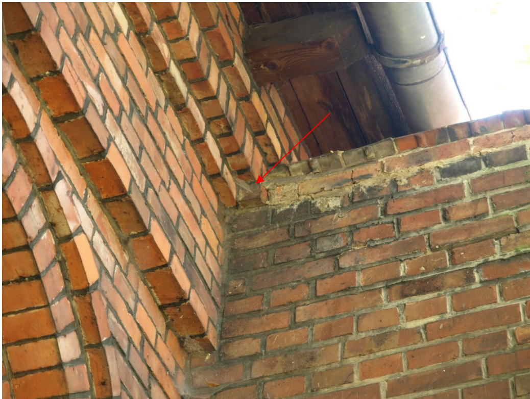
Attyka elewacji północno-wschodniej na mniejszej części budynku. Strzałką zaznaczono zachowany fragment wysuniętej cegły z pierwotnego zakończenia attyki. Fragment ten wyznacza poziom oraz wysunięcie do rekonstrukcji wątku na attykach mniejszej części obiektu.
